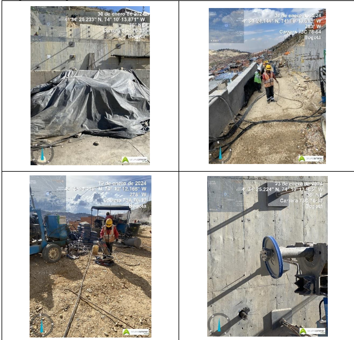
Fotografía 2. Seguimiento a la aplicación de controles ambientales.
