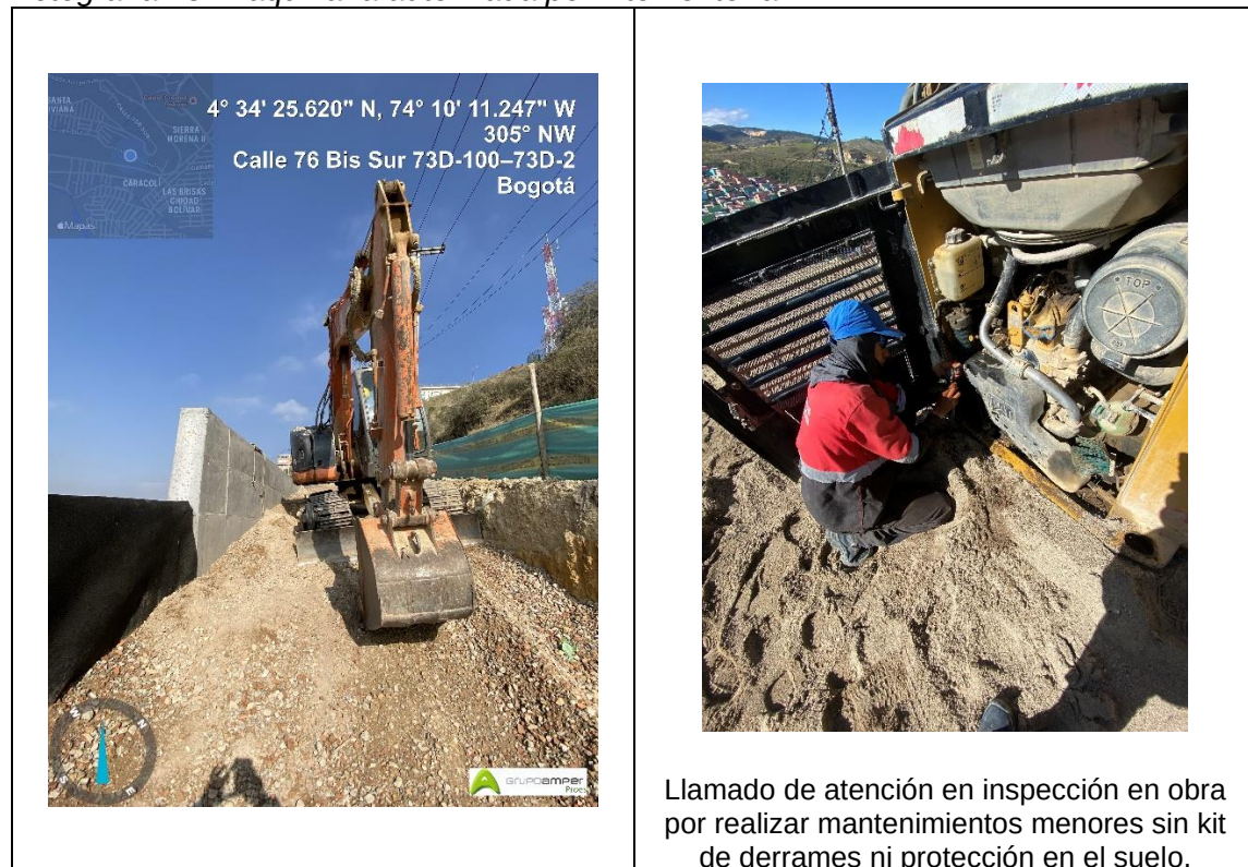
Fotografía 15. Maquinaria autorizada por interventoría.
