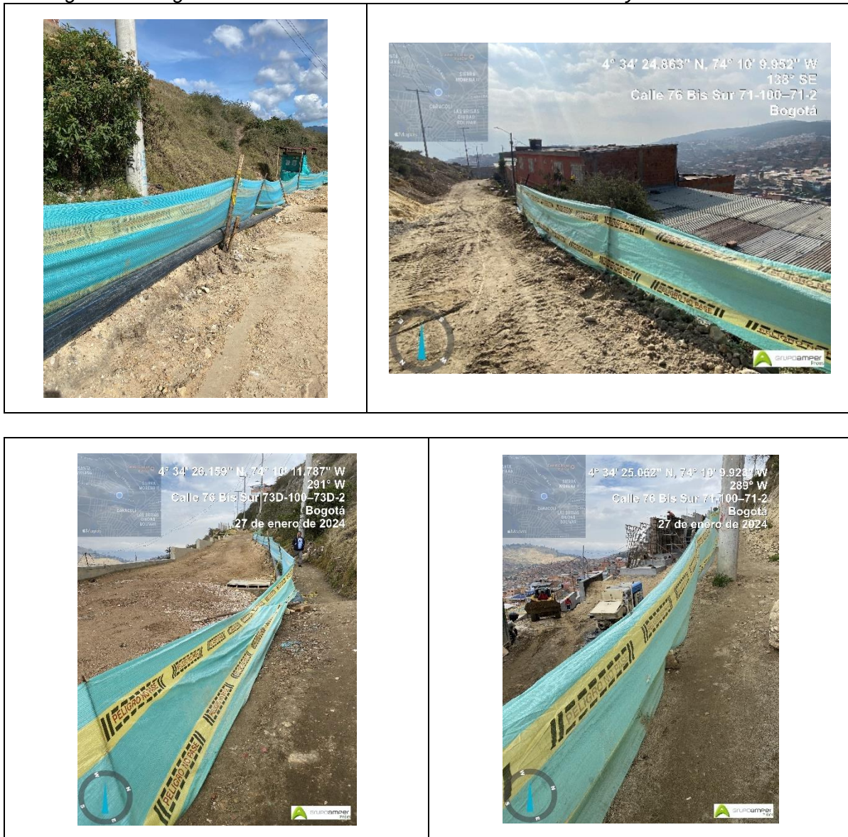
Fotografía 3. Seguimiento a la instalación de cerramientos CIV's y ZRA.
