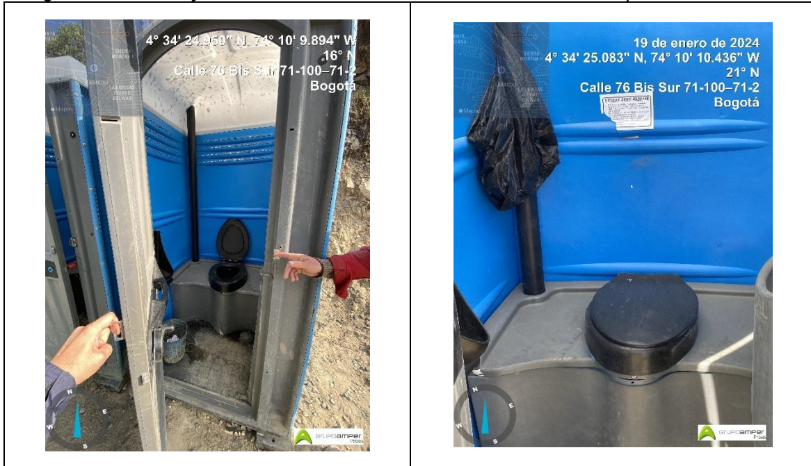
Fotografía 9. Estado y correcto mantenimiento de las UUSSPP en la parte media de la ZRA.
