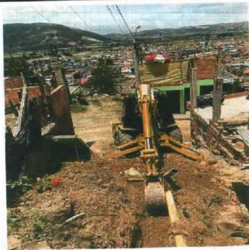
Descripción: Excavación mecánica en material conglomerado y roca para pozo de inspección, Monserrate Bajo
