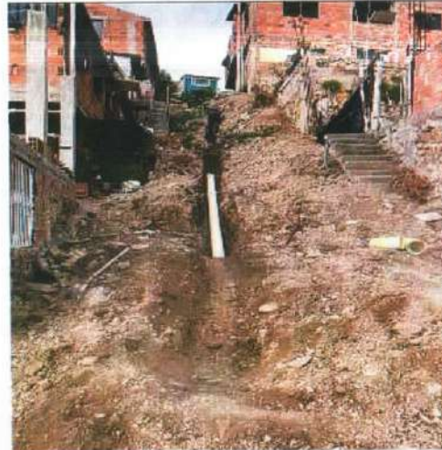
Descripción: Instalación de red de alcantarillado sanitario de 8", Monserrate Bajo
