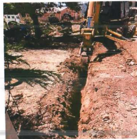
Descripción: Excavación mecánica para tubería en polietileno de 2", Monserrate Alto
