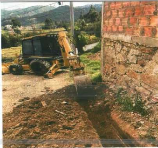
Descripción: Excavación mecánica para red de acueducto, Monserrate Bajo
