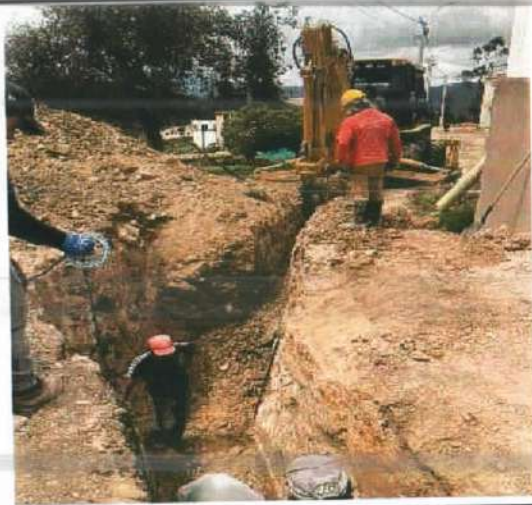
Descripción: Verificación de profundidad de excavación para pozo sanitario, Monserrate Alto
