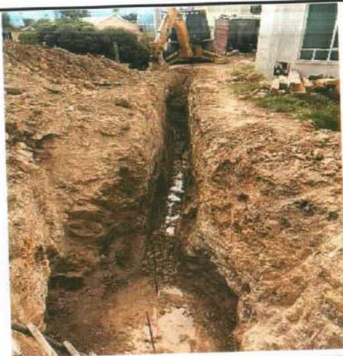
Descripción: Nivelación de piso del pozo para posterior fundida en concreto, Monserrate Alto
