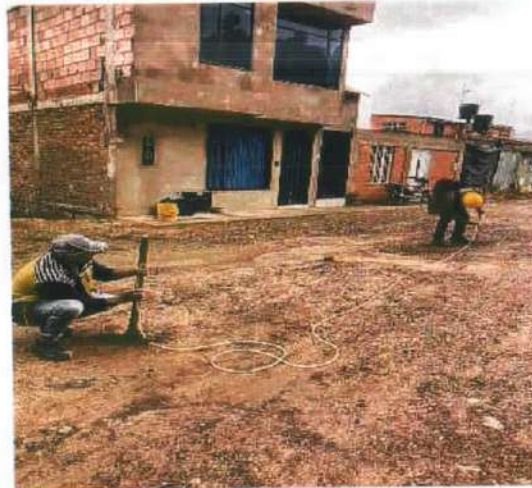
Descripción: Trazo de niveles de terreno para red de alcantarillado Santa Lucía
