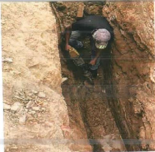
Descripción: Excavación en roca con martillo eléctrico Monserrate Alto
