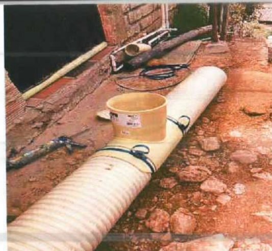
Descripción: Instalación de silla tee para conexión domiciliar, Monserrate Bajo
