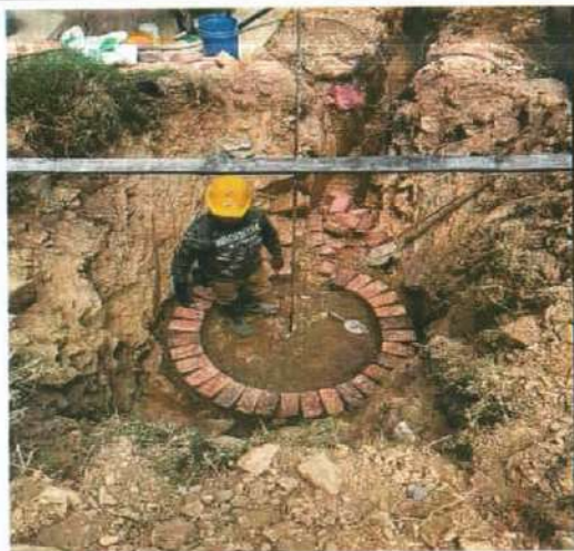
Descripción: Inicio de la construcción de pozo sanitario Monserrate Bajo
