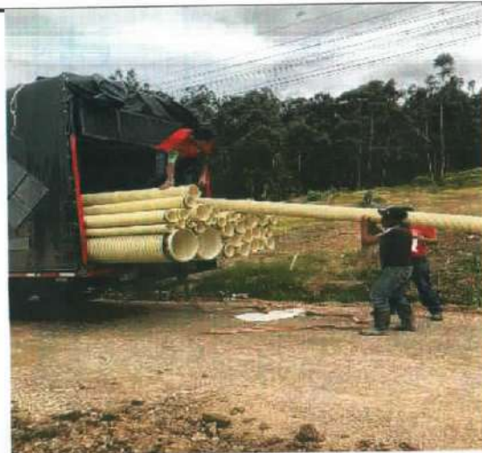
Descripción: Tubería sanitaria de 8" y 2" para red sanitaria Santa Lucía
