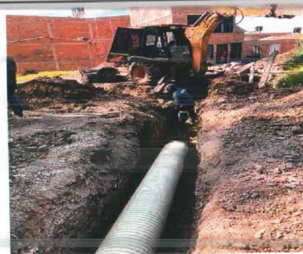
Descripción: Instalación de red pluvial de 16", Santa Lucía
