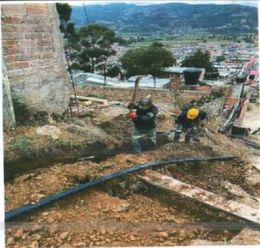
Descripción: Excavación manual para red de acueducto, Monserrate Bajo
