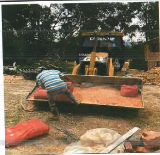
Descripción: Materiales para mortero de pega para construcción de pozo sanitario, Monserrate Bajo
