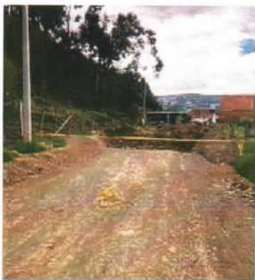
DESCRIPCIÓN: SEÑALIZACION OBRA
