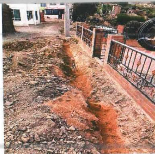
Descripción: Relleno en arena sobre tubería en polietileno, Monserrate Alto
