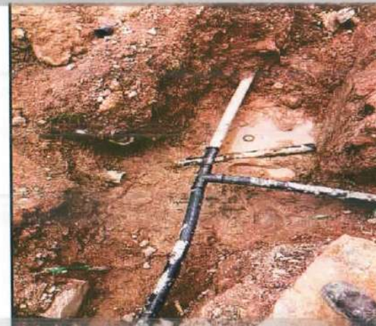
Descripción: Tee en polietileno de 2", Villa del sol
