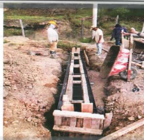
Descripción: Formaleta para hueco de sumidero y fundida de sumidero, Santa Lucía
