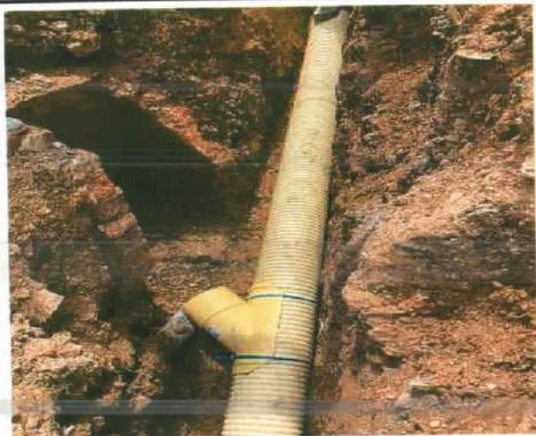
Descripción: Conexión domiciliar con silla tee hasta caja de inspección, Monserrate Bajo
