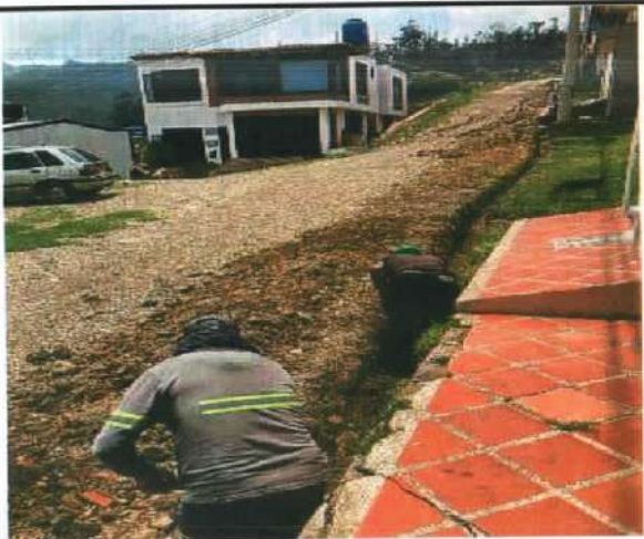
Descripción: Excavación manual en material conglomerado, Villa del sol
