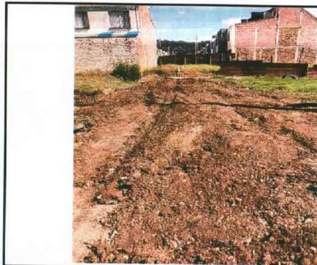
Descripción: Relleno con material común, se evita de rellenar con vegetación ni conglomerados de gran tamaño o piedras que fracturen la tubería, Prados Norte.
