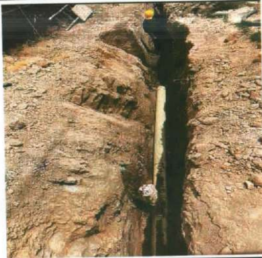
Descripción: Instalación de tubería sanitaria de 8" Monserrate Alto
