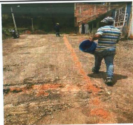
Descripción: Replanteo de red principal sanitaria Santa Lucía
