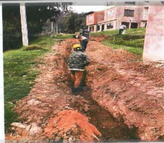
Descripción: Excavación manual para la red de acueducto, Villa del Sol
