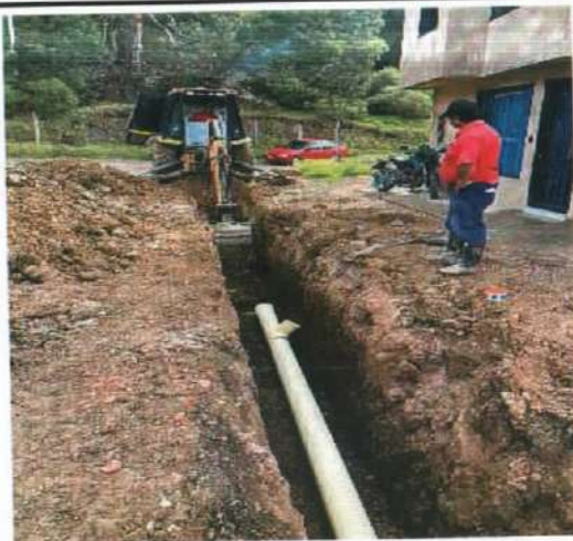
Descripción: Excavación mecánica y trazado de red sanitaria Santa Lucía
