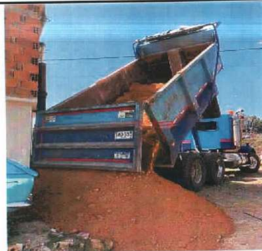
Descripción: Suministro de arena para relleno sobre manguera de polietileno, Monserrate Alto
