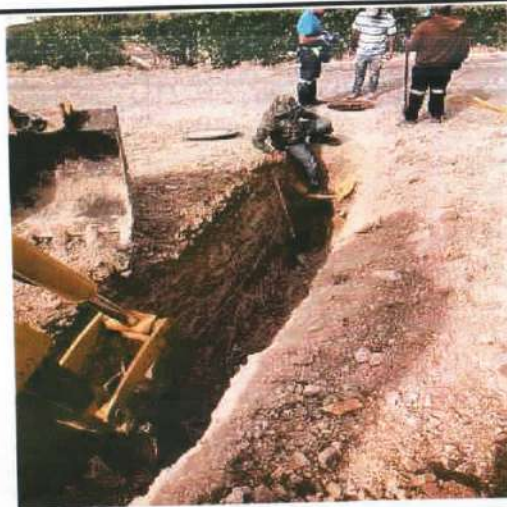
Descripción: Excavación mecánica con retroexcavadora en Monserrate Alto
