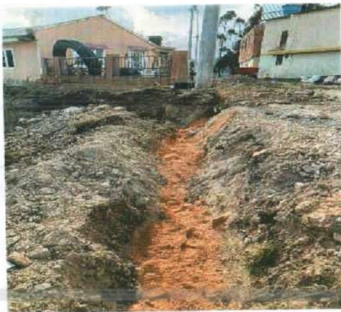
Descripción: Relleno con Arena sobre manguera de polietileno, Monserrate Alto
