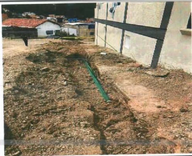
Descripción: Instalación de cinta de demarcación para red de acueducto Villa del Sol
