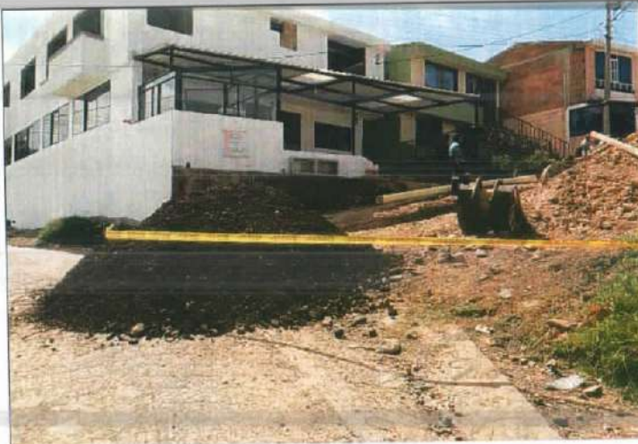
Descripción: Material de afirmado para zanja de red sanitaria, Monserrate Alto
