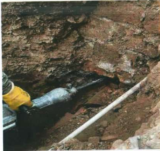
Descripción: Demolición de pared de caja de inspección para realizar conexión domiciliaria, Monserrate Alto
