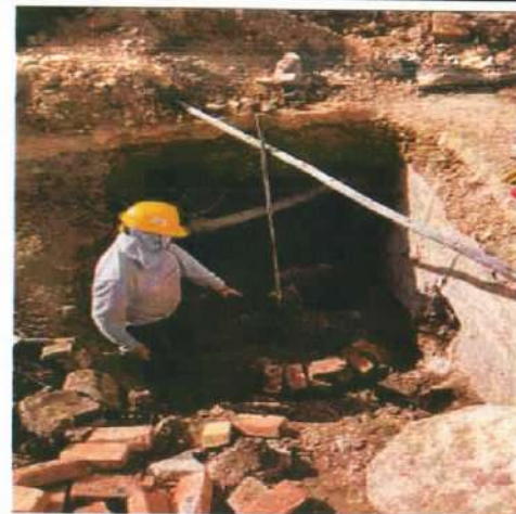
Descripción: Construcción de pozo pluvial Prados Norte
