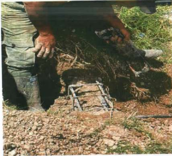
Descripción: Demolición manual de viga de cimentación, Villa de Sol
