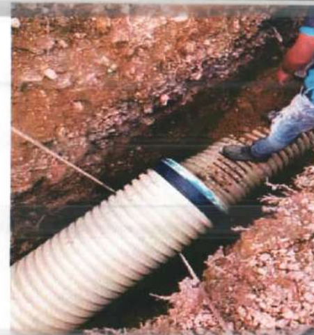
Descripción: Hidrosello y lubricante en tubería 20" Prados Norte
