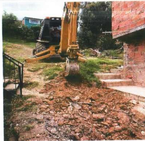
Descripción: Excavación mecánica para pozo Monserrate Bajo
