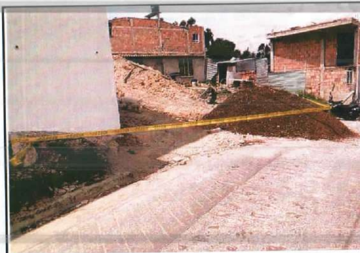
Descripción: Señalización de obra de alcantarillado, Monserrate Alto
