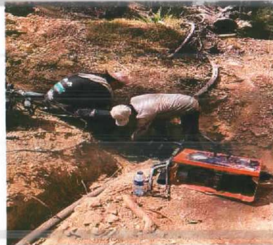
Descripción: Termofusiones para red de acueducto Monserrate Bajo
