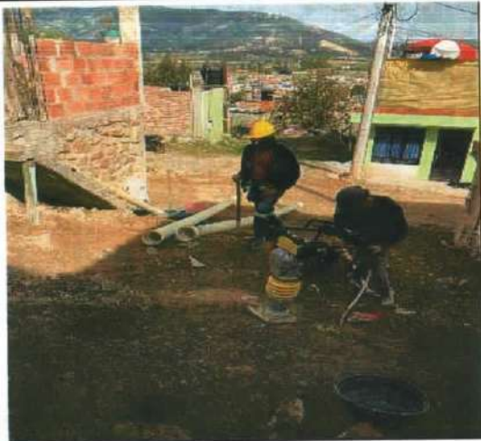
Descripción: Compactación de material de excavación y material de afirmado sobre red sanitaria Monserrate Bajo
