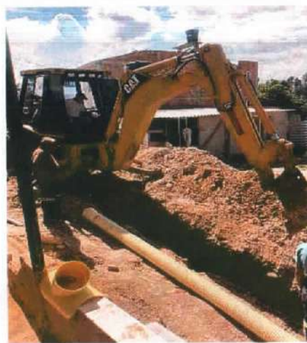
Descripción: Instalación de tubería Novafort de 8" sanitaria Monserrate Alto
