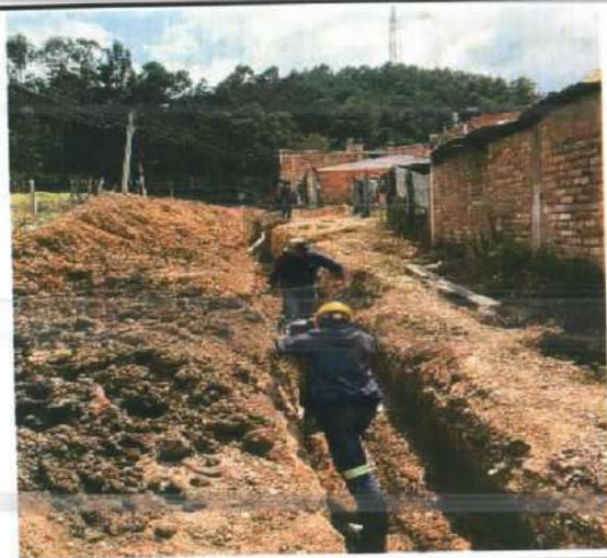
Descripción: Compactación de material de afirmado en zanja sobre red sanitaria, Santa Lucía
