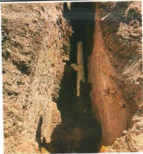
Descripción: Relleno con material de afirmado sobre tubería novafort 8" Monserate Alto
