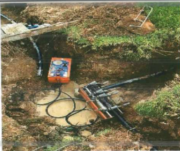
Descripción: Termofusiones para instalación de portabridas y válvulas purga, Villa del Sol
