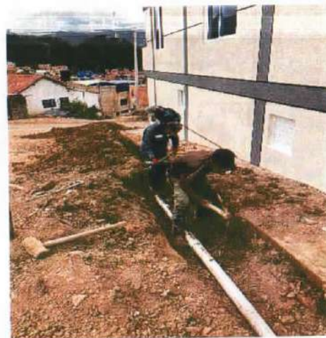
Descripción: Excavación Manual para red de acueducto Villa del Sol
