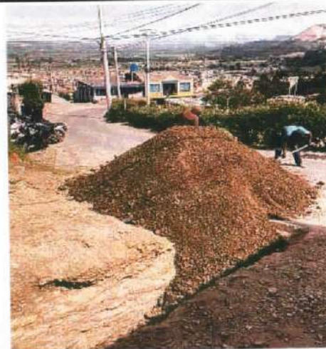
Descripción: Material de afirmado para su adecuada distribución sobre tubería y posterior compactación, Monserrate Alto
