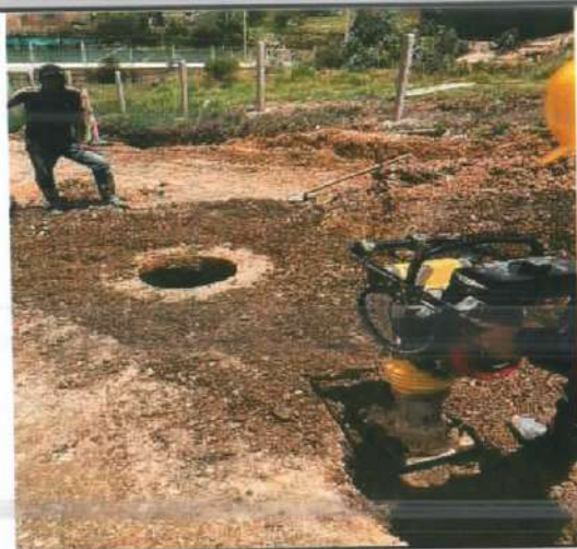
Descripción: Compactación con canguro en contorno al pozo nuevo, Santa Lucía
