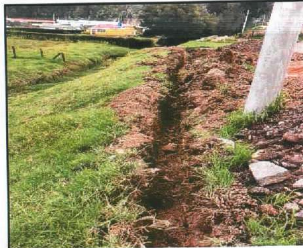
Descripción: Apertura e zanja para red de acueducto, Villa del Sol
