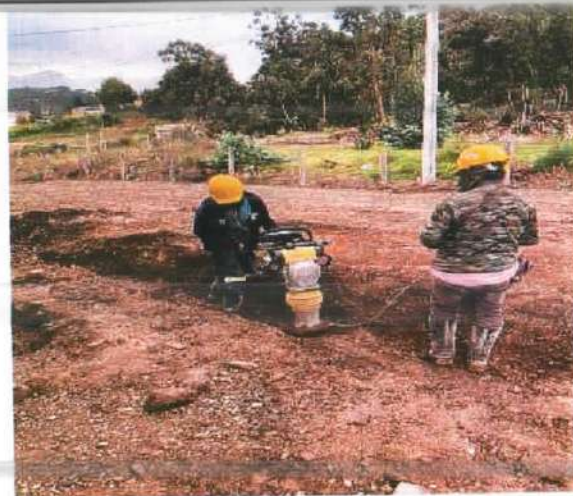
Descripción: Compactación con canguro en zanja de material de afirmado, Santa Lucía
