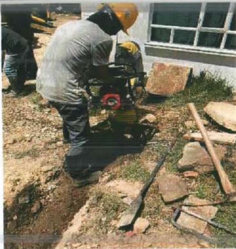
Descripción: Compactación con zapata vibratoria en conexión domiciliaria, Monserrate Alto
