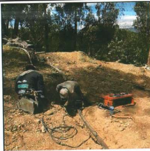
Descripción: Termofusiones para red de acueducto Monserrate Bajo
