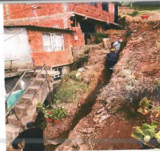
Descripción: Excavación manual para lograr profundidad a la red sanitaria, Monserrate Bajo
