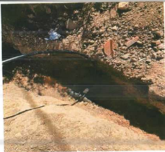
Descripción: Conexión domiciliaria con collarín, Monserrate Alto
