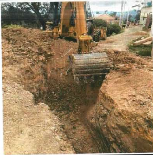
Descripción: Excavación mecánica para pozo de inspección sanitario, Monserrate Alto
