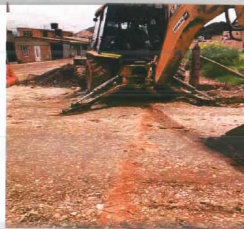
Descripción: Localización y replanteo para excavación de sumidero, Santa Lucía
