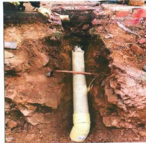
Descripción: Conexión domiciliaria hasta caja de inspección Monserrate Bajo
