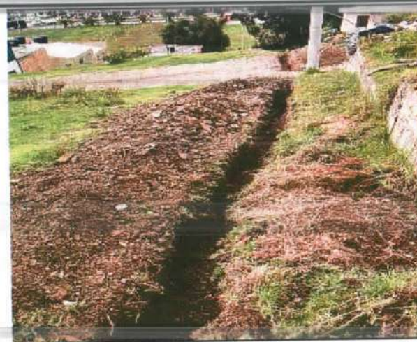
Descripción: Excavación manual de zanja para red de acueducto, Villa del Sol
