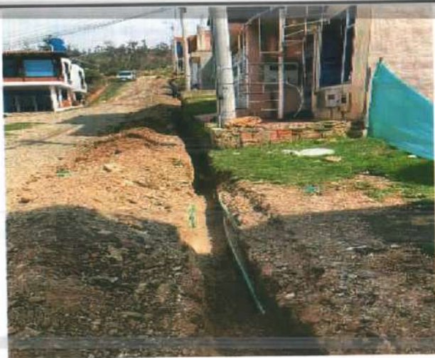
Descripción: Zanja para red de acueducto, Villa del sol
