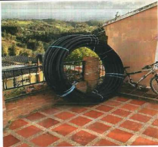
Descripción: Suministro de tubería en polietileno de 2", Monserrate Alto
