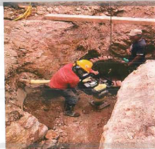
Descripción: Compactación de material de afirmado con zapata vibratoria Monserrate Alto
