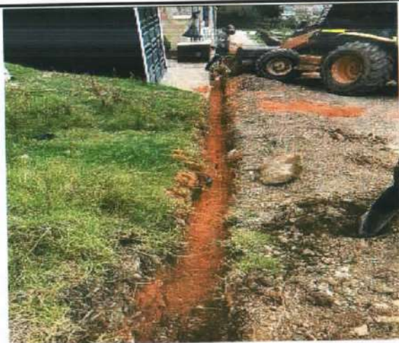
Descripción: Relleno con arena de peña sobre manguera de polietileno, Villa del sol
