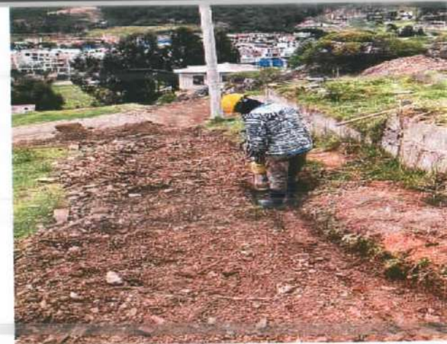
Descripción: Compactación con canguro en material de excavación, Villa del Sol
