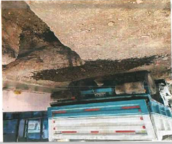
Descripción: Material de afirmado para su posterior compactación sobre tubería Sanitaria Monserrate Alto
