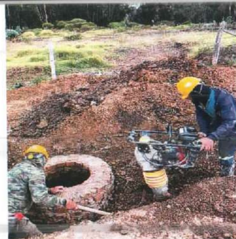
Descripción: Compactación con canguro en contorno al pozo nuevo, Santa Lucía
