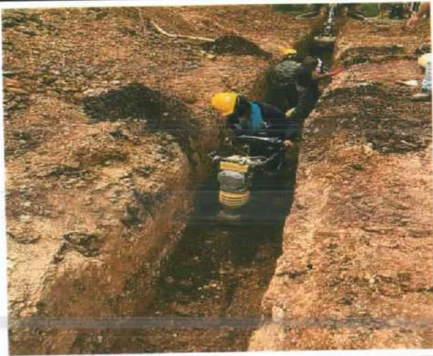
Descripción: Compactación con canguro en zanja de material de afirmado, Santa Lucía
