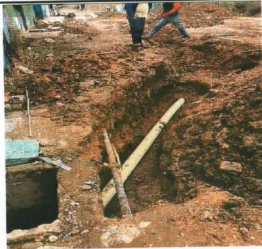
Descripción: Conexión domiciliar a caja de inspección, Santa Lucía
