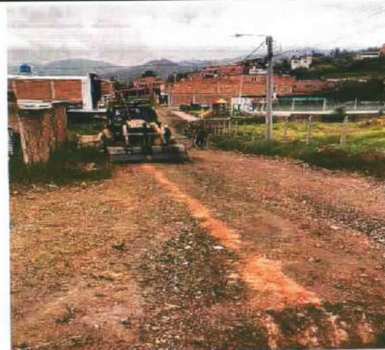
Descripción: Localización y replanteo de red de alcantarillado Santa Lucía
