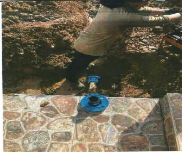
Descripción: Instalación de brida universal, Villa del sol
