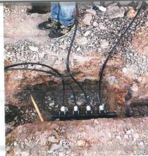
Descripción: Derivaciones con collarines para puntos de acueducto nuevos, Monserrate Alto
