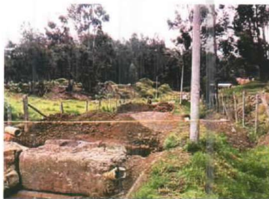
DESCRIPCIÓN: SEÑALIZACION OBRA
