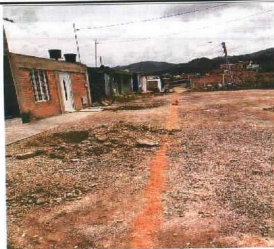
Descripción: Replanteo de red principal sanitaria Santa Lucía
