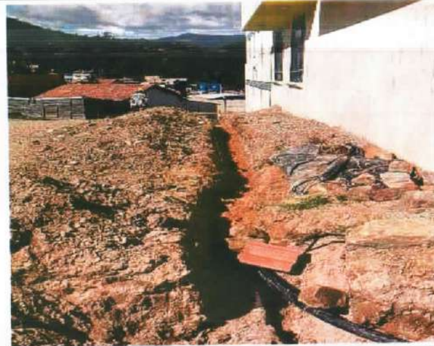
Descripción: Relleno con arena sobre manguera de polietileno, Villa del Sol
