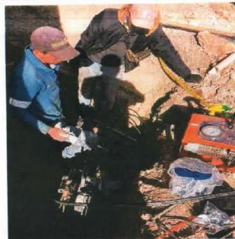
Descripción: Termofusiones para red de acueducto, Monserrate Alto
