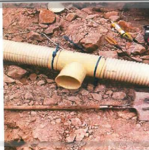
Descripción: Colocación de silla tee en tubería sanitaria de 8", Monserrate alto
