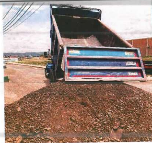
Descripción: Material de afirmado para relleno sobre red sanitaria, Santa Lucía
