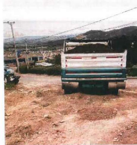
Descripción: Material de afirmado para el reffeno y su posterior compactación, Monserrate Alto
