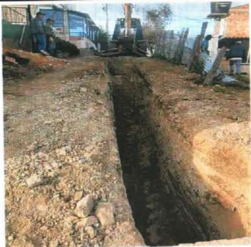
Descripción: Apertura de zanja de acuerdo a profundidades establecidas Monserrate Alto
