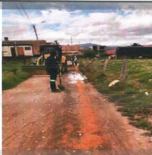
Descripción: Localización y replanteo de red de alcantarillado pluvial, Prados Norte
