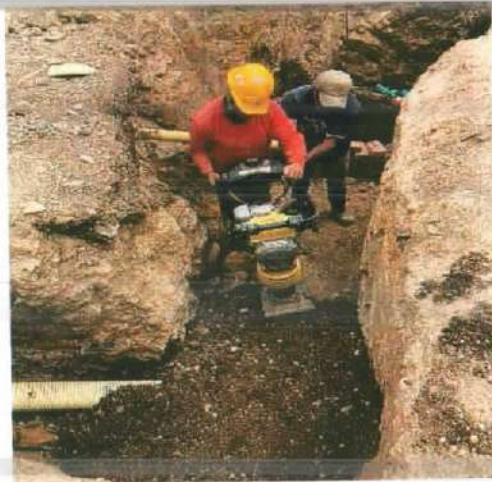
Descripción: Compactación de material de afirmado con zapata vibratoria Monserrate Alto
