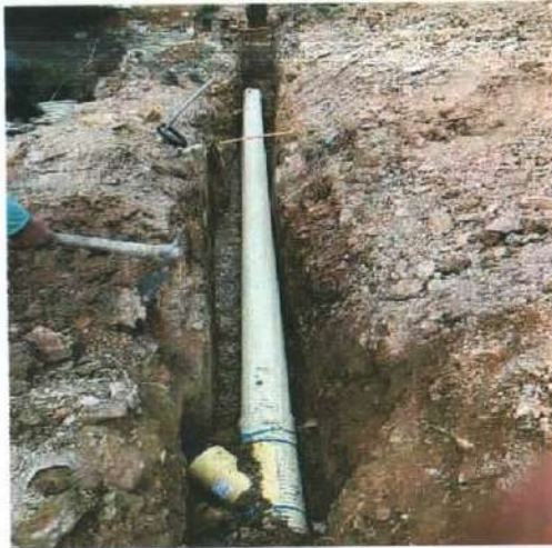
Descripción: Instalación de red de alcantarillado sanitario de 8", con conexión domiciliaria, Monserrate Bajo
