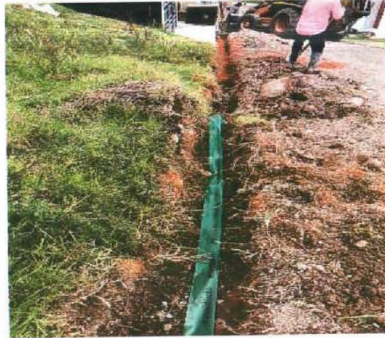
Descripción: Instalación de cinta de demarcación de red de acueducto, Villa del Sol
