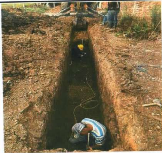
Descripción: Trazo de niveles para colocación de tubería sanitaria, Santa Lucía
