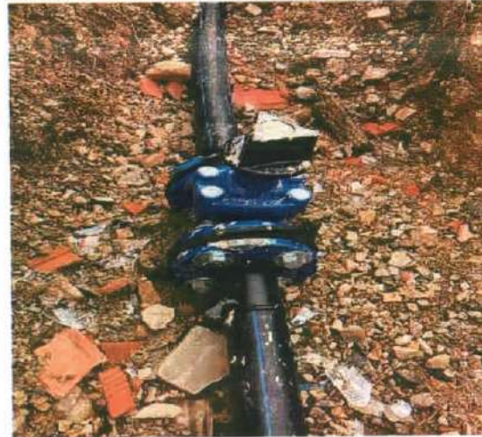
Descripción: Instalación de válvula, Villa del sol
