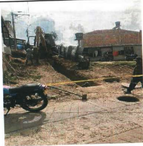
Descripción: Señalización de obra de alcantarillado Monserrate Alto
