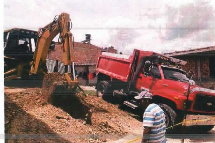
Descripción: Retiro de material producto de la excavación Monserrate Alto
