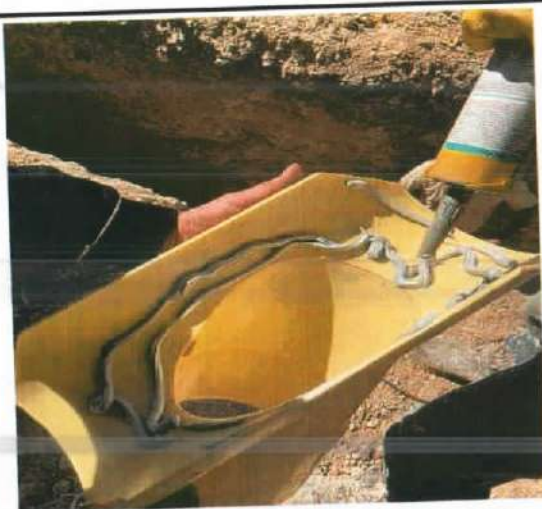
Descripción: Colocación de Silla yee 200mm x 160mm con su respectivo tubo de sika-flex Monserrate Alto
