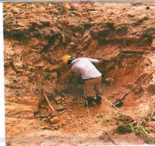
Descripción: Perfilada del terreno con martillo eléctrico para construcción de pozo Monserrate Bajo
