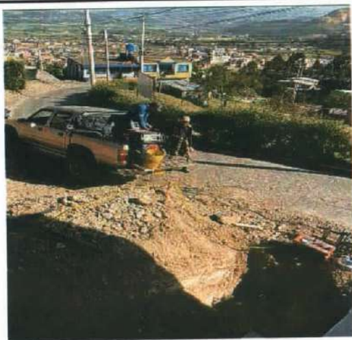
Descripción: Equipo de termofusión para instalación de válvula inicial, Monserrate Alto
