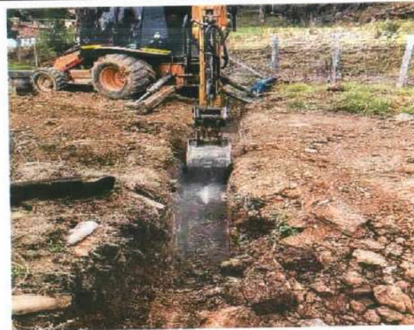
Descripción: Excavación mecánica para red pluvial de 16", Santa Lucía
