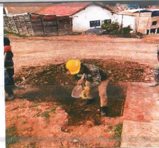
Descripción: Apiques para identificación de redes de agua y gas, Villa del sol
