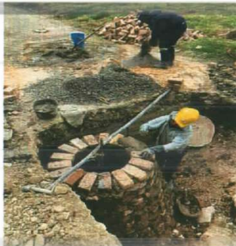
Descripción: Construcción de pozo de inspección pluvial Prados Norte
