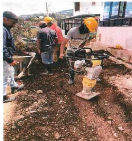
Descripción: Compactación con zapata vibratoria de material de afirmado, Monserrate Alto
