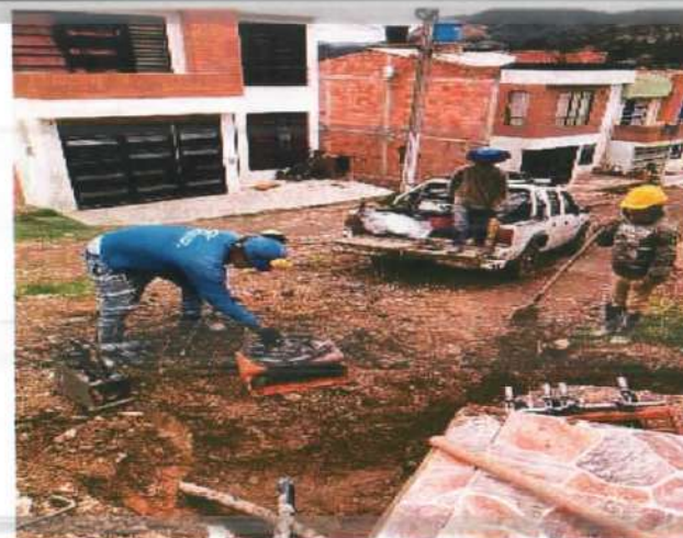
Descripción: Termofusiones para instalación de portabridas y válvulas purga, Villa del Sol
