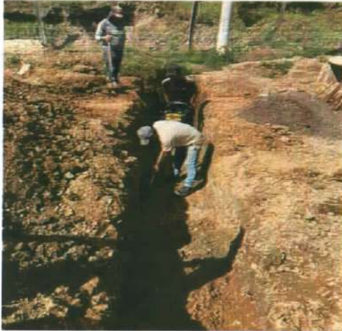
Descripción: Perfilada y nivelación de excavación para sumidero Santa Lucía
