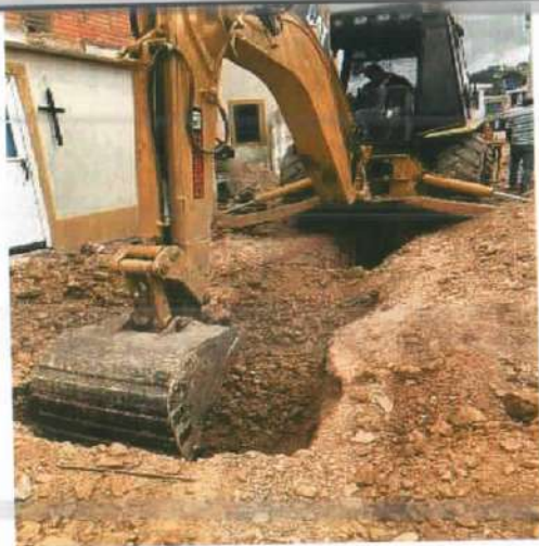
Descripción: Excavación mecánica para la elaboración de pozo de inspección, Monserrate Alto
