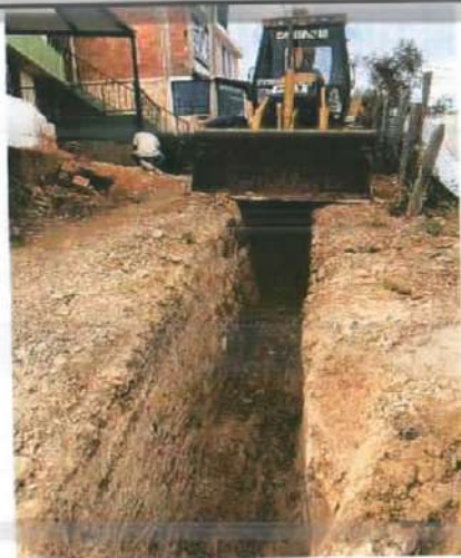
Descripción: Excavación mecánica Monserrate Alto
