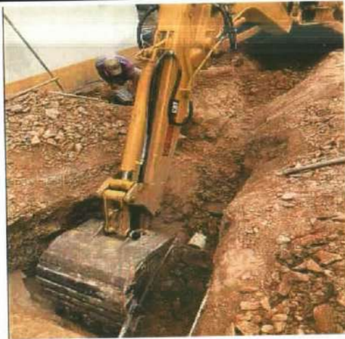
Descripción: Excavación mecánica para pozo de inspección, Monserrate Alto
