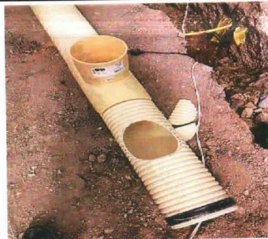
Descripción: Instalación de silla tee en tubería sanitaria de 8" Monserrate Alto
