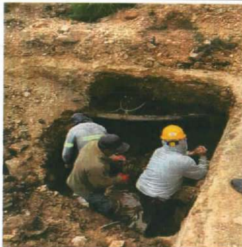
Descripción: Excavación manual para construcción de pozo Prados Norte
