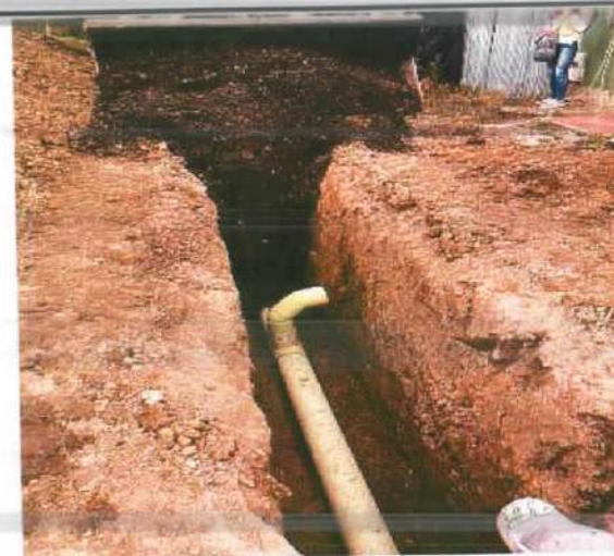
Descripción: Conexión domiciliaria con silla tee y codo hasta caja, Santa Lucía
