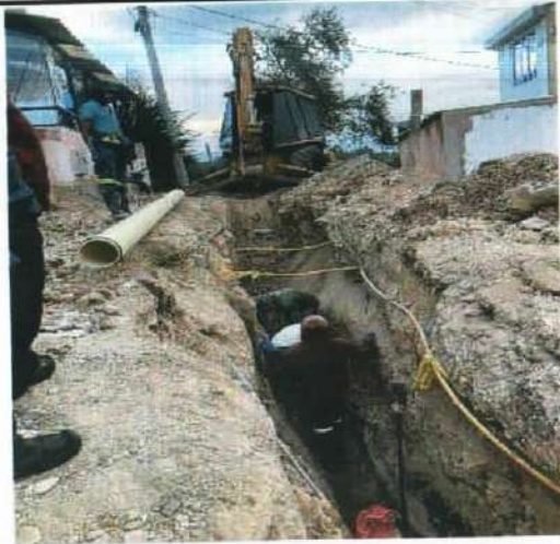
Descripción: Excavación manual para perfilar el terreno y lograr pendiente adecuada, Monserrate Alto
