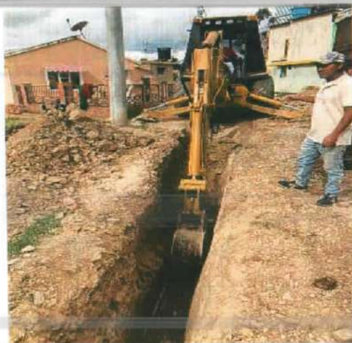
Descripción: Excavación mecánica en material conglomerado y roca, Monserrate Alto
