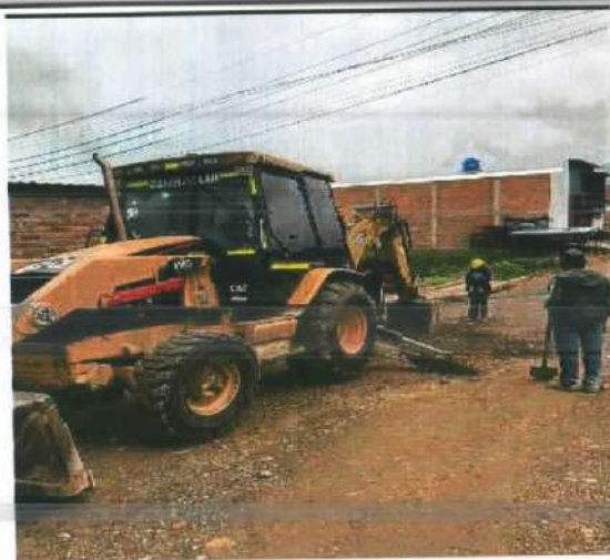
Descripción: Excavación mecánica red sanitaria Santa Lucía
