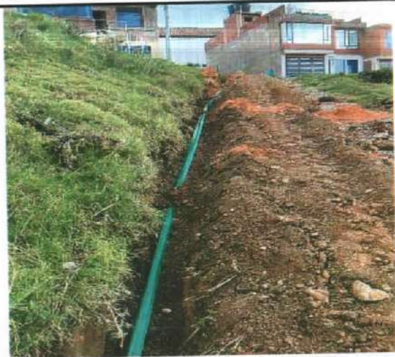
Descripción: Instalación de cinta de demarcación de red de acueducto, Villa del Sol
