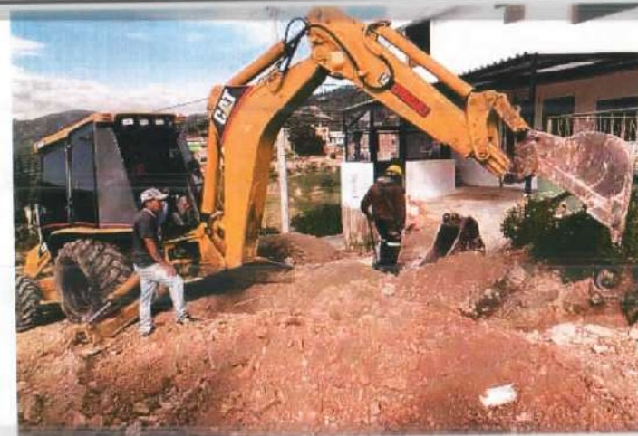
Descripción: Excavación mecánica para red sanitaria, Monserrate Alto
