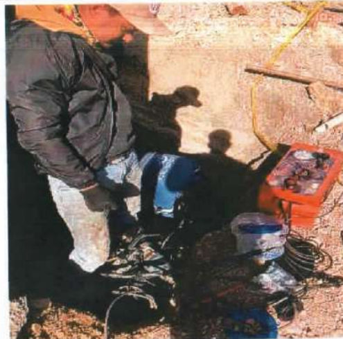
Descripción: Termofusiones red de acueducto Monserrate Alto
