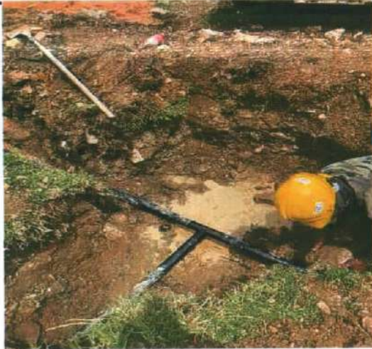
Descripción: Tee en polietileno de 2", Villa del sol
