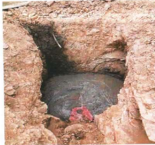
Descripción: Piso en concreto para pozo de inspección, Monserrate Alto
