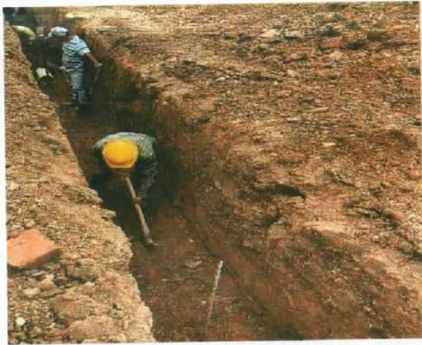
Descripción: Excavación manual para perfilado y nivelación del terreno para dar pendiente, Santa Lucía
