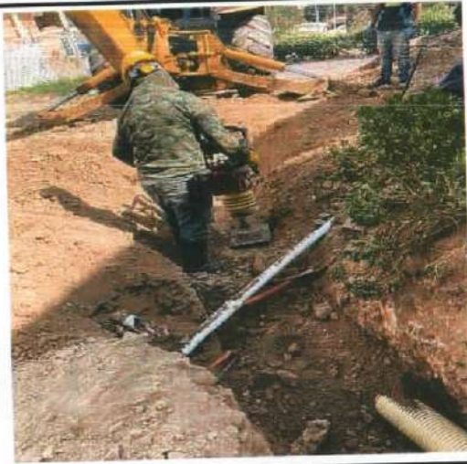
Descripción: Compactación con zapata vibratoria tipo canguro, Monserrate Alto
