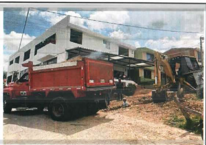
Descripción: Retiro de material producto de la excavación en Monserrate Alto
