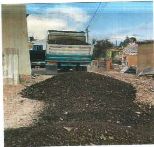
Descripción: Material de afirmado para relleno sobre manguera de polietileno, Monserrate alto
