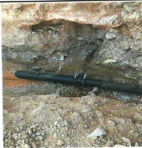
Descripción: Conexión domiciliaria con collarín de derivación 2x1/2", Monserrate Alto
