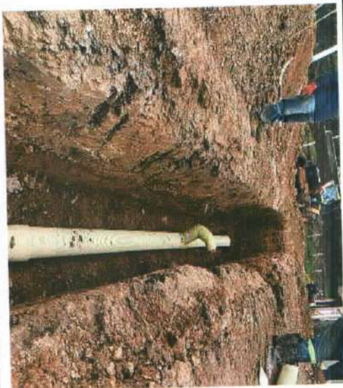
Descripción: Tendido de red sanitaria de 8" y conexión domiciliaria con silla tee y codo, Santa Lucia
