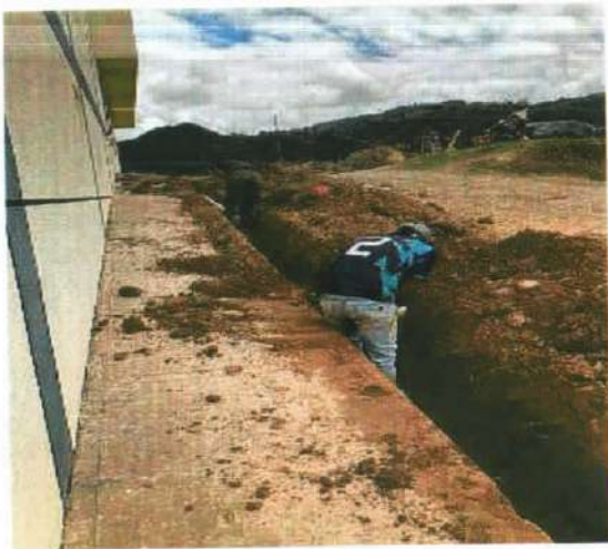
Descripción: Excavación Manual para red de acueducto Villa del Sol
