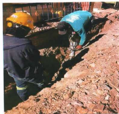
Descripción: Excavación en roca con martillo eléctrico para trazado de red de acueducto, Monserrate Alto
