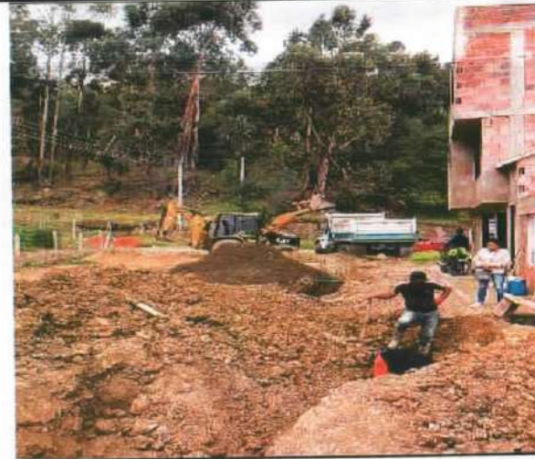
Descripción: Retiro de material producto de excavación, Santa Lucía
