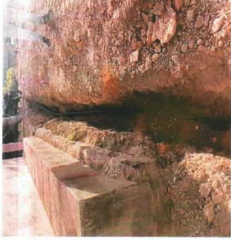
Descripción: Tendido de manguera en polietileno en zanja, Monserrate Alto
