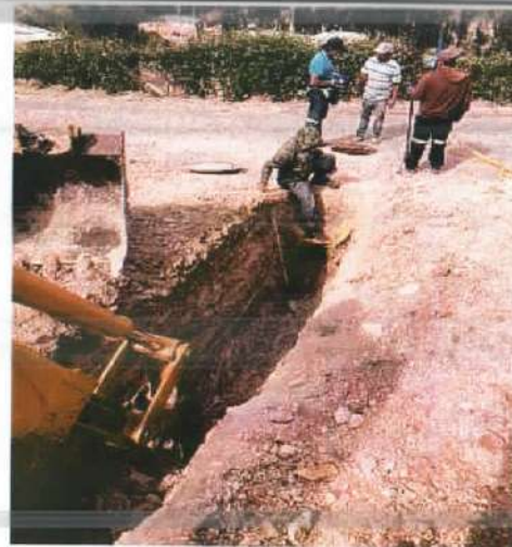
Descripción: Excavación mecánica para red sanitaria, de acuerdo a profundidades de pozos y pendiente de tubería, Monserrate alto
