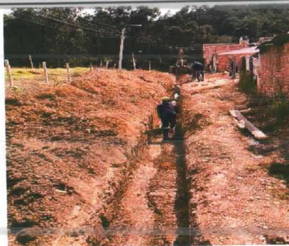
Descripción: Compactación de material de afirmado en zanja sobre red sanitaria, Santa Lucía
