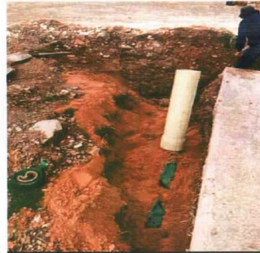
Descripción: Relleno con arena y cinta de señalización en área de válvulas y camisa para mariposa de válvula, Villa del sol
