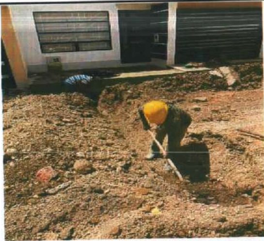
Descripción: Excavación Manual para conexión domiciliaria, Villa de Sol
