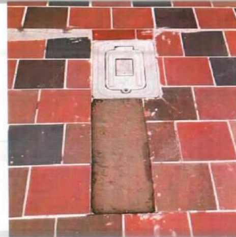
Descripción: Resane de andenes debido a la conexión domiciliaria, Villa del Sol
