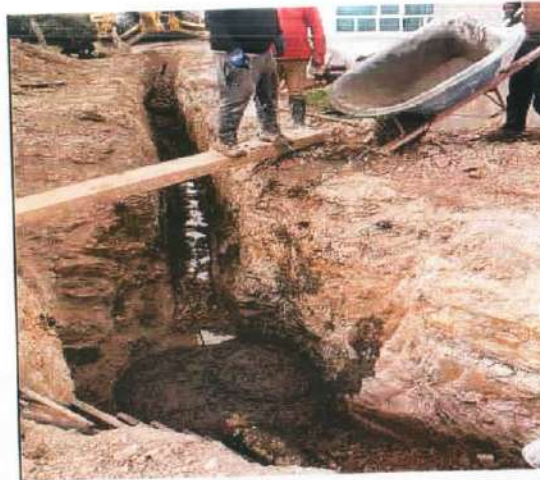
Descripción: Fundida del piso del pozo con concreto de acuerdo a niveles previamente tomados, Monserrate Alto
