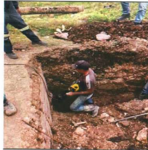
Descripción: Demolición de muro de concreto reforzado con martillo eléctrico, Prados Norte
