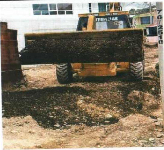
Descripción: Relleno con material de afirmado para posteriormente ser compactado, Monserrate Alto
