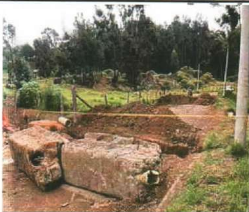
DESCRIPCIÓN: SEÑALIZACION OBRA
