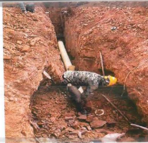
Descripción: Excavación manual para perfilado y nivelado de la excavación para pozo sanitario, Monserrate Alto
