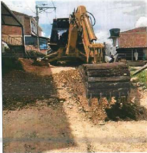
Descripción: Excavación mecánica Monserrate Alto
