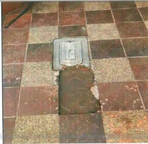
Descripción: Resane de andenes debido a la conexión domiciliaria, Villa del Sol
