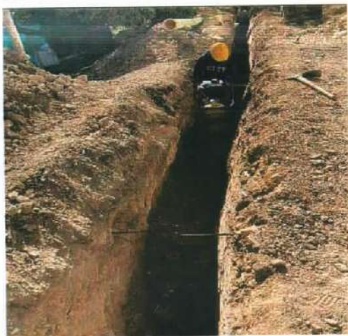
Descripción: Compactación con zapata vibratoria en zanja sobre tubería sanitaria y material de afirmado, Monserrate Alto
