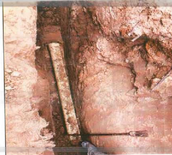
Descripción: Instalación de tubería sanitaria de 8", Monserrate Alto
