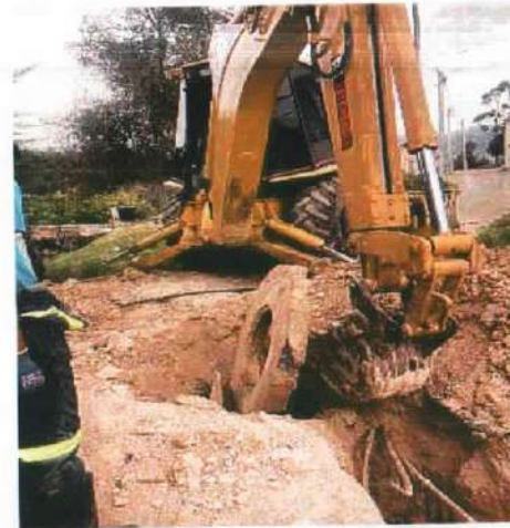
Descripción: Demolición de pozo existente, Monserrate alto
