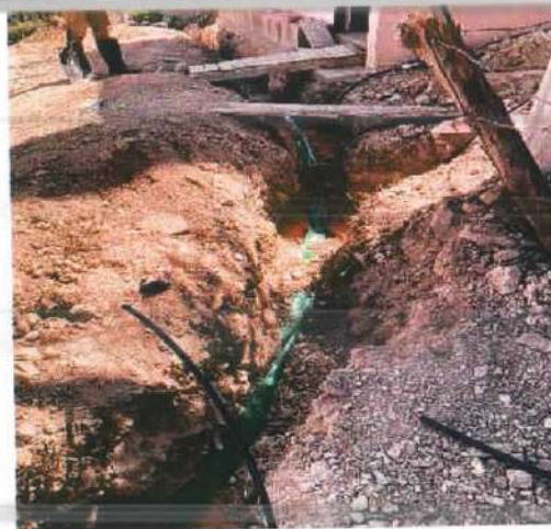
Descripción: Instalación de cinta de demarcación red de acueducto, Monserrate Alto
