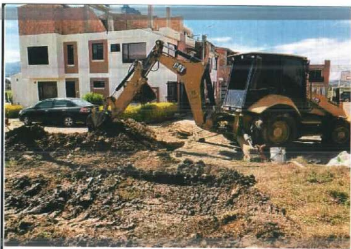
Descripción: Relleno con Maquinaria amarilla Sector Prados del Norte
