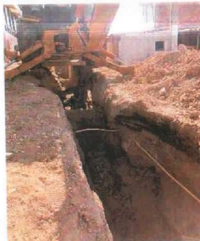
Descripción: Excavación mecánica e identificación de redes de gas Monserate Alto
