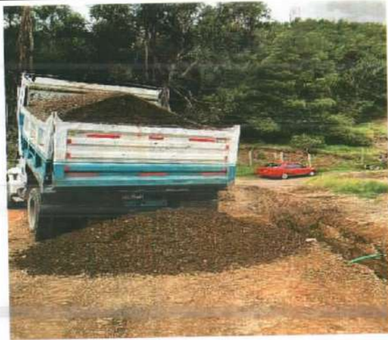
Descripción: Material de afirmado para relleno sobre red sanitaria, Santa Lucía
