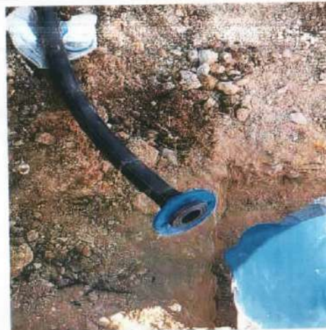
Descripción: Instalación de portabrida y brida loca de 2", Monserrate Alto
