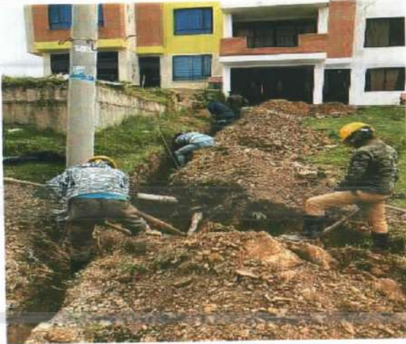
Descripción: Excavación manual en material conglomerado, Villa del Sol
