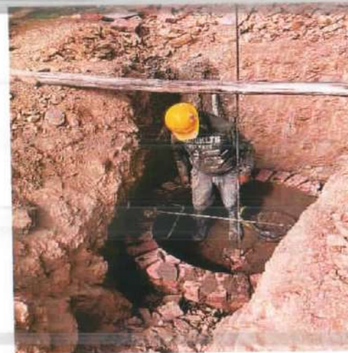
Descripción: Inicio con la construcción de pozo de inspección, Monserrate Alto
