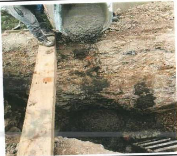
Descripción: Fundida de piso de pozo en concreto, Monserrate Alto
