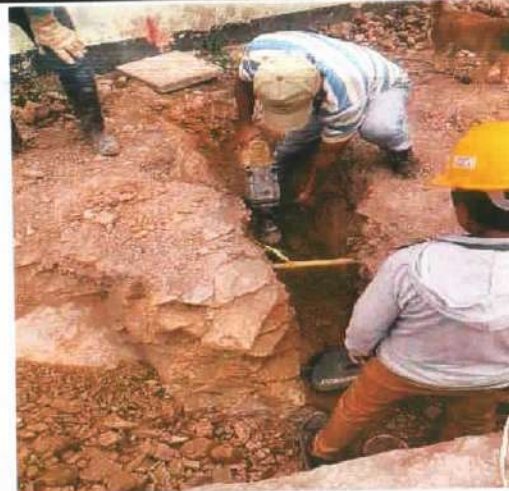
Descripción: Excavación con martillo eléctrico en roca para conexión domiciliaria hasta caja, Monserrate Alto
