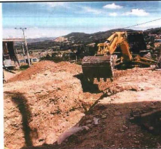
Descripción: Excavación mecánica en material conglomerado y roca, Monserrate Alto
