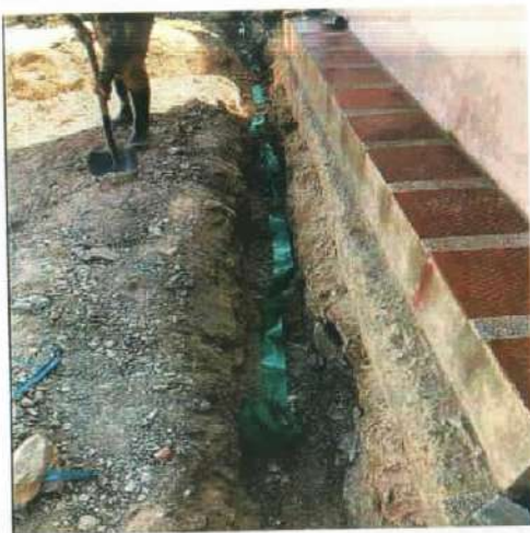
Descripción: Instalación de cinta de demarcación red de acueducto, Monserrate Alto
