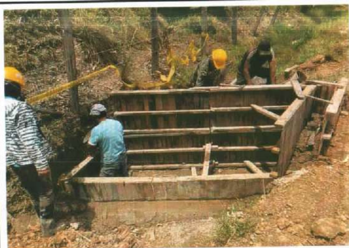
Descripción: Fundida de muro en concreto ciclópeo, Santa Lucía
