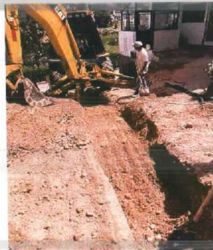
Descripción: Excavación mecánica Monserrate Alto
