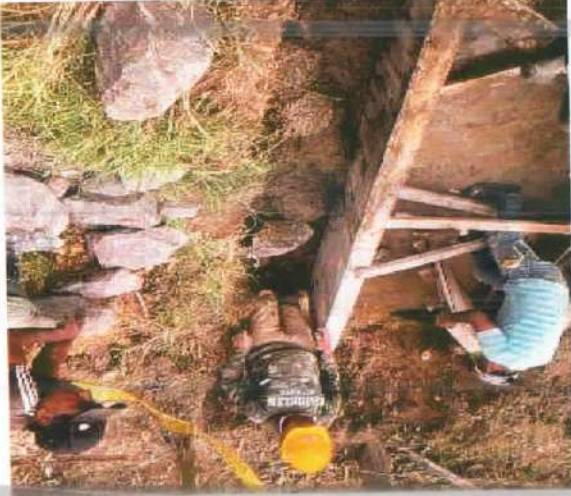
Descripción: Fundida de muro en concreto ciclópeo, Santa Lucía
