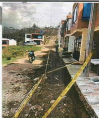
DESCRIPCIÓN: SEÑALIZACION OBRA
