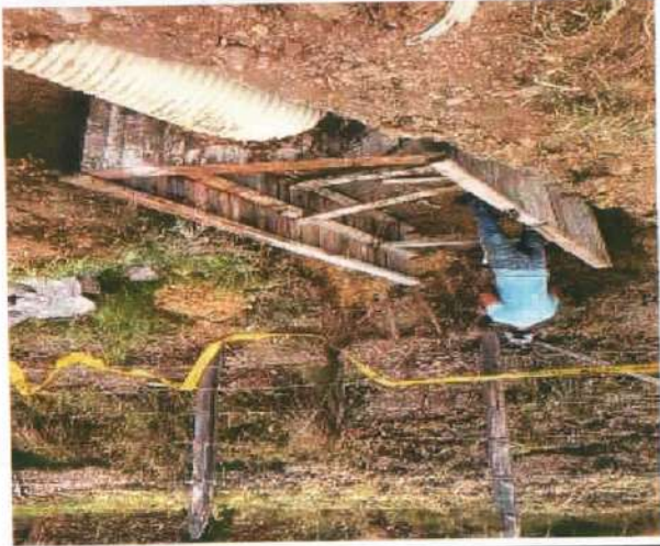
Descripción: Encofrado para muro ciclópeo, Santa Lucía
