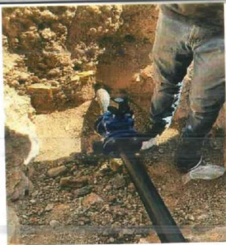
Descripción: Suministro e instalación de válvula 2", Monserrate Alto
