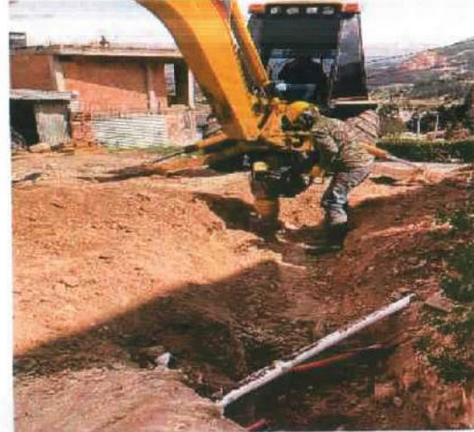
Descripción: Compactación de material de afirmado y material de excavación con zapata vibratoria, Monserrate Alto
