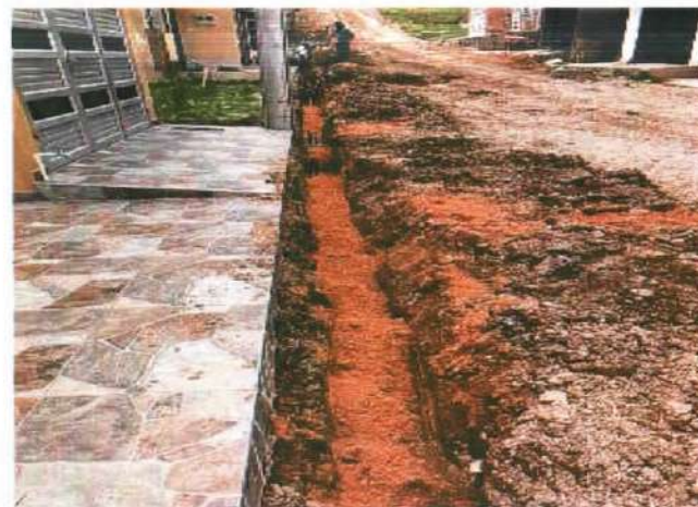
Descripción: Relleno con arena de peña sobre manguera de polietileno, Villa del Sol
