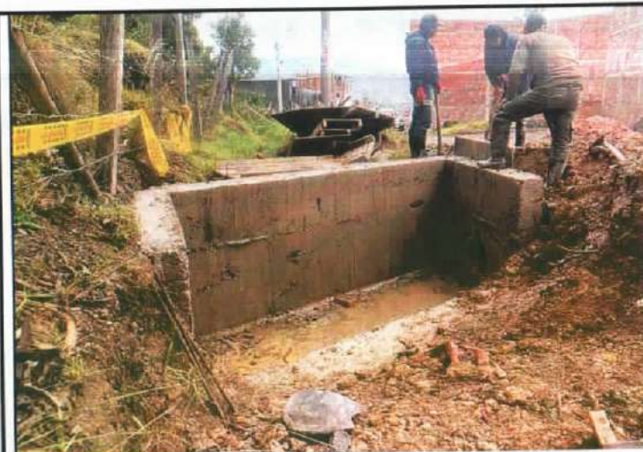
Descripción: Muro en concreto ciclópeo desencofrado, Santa Lucía
