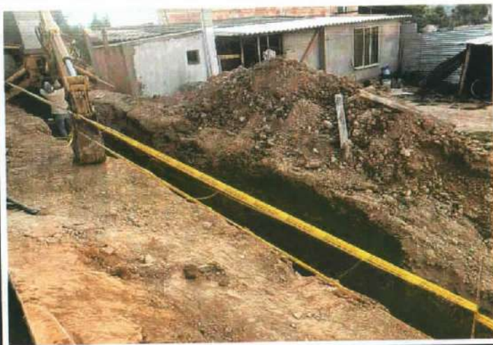
Descripción: Señalización de excavación para tubería sanitaria, Monserrate Alto
