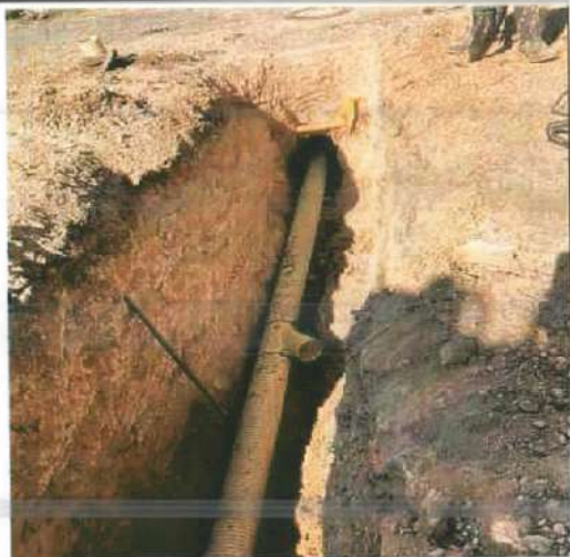
Descripción: Instalación de silla yee para posterior conexión domiciliaria Monserrate Alto
