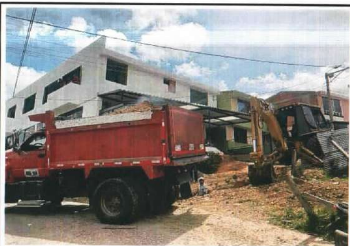
Descripción: Retiro de Material producto de excavación Monserrate Alto
