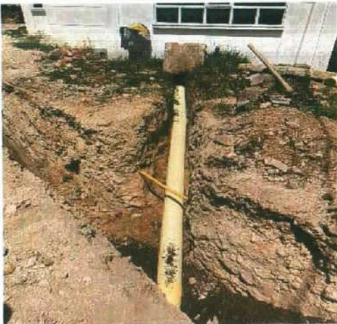
Descripción: Conexión domiciliaria hasta caja de Inspección, Monserrate Alto
