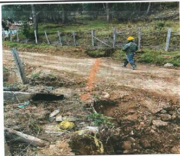
Descripción: Localización y replanteo de red pluvial de 16" Santa Lucía
