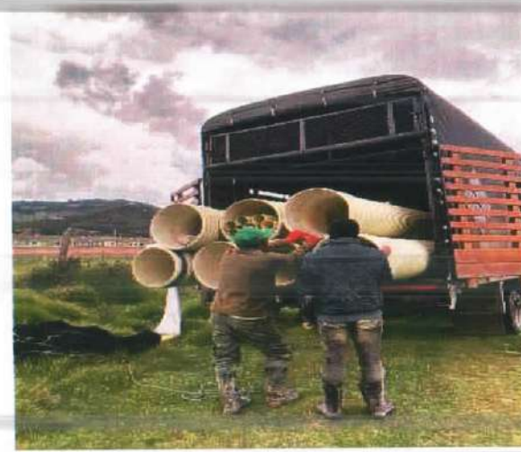
Descripción: Sumunistro de tubería pluvial de 20", Prados Norte
