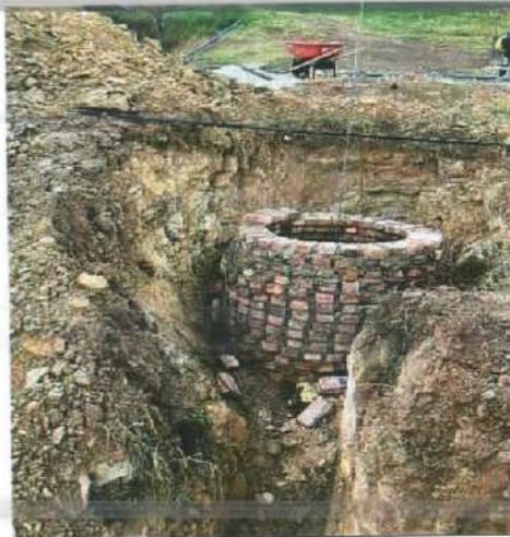
Descripción: Pozo de inspección Monserrate Bajo
