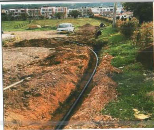
Descripción: Tendido de red de polietileno de 2", Villa del sol
