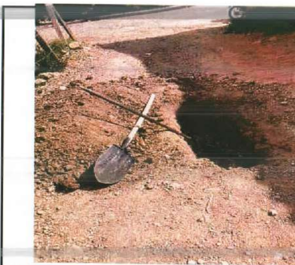
Descripción: Localización y replanteo de redes de gas y agua por medio de apiques en el sector de Monserrate Alto
