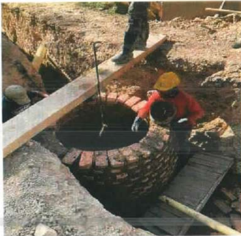
Descripción: Construcción de pozo de inspección Monserrate Alto
