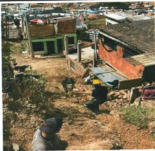
Descripción: Compactación con zapata vibratoria en pendiente pronunciada, Monserrate bajo
