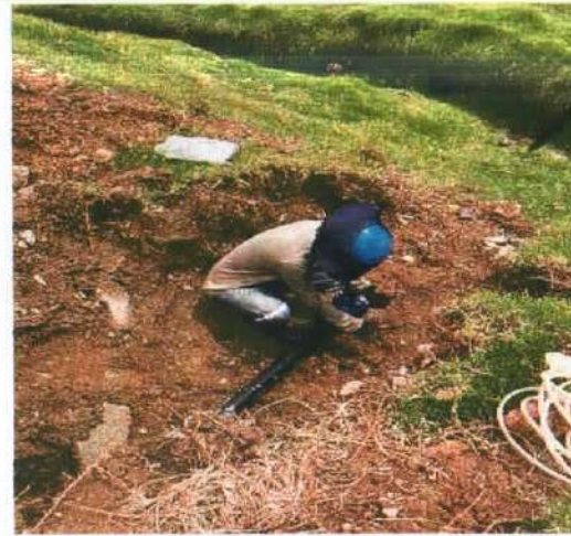
Descripción: Instalación de válvula purga hacia zanjón, Villa del sol
