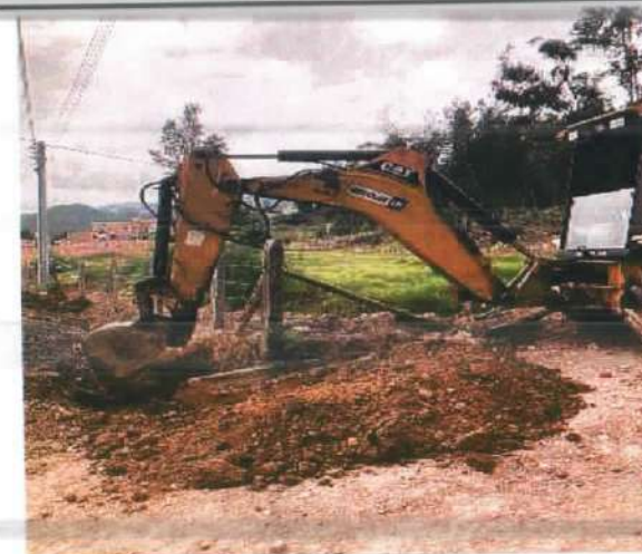
Descripción: Excavación mecánica para pozo pluvial, Santa Lucía
