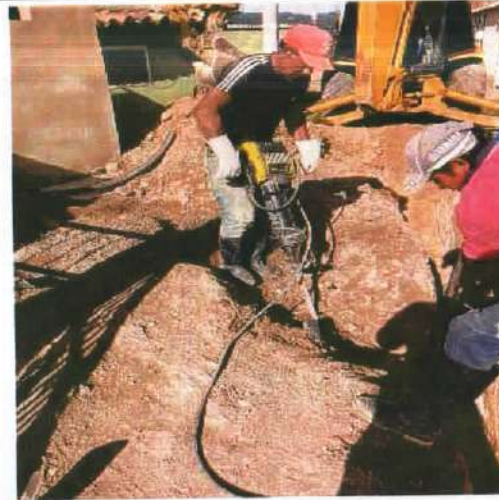
Descripción: Excavación manual en roca con martillo eléctrico, Monserrate Alto
