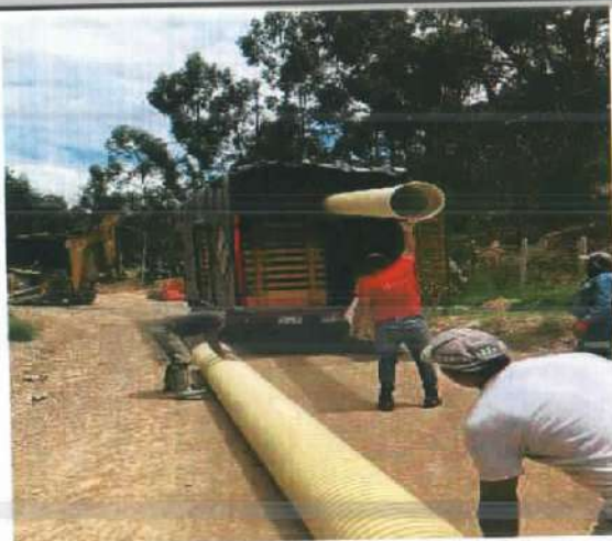
Descripción: Tubería de 16" para red pluvial, Santa Lucía
