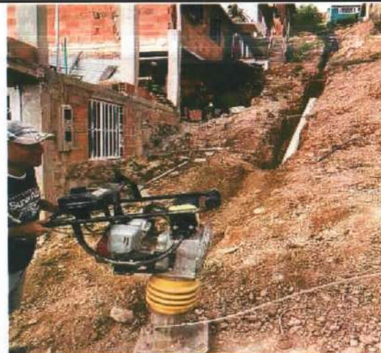
Descripción: Tendido de red sanitaria de 8" y compactación con zapata vibratoria, Monserrate Bajo
