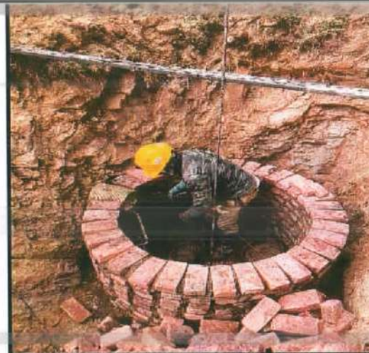
Descripción: Construcción de pozo sanitario Monserrate Bajo
