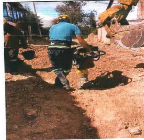
Descripción: Compactación con zapata vibratoria, Monserrate Alto
