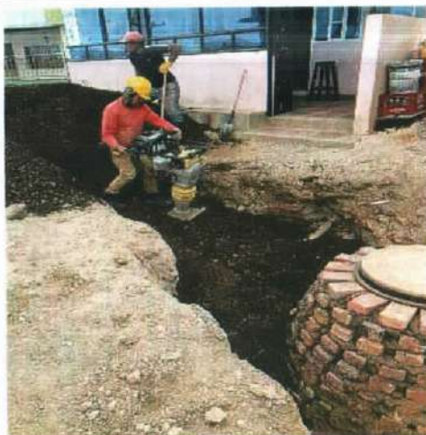
Descripción: Compactación con zapata vibratoria de material de afirmado, Monserrate Alto
