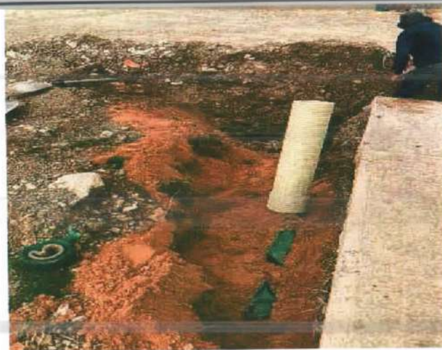
Descripción: Camisa para válvula inicial, Villa del sol
