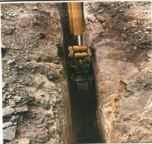
Descripción: Excavación mecánica en material de roca Monserrate Alto
