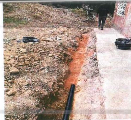
Descripción: Relleno con arena en red de acueducto, Monserrate Bajo
