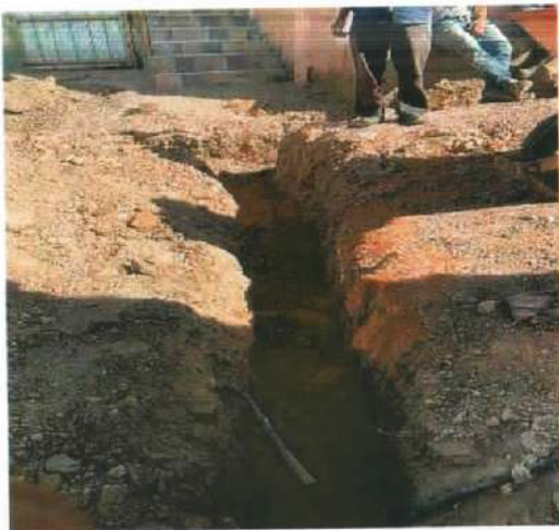
Descripción: Relleno con arena sobre manguera de polietileno, Monserrate Alto
