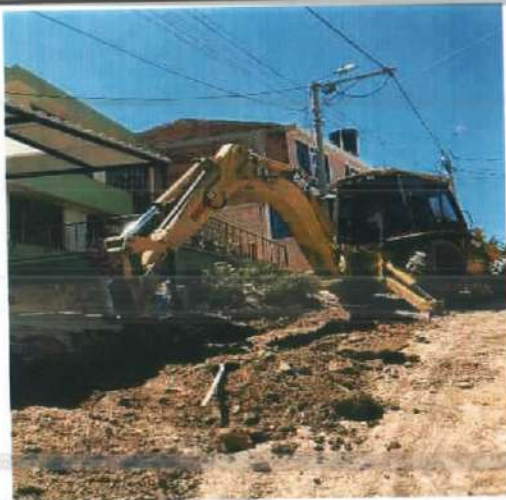
Descripción: Excavación mecánica de zanja para estendido de manguera de 2", Monserrate Alto
