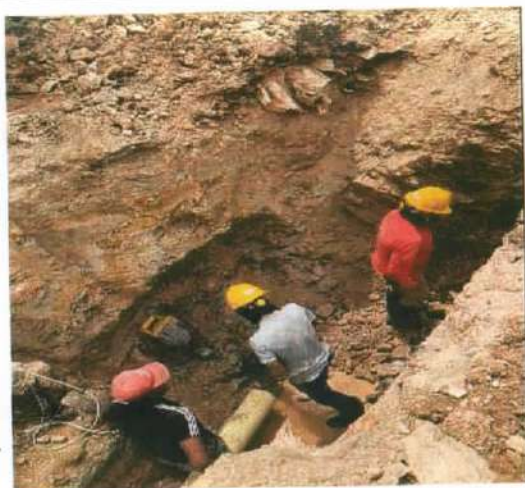
Descripción: Excavación manual en roca con martillo eléctrico, Monserrate Alto
