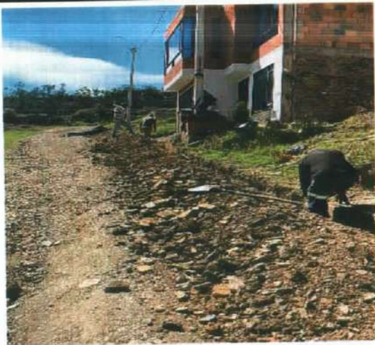
Descripción: Excavación manual en material conglomerado, Villa del Sol
