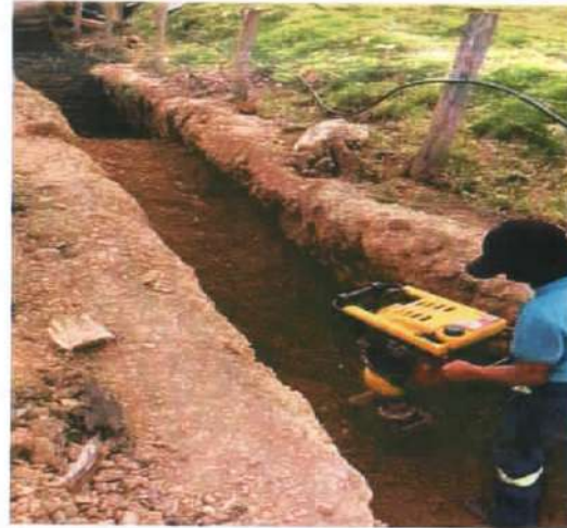
Descripción: Relleno con material de afirmado compactado sobre tubería de 20" Prados Norte
