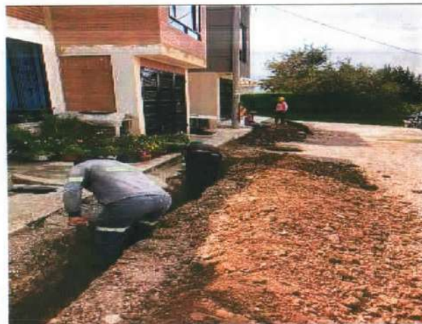
Descripción: Excavación manual en material conglomerado, Villa del sol
