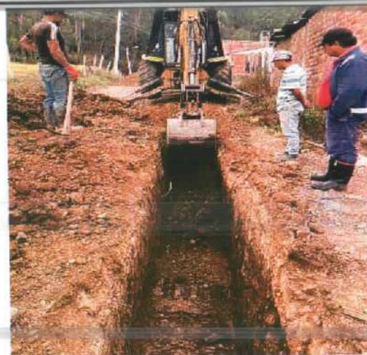
Descripción: Excavación mecánica red sanitaria Santa Lucía
