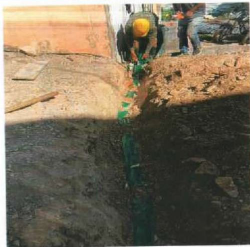
Descripción: Suministro de cinta para señalización de red de acueducto, Monserrate Alto
