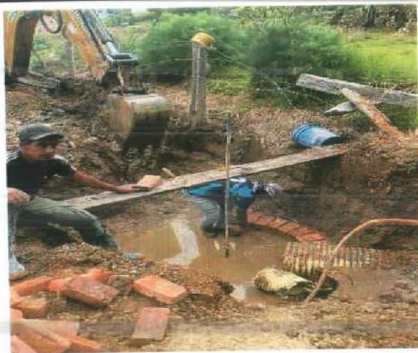
Descripción: Construcción de pozo pluvial, Santa Lucía
