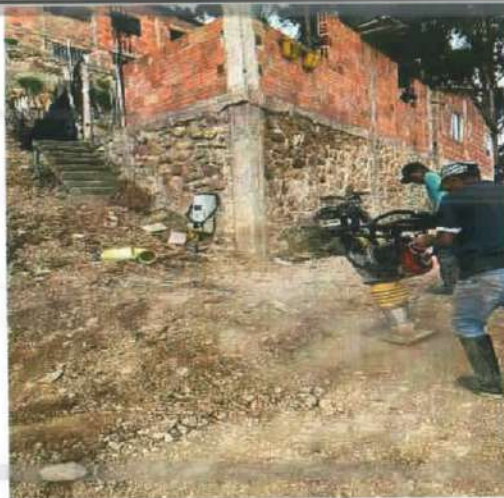
Descripción: Compactación con zapata vibratoria de material de afirmado y material común, Monserrate bajo
