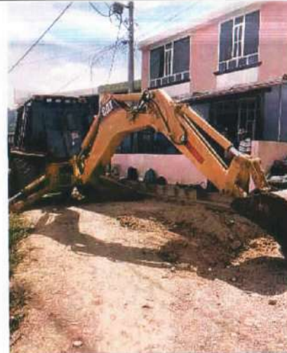
Descripción: Excavación Mecánica para la apertura de zanja para tubería sanitaria en Monserrate Alto
