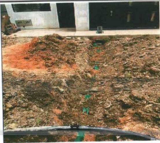
Descripción: Conexión domiciliaria con arena y cinta de demarcación, Villa del Sol
