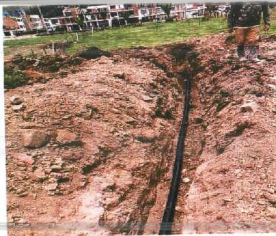
Descripción: Tendido de manguera de 2" em polietileno, Villa del Sol
