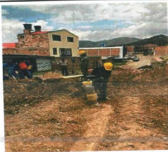
Descripción: Compactación con canguro sobre material de afirmado y material común, Santa Lucía
