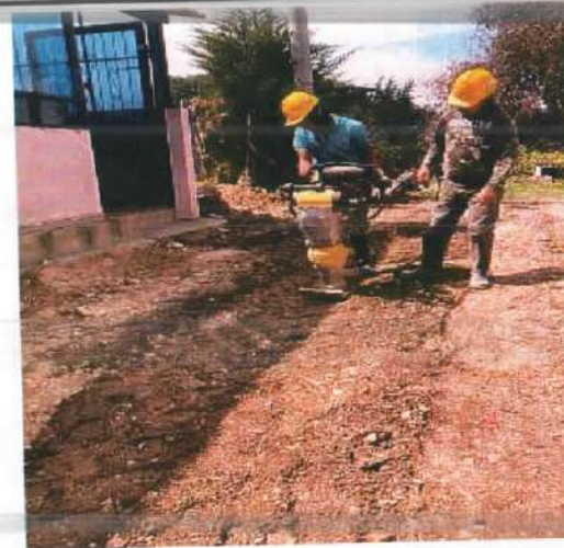
Descripción: Compactación con zapata vibratoria tipo canguro de material de afirmado, Monserrate Alto
