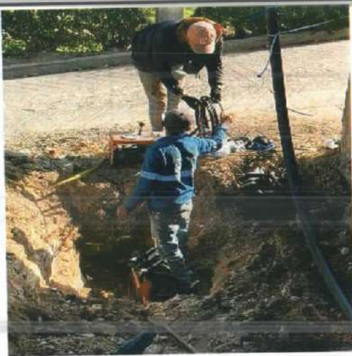
Descripción: Termofusiones en red de acueducto, Monserrate Alto
