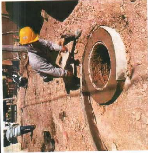
Descripción: Fundida de aro de pozo sanitario, Monserrate Alto
