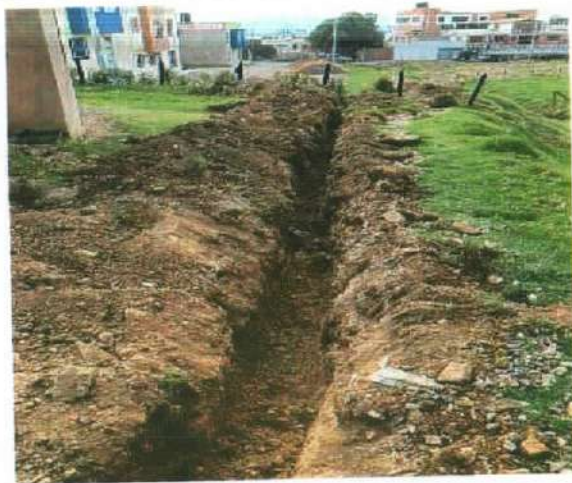
Descripción: Apertura e zanja para red de acueducto, Villa del Sol
