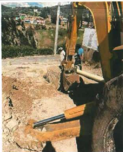
Descripción: Excavación mecánica Monserrate Alto
