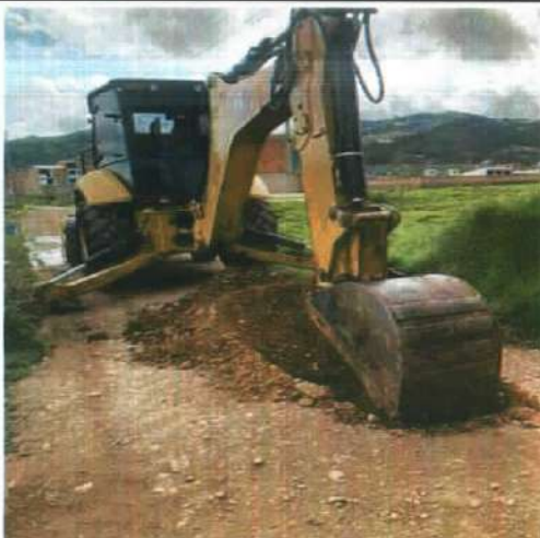
Descripción: Excavación mecánica en material común Prados Norte
