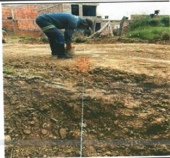
Descripción: Localización y replanteo para tubería pluvial de 16", Santa Lucía
