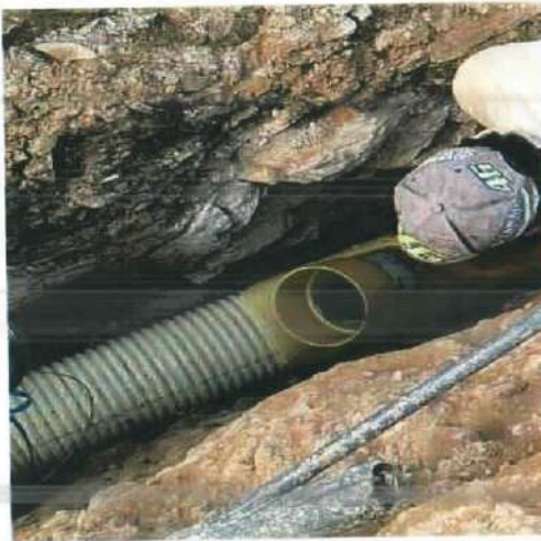
Descripción: Instalación de silla yee para conexión domiciliaria a caja de inspección, Moserrate Alto
