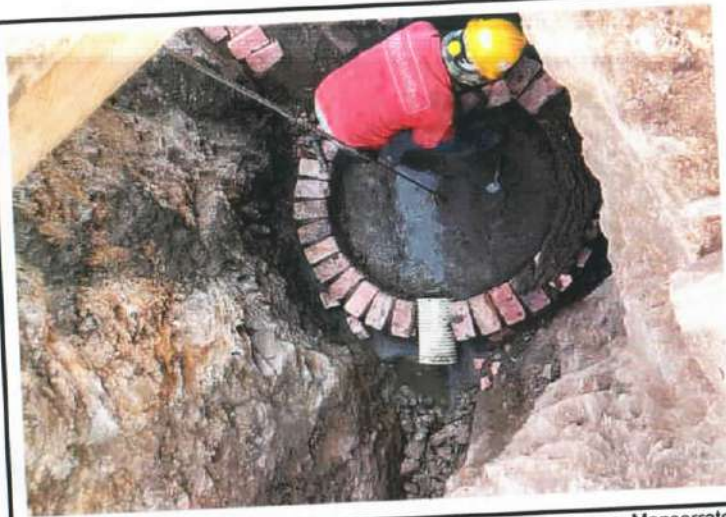
Descripción: Construcción de primeras hiladas de ladrillo para pozo, Monserrate Alto
