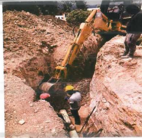
Descripción: Excavación mecánica para pozo de inspección sanitario, Monserrate Alto
