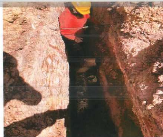
Descripción: Instalación de silla yee para conexión domiciliaria, Monserrate Alto
