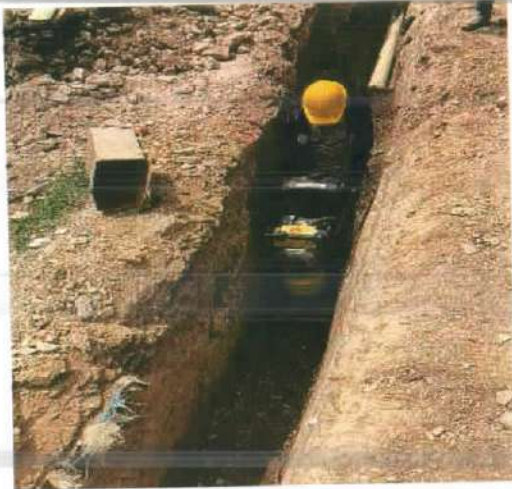
Descripción: Compactación de material de afirmado sobre tubería de 8" Monserrate Alto
