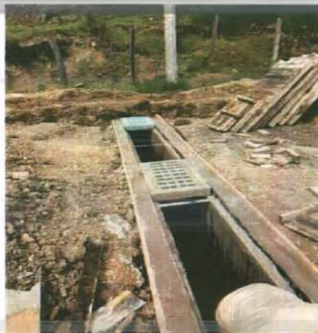
Descripción: Sumidero transversal en Santa Lucía
