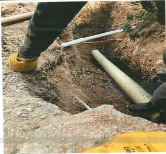
Descripción: Instalación de tubería sanitaria de 6" para conexión domiciliaria a caja de inspección, Monserrate Alto
