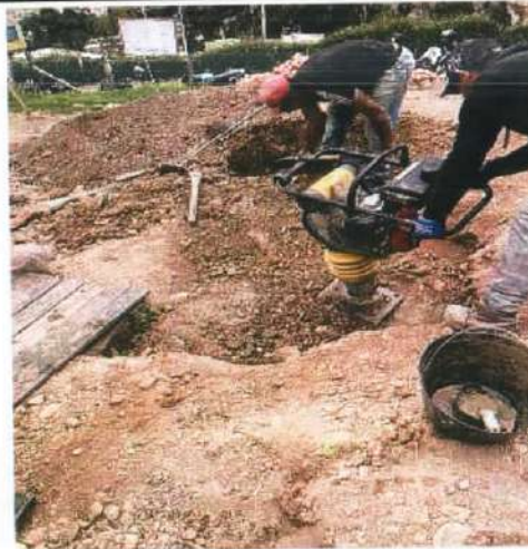
Descripción: Compactación con zapata vibratoria en conexión domiciliar, Monserrate Alto
