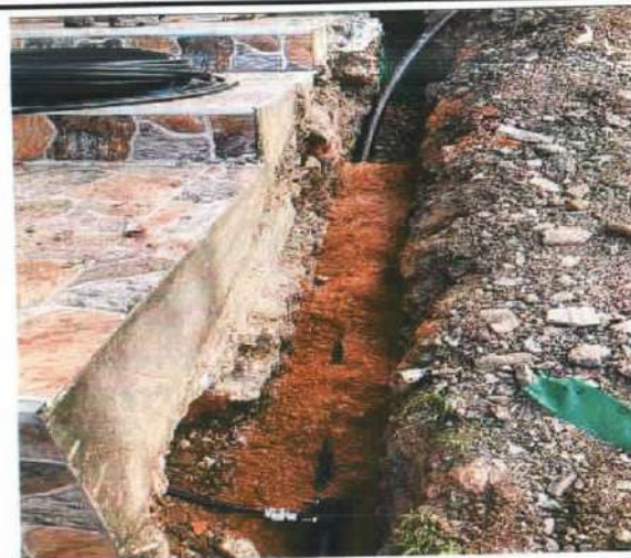
Descripción: Relleno con arena de peña y conexión domiciliar, Villa del sol
