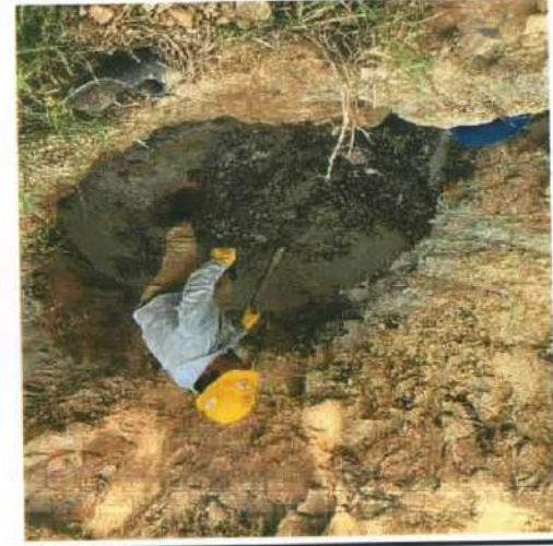
Descripción: Fundida del piso en concreto del pozo, Monserrate Bajo
