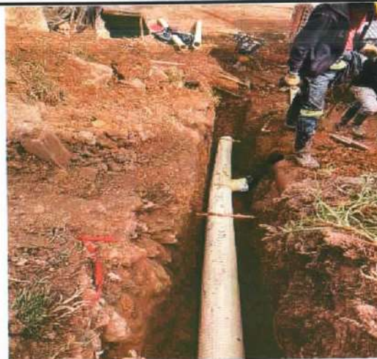
Descripción: Conexión domiciliar por medio de silla tee Monserrate Bajo
