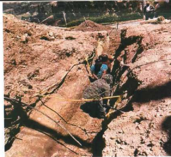
Descripción: Perfilado de manera manual en material de conglomerado y roca para tubería sanitaria 8", Monserrate Alto
