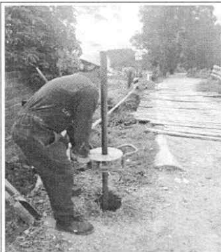
Ilustración 6. Perforación manual Sondeo 1
