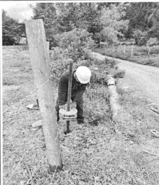
Ilustración 7. Perforación manual Sondeo 2
