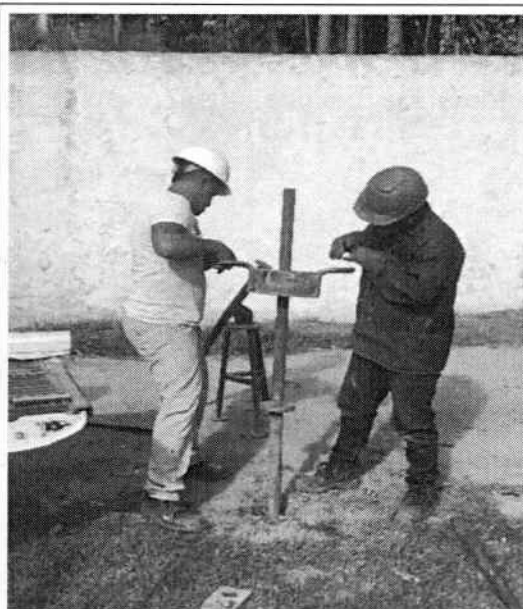
Ilustración 7. Perforación manual Sondeo 2
