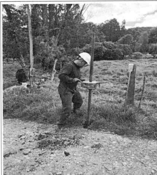
Ilustración 6. Perforación manual Sondeo 1
