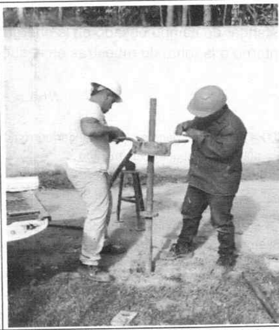
Ilustración 7. Perforación manual Sondeo 2
