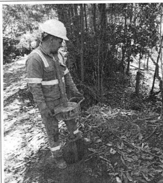
Ilustración 6. Perforación manual Sondeo 1
