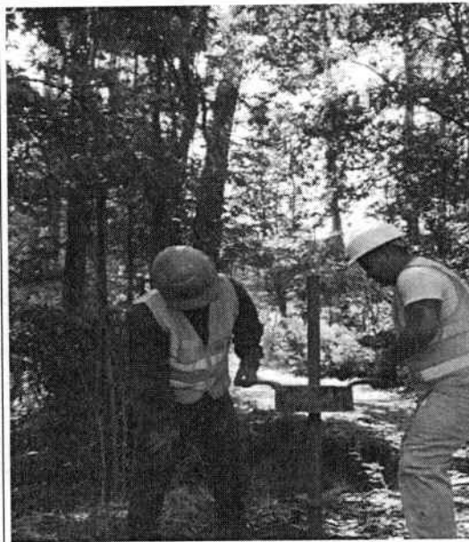
Ilustración 7. Perforación manual Sondeo 2
