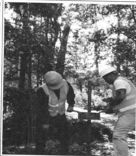
Ilustración 7. Perforación manual Sondeo 2
