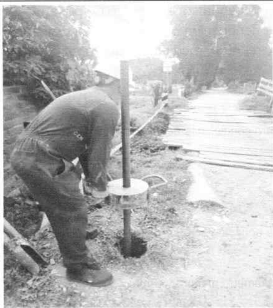
Ilustración 6. Perforación manual Sondeo 1
