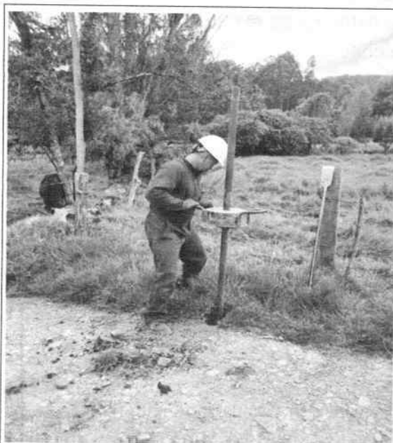
Ilustración 6. Perforación manual Sondeo 1
