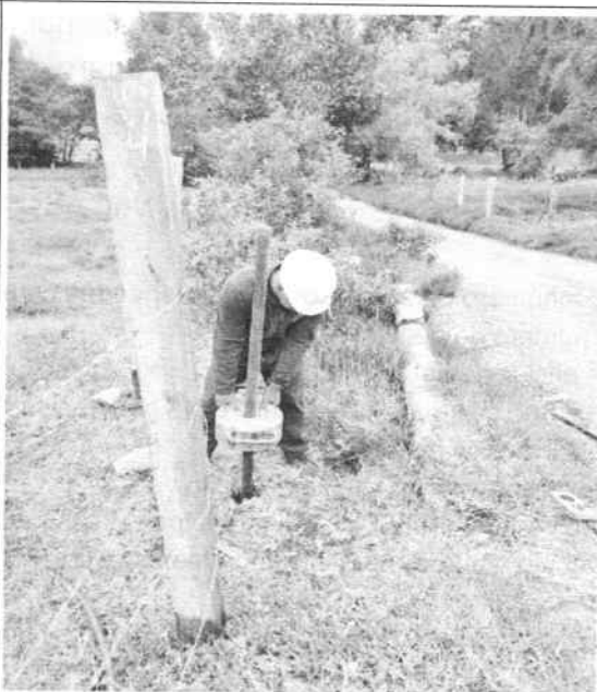
Ilustración 7. Perforación manual Sondeo 2
