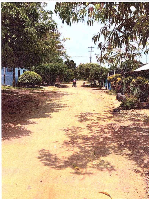
Fotografía 5. Estabilización del terreno
