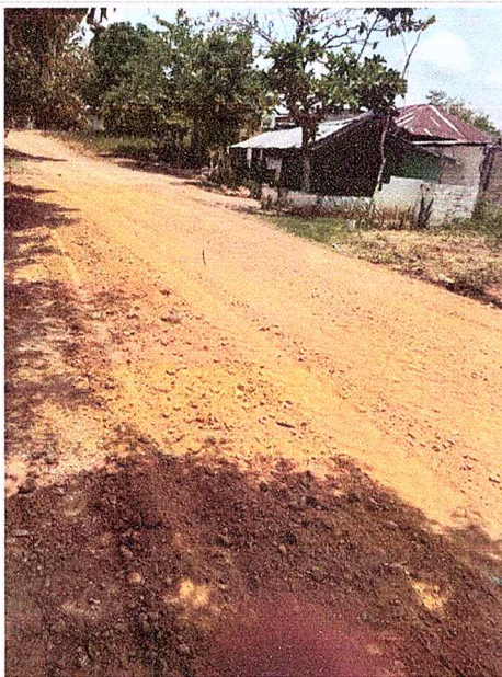
Fotografía 9. Material suministrado para calle.
