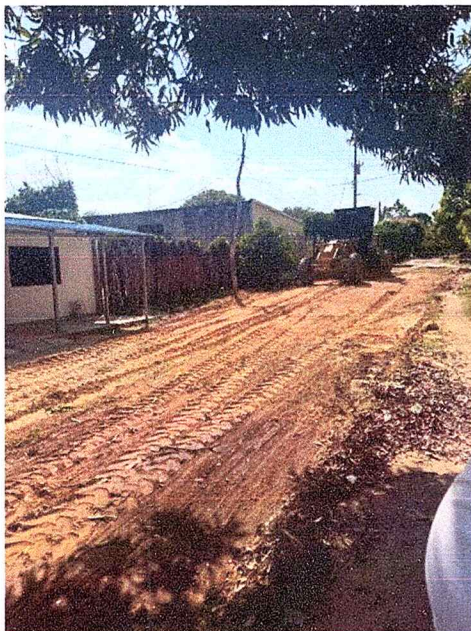
Fotografía 1. Extendida de material de relleno.
