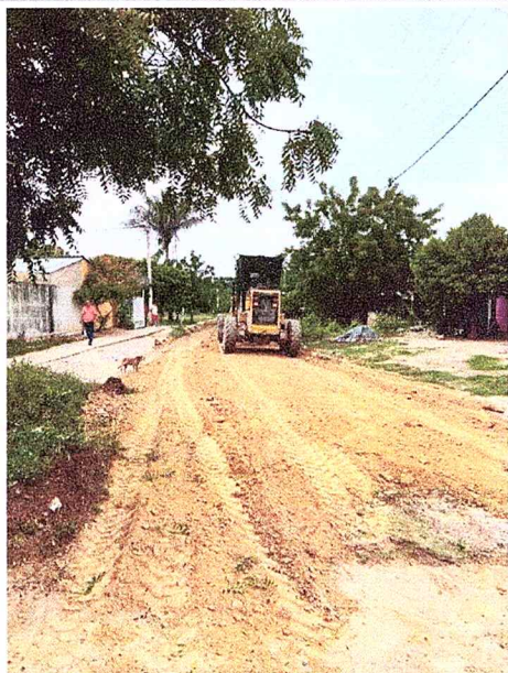
Fotografía 7. Estabilización del terreno
