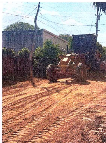
Ilustración 5. Trabajos de extendida de material de relleno.
