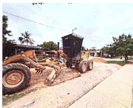
Ilustración 7. Trabajos de extendida de material de relleno.
