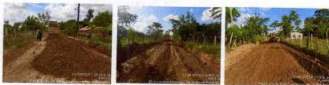
Realización de ensayos de densidad en campo
