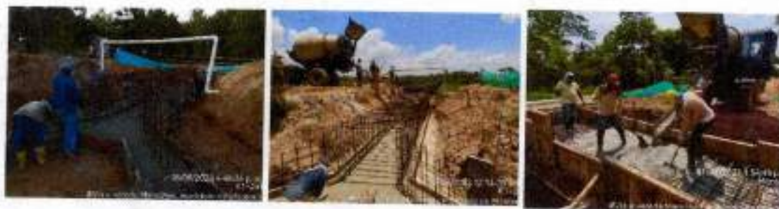
Fundida de Box culvert
