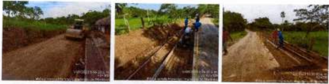
Estado de la vía durante la intervención
