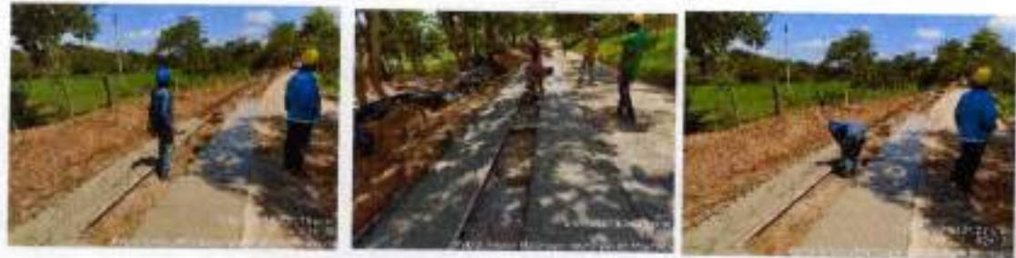
Fundida de concreto reforzado de 21MPa
