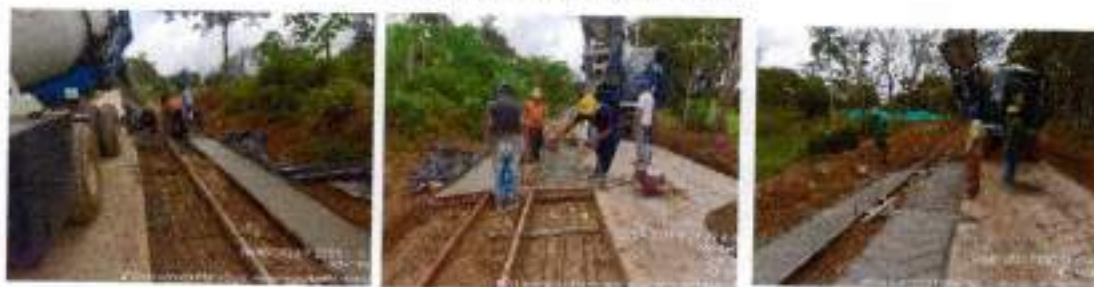
Fundida de concreto reforzado de 21MPa
