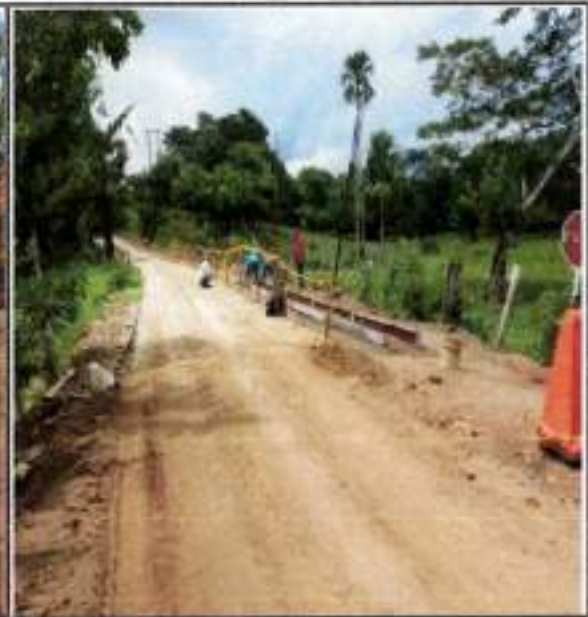
Foto GSST6. Evidencia de señalizaciones en obra
