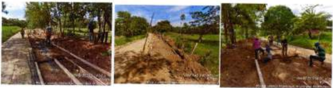
Estado de la vía durante la intervención
