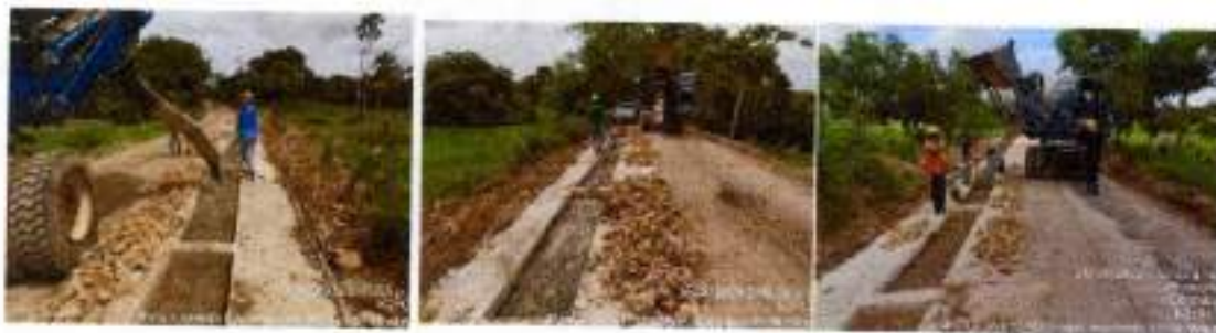
Fundida de concreto de 14MPa
