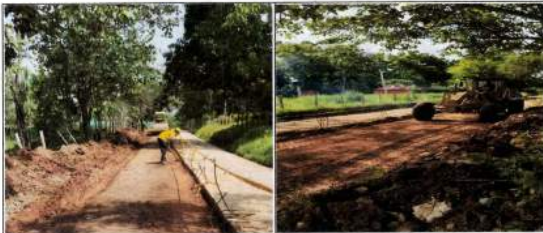
Adecuación y Nivelación de Media Banca
