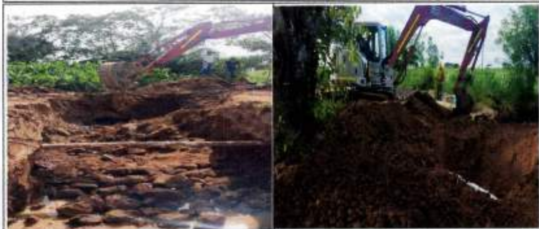
Excavación del Box #2 y Mejoramiento
