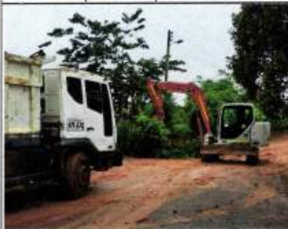
Descapote y Cargue de Material con Acarreo Libre
