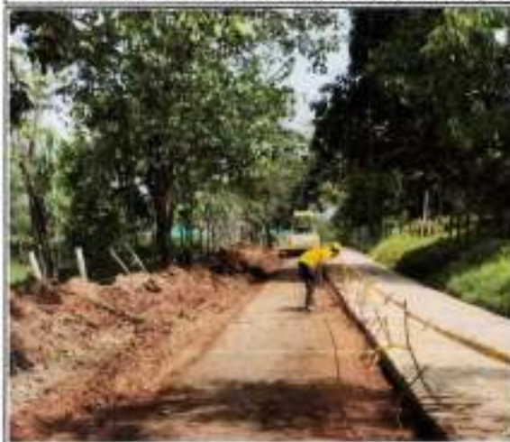
Adecuación y Nivelación de Media Banca
