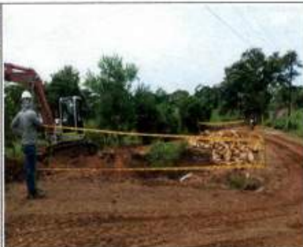
Foto GA2. Cerramiento con cinta de seguridad
