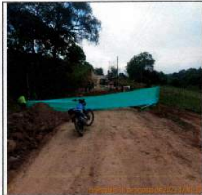
Foto GSST3. Evidencia de instalación de delimitación de material para obra
