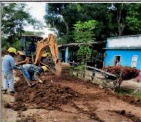
Conformación de Terraplén con Material de Relleno General
