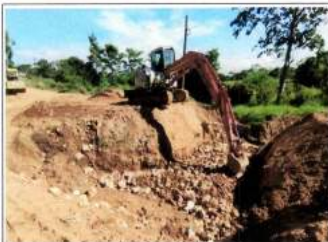
Foto GA1. Retiro material
