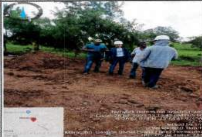
Foto GS4. Realización de pasos provisionales boxcouvert a propietarios de predios.
