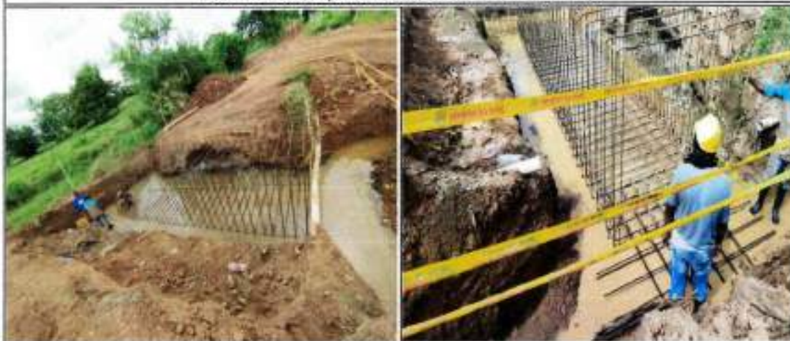
Figuración y Colocación de Acero de Refuerzo para Elementos Estructurales del Box Culvert #2
