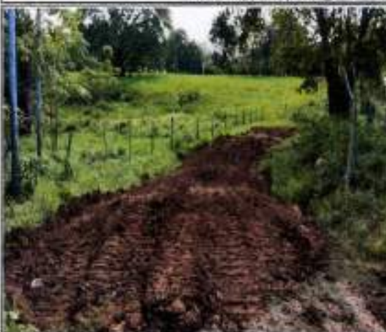
Conformación de Terraplén con Material de Relleno General
