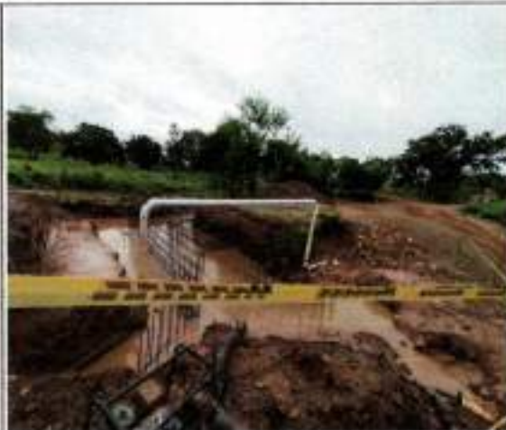
Reparaciones y Desvíos Provisionales de Tubería de Agua Potable de 4" y 6"
