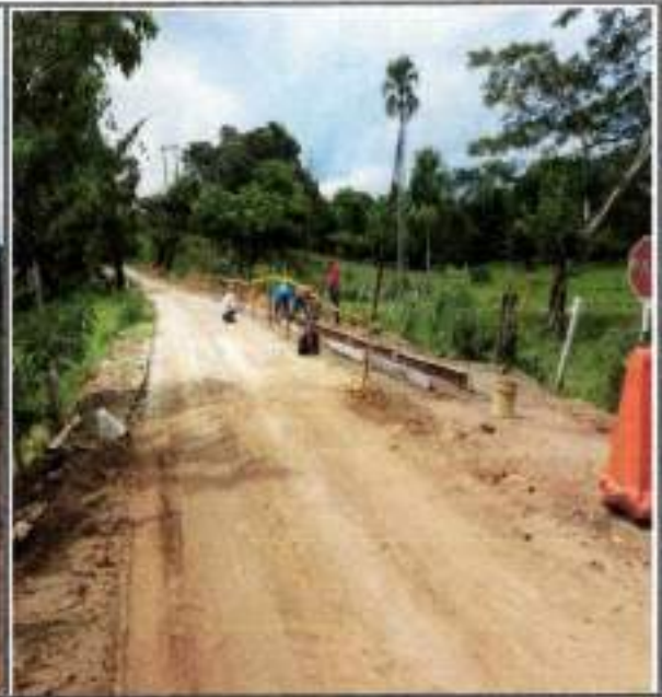
Foto GSST6. Evidencia de señalizaciones en obra
