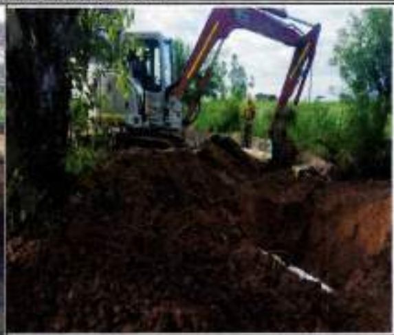
Excavación del Box #2 y Mejoramiento
