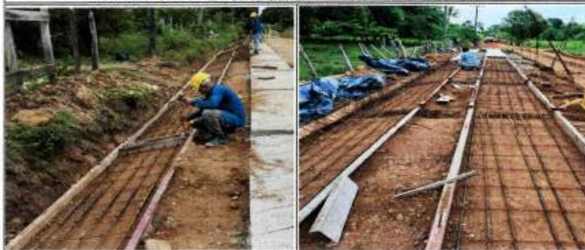
Figurado y Colocación de Acero para Refuerzo de Placa Huella
