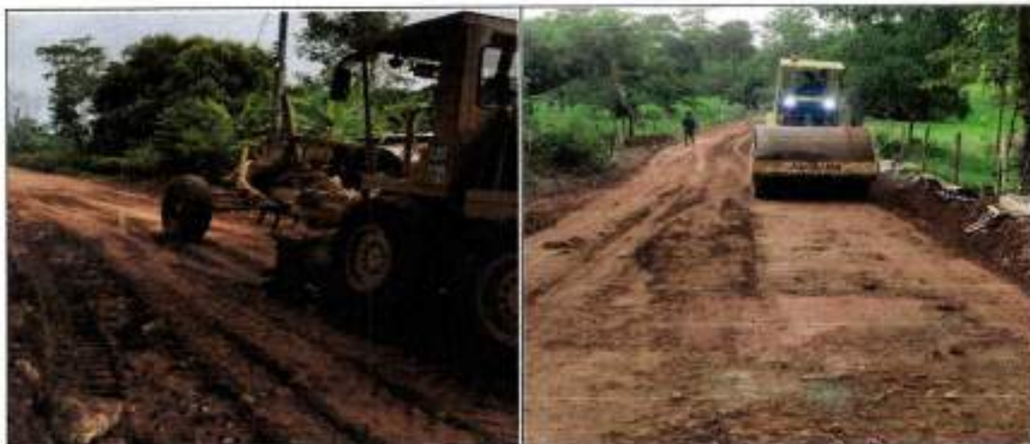
Colocación, Extendido y Compactación de Subbase Granular Clase C
