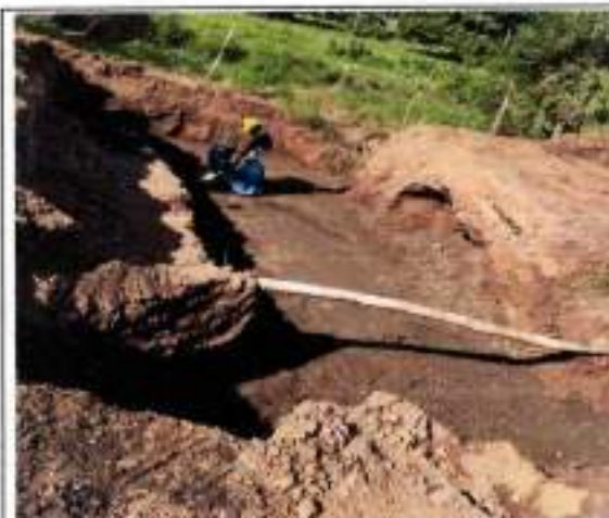
Reparaciones y Desvíos Provisionales de Tubería de Agua Potable de 4" y 6"
