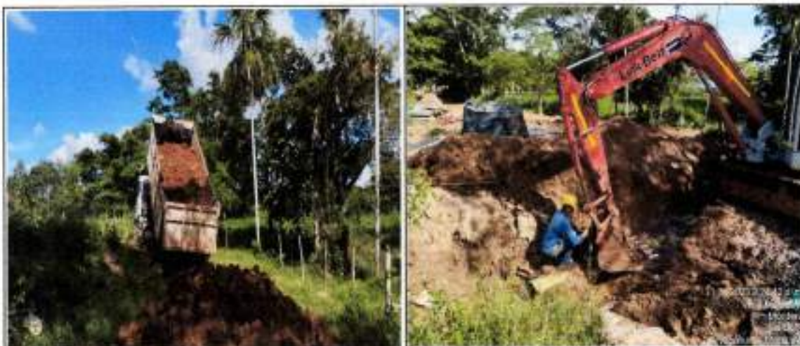
Paso Provisional para la Construcción del Box Culvert
