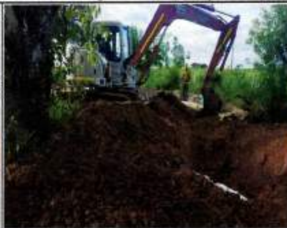
Descapote y Cargue de Material con Acarreo Libre
