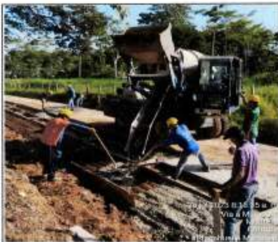
Vaciado de Concretos Placa Huella (Placa Rígida, Concreto Ciclópeo, Viga Riostra y Berma Cuneta)
