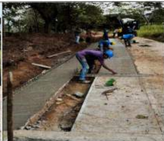
Vaciado de Concretos Placa Huella (Placa Rígida, Concreto Ciclópeo, Viga Riostra y Berma Cuneta)
