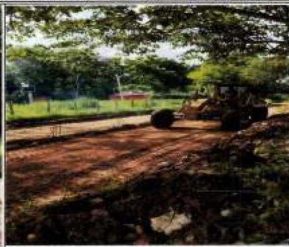
Adecuación y Nivelación de Media Banca
