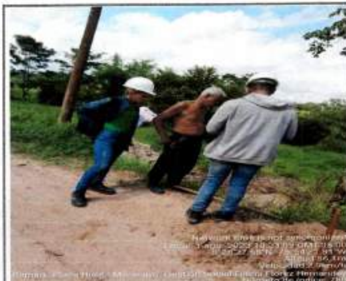
Foto GS1. Realización de pasos provisionales boxcouvert a propietarios de predios.
