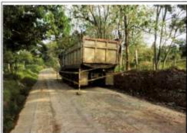
Foto GA3. Cerramiento de maquinaria con cinta de seguridad
