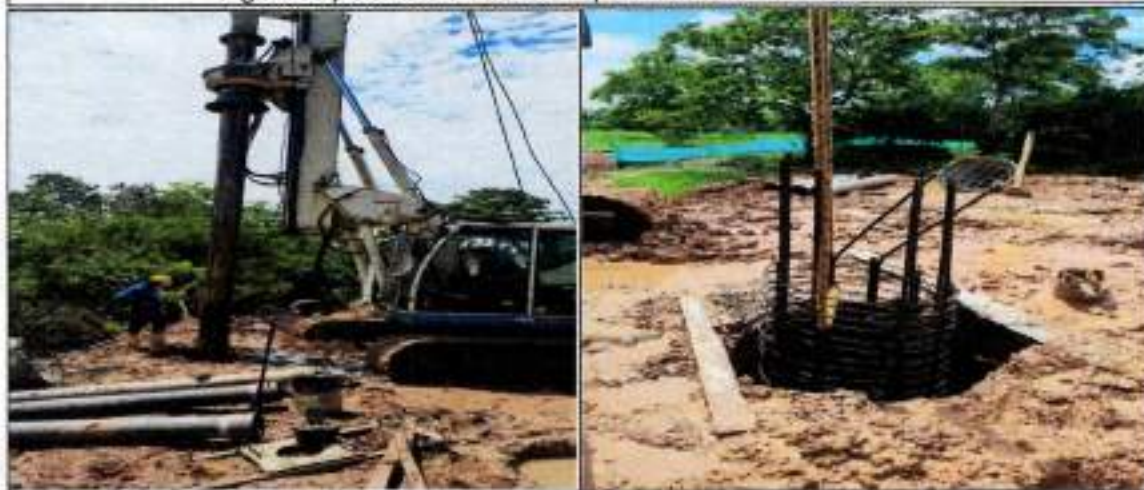
Excavación y Fundición de Pilotos Restantes (16 Unidades)
