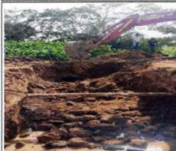
Excavación del Box #2 y Mejoramiento
