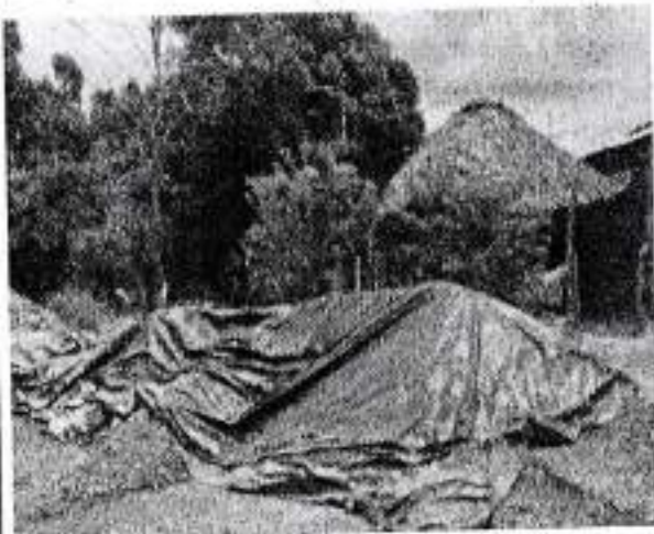
Foto GSST1. Evidencia de cercamiento de materiales en obra
