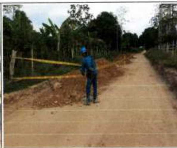
Foto GA2. Cerramiento con cinta de seguridad
