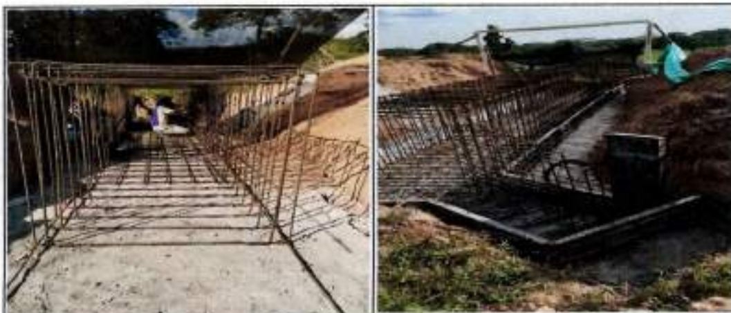
Figuración y colocación acero de refuerzo elementos estructurales box culvert #4
