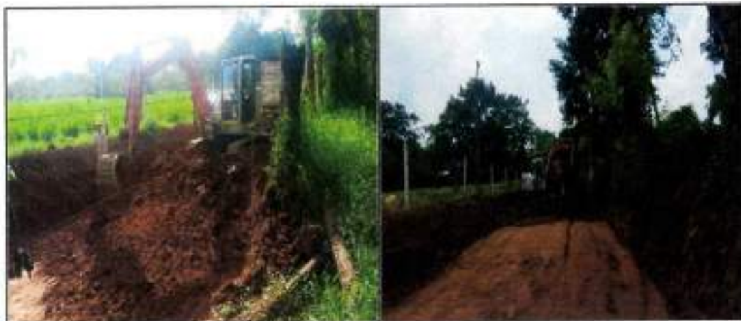
Corte, cargue y retiro de material sobrante, con acarreo libre
