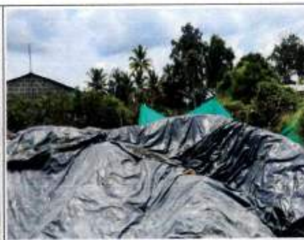
Foto GA4. Acopio de material
