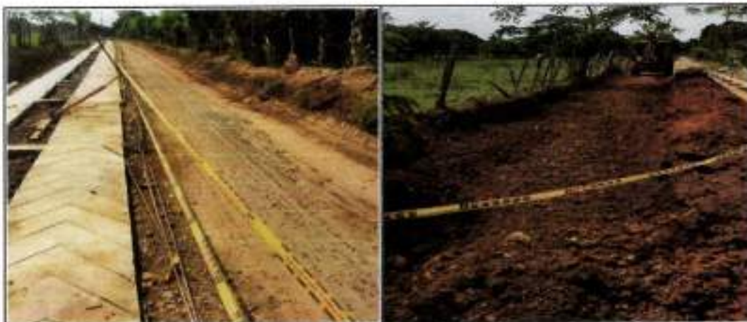
Adecuación, chequeo topográfico y compactación de subbase granular clase c en la media banca
