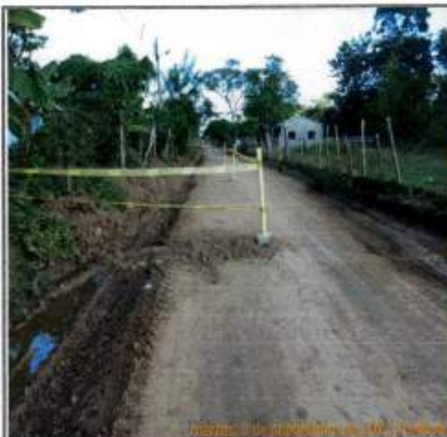
Foto GSST3. Evidencia de instalación de delimitación de material para obra
