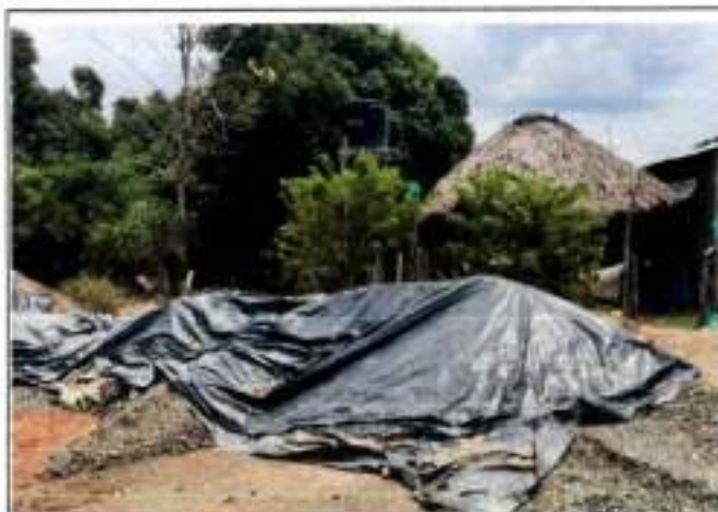
Foto GA5. Acopio de material
