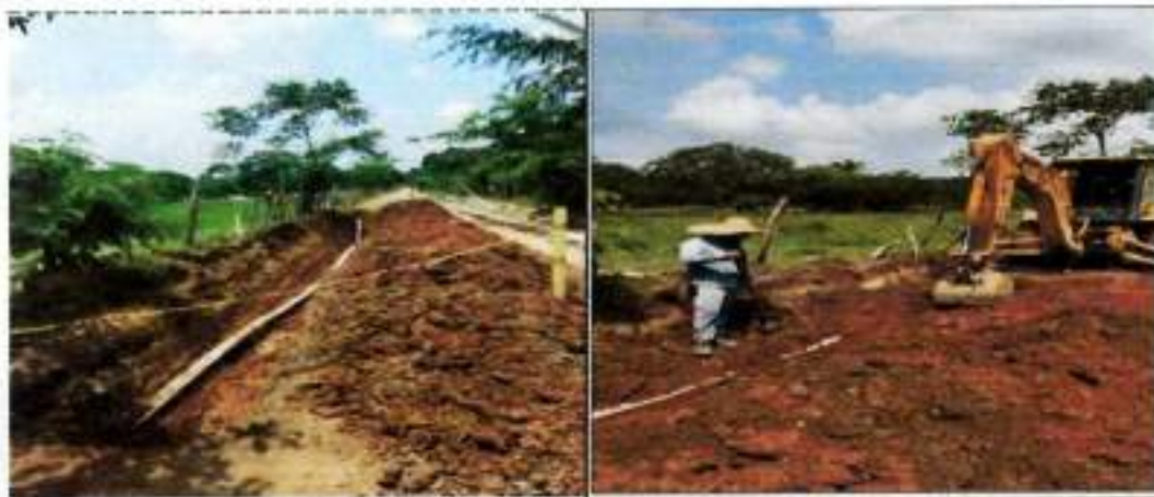
Reparaciones de daños en tubería de 4", profundización de esta y reparaciones completas de domiciliarias de agua potable
