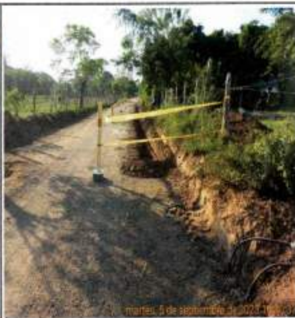
Foto GSST6. Evidencia de señalizaciones en obra
