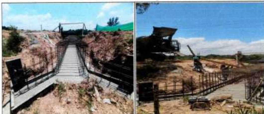
Formaleteo y vaciado de la losa inferior del box #4
