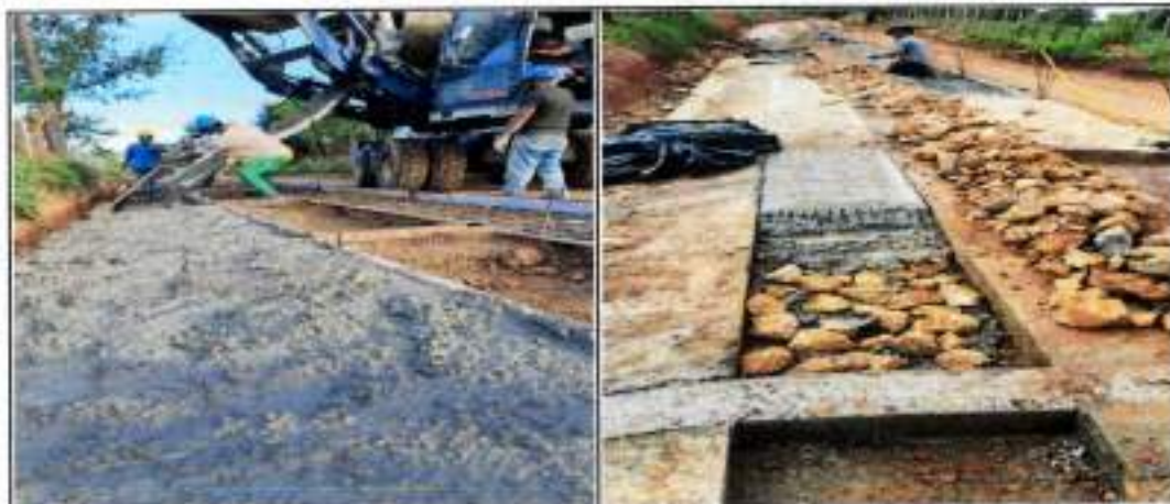
Vaciado concretos placa huella (placa rígida, concreto ciclópeo, viga riostra y berma cuneta)
