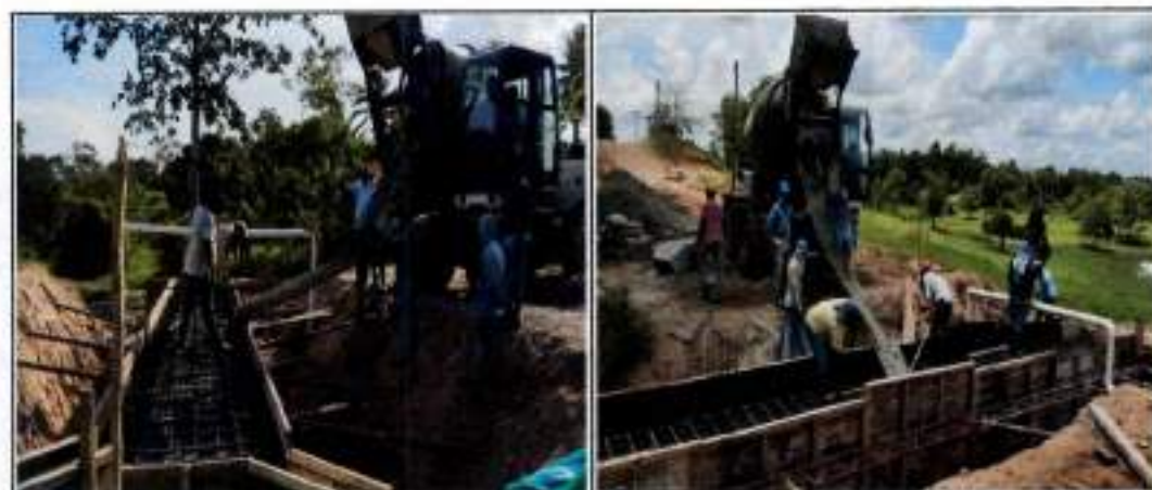
Vaciado del box coulvert #3 y #4 de forma monolítica
