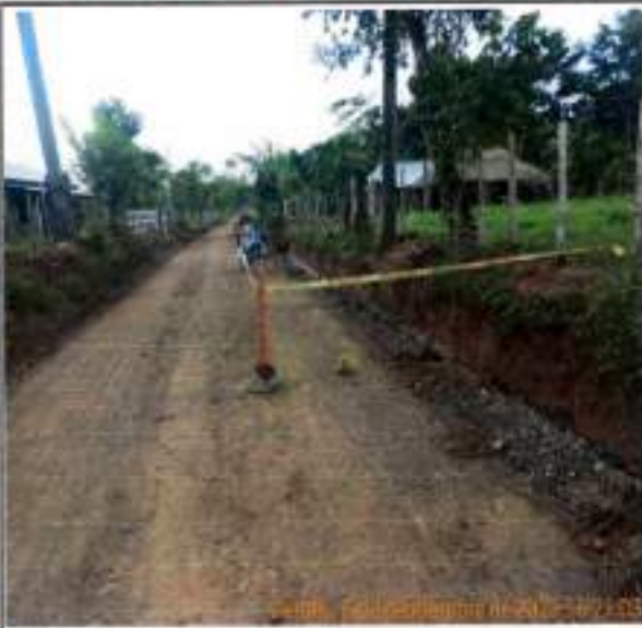
Foto GSST2. Evidencia de señalizaciones en obra
