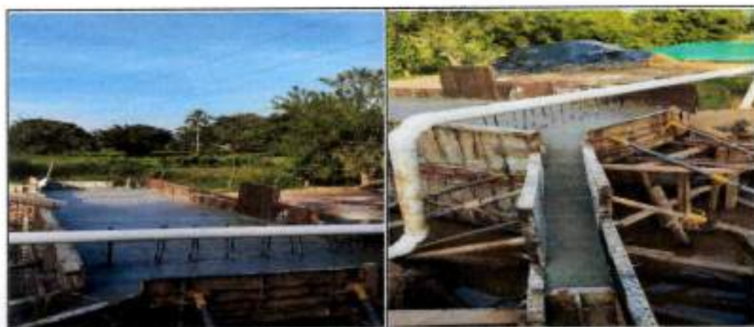
Formaleteo y vaciado de la losa superior del box coulvert #1
