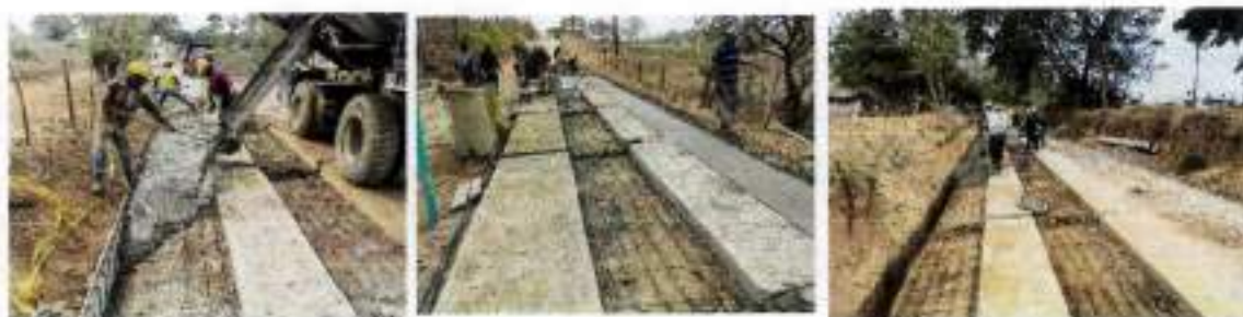
Fundida de concreto reforzado de 21MPa
