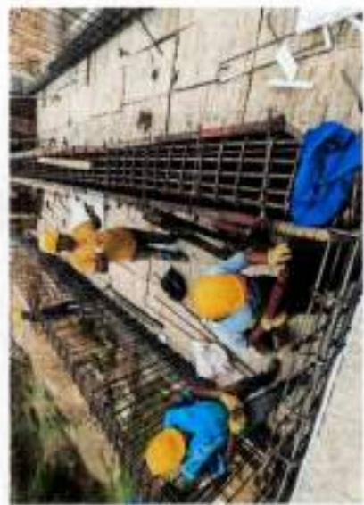
Se evidencia la construcción del fondo de los canales.
