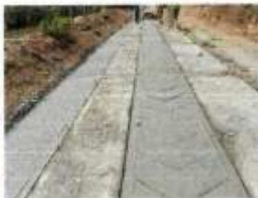
Fundida de concreto de 21MPa
