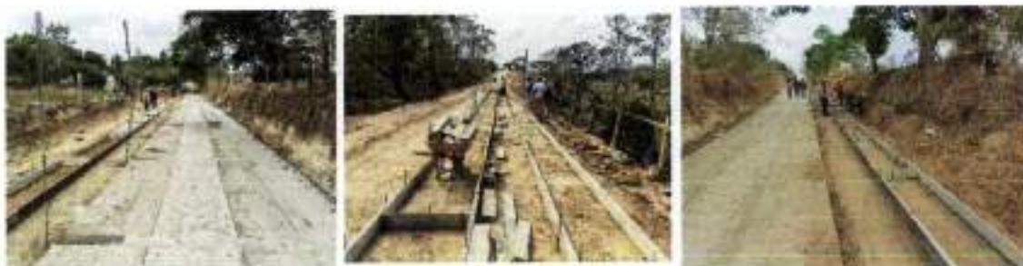
Estado de la vía durante la intervención
