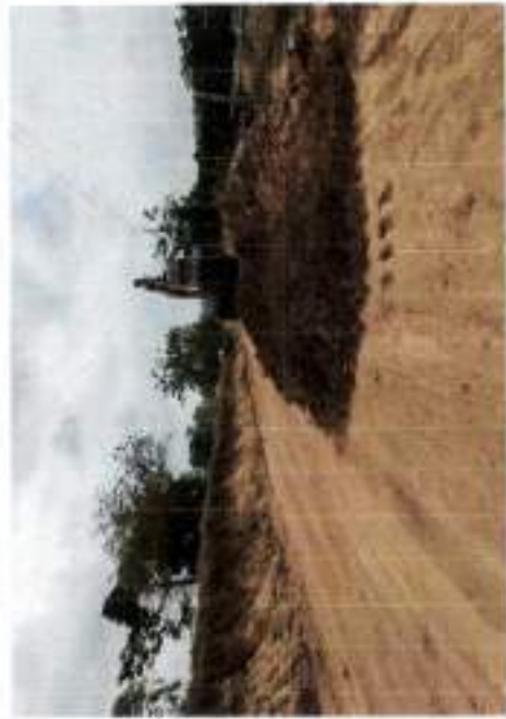
Se evidencia la excavación con máquina para la instalación de filtros.
