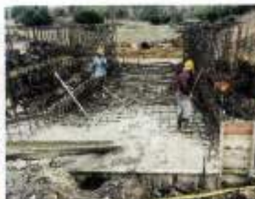
Fundida de losa inferior de Boxcoulvert No. 06
