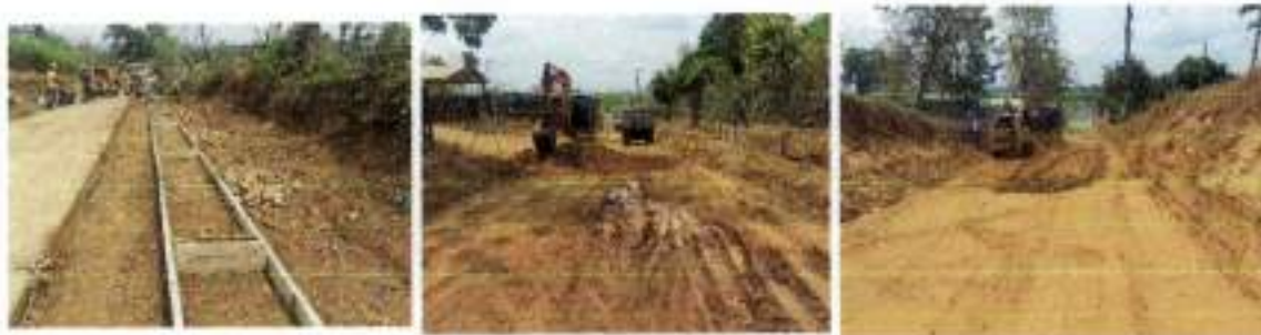
Estado de la vía durante la intervención
