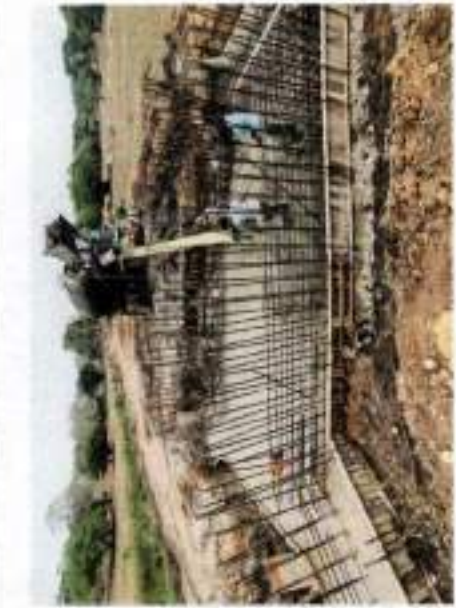
Se evidencia la construcción del fondo de los canales.
