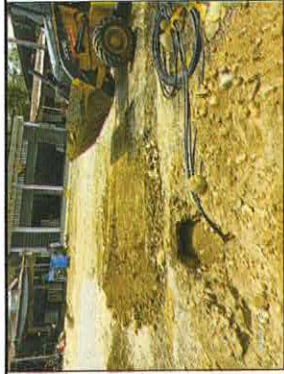
Foto 1: ACOMETIDA DOMC. ACUED. CON SILLETA TERMOFUSION A SOCKET 75MMX20MM (3"X1/2") (INC. SUMIN. E INSTAL. MANGUERA 50M. ACCESORIOS. REGISTRO CORTE Y CAJILLA EN POLIPROPILENO)
