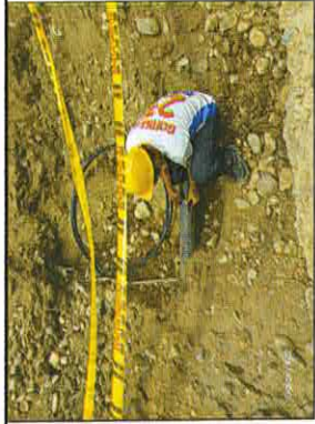
Foto 2: ACOMETIDA DOMC. ACUED. CON SILLETA TERMOFUSION A SOCKET 75MMX20MM (3"X1/2") (INC. SUMIN. E INSTAL. MANGUERA 50M. ACCESORIOS. REGISTRO CORTE Y CAJILLA EN POLIPROPILENO)
