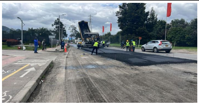
Suministro e instalación asfalto
