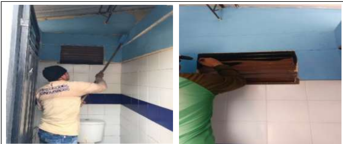
Foto2: se aplica pintura de color azul claro tipo 2 a dos manos a las paredes interiores y exteriores de las unidades sanitarias con rodillo y con brocha en los remates, también se aplica pintura en aceite a las ventanas que dan aire al baño.
