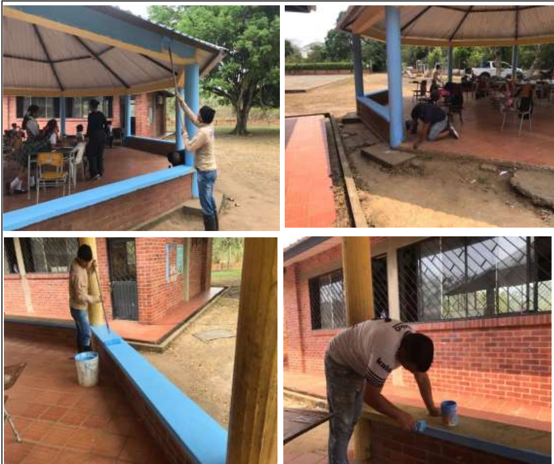
Foto 1: se aplica pintura tipo 2 a dos manos con brocha y rodillo de color azul claro a las partes externas e inferiores del kiosco.
