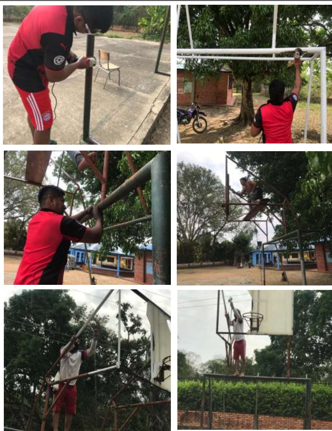
Foto 2: se lija la cancha con la pulidora y lija de trapo para levantar todas las partes oxidadas y luego se procede a pintar con el compreso los marcos de la cancha.
