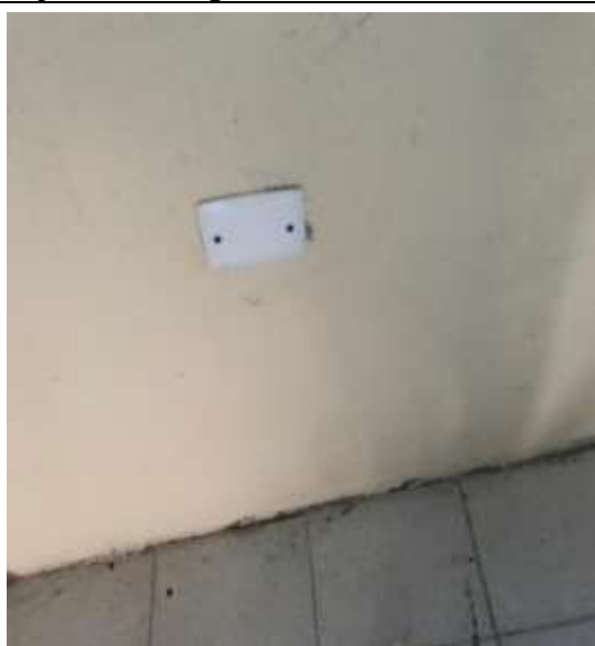
Foto 2: se tapa con cemento las regateadas que se hicieron para poder cambiar las cajas de las tomas luego se hacen las respectivas conexiones, se corrigen las fugas de energía y se procede a colocar las tapas en los puntos que no están habilitados.
