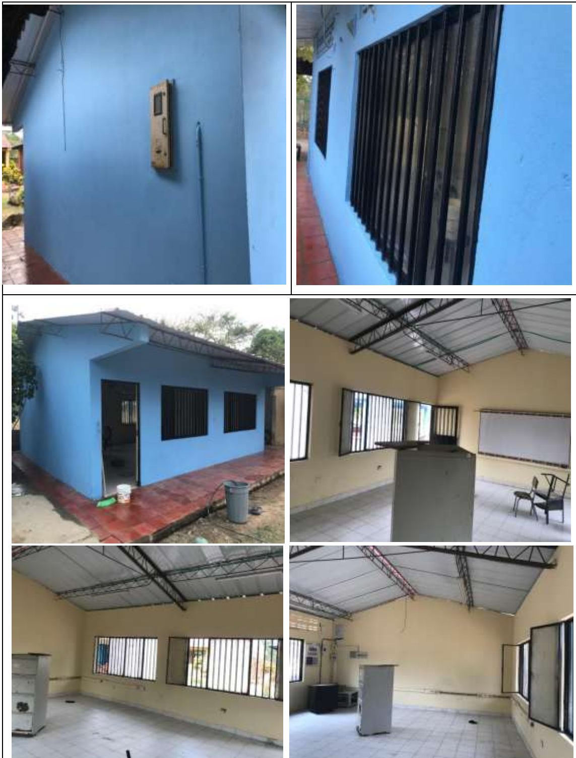
Foto 4: se pintan los 161.90 metros cuadrados de color azul en la parte exterior y de color beige en la parte interior con pintura de agua a dos manos y se hacen los respectivos remates con brocha en los bordes del techo y en los finales de la pared.
