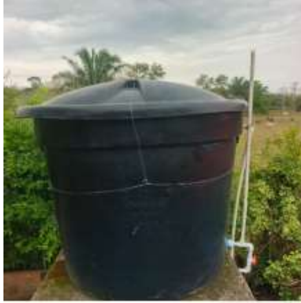
Foto1: la tapa queda instalada y amarrada al tanque, para conservar el agua.
