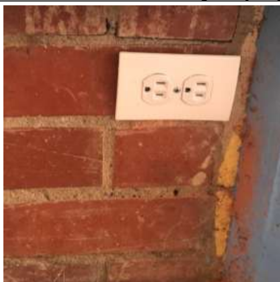
Foto 2: se tapa con cemento las regateadas que se hicieron para poder cambiar las cajas de las tomas luego se hacen las respectivas conexiones, se corrigen las fugas de energía y se procede a colocar las tapas en los puntos que no están habilitados.
