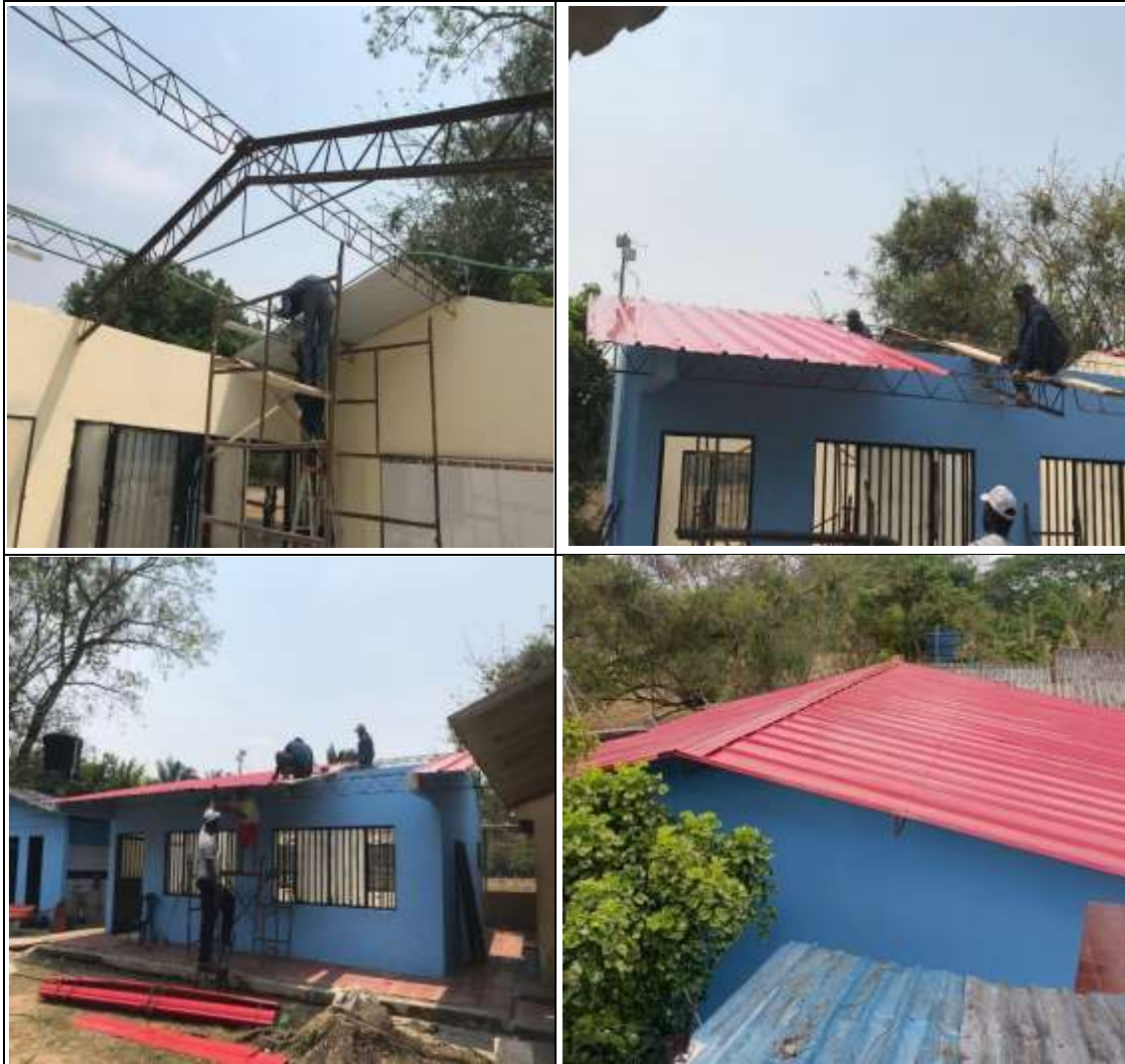
Foto 3: se hace la respectiva instalación de la lamina master 1000 calibre 28 como resultado final, evidenciada en la última foto.
