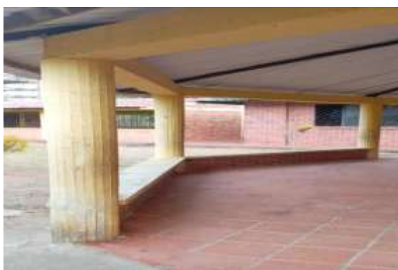
Foto 1: se puede evidenciar que el kiosk escolar esta sucio y descolorido, la pintura existente es de un tono amarillo donde en partes se evidencia la humedad.
