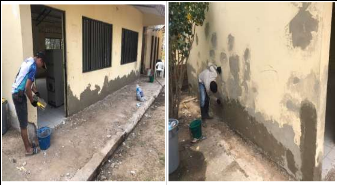
Foto 2: las paredes ya esta gratiadas y lijadas, donde se levanta la pintura que esta soplada y el pañete podrido para luego resanarlas.
