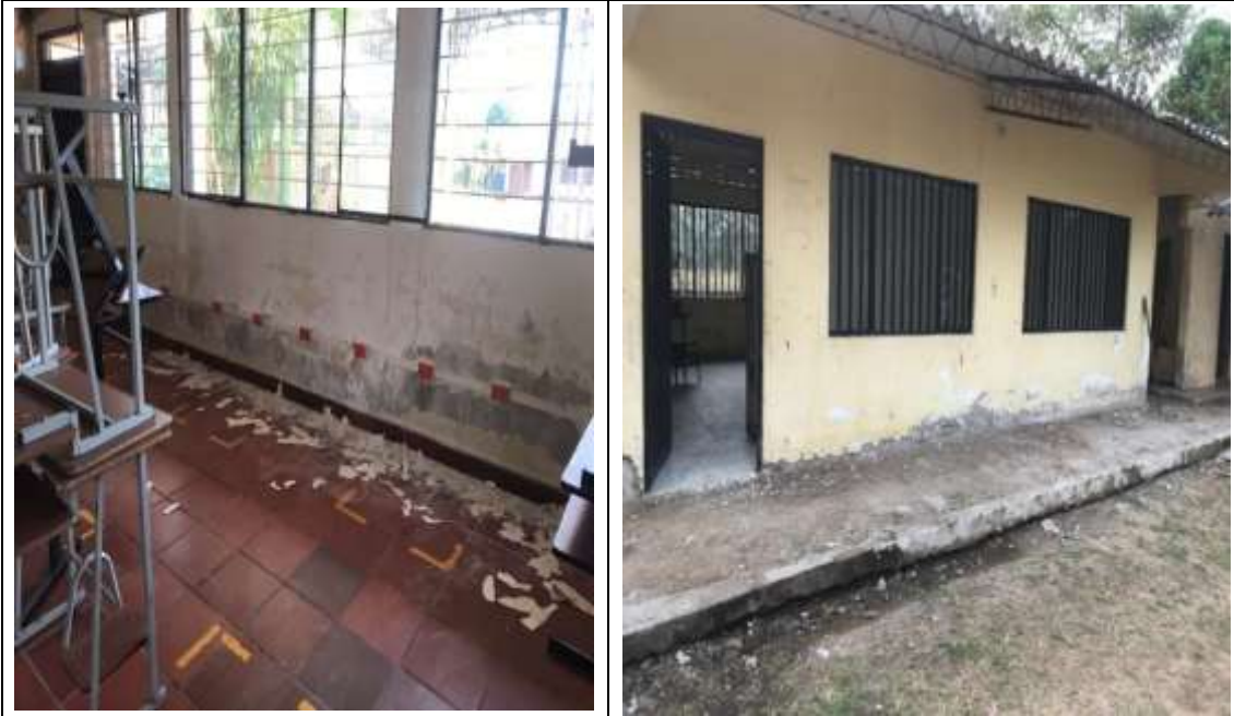
Foto 2: las paredes ya esta gratiadas y lijadas, donde se levanta la pintura que esta soplada y el pañete podrido para luego resanarlas.
