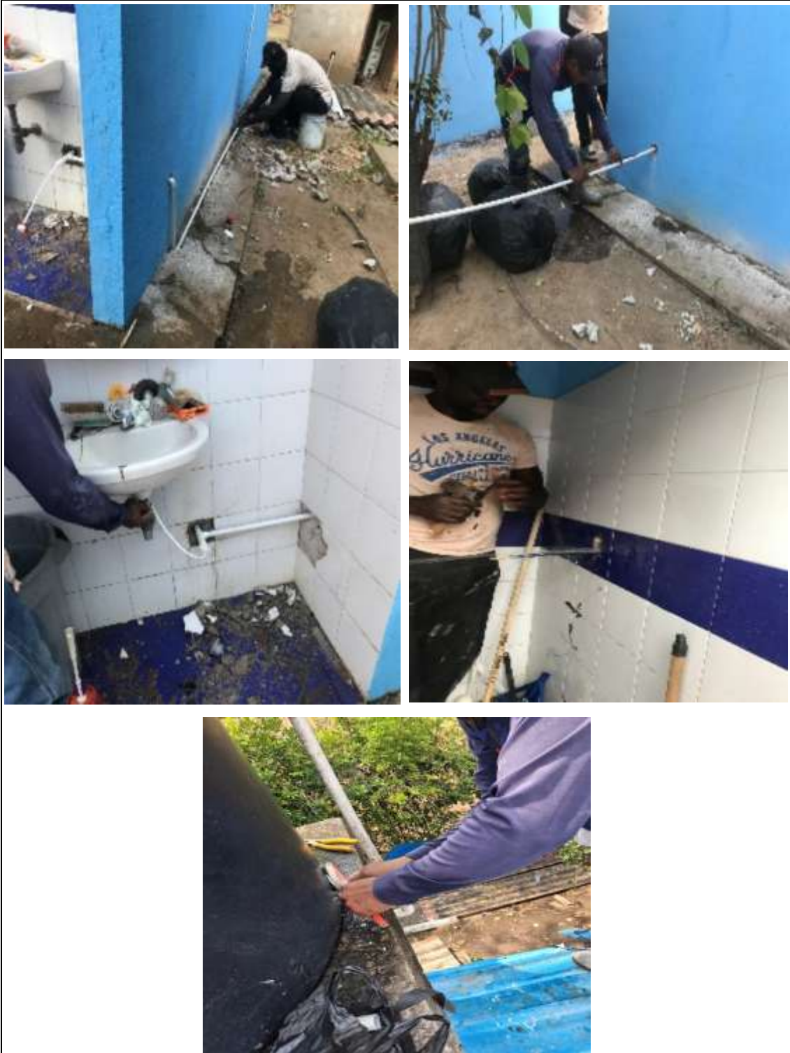
Foto 2: se hacen las instalaciones de la nueva tubería que alimentara la malla hidráulica que no tiene el servicio de agua para habilitar el lavamanos y los sanitarios, se cambian los cheques del tanque y se hace las conexiones de los accesorios para habilitar las unidades sanitarias.
