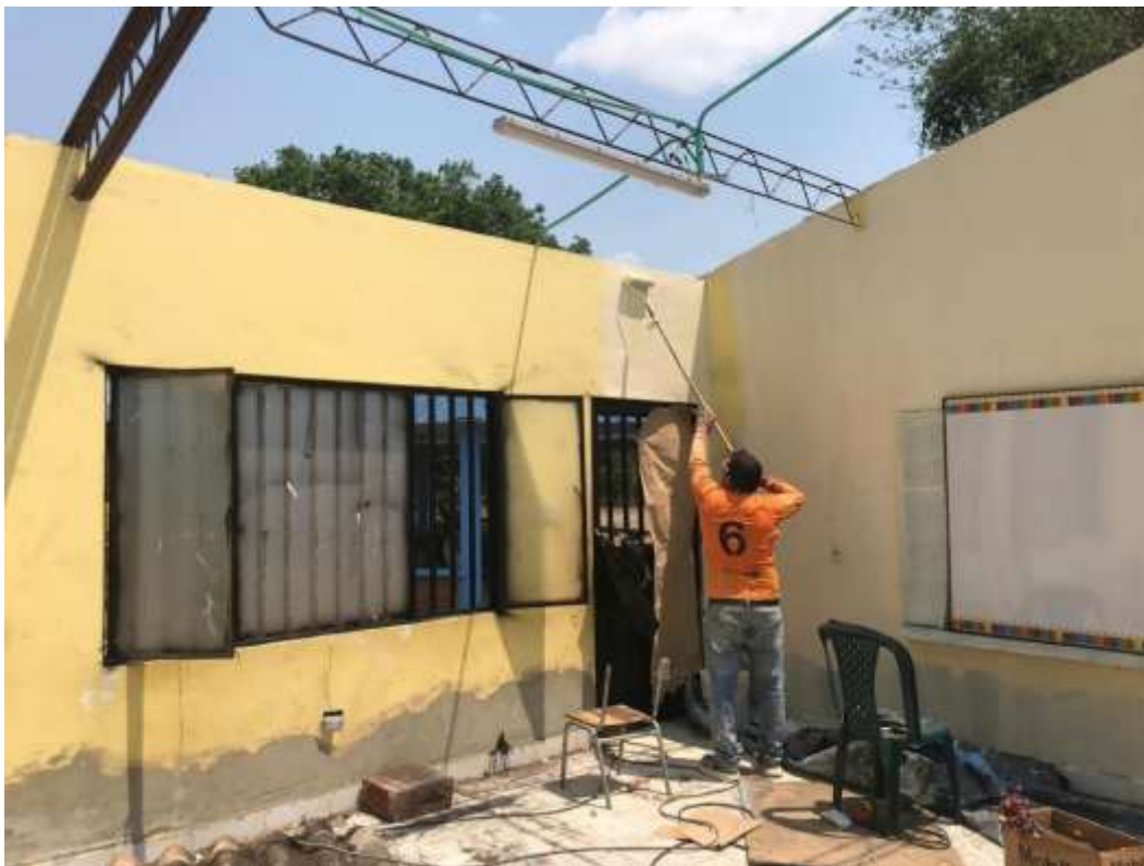
Foto 3: se hace el resane con pega master e invcryl, corrigiendo todas las humedades y deterioros de la pared, luego se aplica la pintura de agua tipo 2 a dos manos de manera interior y exterior color beige y azul claro.
