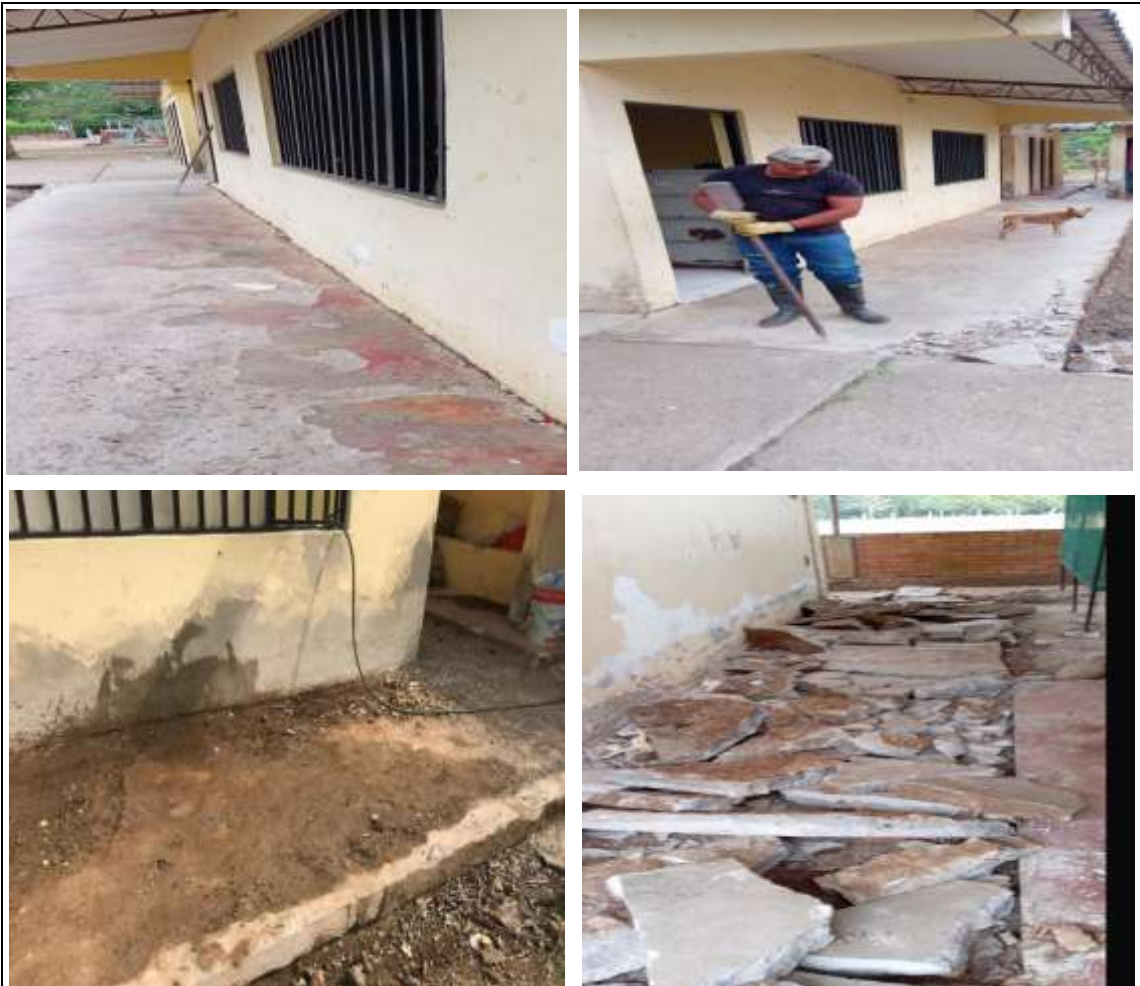
Foto1: se hace la demolición del piso existente con barra y punta, luego se retira el escombro para hacer el replanteo y nivel del existente para poder enchapar el tablón en Gress.
