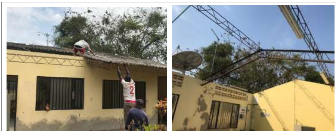
Foto 2: imagen de los salones, ya retirando el techo de Eternit para dejar la disposición final y hacer la instalación de la lamina master.
