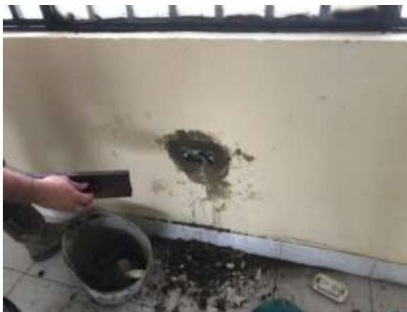
Foto 2: se tapa con cemento las regateadas que se hicieron para poder cambiar las cajas de las tomas luego se hacen las respectivas conexiones, se corrigen las fugas de energía y se procede a colocar las tapas en los puntos que no están habilitados.
