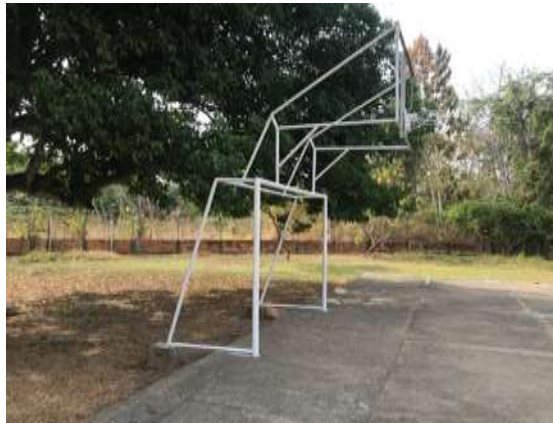
Foto 3: resultado final de la cancha ya con los nuevos tubos en los soportes faltantes y de una vez pintada con el color asignado.
