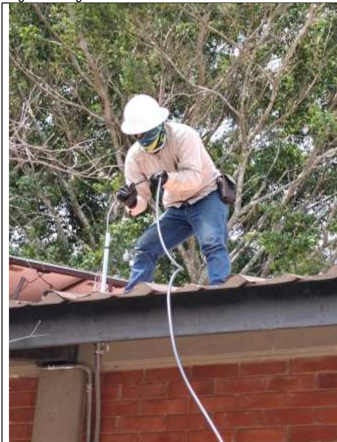
Foto 1: Estado inicial instalación cable concéntrico monofásico
