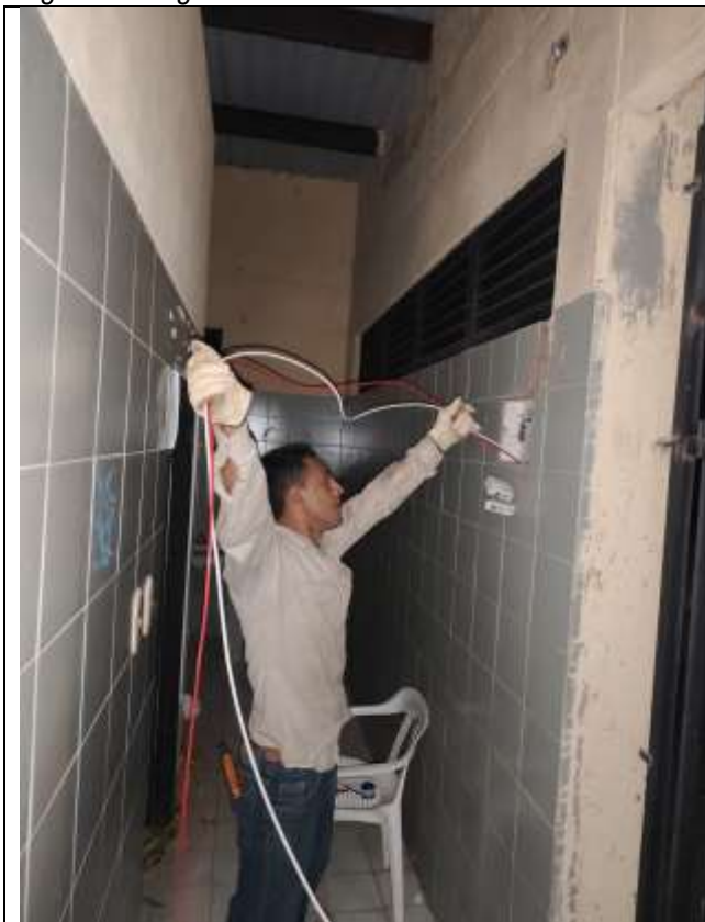
Foto 1: Estado inicial Sondeo y limpieza a tubería eléctrica existente
