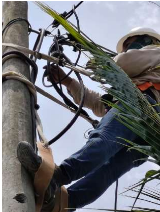
Foto 2: Estado Final Conector de perforación para acometida.
