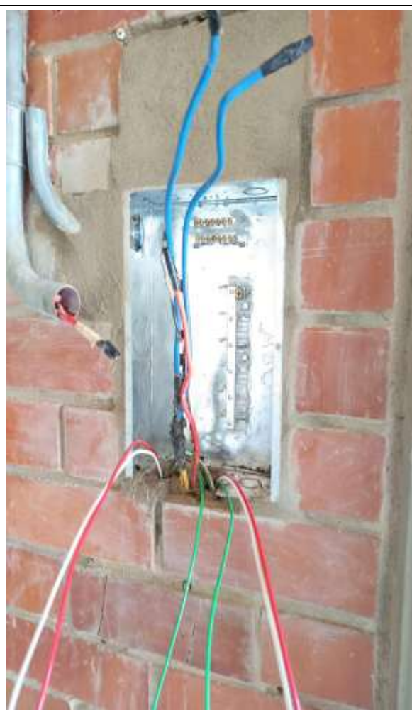
Foto 2: Estado Final instalación de Caja de 6 circuitos monofásica.
