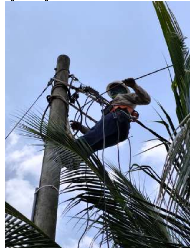
Foto 1: Estado inicial Conector de perforación para acometida.
