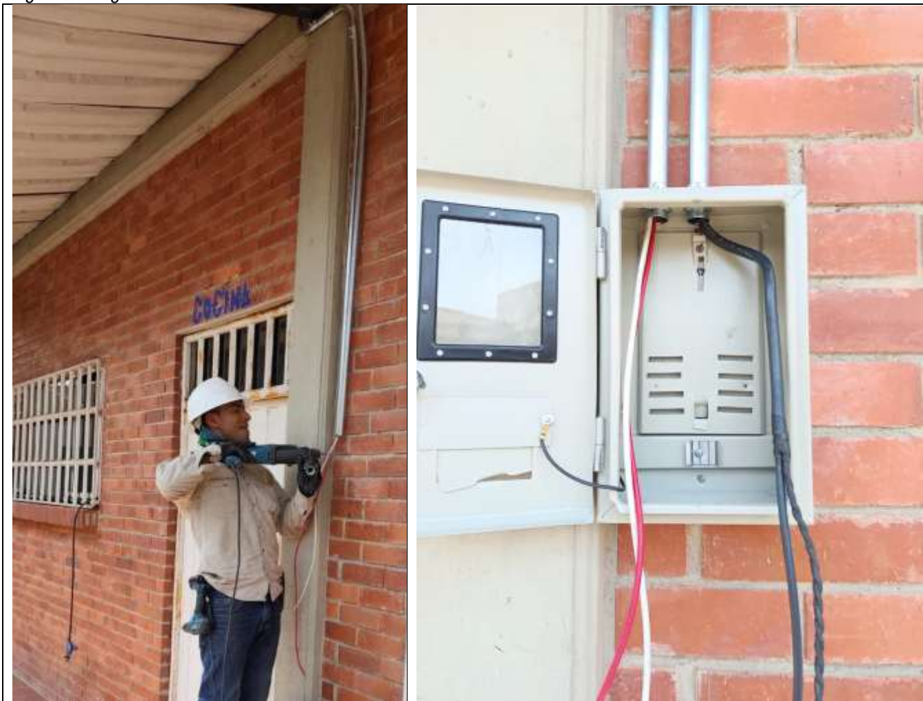
Foto 1: Estado inicial donde se instalará la caja área medidor
