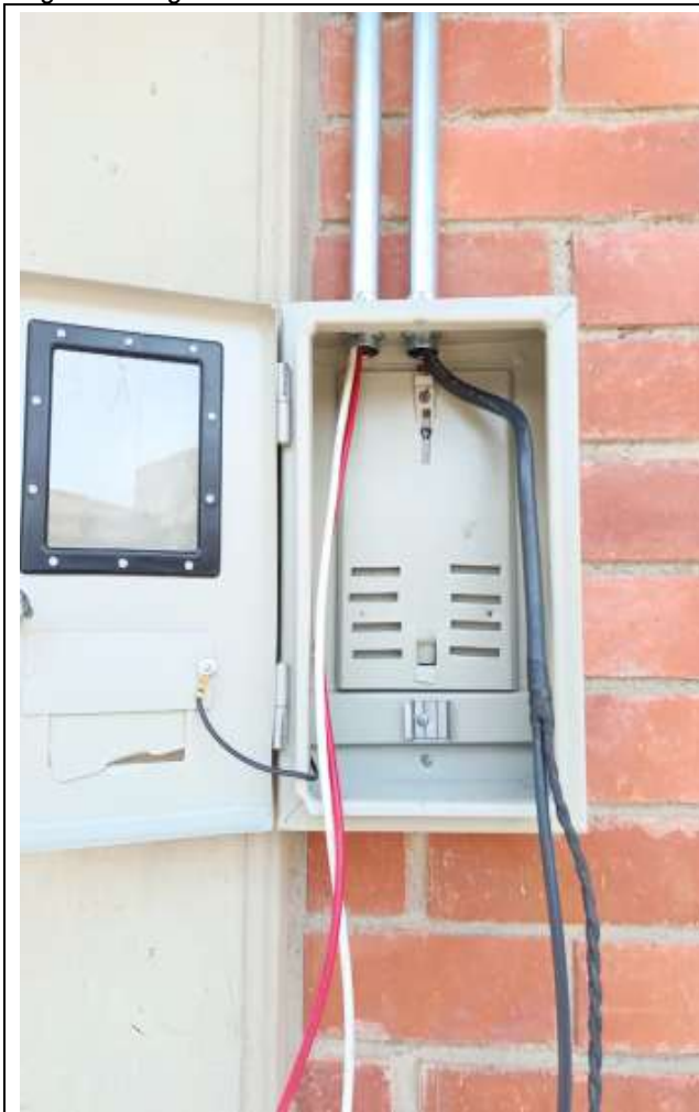
Foto 1: Estado inicial donde se instalará el medidor monofásico
