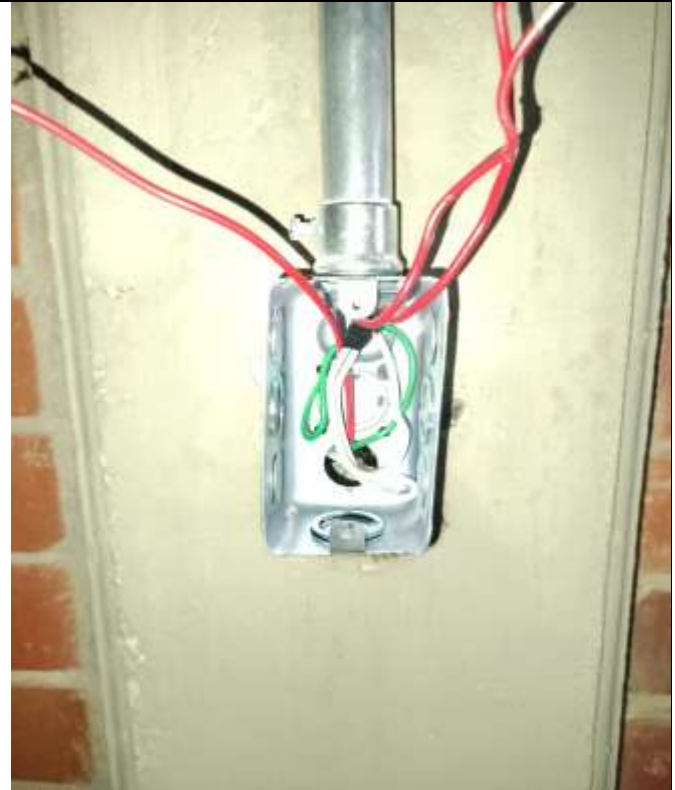
Foto 2: Estado Final instalación Alambre de Cobre THWN N° 14 AWG
