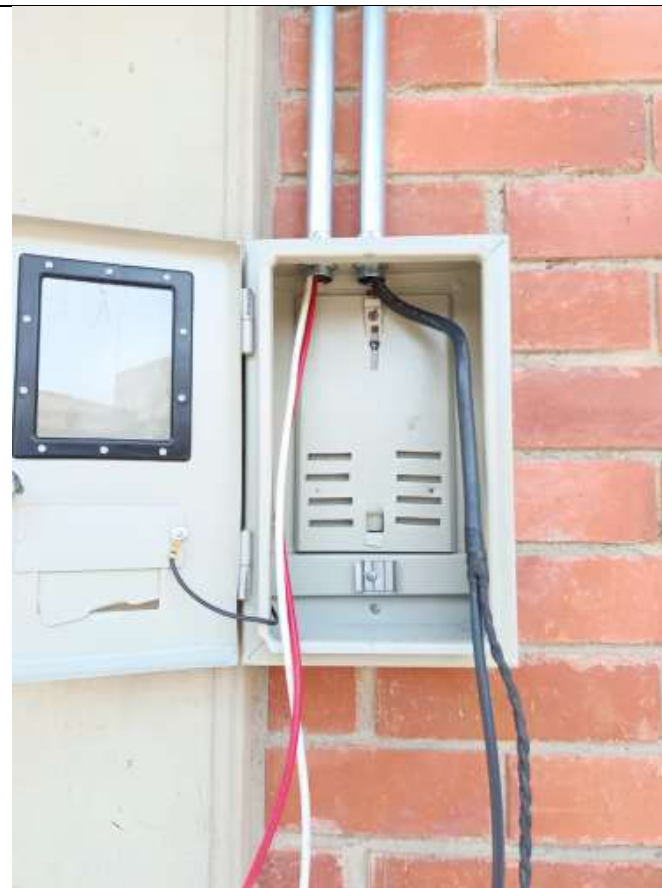
Foto 2: Estado Final instalación cable concéntrico monofásico
