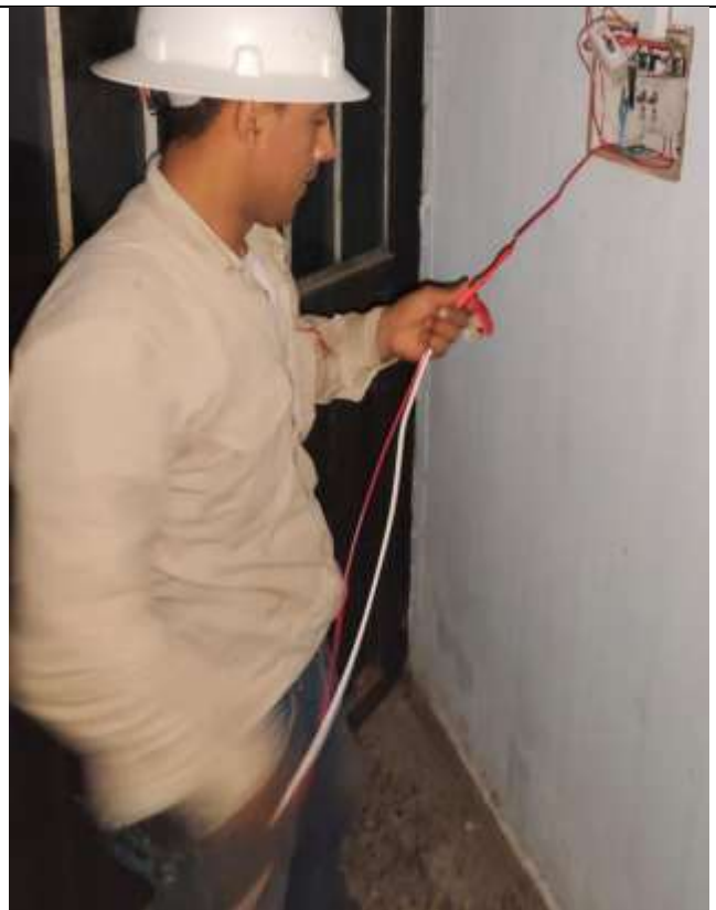
Foto 2: Estado Final Sondeo y limpieza a tubería eléctrica existente
