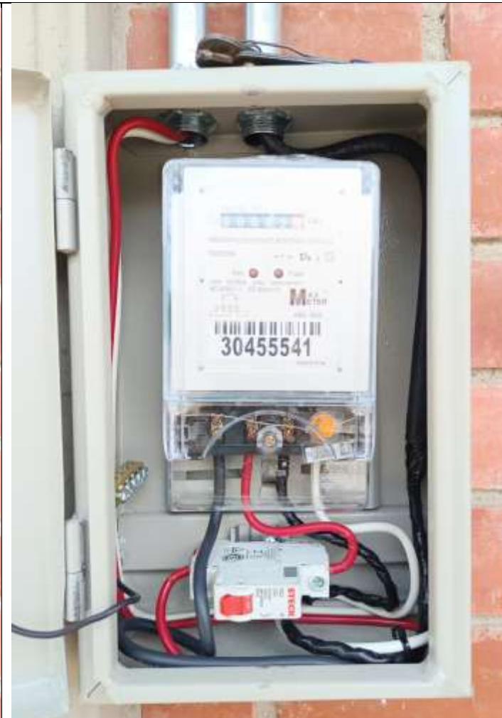
Foto 2: Estado Final instalación de medidor monofásico
