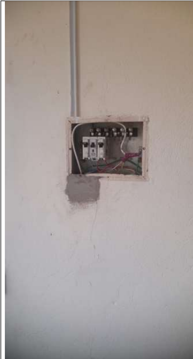
Foto 1: Estado inicial Conector de perforación para acometida.
