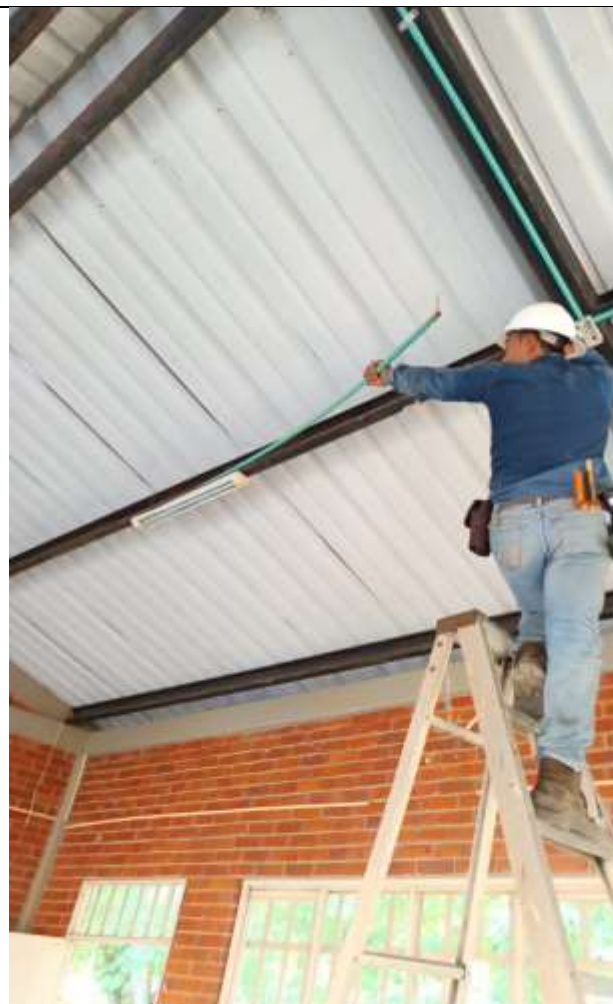
Foto 2: Estado Final retiro de iluminarias
