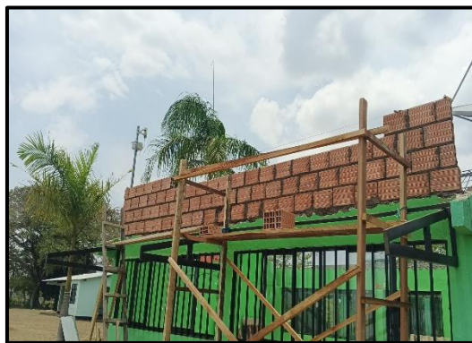
Foto 2: Se evidencia el levantamiento de Muros con Bloques Maguncia en la parte Frontal del Salón.
