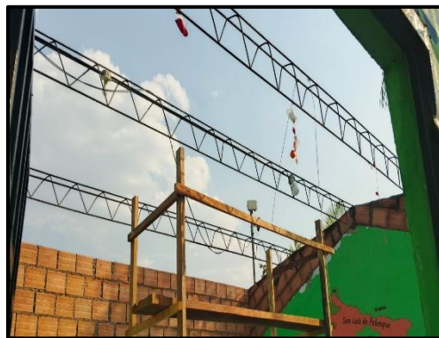
Foto 2: Se evidencia el Desmonte de la Cubierta Existente, donde se reinstalaron las cerchas existentes apoyadas en la Mampostería nueva del Salón.
