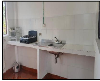
Foto 2: Suministro e Instalación de Pintura en Vinilo de las Zonas comunes (Cocina Escolar) de la Escuela La Venturosa.
