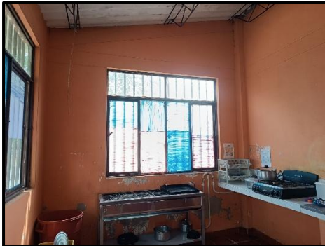
Foto 1: Enchape existente del Mesón de la Cocina del Restaurante Escolar de la Escuela Venturosa.
