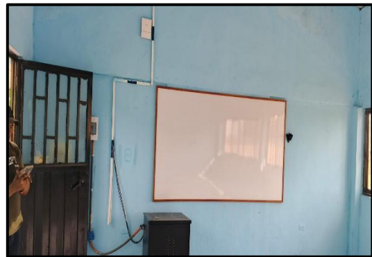
Foto 2: Suministro y Aplicación de Pintura del Salón de Clases de Color Azul Claro.
