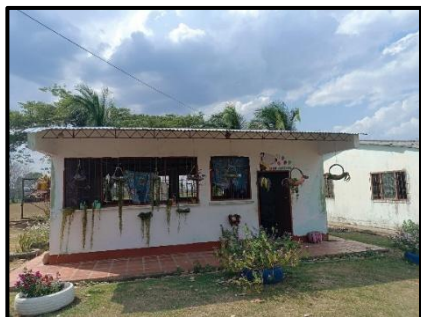
Foto 1: Cubierta existente del Salón de Clases.
