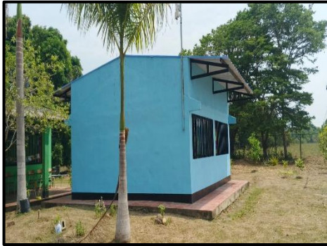
Foto 2: Esta actividad contempló la ejecución de 63.80 M2 de desmonte de cubierta existente (incluyendo su caballete), contempló el retiro y posterior instalación de las cerchas existentes, contempló el retiro y posterior instalación de los Pie de Amigos existentes para la cubierta, contempló la Instalación de la Cubierta en lámina master 1000 calibre 28 incluido el caballete y el sellado de los amarres con sellante para goteras.
