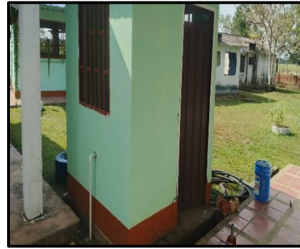
Foto 2: Suministro e Instalación de Pintura en Vinilo para los Muros del Cuarto donde se encuentra la Planta Eléctrica de la Escuela La Venturosa.
