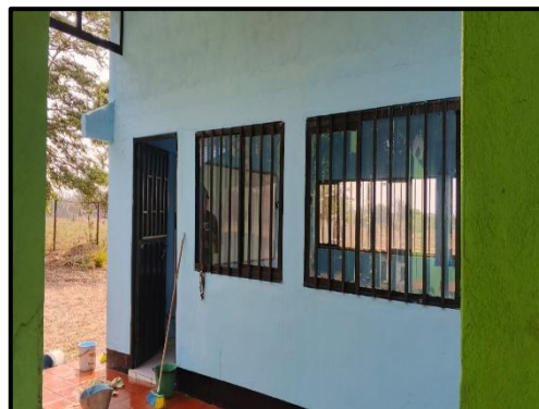
Foto 2: Suministro e Instalación de Pintura para la Puerta del Salón de Clases.
