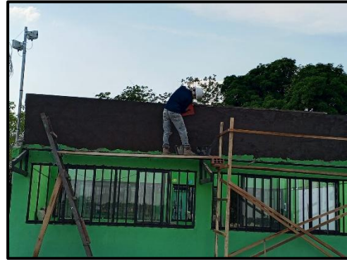
Foto 2: Se evidencia la Instalación del Pañete.
