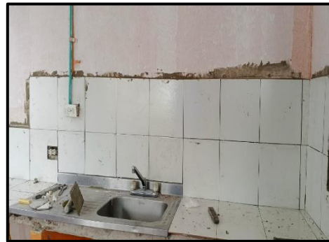
Foto 2: Suministro e Instalación de Baldosa para el Mesón de la Cocina del Restaurante Escolar de la Escuela Venturosa.
