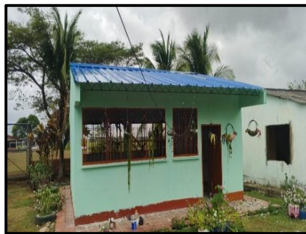
Foto 2: Suministro e Instalación de Pintura en Aceite para la Puerta y Ventanas del Salón de Clases.
