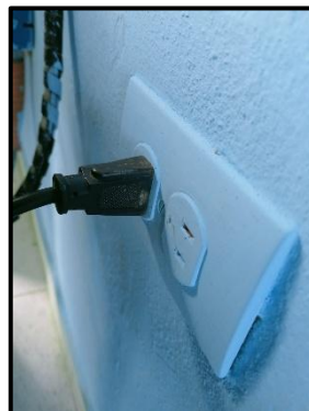
Foto 2: Se realizó la Limpieza de Puntos Eléctricos y Suministro de Accesorios.
