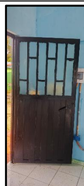
Foto 2: Suministro e Instalación de Pintura para la Puerta del Salón de Clases.
