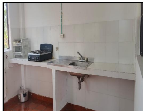
Foto 2: Suministro e Instalación de Baldosa para el Mesón de la Cocina del Restaurante Escolar de la Escuela Venturosa.
