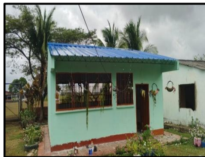
Foto 2: Suministro e Instalación de Cubierta Nueva para el Salón de Clases.
