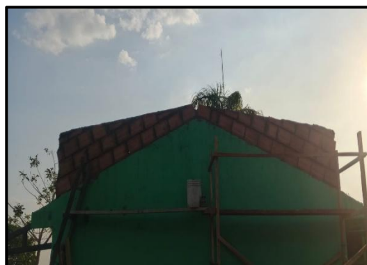
Foto 2: Se evidencia el levantamiento de Muros con Bloques Maguncia en la parte Posterior del Salón.
