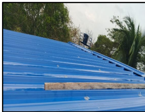
Foto 2: Se evidencia la Instalación de la Cubierta Master Mil, con su respectivo Caballete, también se evidencia la Aplicación del sellante para Goteras en todos los Amarres.
