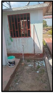
Foto 1: Pintura existente de los Muros del Cuarto donde se encuentra la Planta Eléctrica de la Escuela La Venturosa.
