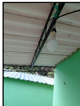
Foto 2: Se realizó la Instalación de Lámparas en zonas exteriores de la Escuela.
