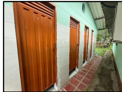
Foto 2: Suministro e Instalación de Pintura en Vinilo de los Muros de las Baterías Sanitarias de la Escuela La Venturosa.
