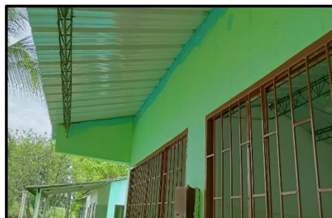
Foto 2: Suministro e Instalación de Pintura en Aceite para la Puerta y Ventanas del Salón de Clases.
