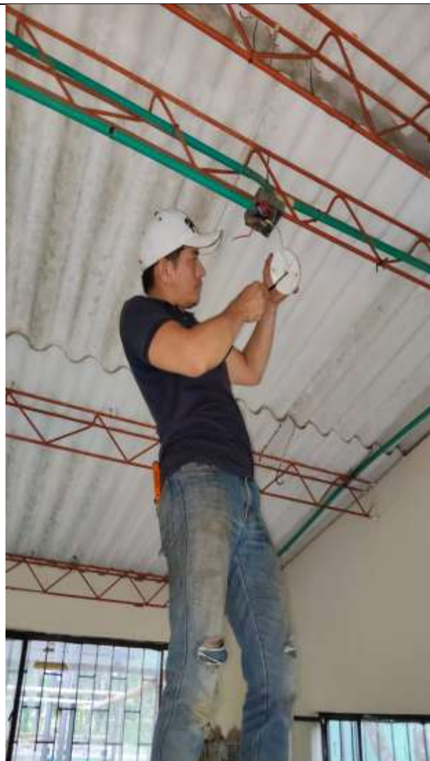
Foto 2: Estado Final Desmonte punto eléctrico salida luminaria
