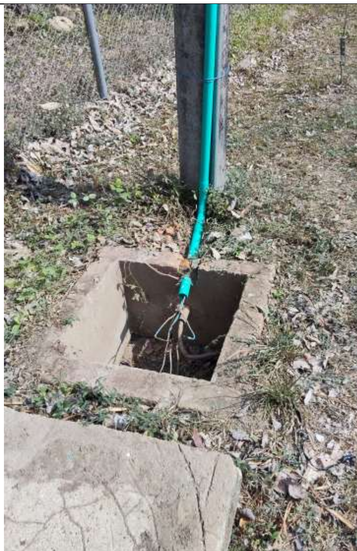
Foto 2: : Estado Final de sondeo y limpieza de conductos .
