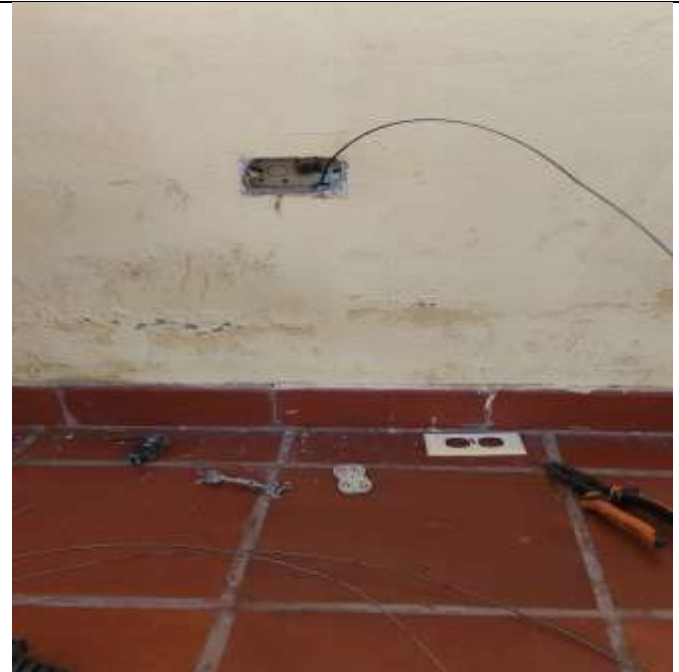
Foto 2: Sondeo de cableado
