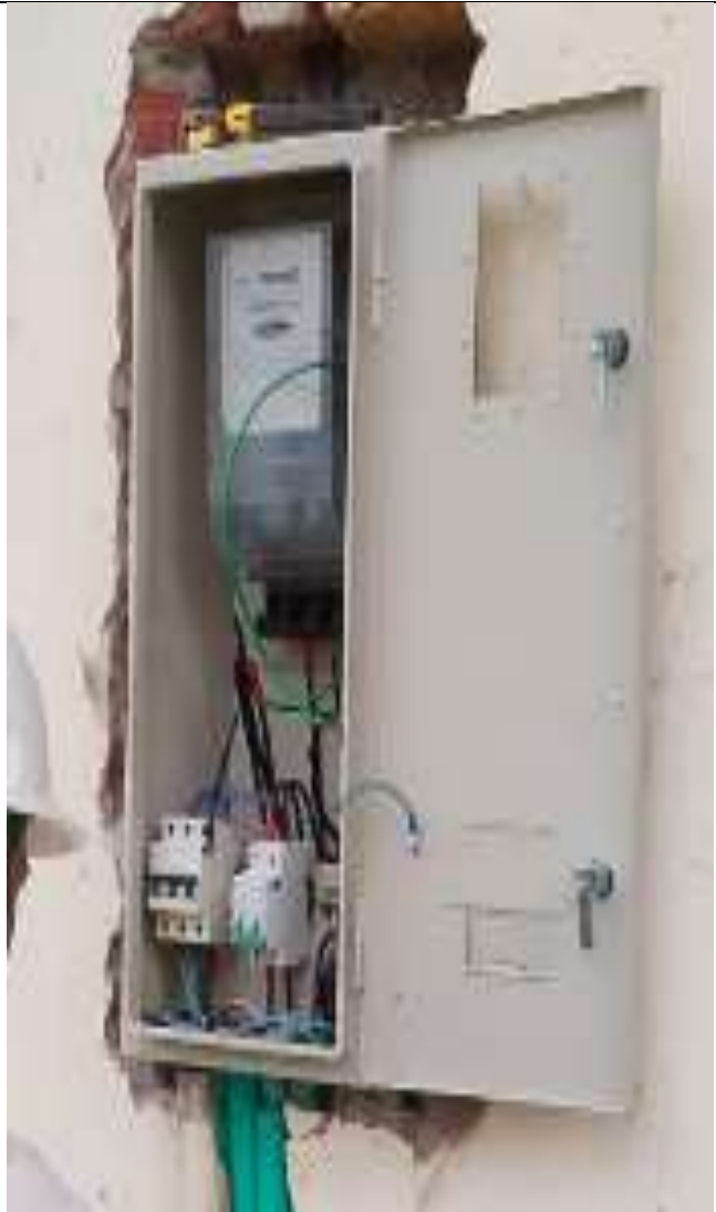
Foto 2: instalación final de breaker 2 x 63 Amp.
