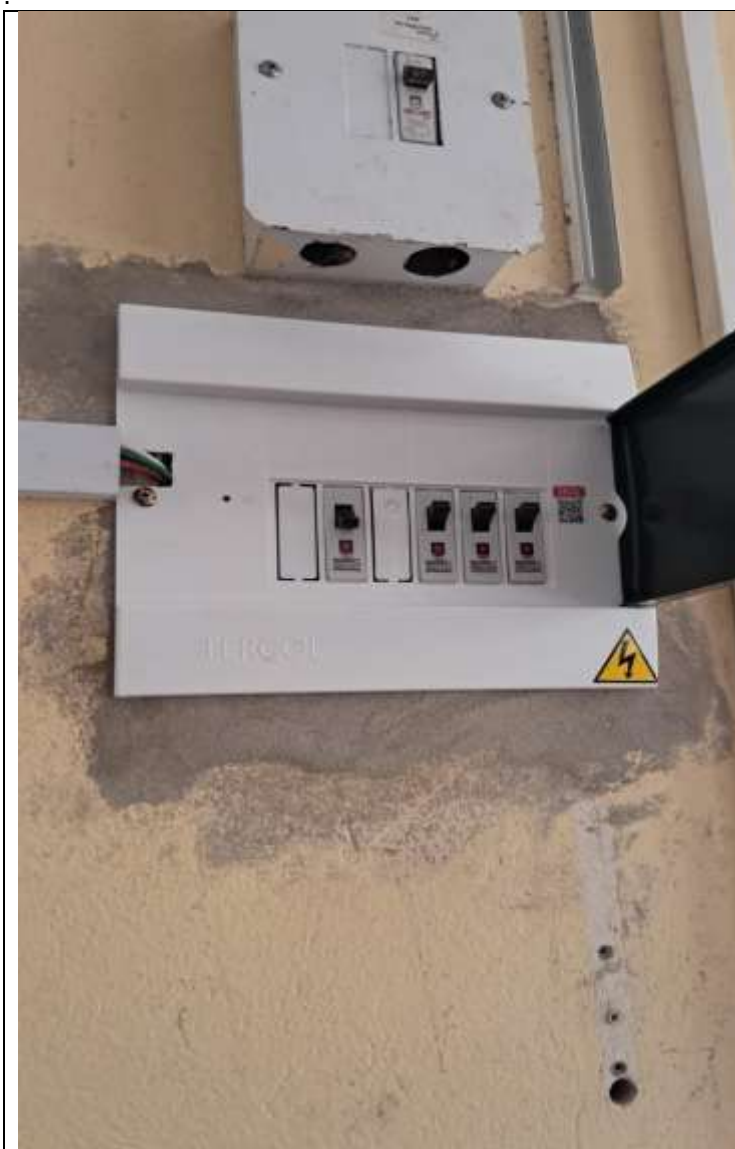
Foto 1: instalación de 4 breaker de 1 x 20 Amp,
