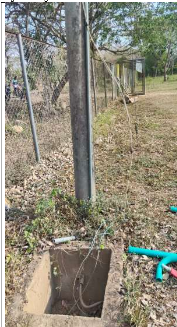
Foto 1: Estado inicial sondeo y limpieza de conductos
