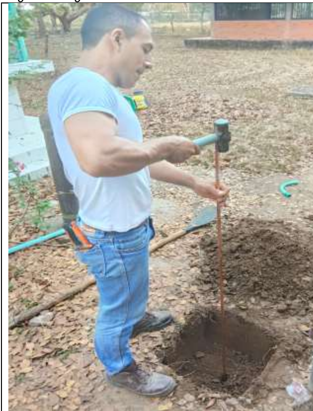
Foto 1: instalación de varilla de cobre coperwerld 1/2" x 2,5 m,
