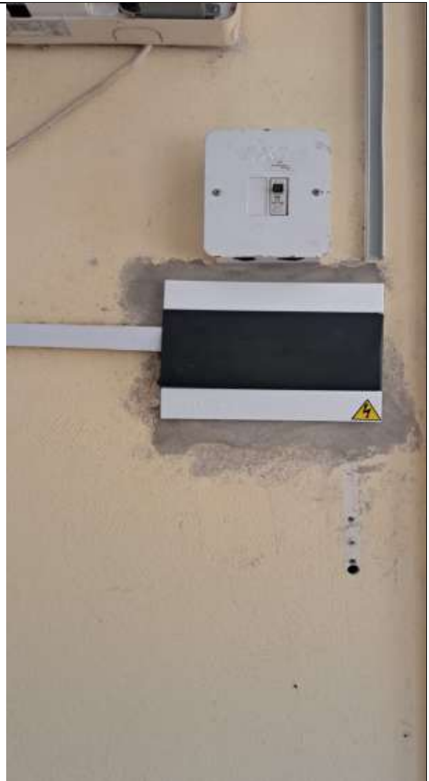
Foto 2: instalación caja de 4 circuitos
