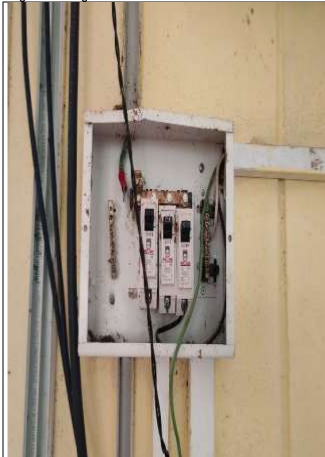
Foto 1: Estado inicial del tablero
