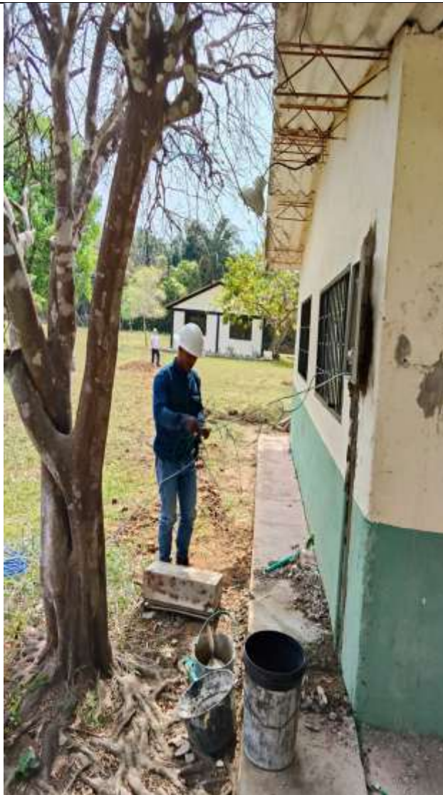
Foto 2: instalación de alambre de Cobre THWN N° 14 AWG color verde.
