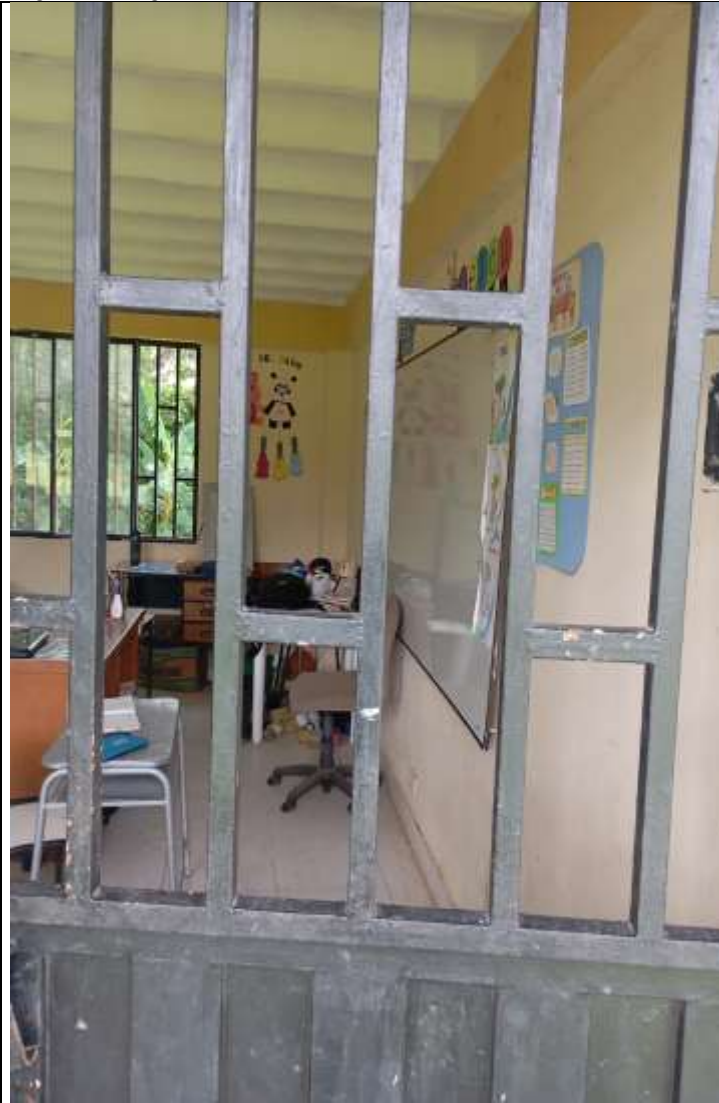
Foto 1: instalación de vidrios
