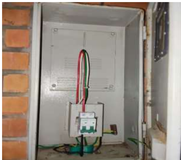
Foto 2: estado final con breaker
