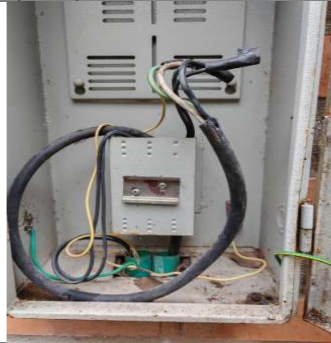
Foto 1: instalacion cable 8 AWG cobre de color blanco
