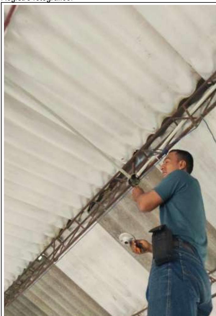
Foto 1: Estado inicial de iluminación
