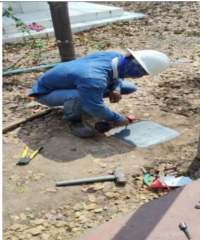
Foto 2: construcción de caja de SPT.
