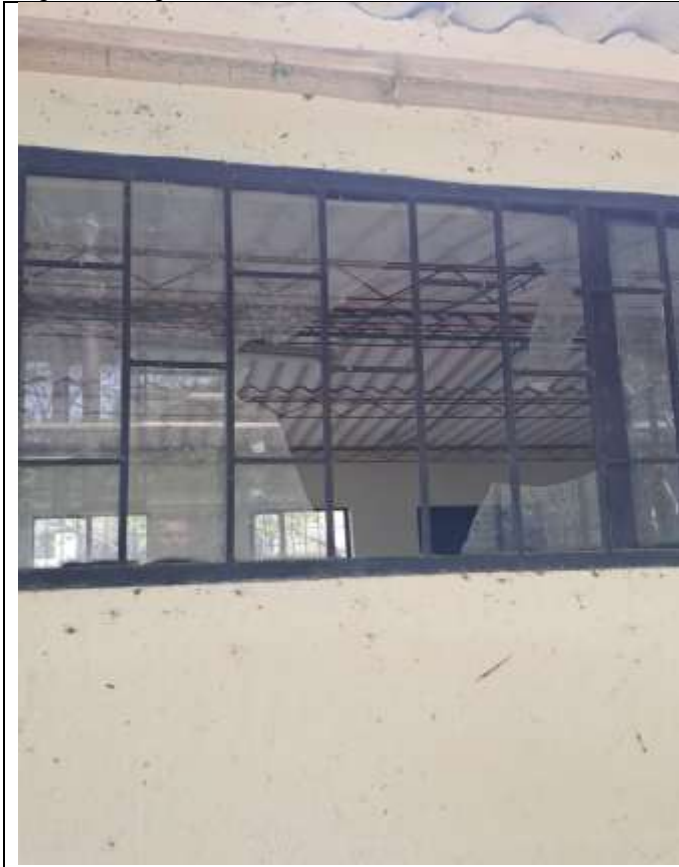
Foto 1: Estado Inicial de ventanas
