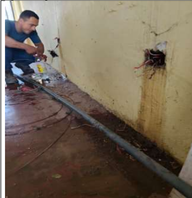
Foto 1: Limpieza de la tubería
