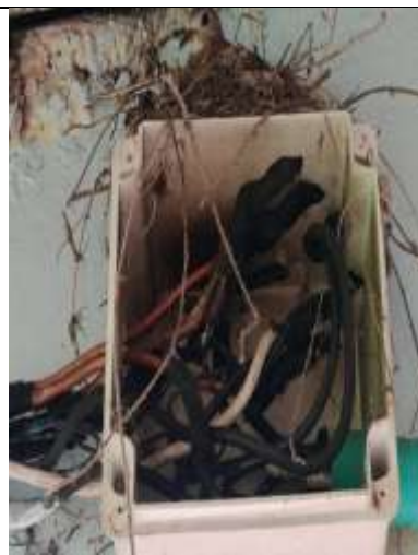
Foto 1: Estado Inicial de tubería PVC conduit 3/4
