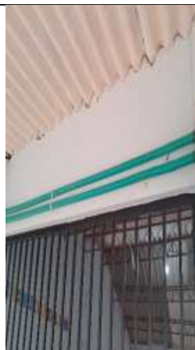
Foto 2: Estado Final instalación de tubería PVC conduit 3/4
