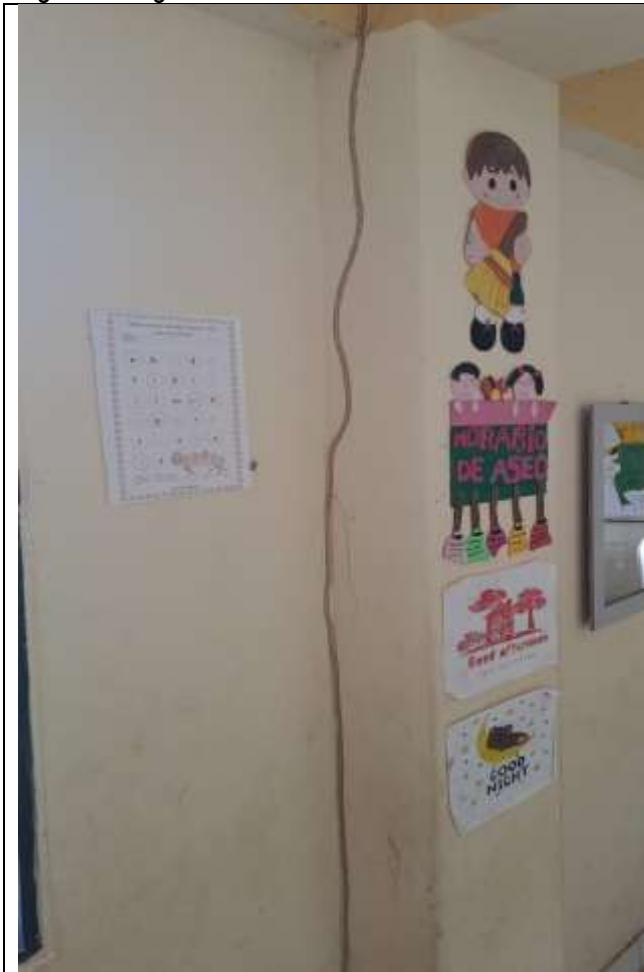
Foto 1: Estado Inicial de pintura
