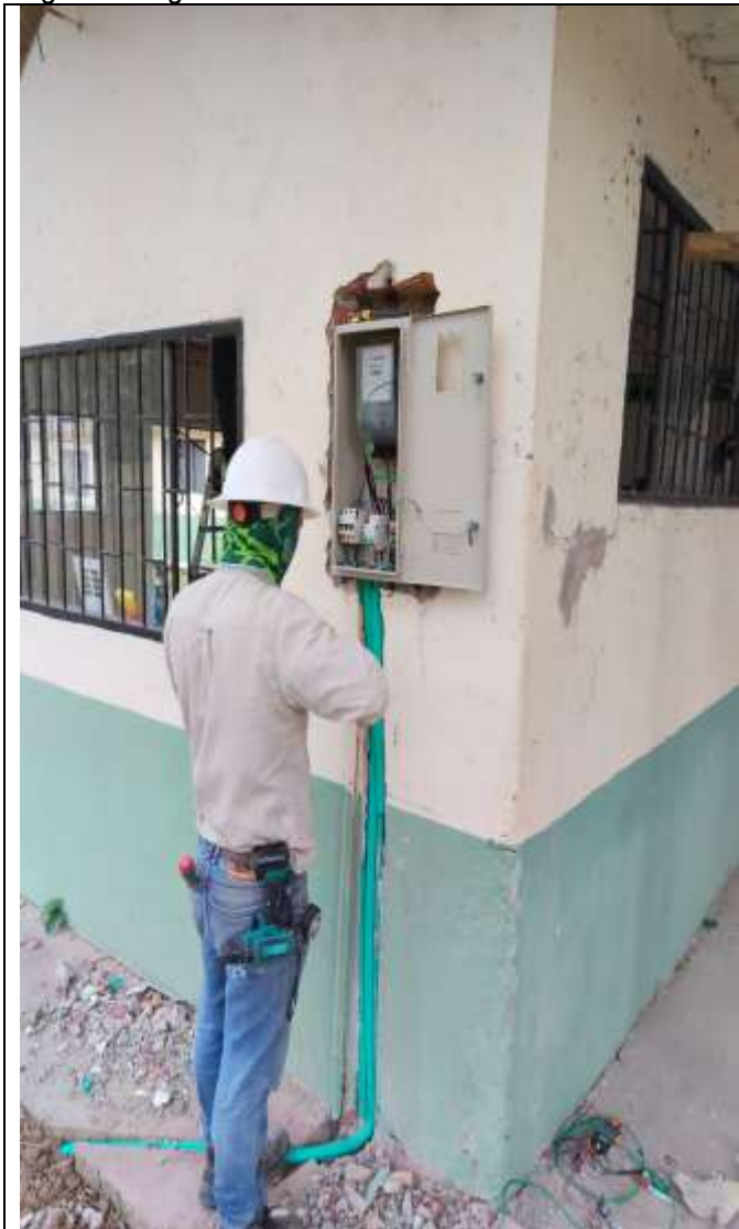
Foto 1: Estado inicial de instalación de tubería PVC conduit 3/4
