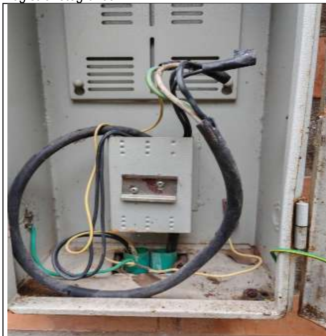
Foto 1: instalacion cable 8 AWG cobre de color rojo
