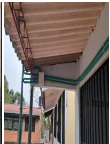
Foto 2: Estado Final instalación de tubería PVC conduit 3/4
