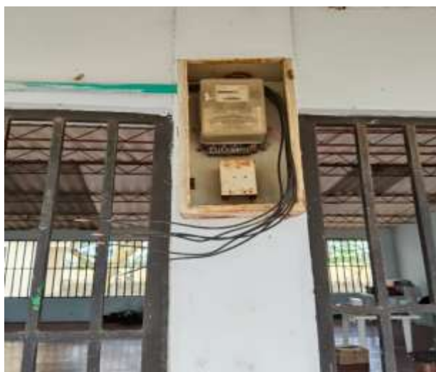
Foto 1: desmantelamiento de cableado
