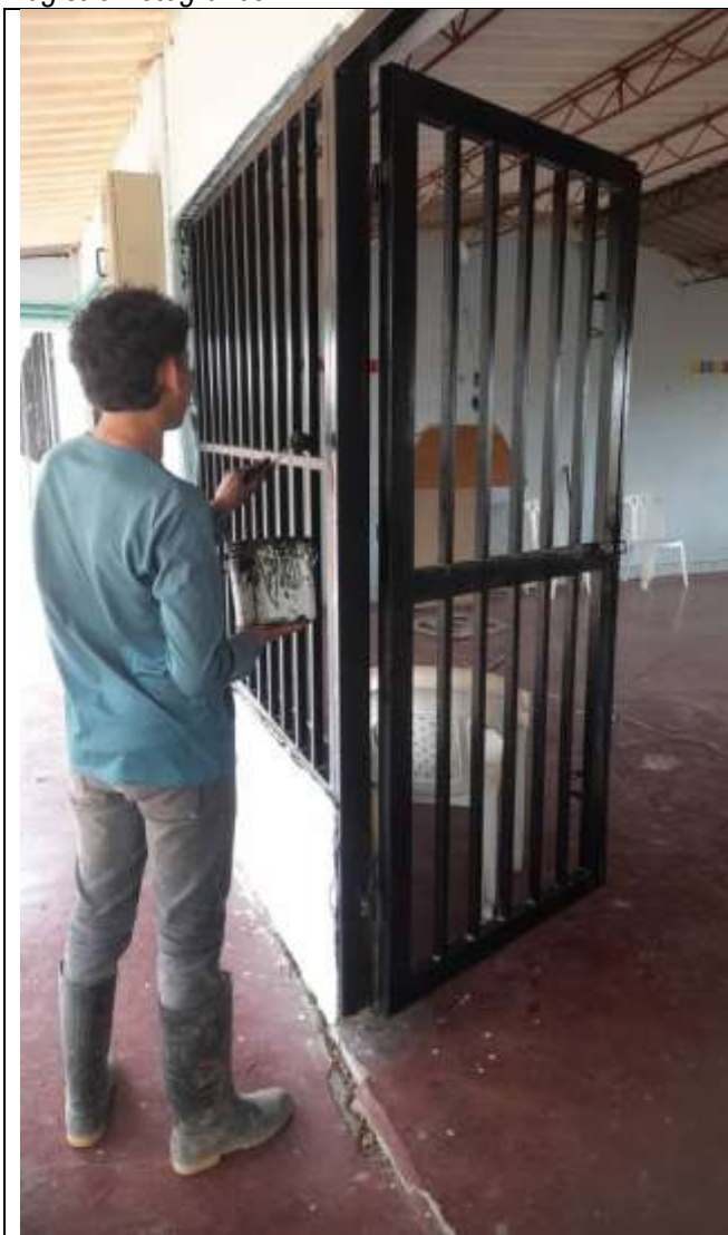
Foto 1: Puerta y ventana biblioteca inicial
