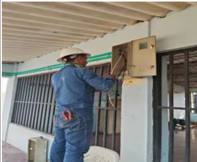
Foto 2: instalación de cable encauchado
