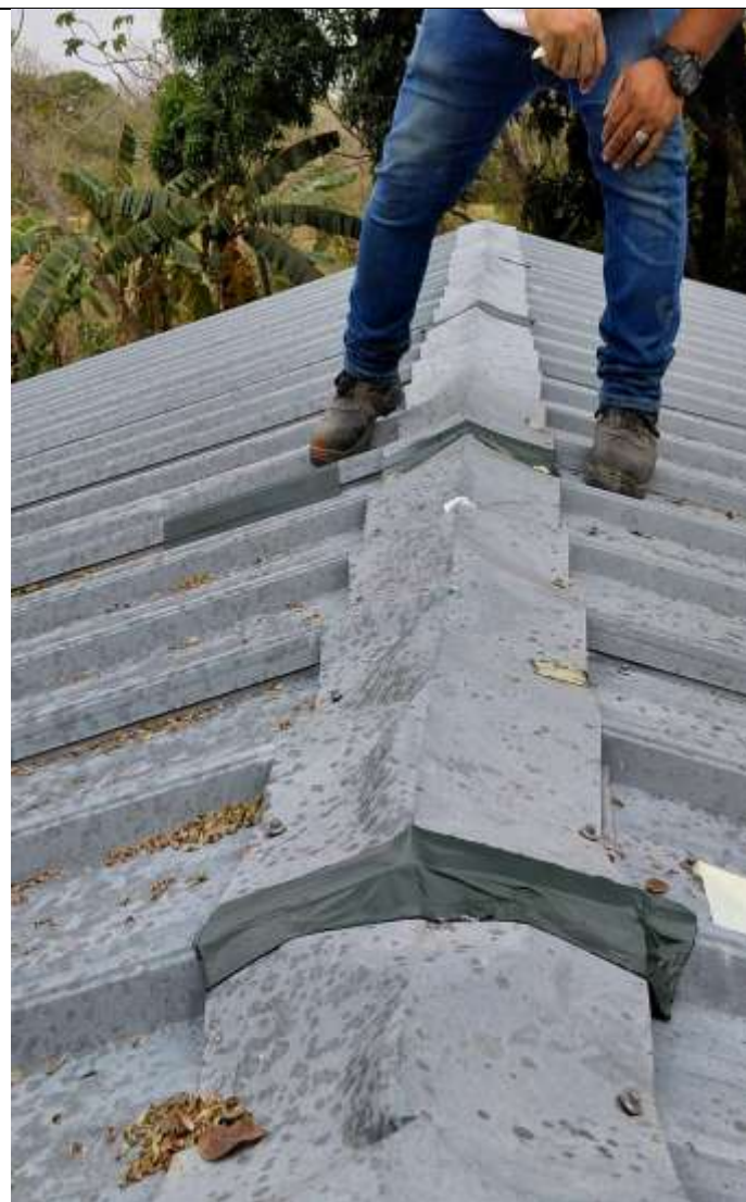
Foto 2: cinta asfáltica final
