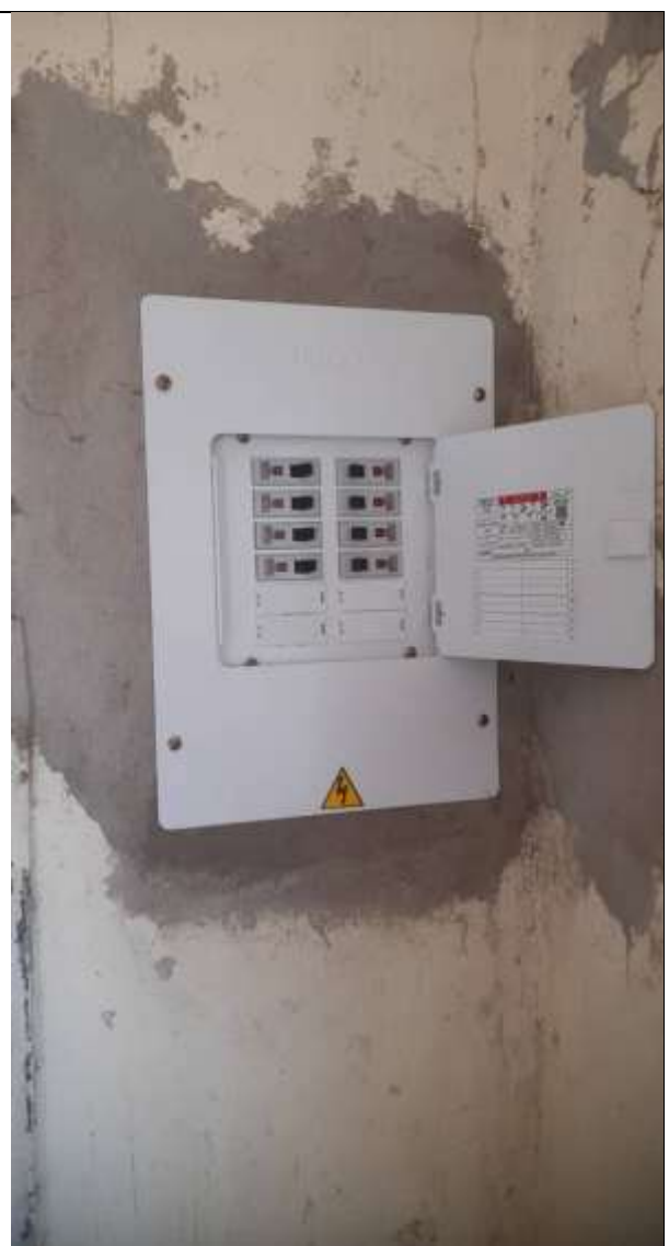
Foto 2: instalación de 8 breaker de 1 x 20 Amp,
