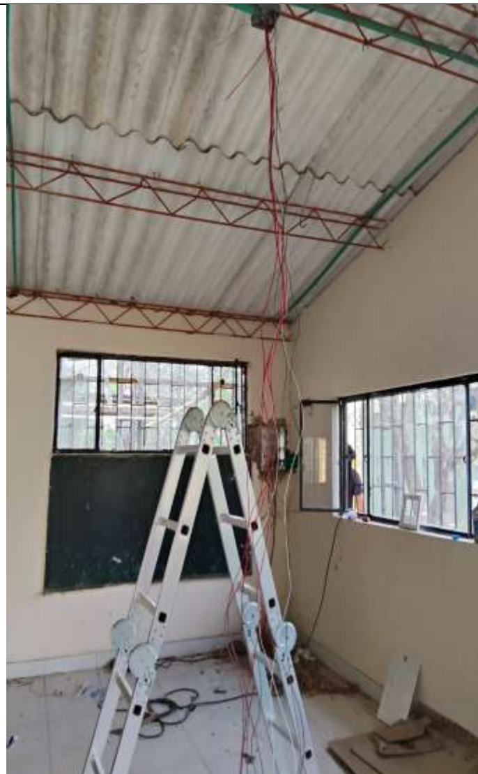
Foto 1: Estado Inicia Desmonte punto eléctrico salida luminaria
