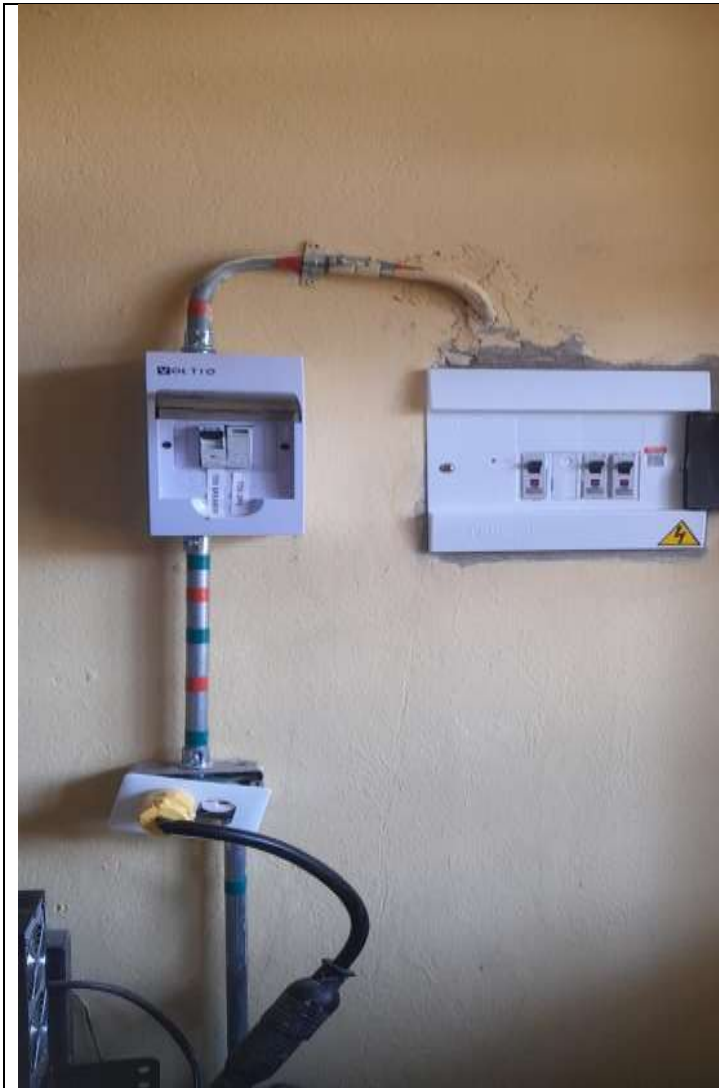
Foto 1: instalación caja de 4 circuitos
