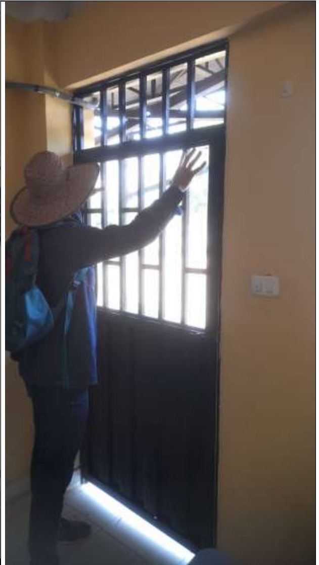
Foto 2: instalación de vidrios
