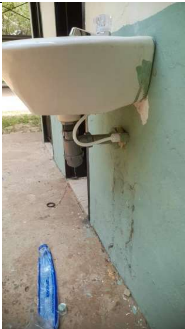
Foto 2: instalación pitorra sanitaria
