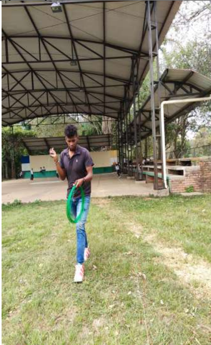
Foto 1: instalación de alambre de Cobre THWN N° 14 AWG color verde.
