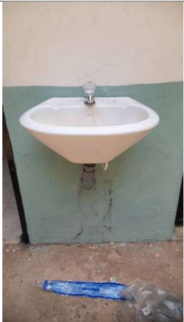
Foto 2: Estado Final conexión lavamanos
