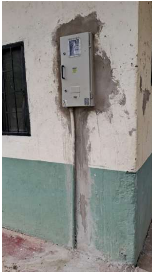
Foto 2: Estado Final de instalación de tubería PVC conduit 3/4
