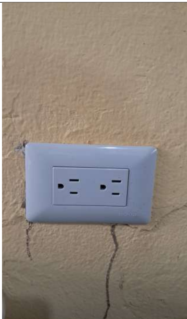
Foto 2: Estado final instalación de cobre THWN N°12 AWG, color rojo o negro
