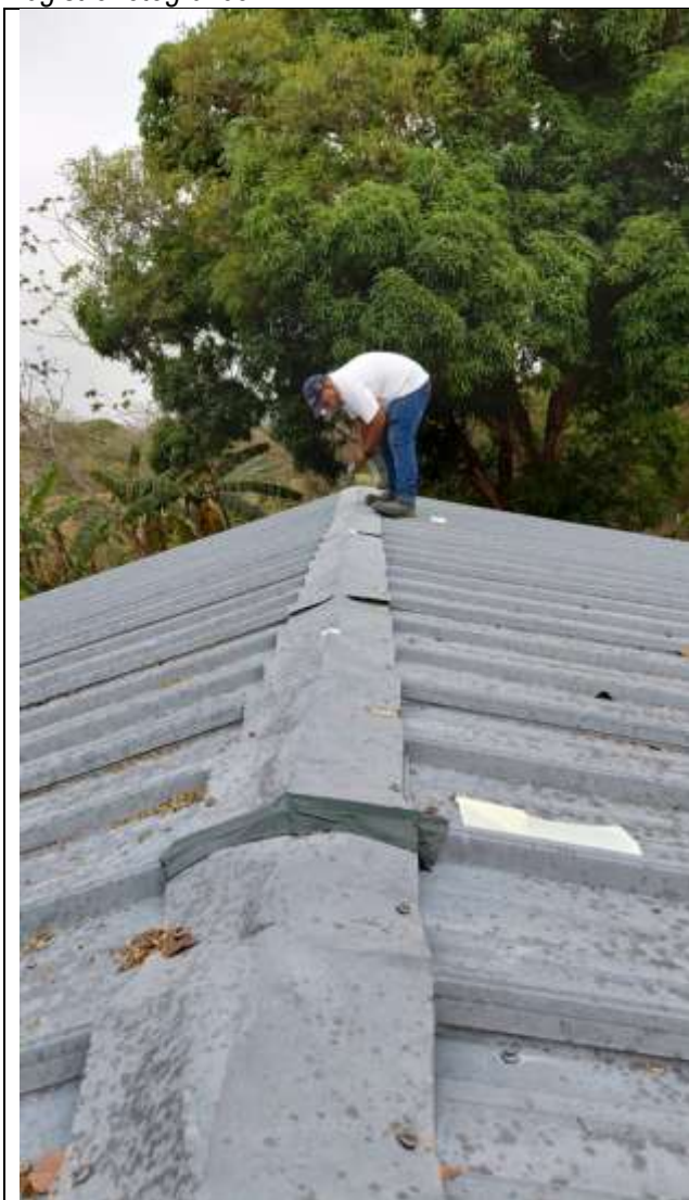
Foto 1: cinta asfáltica inicial
