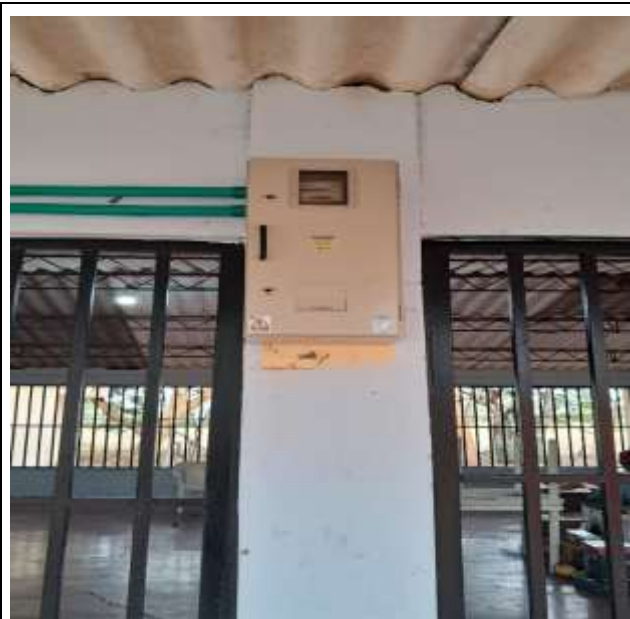
Foto 2: Estado final caja
