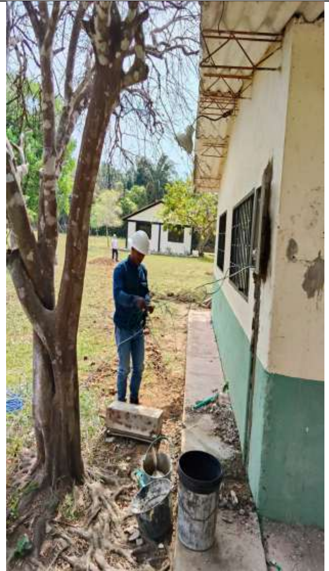
Foto 2: instalación de alambre de Cobre THWN N° 14 AWG color verde.
