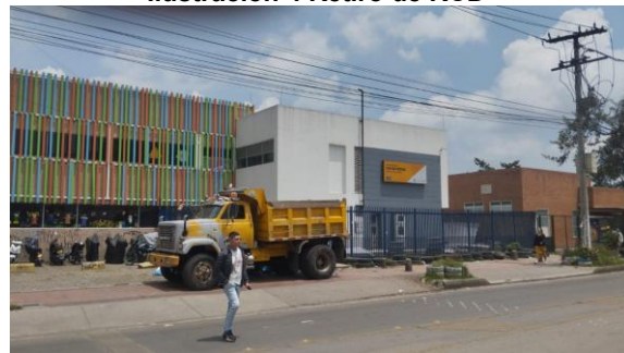
Ilustración 4 Retiro de RCD
