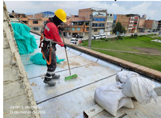
Ilustración 16 Jornadas de orden y aseo en obra
