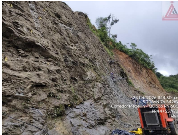
Figura 5. PR 44+850 Ruta 6002, Perforación para instalación de pernos soporte malla protección talud.
