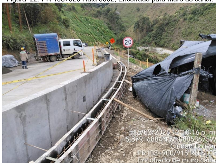
Figura 22. PR 103+920 Ruta 6002, Encofrado para muro de canal.
