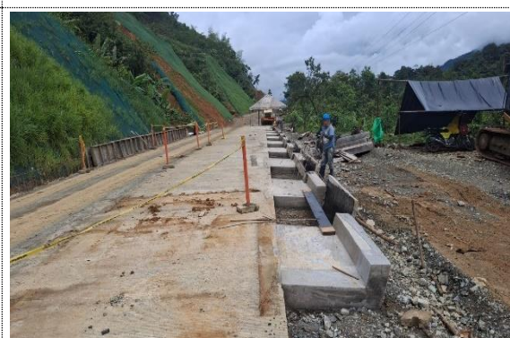
PR 71+700 RUTA 6002, CONSTRUCCIÓN DE CUNETAS.
