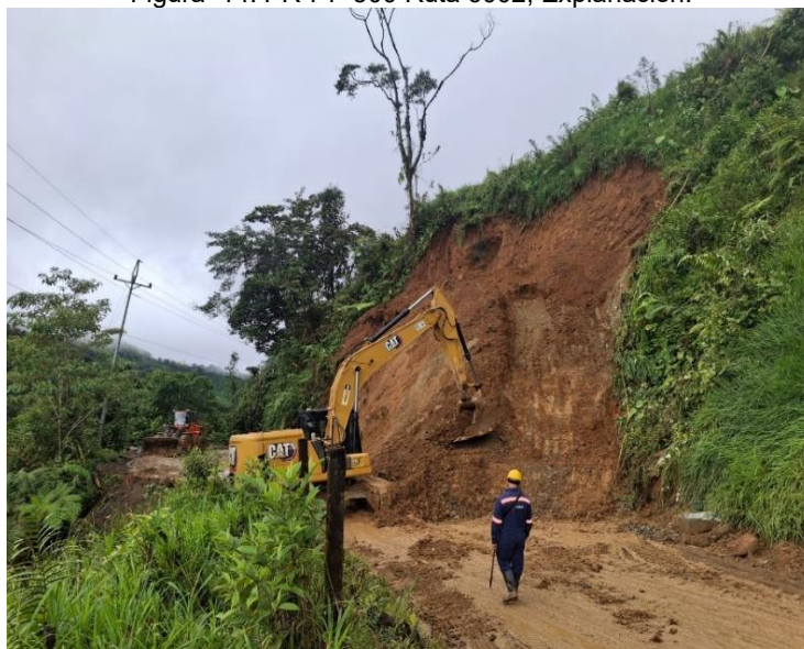
Figura 14. PR 71+500 Ruta 6002, Explanación.
