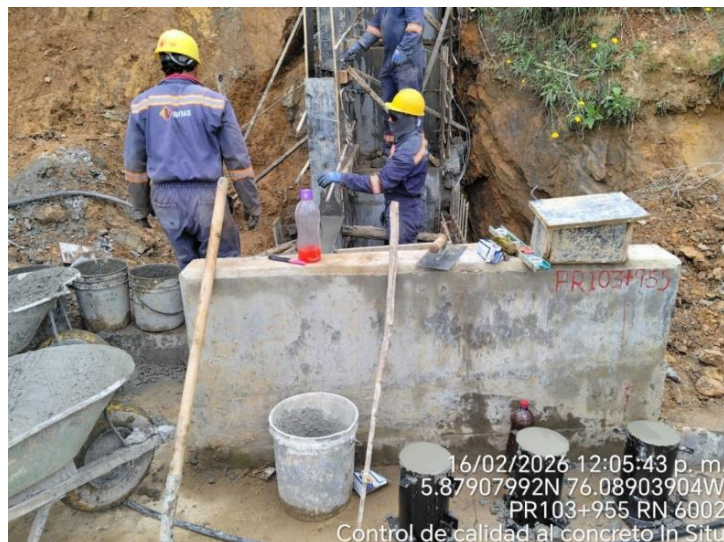
Figura 22. PR 103+920 Ruta 6002, Encofrado para muro de canal.
