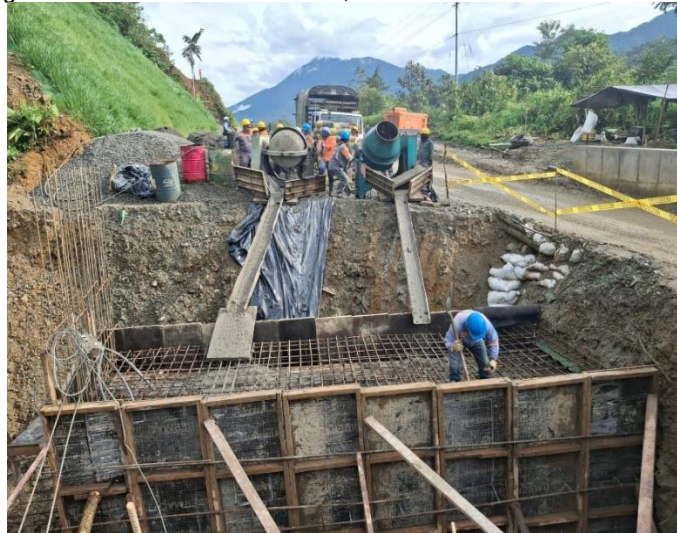
Figura 13. PR 71+850 Ruta 6002, Vaciado de muros de box coulvert.
