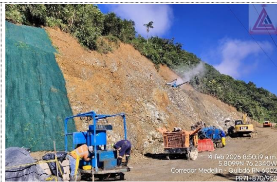
PR 71+870 RUTA 6002, PERFORACIÓN E INSTALACIÓN DE ANCLAJES ACTIVOS.
