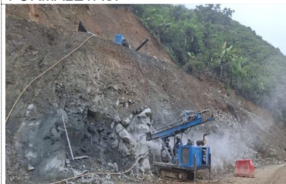
PR 71+730 RUTA 6002, PERFORACIÓN PARA INSTALACIÓN DE ANCLAJES ACTIVOS.
