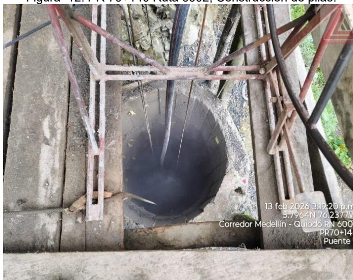
Figura 12. PR 70+140 Ruta 6002, Construcción de pilas.
