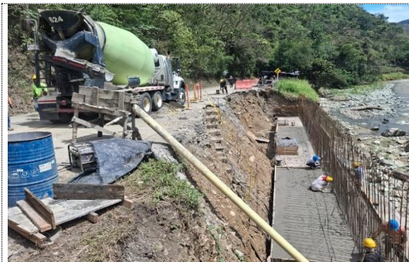
PR 36+810 RUTA 6003, CONSTRUCCIÓN DE MURO.
