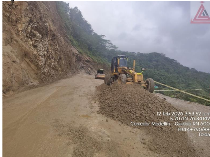
Figura 6. PR 44+790 Ruta 6002, Conformación de subrasante.
