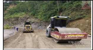
PR 45+000 RUTA 6002, MEJORAMIENTO SUBRASANTE.
