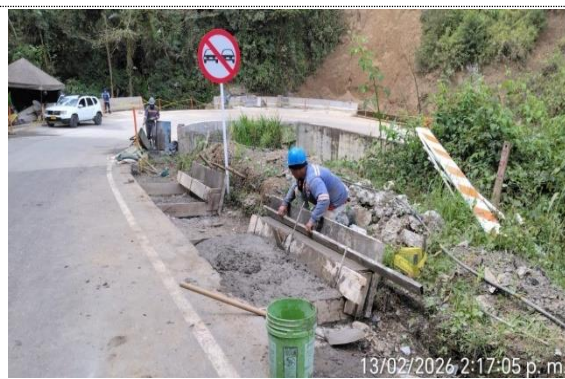
PR 98+730 RUTA 6002, CONSTRUCCIÓN DE CUNETAS.
