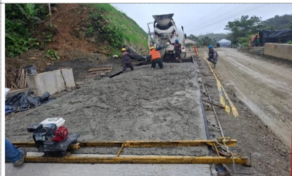
PR 60+850 RUTA 6002, VACIADO DE LOSAS EN CONCRETO.
