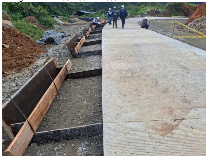
Figura 11. PR 66+400 Ruta 6002, Encofrado de cunetas.
