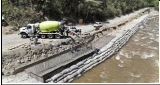
PR 36+800 RUTA 6003, CONSTRUCCIÓN DE MURO.
