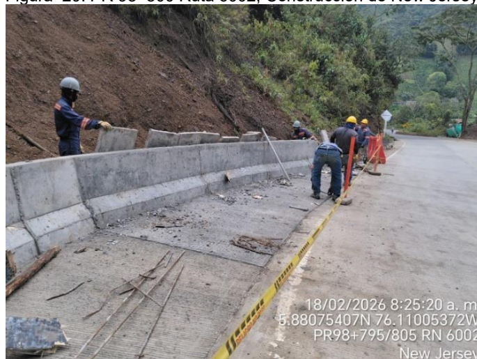
Figura 20. PR 98+800 Ruta 6002, Construcción de New Jersey.
