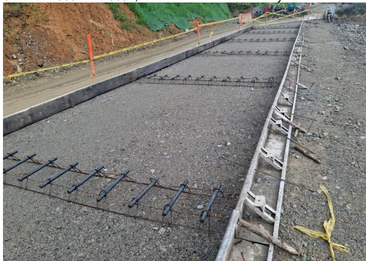
Figura 16. PR 71+800 Ruta 6002, Instalación de formaletas y barras de transferencias.
