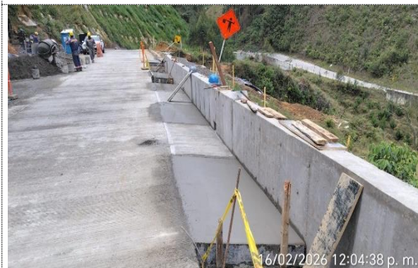
PR 103+920 RUTA 6002, CONSTRUCCIÓN DE CUNETAS.
