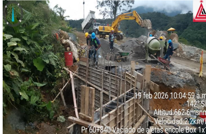
Figura 7. PR 60+840 Ruta 6002, Vaciado de aletas encole Box 1x1.
