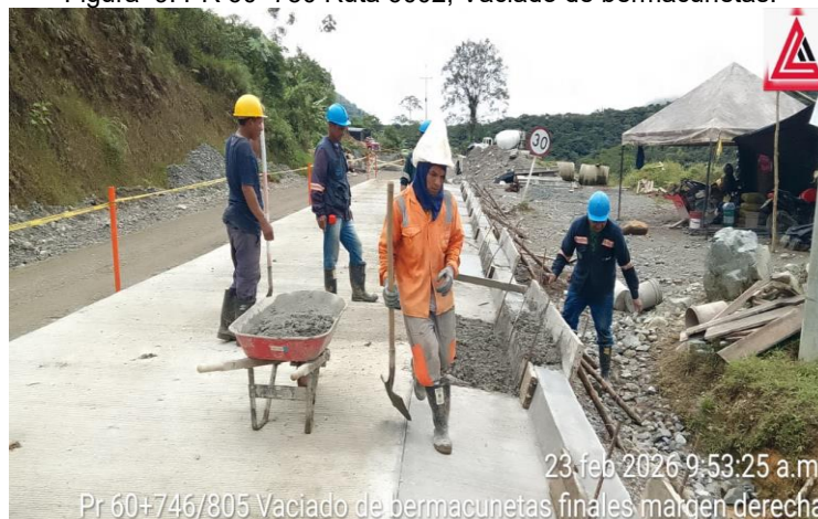
Figura 9. PR 60+750 Ruta 6002, Vaciado de bermacunetas.
