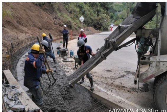
PR 98+790 RUTA 6002, VACIADO DE SOBREENCHO.
