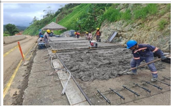
PR 71+860 RUTA 6002, VACIADO DE LOSAS.
