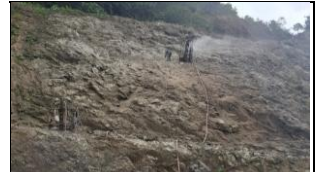
PR 44+600 RUTA 6002, PERFORACIÓN PARA INSTALACIÓN DE PERNOS SOPORTE PARA MALLA.
