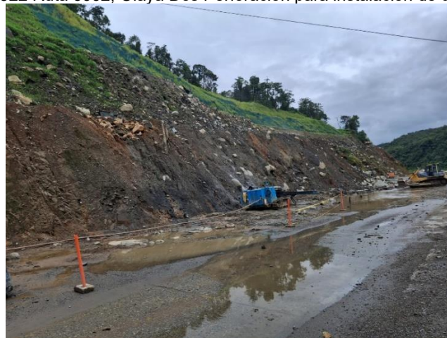
Figura 4. PR 43+922 Ruta 6002, Olaya Dos Perforación para instalación de drenes horizontales.
