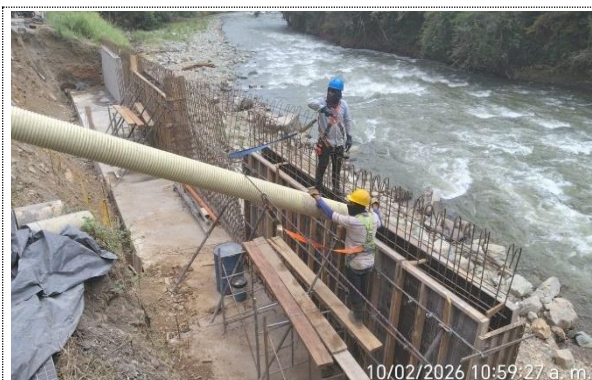
PR 36+810 RUTA 6003, VACIADO DE VASTAGO.
