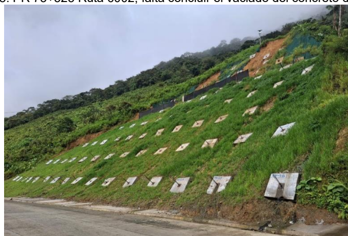
Figura 18. PR 73+525 Ruta 6002, falta concluir el vaciado del concreto de 6 dados.
