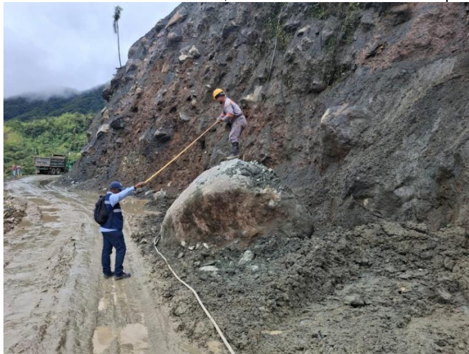
Figura 10. PR 66+400 Ruta 6002, Fracturación de rocas con explosivos
