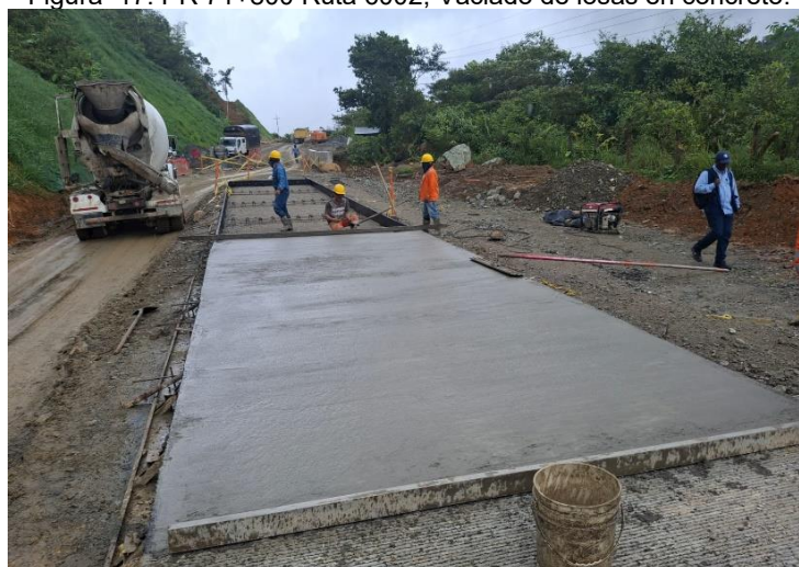
Figura 17. PR 71+800 Ruta 6002, Vaciado de losas en concreto.
