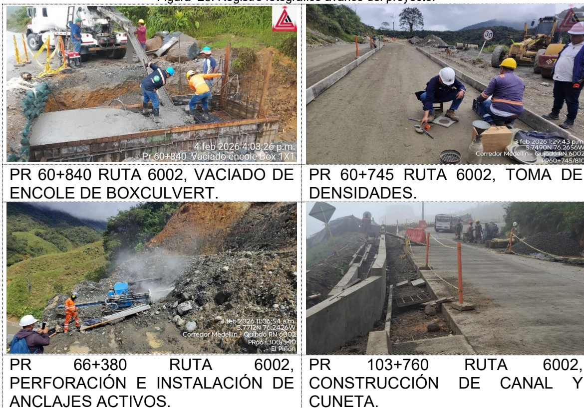
Figura 28. Registro fotográfico avance del proyecto.
