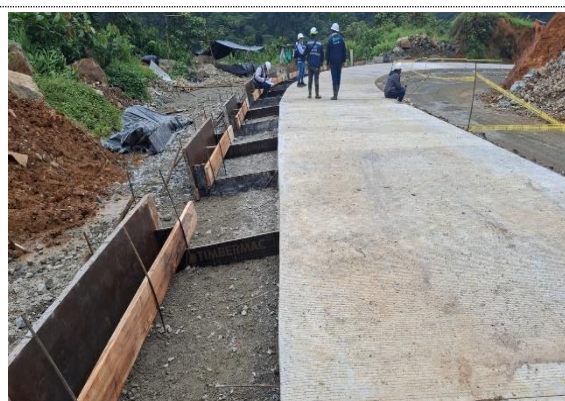
PR 66+600 RUTA 6002, CONSTRUCCIÓN DE CUNETAS.
