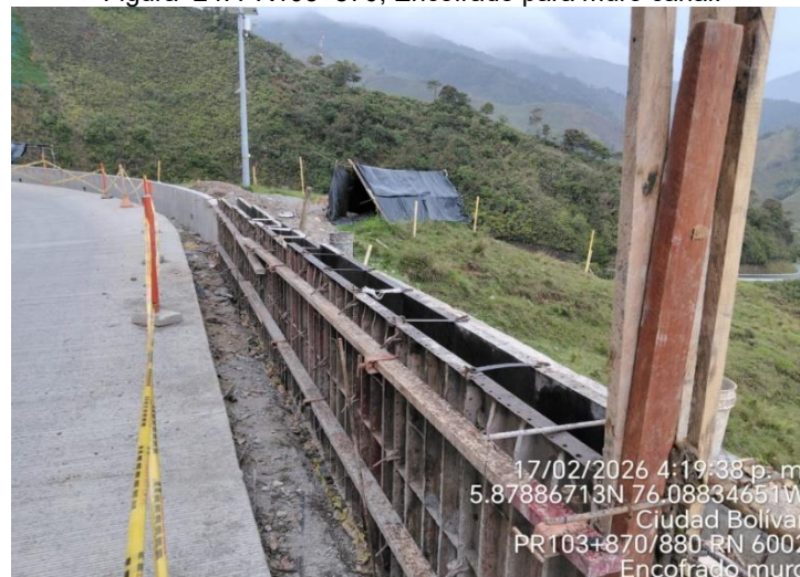
Figura 24. PR103+870, Encofrado para muro canal.
