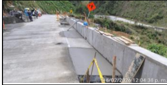
PR 103+920 RUTA 6002, CONSTRUCCIÓN DE CUNETAS.
