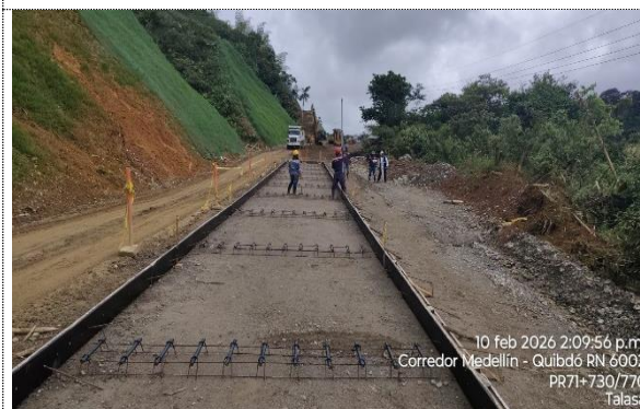
PR 71+730 RUTA 6002, INSTALACIÓN DE SBG, BARRAS DE TRANSFERENCIA DE CARGA Y FORMALETAS.
