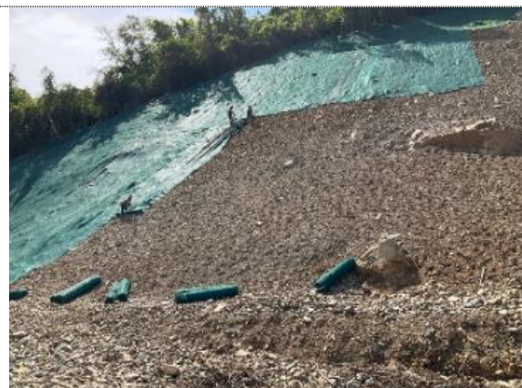
PR36+200 RUTA 6003- EMPRADIZACIÓN Y REVEGETALIZACIÓN DE TALUD
