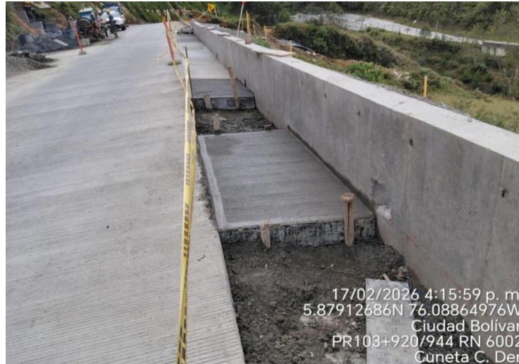
Figura 24. PR103+870, Encofrado para muro canal.
