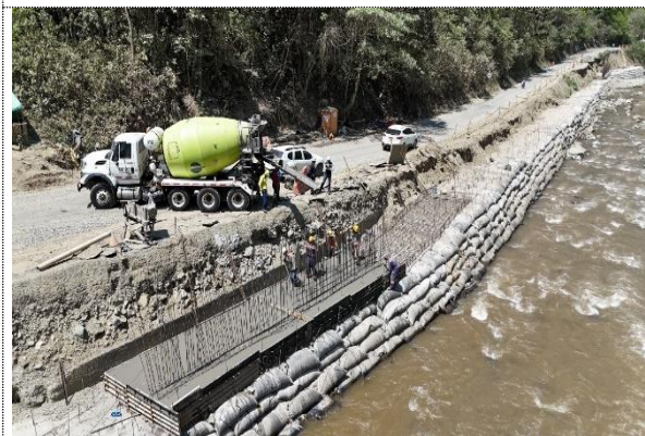
PR 36+800 RUTA 6003, CONSTRUCCIÓN DE MURO.
