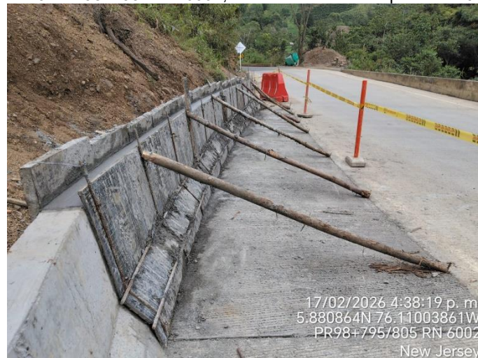
Figura 19. PR 98+795 Ruta 6002, Vaciado de concreto para New Jersey.
