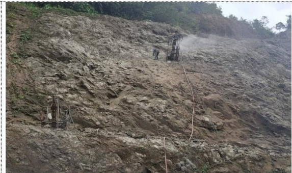
PR 44+600 RUTA 6002, PERFORACIÓN PARA INSTALACIÓN DE PERNOS SOPORTE PARA MALLA.
