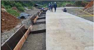
PR 66+600 RUTA 6002, CONSTRUCCIÓN DE CUNETAS.
