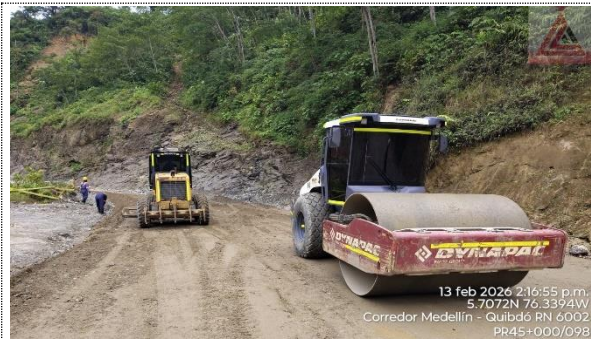
PR 45+000 RUTA 6002, MEJORAMIENTO SUBRASANTE.
