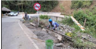
PR 98+730 RUTA 6002, CONSTRUCCIÓN DE CUNETAS.
