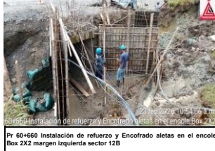
Pr 60+660 Instalación de refuerzo y Encofradoaletas en el encole Box 2X2 margen izquierda sector 12B
