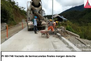
Pr 60+746 Vaciado de bermacutetas finales margen derecha
