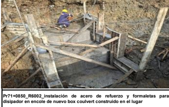
Pr71+0850_R6002_instalación de acero de refuerzo y formaleas para disipador en encole de nuevo box culvert construido en el lugar
