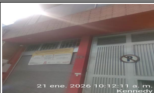
Inspección Punto PAC
