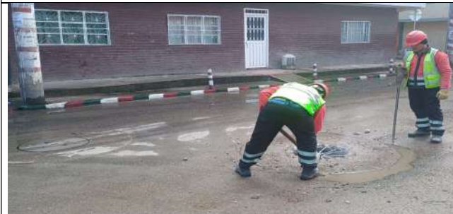
Localización, destape y cambio de tapas en pozos de alcantarillado sellados.
