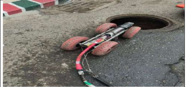
Inspección interna de red de alcantarillado mediante equipo robotizado CCTV.
