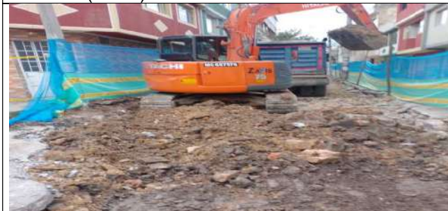
Cargue, retiro y transporte de material de excavación CIV 8009549 (NC28).
