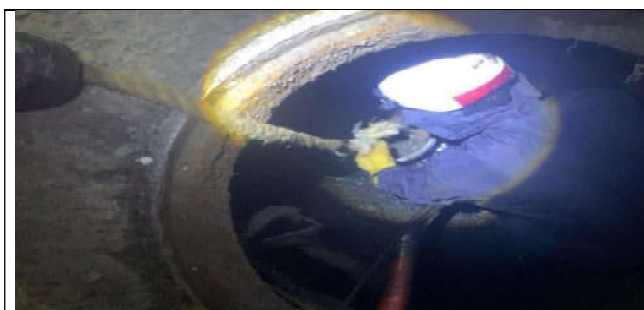
Destape y limpieza manual de pozo de inspección de alcantarillado.
