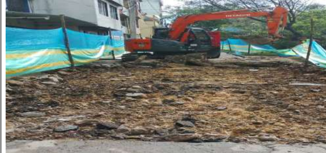
Demolición mecánica del pavimento existente en la vía CIV 8009556 (NC6).
