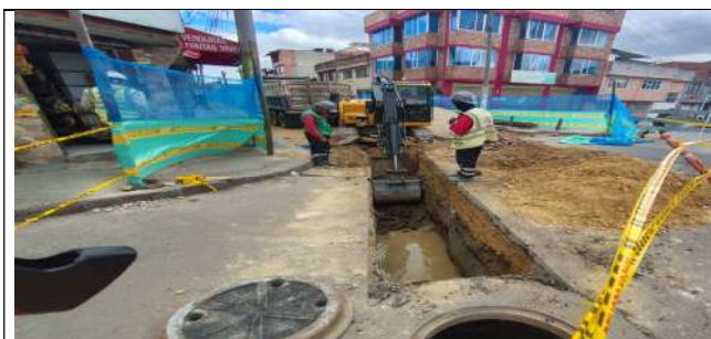
Excavación para instalación de red sanitaria CIV 8010695 (NC27).
