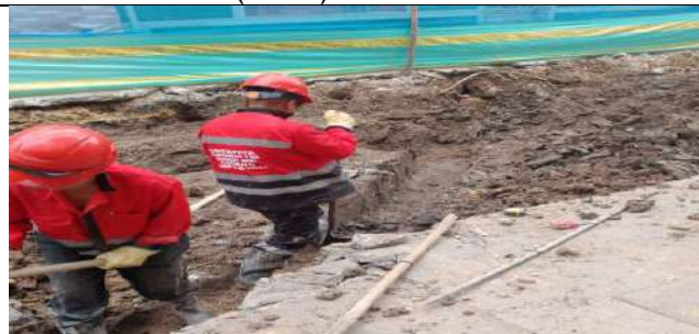
Excavación manual para domiciliarias CIV 8009549 (NC28).
