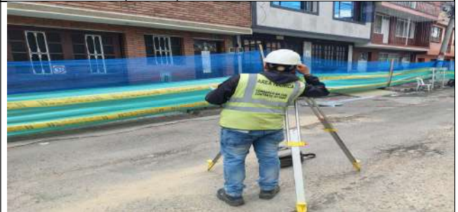
Replanteo topográfico general de la vía CIV 8010695 (NC27).
