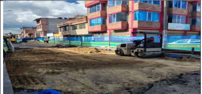
Compactación de la subrasante CIV 8010695 (NC27).
