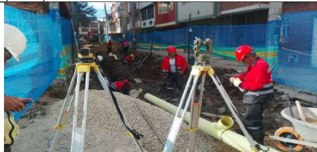
Replanteo topográfico general de la vía CIV 8009549 (NC28).
