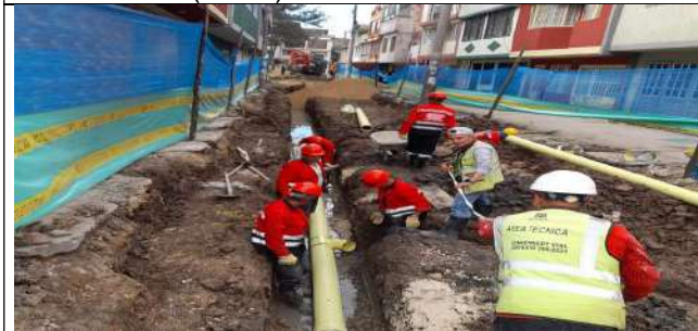
Excavación e instalación de tubería CIV 8009549 (NC28).
