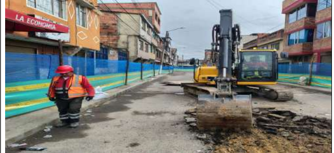
Demolición mecánica de la carpeta asfáltica existente CIV 8010695 (NC27).
