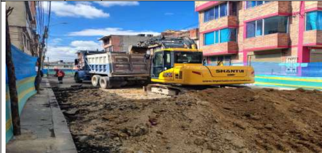
Cargue, retiro y transporte de material de excavación CIV 8010695 (NC27).
