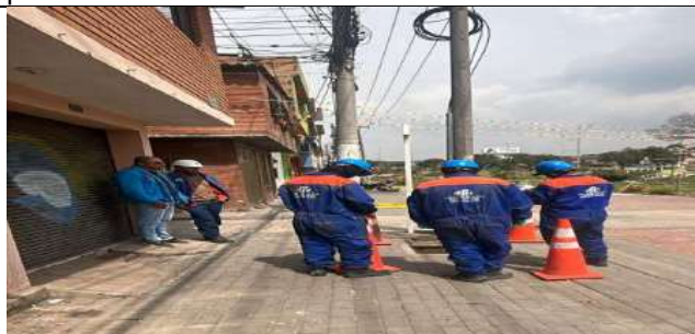
Recorrido técnico con la empresa de servicios públicos ETB.
