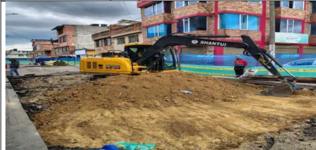
Excavación mecánica de material común en vía CIV 8010695 (NC27).
