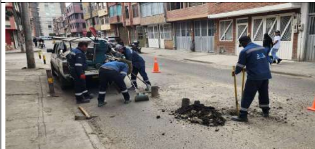
Apiques de los segmentos viales.
