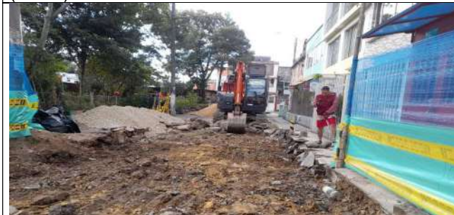
Demolición mecánica del pavimento existente en la vía CIV 8009623 (NC36).
