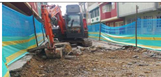
Demolición mecánica del pavimento existente en la vía CIV 8009549 (NC28).
