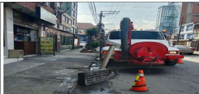
Lavado, limpieza e inspección de pozos y redes mediante inspección CCTV.
