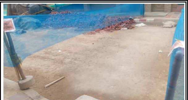
Cerramiento y sendero peatonal en el siguiente CIV: 8010914 - 8010695
