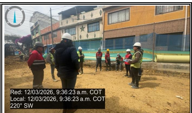
Capacitación de riesgos existentes en obra en siguiente CIV: 8010914 - 8010695
