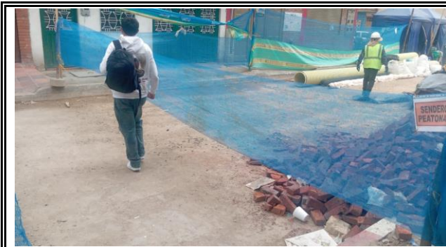
Cerramiento y sendero peatonal en el siguiente CIV: 8010914 - 8010695
