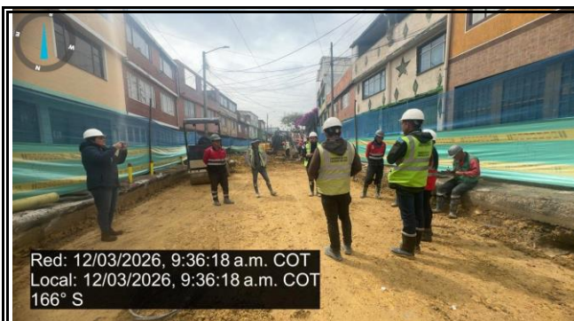
Capacitación de riesgos existentes en obra en siguiente CIV: 8010914 - 8010695
