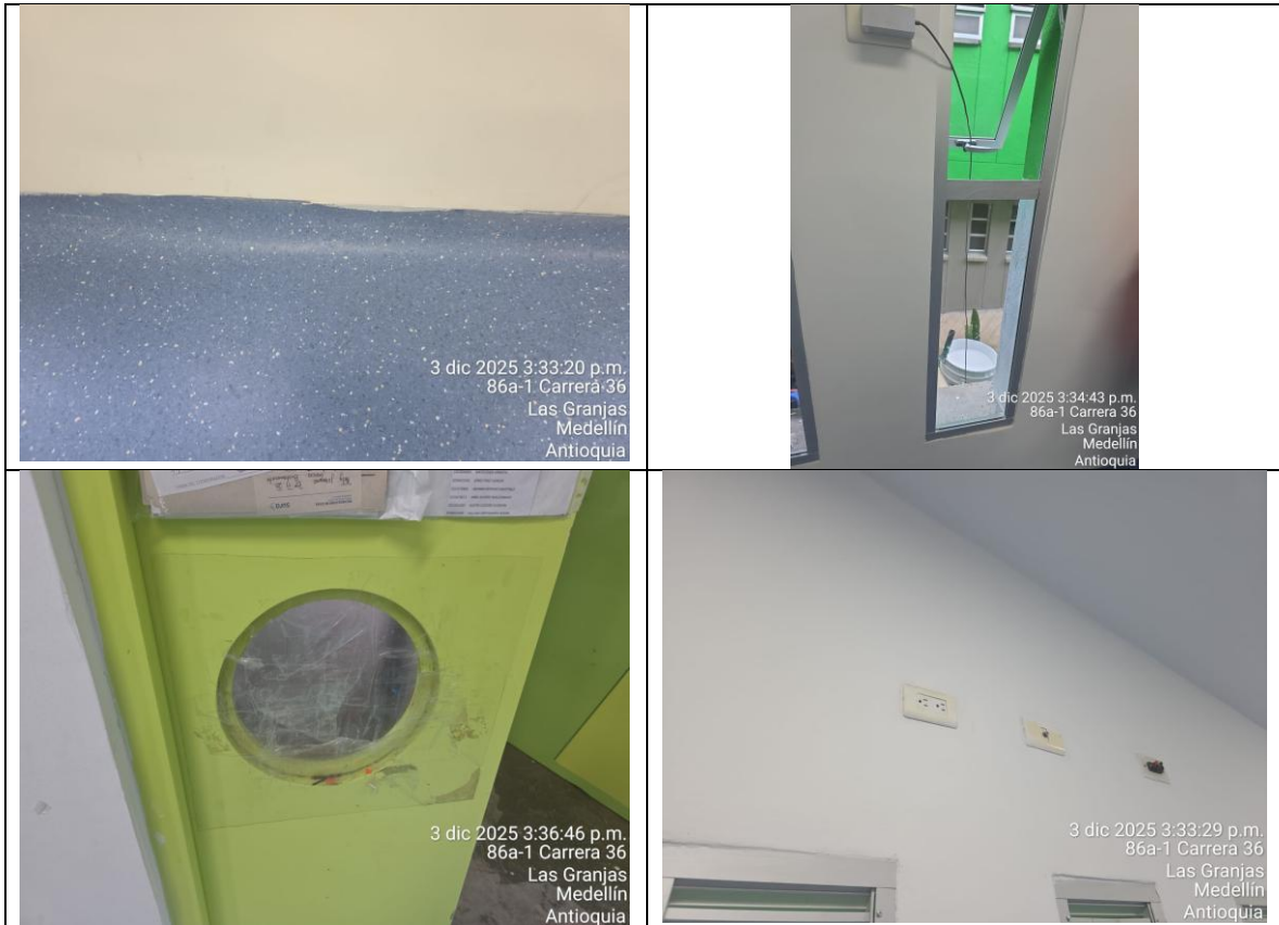
Imágenes tomadas el 3 de diciembre de 2025 – Recorrido de obra.
