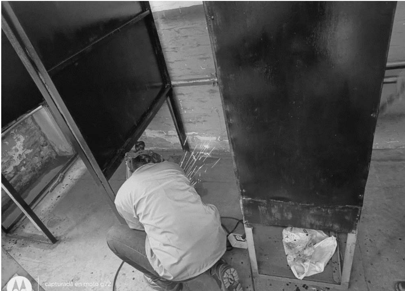
Fig 1. Reposicionamiento de cabinas restauradas, (Lijado y pintada con anticorrosivo) por l@s aprendices en la ficha: 3157626 – Abril 20 de 2026
