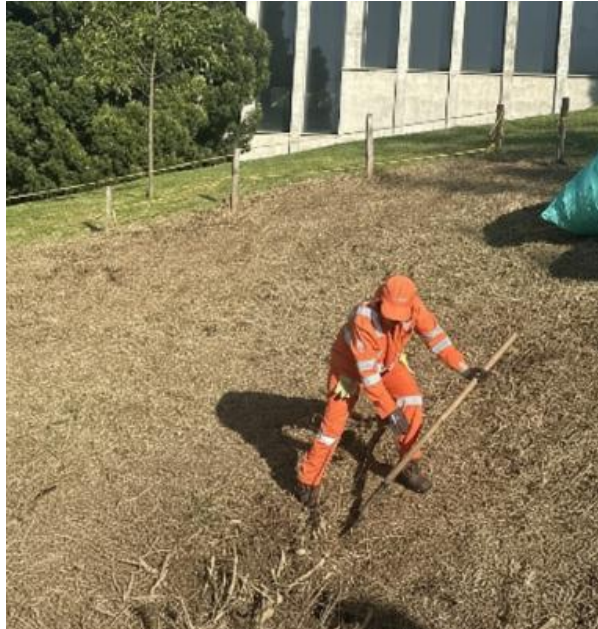
Ilustración 12 Remoción de tocones (Zona 2)
