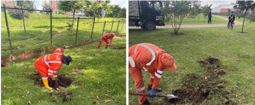
Ilustración 17 Preparación del suelo
