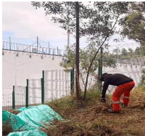
Ilustración 13 Remoción de tocones (Zona 3 - Puente)
