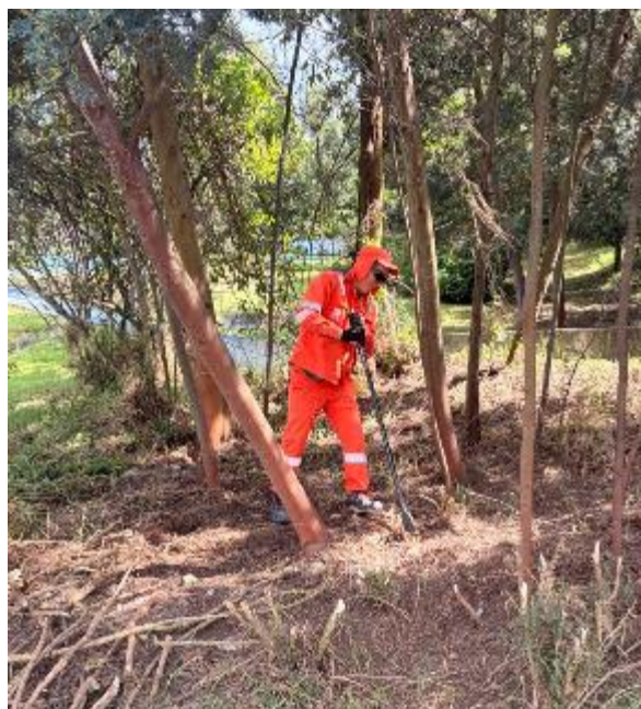
Ilustración 11 Remoción de tocones (Zona 1 – Pista de trote)
