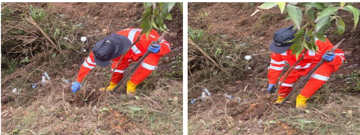
Ilustración 8 Remoción de tocones (Monserrate)
