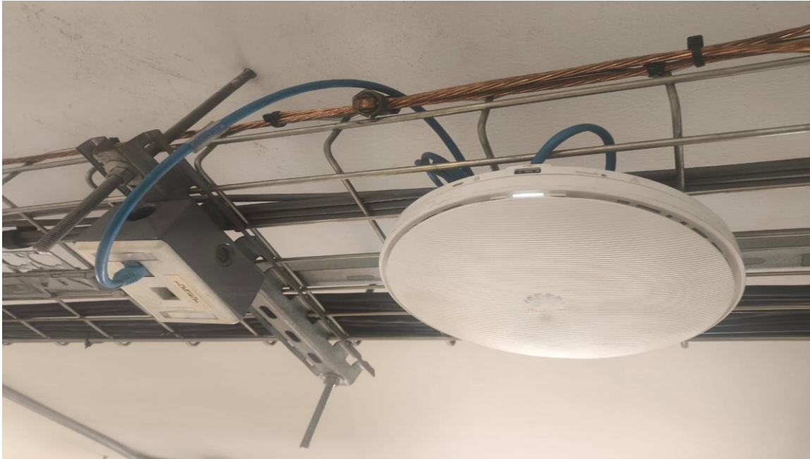
Verificación y pinchado el punto del AP 204.
