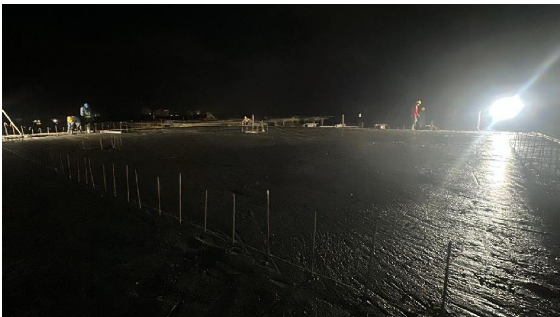
Fotografía 9. Fundida losa de cubierta bloque 2
