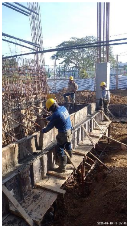
Fotografía 6. Fundición en concreto de viga cimiento Bloque 1
