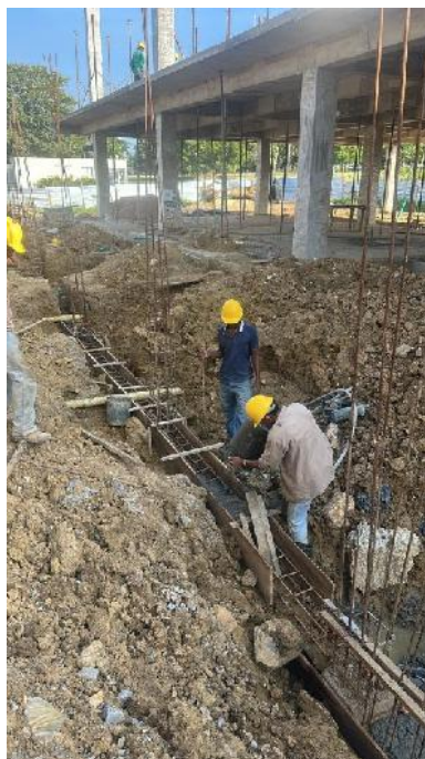
Fotografía 7. Fundición zarpa muro de contención rampa peatonal
