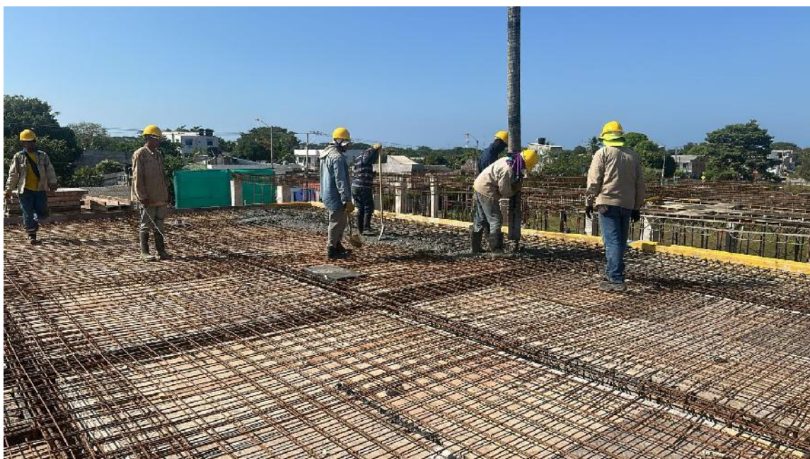
Fotografía 4. Fundición de losa de cubierta en concreto Bloque 2
