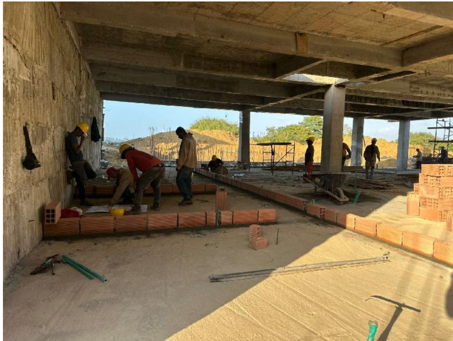
Fotografía 13. Levante de muro
