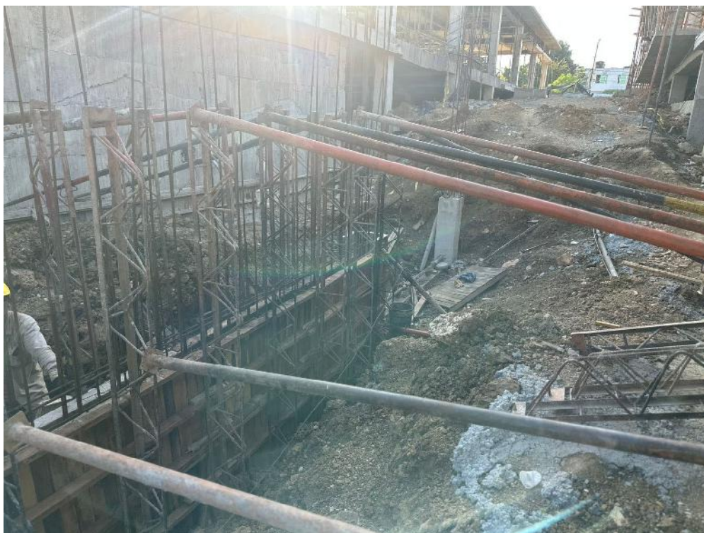
Fotografía 12. Avance de rampa en concreto
