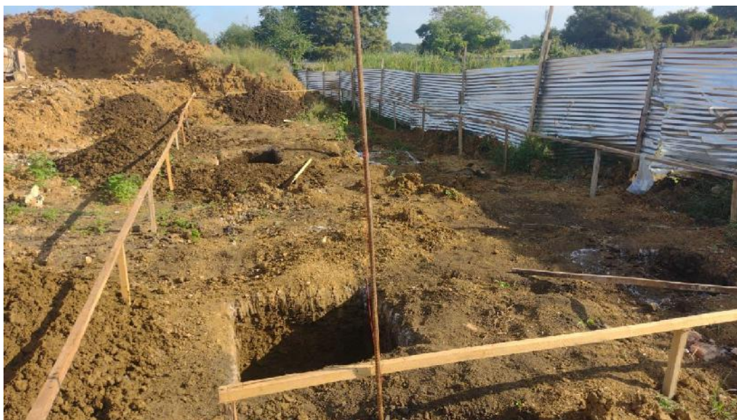
Fotografía 19. Excavaciones zapatas cuarto de basuras
