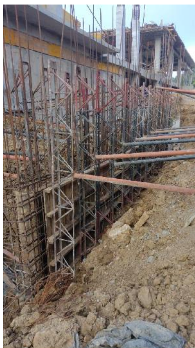
Fotografía 18. Amarre acero de muro de contención rampa peatonal bloque 3
