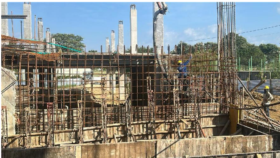
Fotografía 5. Fundida de concreto muro de contención Bloque 1
