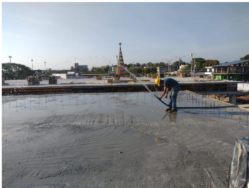
Fotografía 10. Hidratación losa cubierta bloque 2
