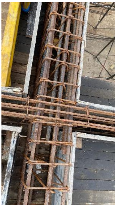
Fotografía 17. Amarre acero losa de cubierta bloque 3
