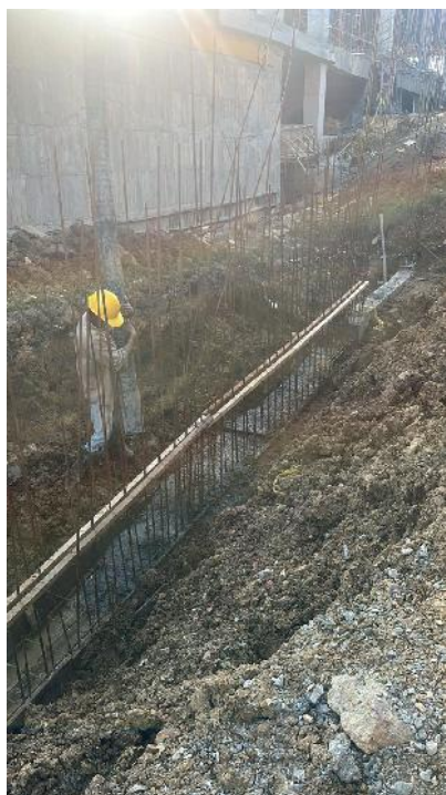
Fotografía 7. Fundición zarpa muro de contención rampa peatonal
