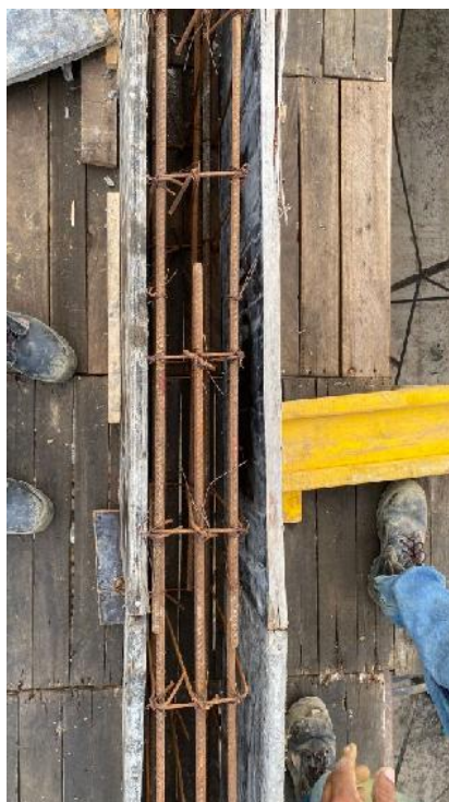
Fotografía 16. Amarre acero losa de cubierta bloque 3
