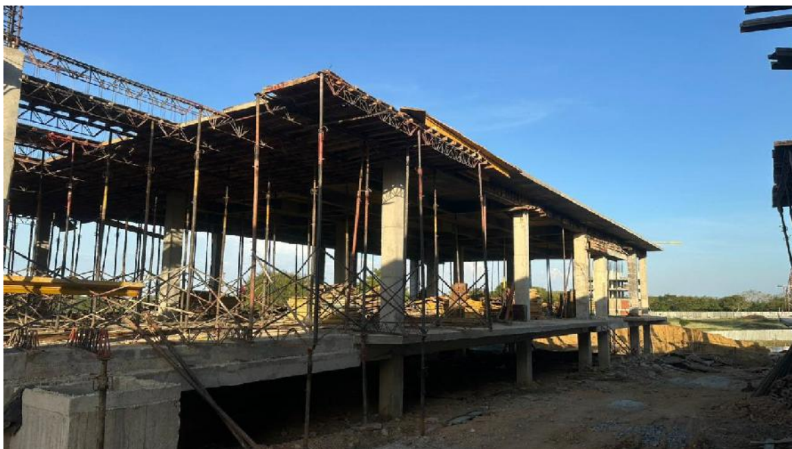
Fotografía 11. Vista general avance Bloque 3
