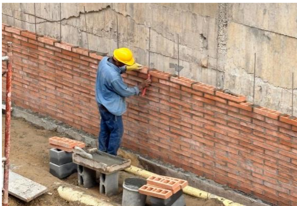
Imagen 4 Levante muro gran formato
