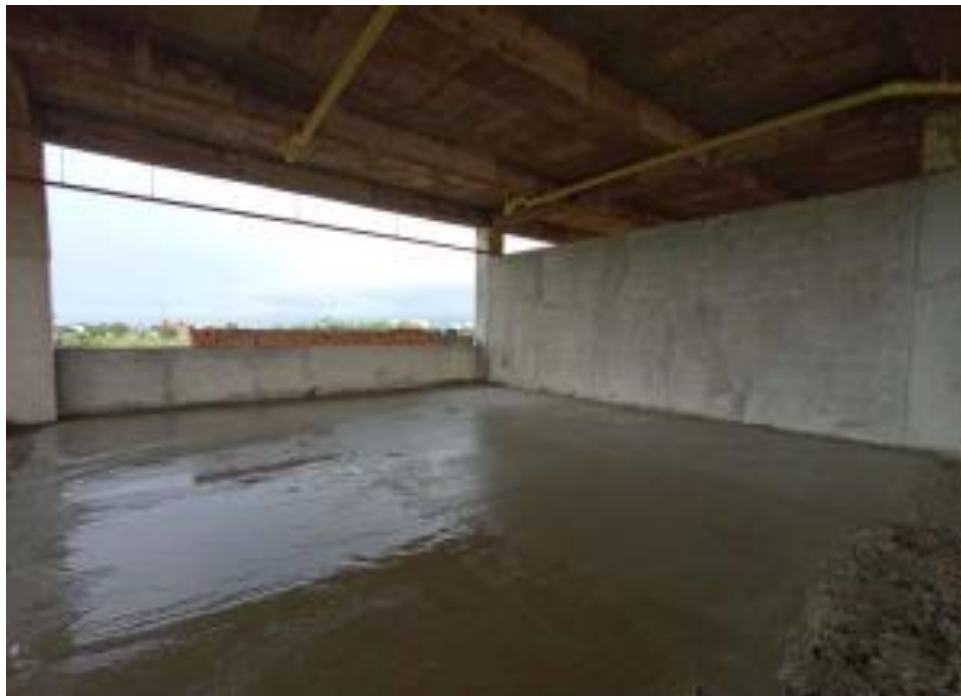
Imagen 6 Plantilla de nivelación bloque 2
