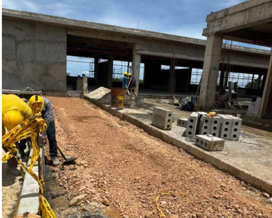
Imagen 5 conformación de espacio público zona exterior
