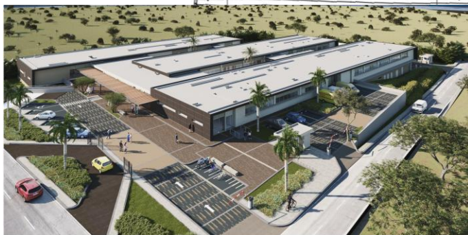
Imagen acceso principal, esquina Carrera 25 – Calle 6
