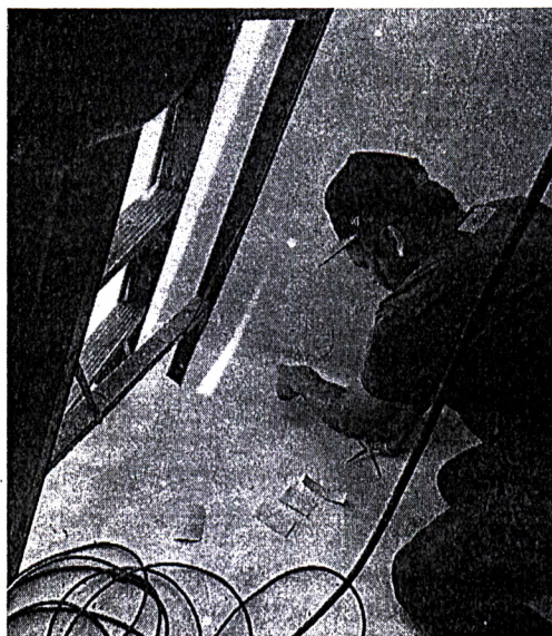
Impermeabilización de filtraciones identificadas
