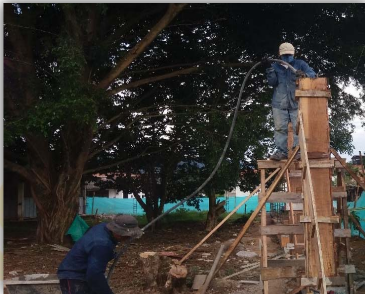
Fotografía 23 Fundición de columnas en concreto y vibrado
