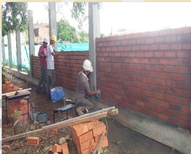
Fotografía 25 Columnas en concreto de 3000 psi
