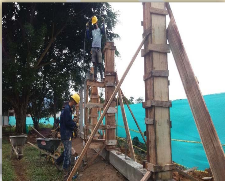
Fotografía 24 Fundición de columnas en concreto
