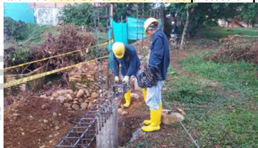
Fotografía 7 Buen uso de los elementos de protección personal
