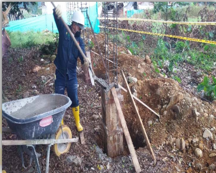
Fotografía 17 Figurado de hierro para columnas, Fundición de pedestal
