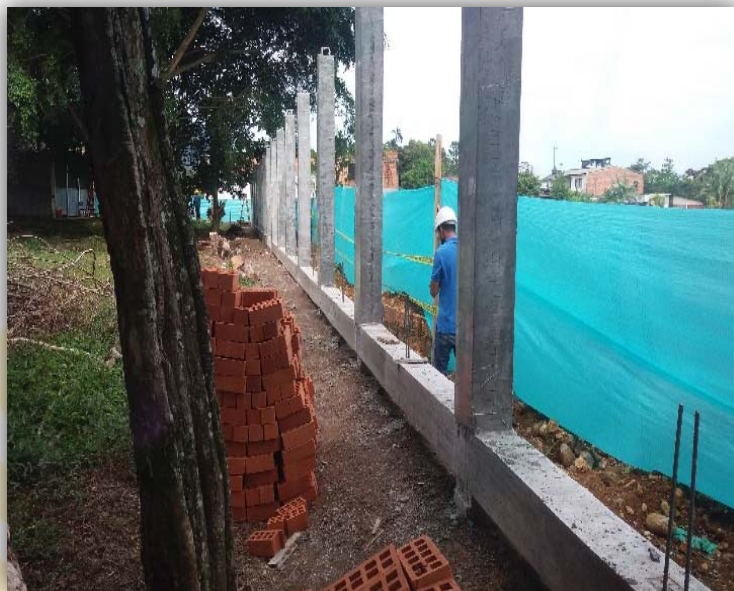
Fotografía 25 Columnas en concreto de 3000 psi
