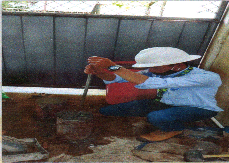
Fotografía 31 Toma de muestras de concreto
