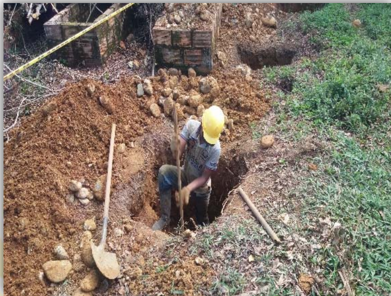
Fotografía 13 Excavación manual en conglomerado
