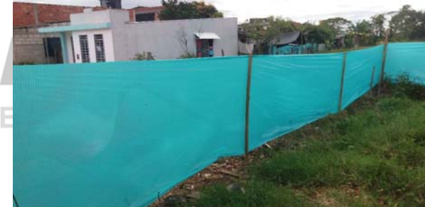
Fotografía 11 Cerramiento de protección
