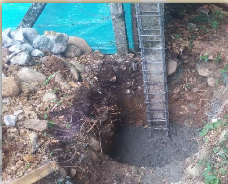
Fotografía 16 Fundición de pedestal inicial, lado de muro existente
