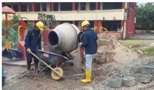
Fotografía 6 Buen uso de los elementos de protección personal
