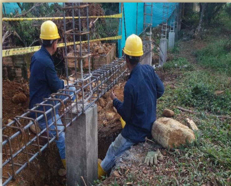
Fotografía 18 Figurado de hierro para viga de cimentación
