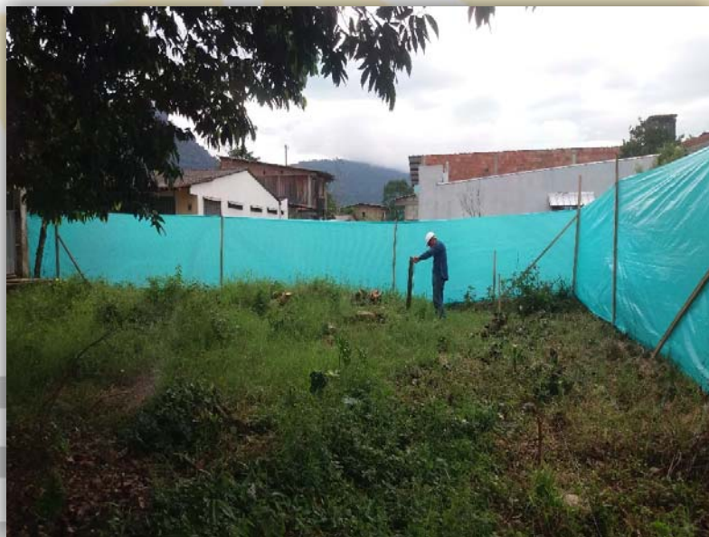
Fotografía 12 Localización y replanteo - cerramiento provisional
