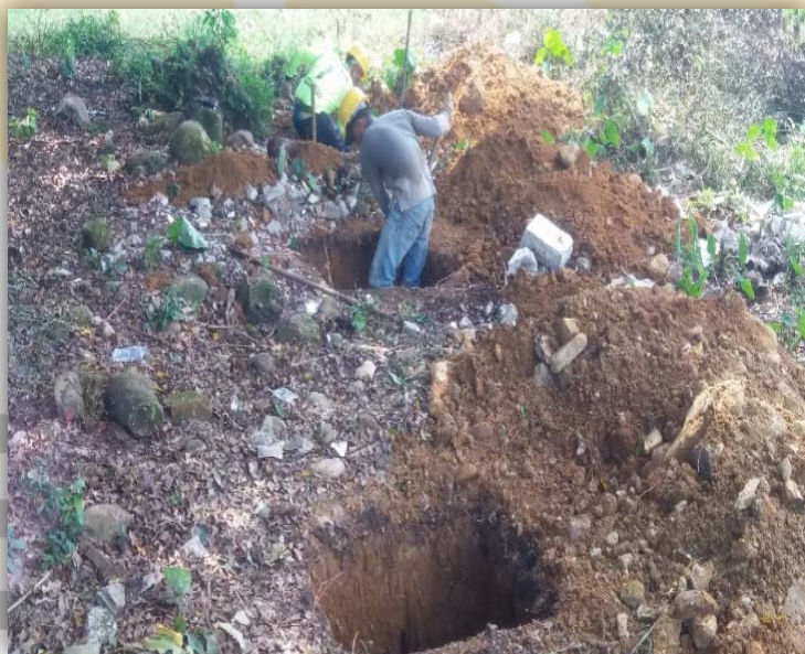
Fotografía 14 Excavación manual en conglomerado
