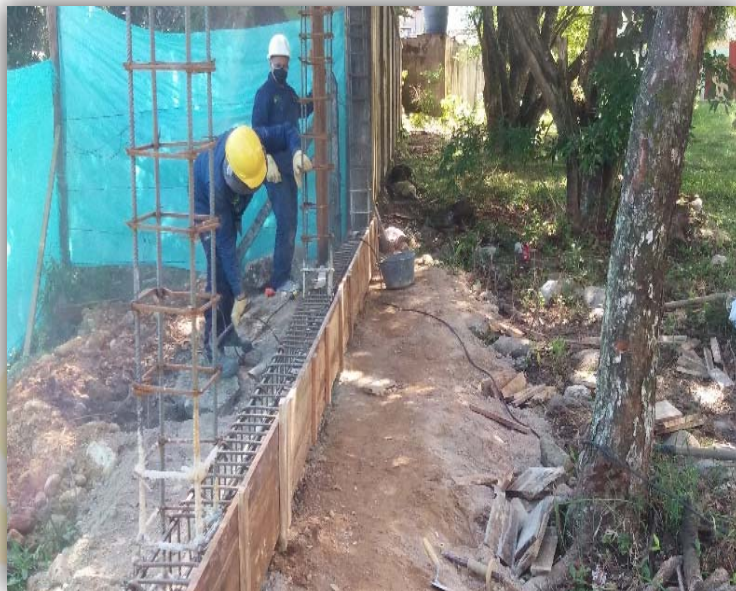
Fotografía 21 Encofrado para viga de cimentación
