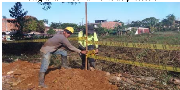
Fotografía 12 Señalización área de trabajo
