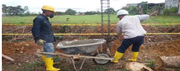
Fotografía 13 Señalización área de trabajo
