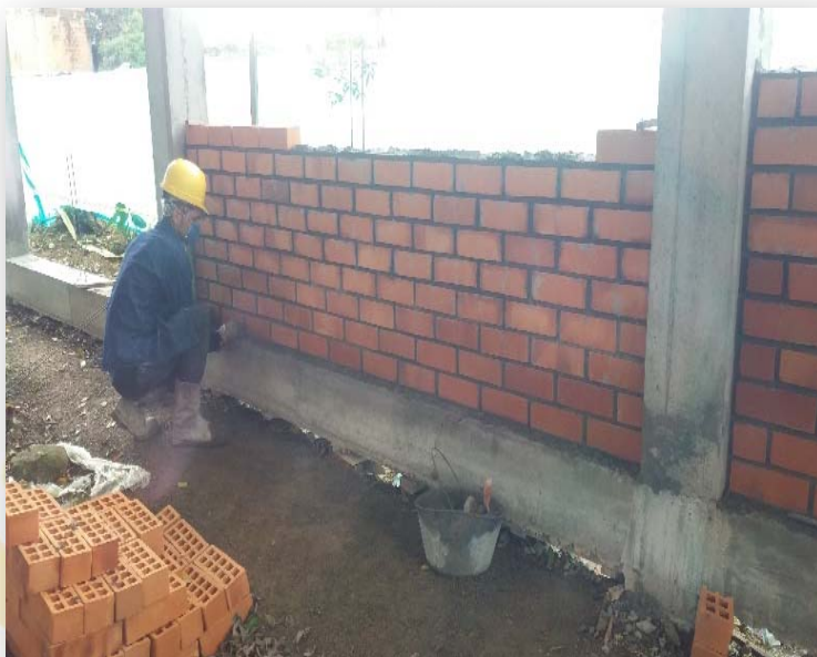
Fotografía 27 Muro en ladrillo a la vista
