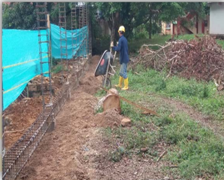
Fotografía 19 Relleno material seleccionado proctor 95%
