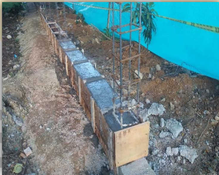
Fotografía 22 Fundición para viga de cimentación
