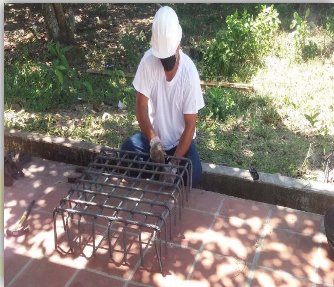
Fotografía 15 Figurado de acero de refuerzo 60000 psi para zapatas
