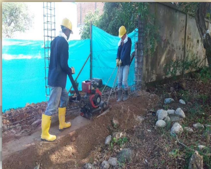
Fotografía 20 Relleno material seleccionado proctor 95%
