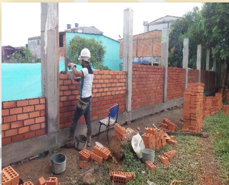
Fotografía 27 Muro en ladrillo a la vista
