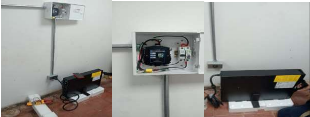
Supervisión de la instalación de UPS de la sede ID 226 de puerto gaitan
