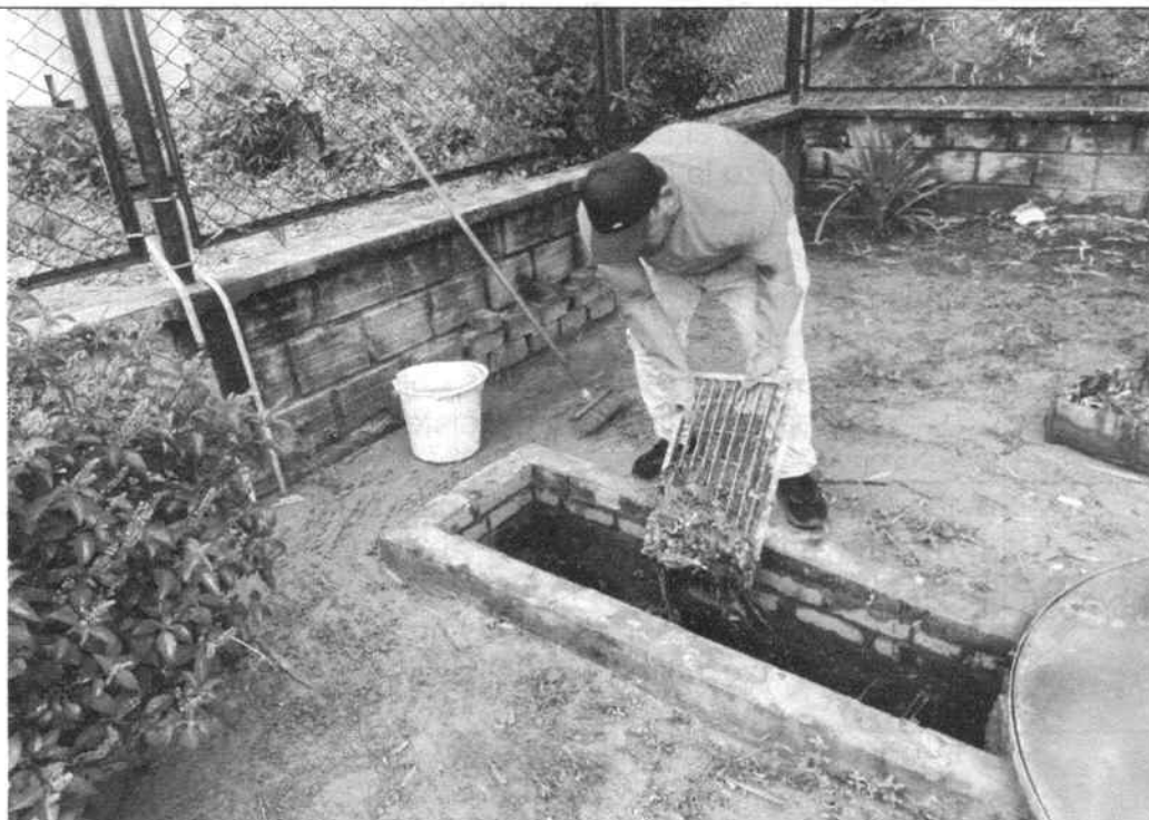
Limpieza y lavado de rejillas del sistema de cribado.
