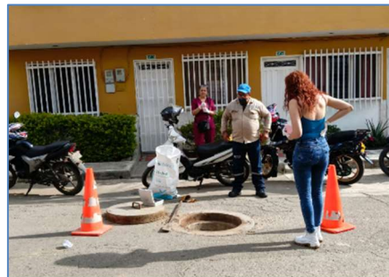
Toma de muestra del alcantarillado de vertimiento
