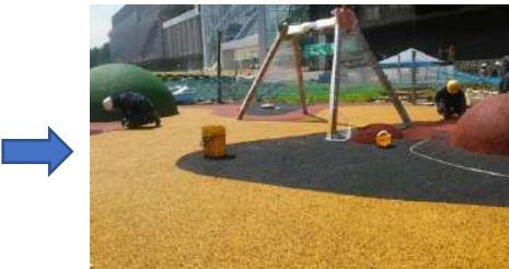
Uso de niveladores para garantizar el espesor solicitado
