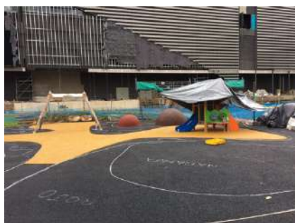
Marcación del diseño sobre el caucho SBR
