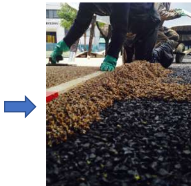
Uso de niveladores para garantizar el espesor solicitado
