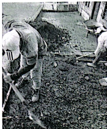
Excavaciones mano de material común
