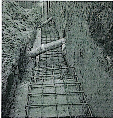
Instalación de acero de refuerzo
