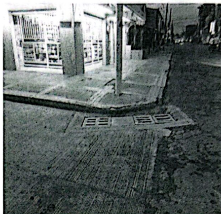
Construcción de sumideros
