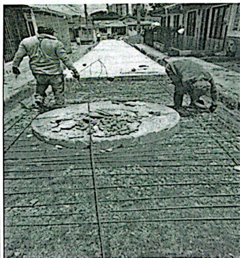
Instalación de acero de refuerzo en losas de pavimento rígido
