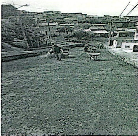
Instalación de subbase
