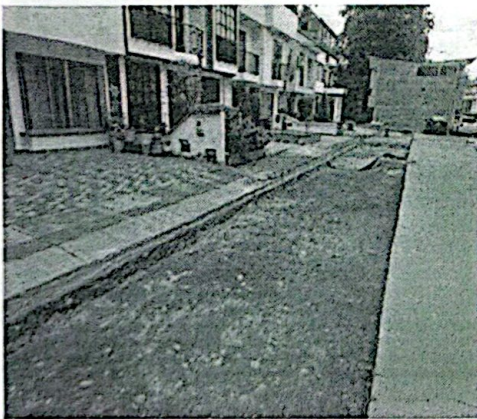
Conformación y compactación de subrasante
