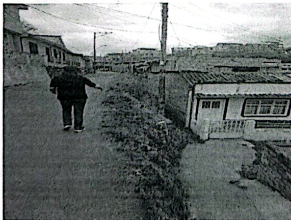
Estado inicial del sector
