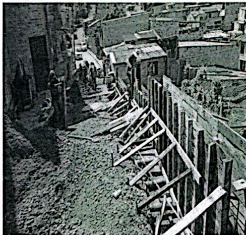
Fundición de muro en concreto
