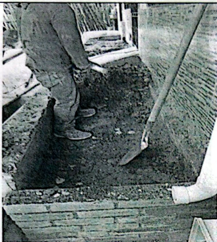
Excavación para andén
