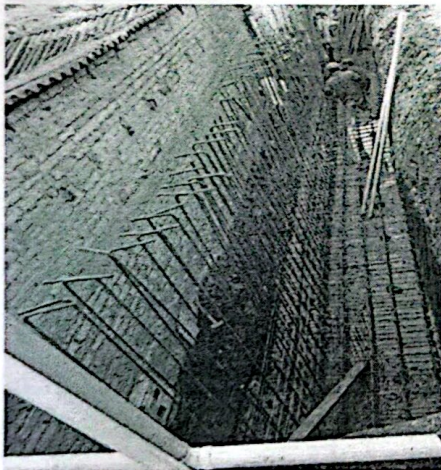
Instalación de acero de refuerzo
