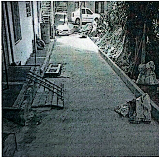
Construcción de bordillos
