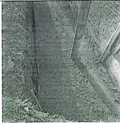
Nivelación de la excavación
