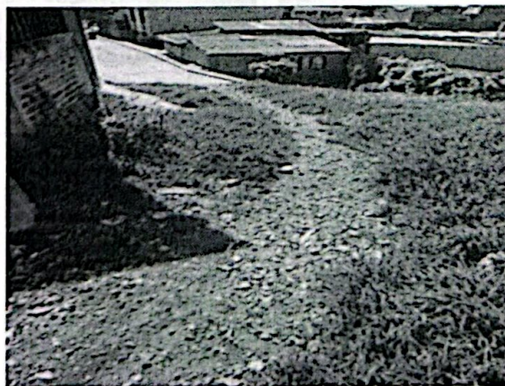
Estado Inicial de la vía a intervenir
