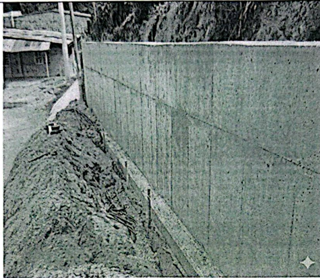
Muro en concreto reforzado
