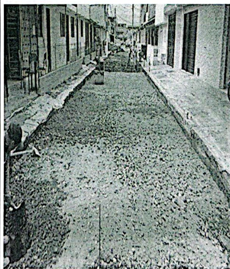
Instalación y compactación de subbase
