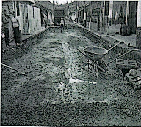
Excavación y preparación de la subrasante
