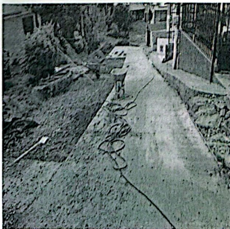
Construcción de losas de concreto
