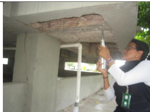
FOTOGRAFIA no. 69 Ensayo de esclerometría viga eje B 1-2 bloque de patrulleros.
