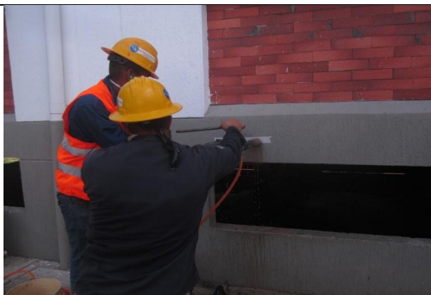
FOTOGRAFIA no 107. Extracción de núcleo en viga eje C 2-3 semisótano bloque de patrulleros.
