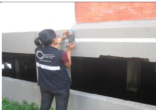
FOTOGRAFIA no. 133. Ensayo de detección magnética ferrosca Viga Eje I 7-8 semisótano bloque de oficiales.
