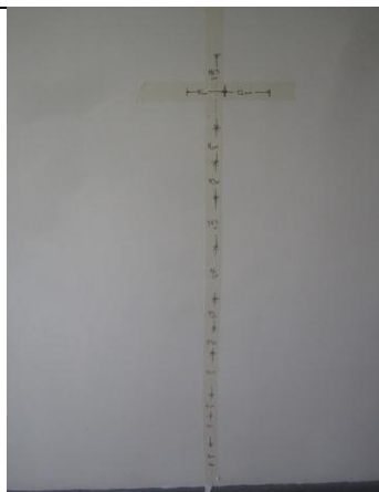
FOTOGRAFIA no. 153. Ensayo de detección magnética ferrosca Columna eje B2 piso 2 bloque de patrulleros.
