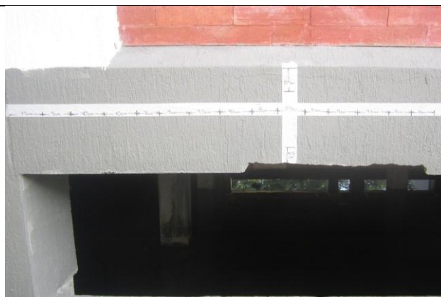
FOTOGRAFIA no. 134. Ensayo de detección magnética ferrosca Viga Eje I 7-8 semisótano bloque de oficiales.
