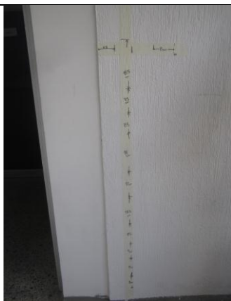
FOTOGRAFIA no. 151. Ensayo de detección magnética ferrosca Columna eje C5 piso 2 bloque de patrulleros.
