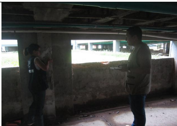
FOTOGRAFIA No. 52 Ensayo de esclerometría Columna 5.
