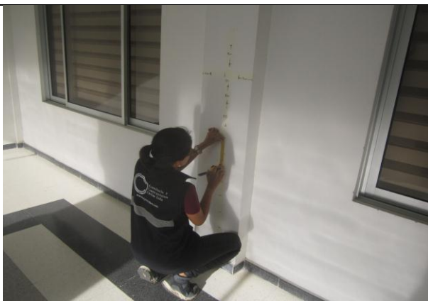
FOTOGRAFIA no. 135. Ensayo de detección magnética ferroscan Columna Eje G10 piso 1 bloque de oficiales.
