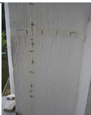
FOTOGRAFIA no. 147. Ensayo de detección magnética ferrosca Columna eje C4 piso 1 bloque de patrulleros.
