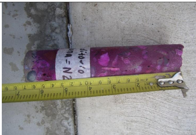
FOTOGRAFIA no. 91. Extracción de núcleo en columna eje I6 semisótano bloque de oficiales.
