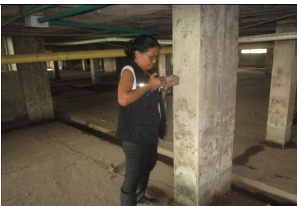
FOTOGRAFIA No. 48 Ensayo de esclerometría Columna 1.
