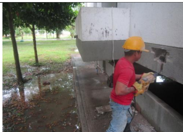
FOTOGRAFIA no. 46. Regata Viga eje 1 B-C piso 1 bloque de patrulleros.
