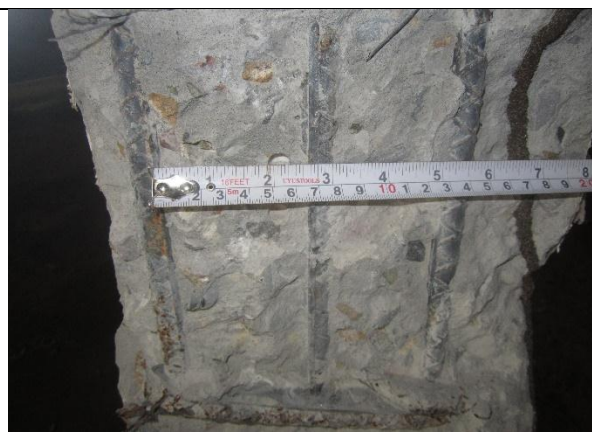
FOTOGRAFIA no. 73. Extracción de núcleo en columna eje 8-IF semisótano bloque de administración.
