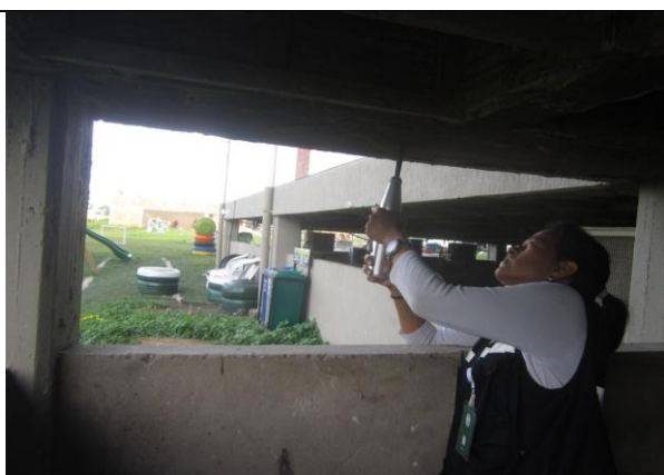
FOTOGRAFIA No. 64 Ensayo de esclerometría viga eje 8 A-B bloque de oficiales.
