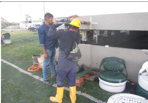
FOTOGRAFIA no. 101. Extracción de núcleo en viga eje B 10-11 semisótano bloque de oficiales.
