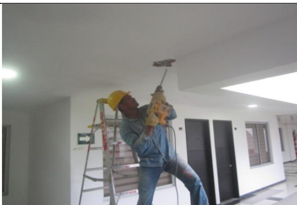
FOTOGRAFIA no. 25. Regata Viga entrepiso 2 eje D 9-10 bloque de oficiales.
