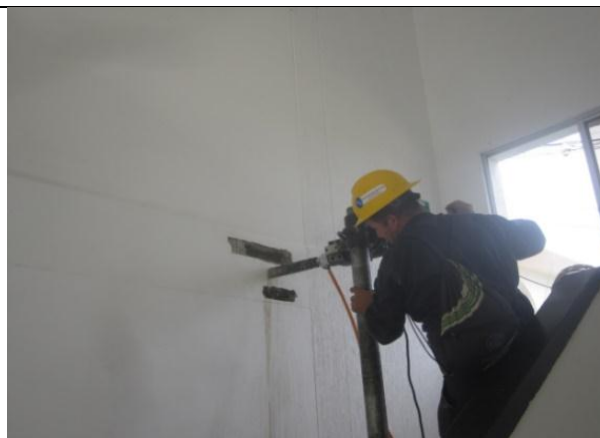
FOTOGRAFIA no. 81. Extracción de núcleo en Viga entrepiso 2-3 eje 4-5 zona administrativa.
