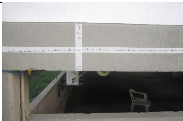
FOTOGRAFIA no. 132. Ensayo de detección magnética ferrosca Viga Eje B 10-11 semisótano bloque de oficiales.
