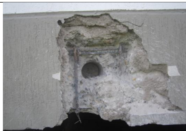
FOTOGRAFIA no. 34. Regata Viga eje B 10-11 semisótano bloque de oficiales.
