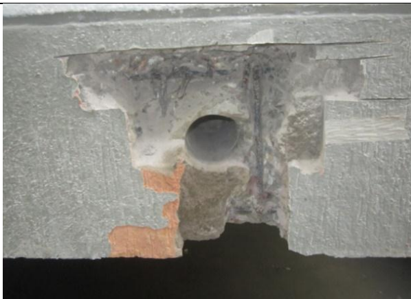
FOTOGRAFIA no. 47. Regata Viga eje 1 B-C piso 1 bloque de patrulleros.
