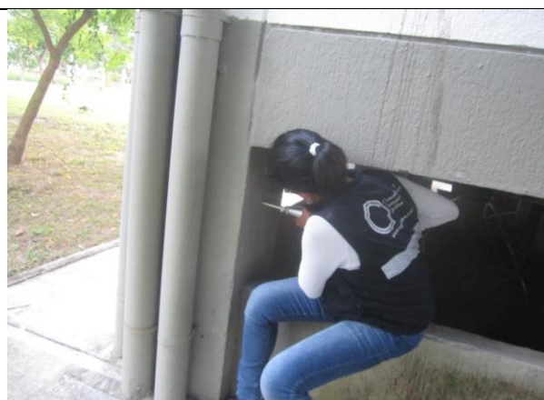
FOTOGRAFIA no. 70 Ensayo de esclerometría columna eje A1 bloque de patrulleros.
