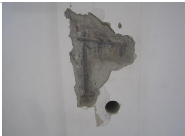
FOTOGRAFIA no. 22. Columna eje C7 piso 2 bloque administrativo.
