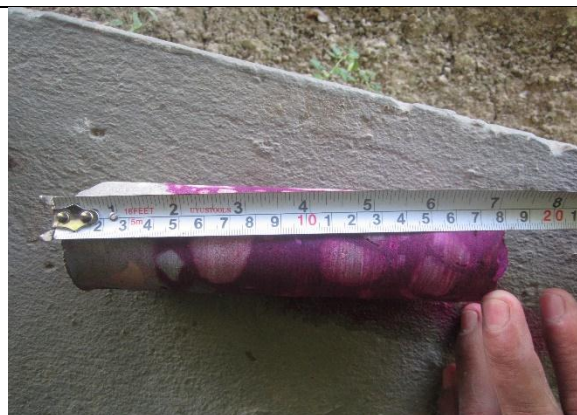
FOTOGRAFIA no. 75. Extracción de núcleo en columna eje 8-IF semisótano bloque de administración.
