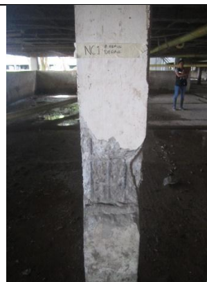
FOTOGRAFIA no 7. Regata columna semisótano eje F-8I. Bloque de sanidad.
