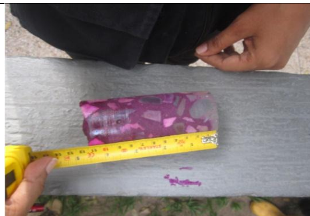
FOTOGRAFIA no. 84. Extracción de núcleo en Viga eje 7i I-H piso 2 zona administrativa.
