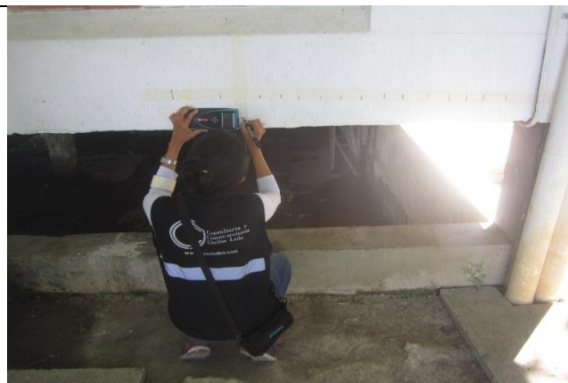
FOTOGRAFIA no. 125. Ensayo de detección magnética ferrosca en viga eje 11I F-G piso 1 sanidad.
