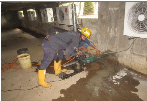
FOTOGRAFIA no. 76. Extracción de núcleo en columna eje K-6I semisótano bloque de administración.
