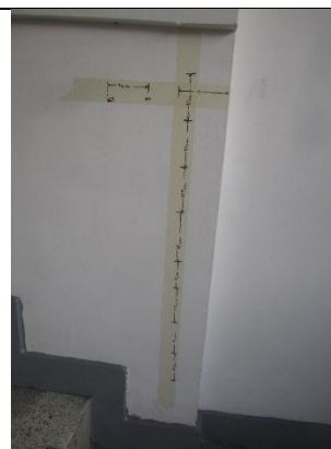
FOTOGRAFIA no 119. Ensayo de detección magnética ferrosca columna eje H 7I piso 2 zona administrativa 1.
