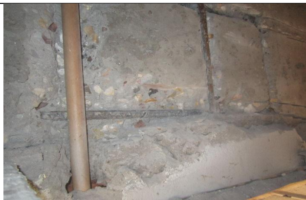
FOTOGRAFIA no 15. Regata viga de cubierta eje 8 C-B zona administrativa 2 piso 3.
