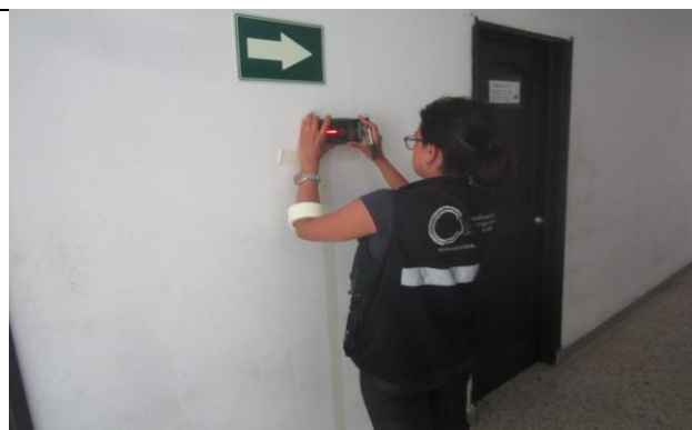
FOTOGRAFIA no. 148. Ensayo de detección magnética ferrosca Columna eje C7 piso 1 bloque de patrulleros.
