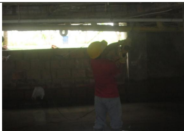
FOTOGRAFIA no. 41. Regata Viga entrepiso semisótano eje B 3-4 bloque de patrulleros.
