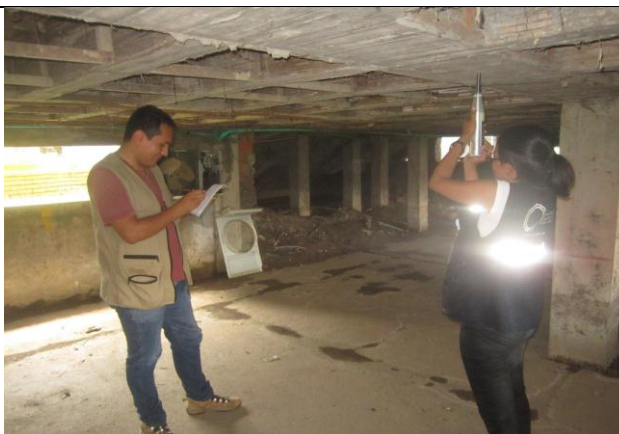
FOTOGRAFIA No. 57 Ensayo de esclerometría Viga 5.
