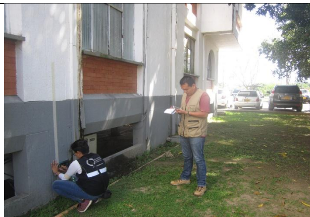
FOTOGRAFIA no. 129. Ensayo de detección magnética ferroscaan columna eje I2 piso 1 zona administrativa 1.
