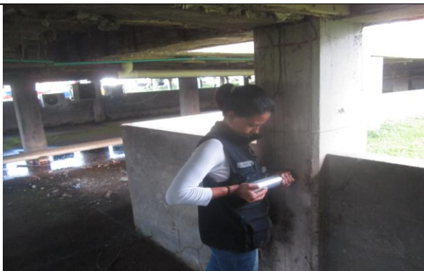
FOTOGRAFIA no. 61 Ensayo de esclerometría columna eje D8 bloque de oficiales.
