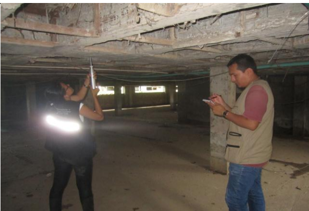
FOTOGRAFIA No. 55 Ensayo de esclerometría Viga 3.
