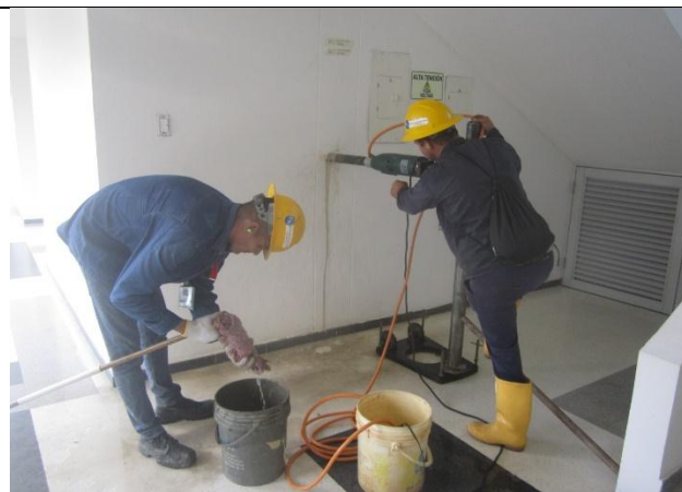
FOTOGRAFIA no. 92. Extracción de núcleo en columna eje C10 piso 1 bloque de oficiales.
