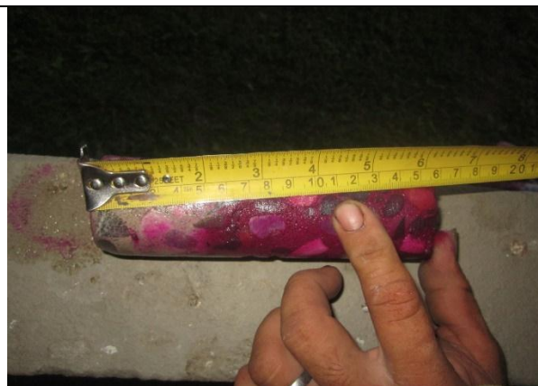
FOTOGRAFIA no. 100. Extracción de núcleo en columna eje C7 semisótano bloque de oficiales.
