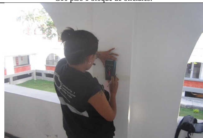
FOTOGRAFIA no. 95. Extracción de núcleo en columna eje D4 piso 2 bloque de oficiales.
