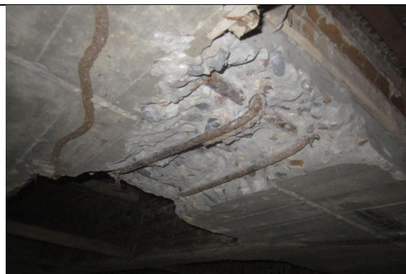
FOTOGRAFIA no 9. Regata viga semisótano eje F 9I-8I. Bloque de sanidad.
