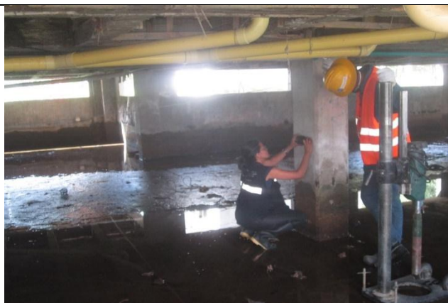
FOTOGRAFIA no 103. Extracción de núcleo en columna eje C6 semisótano bloque de patrulleros.
