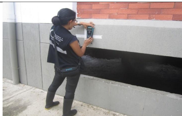
FOTOGRAFIA no 106. Extracción de núcleo en viga eje C 2-3 semisótano bloque de patrulleros.
