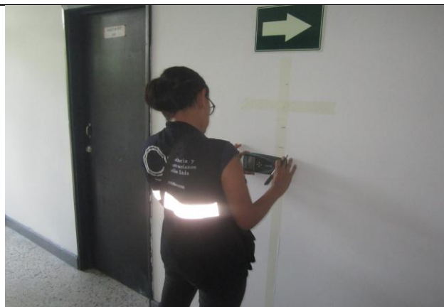
FOTOGRAFIA no. 152. Ensayo de detección magnética ferrosca Columna eje B2 piso 2 bloque de patrulleros.
