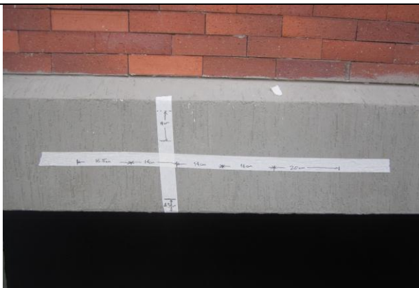
FOTOGRAFIA no. 145. Ensayo de detección magnética ferrosca Viga eje C 3-4 piso 1 bloque de patrulleros.
