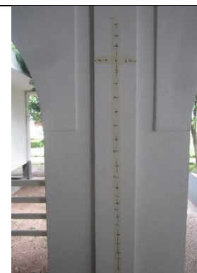
FOTOGRAFIA no. 127. Ensayo de detección magnética ferrosca en columna eje G 4I piso 1 zona administrativa 1.
