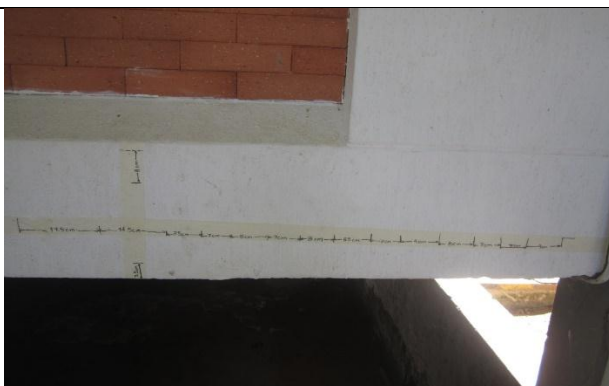
FOTOGRAFIA no 126. Ensayo de detección magnética ferrosca en viga eje 11I F-G piso 1 sanidad.
