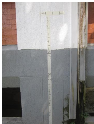
FOTOGRAFIA no. 130. Ensayo de detección magnética ferroscaan columna eje I2 piso 1 zona administrativa 1.
