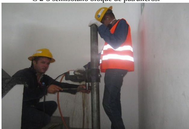
FOTOGRAFIA no 109. Extracción de núcleo en viga eje B 5-6 piso 2 bloque de patrulleros.
