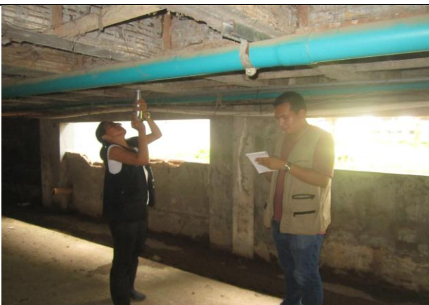
FOTOGRAFIA No. 56 Ensayo de esclerometría Viga 4.
