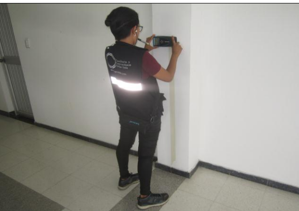
FOTOGRAFIA no. 143. Ensayo de detección magnética ferroscaan Columna Eje D8 piso 2 bloque de oficiales.
