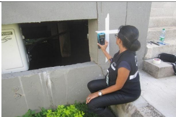
FOTOGRAFIA no. 89. Extracción de núcleo en columna eje I6 semisótano bloque de oficiales.
