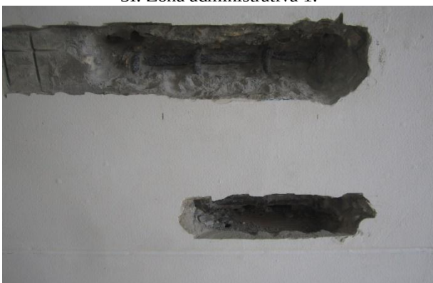
FOTOGRAFIA no 12. Regata viga de entrepiso nivel 2 a nivel 3 eje E 4-5 zona administrativa 1.
