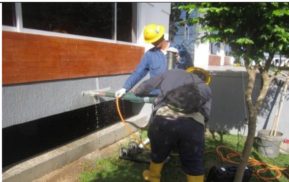
FOTOGRAFIA no. 87. Extracción de núcleo en viga eje N 5-6 semisótano bloque de oficiales.
