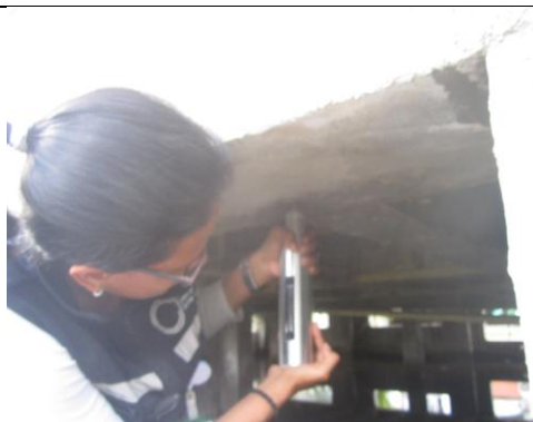
FOTOGRAFIA no. 68 Ensayo de esclerometría viga eje A 5-6 bloque de patrulleros.
