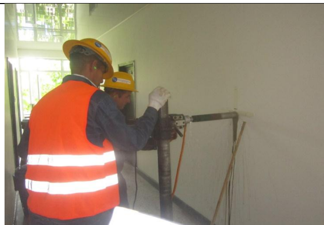
FOTOGRAFIA no. 112. Extracción de núcleo en columna eje B3 piso 2 bloque de patrulleros.
