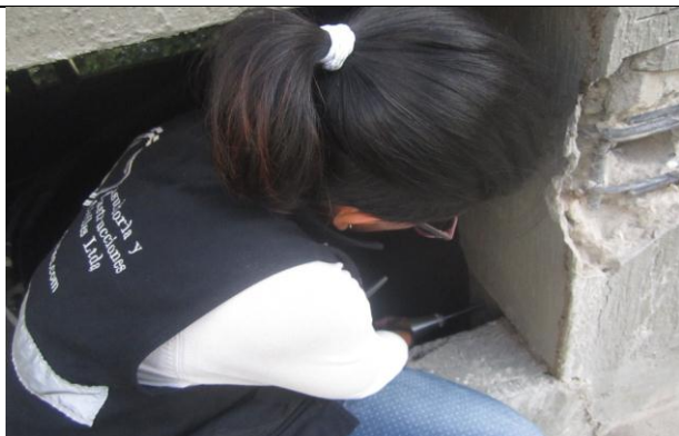
FOTOGRAFIA no. 60 Ensayo de esclerometría columna eje I6 bloque de oficiales.
