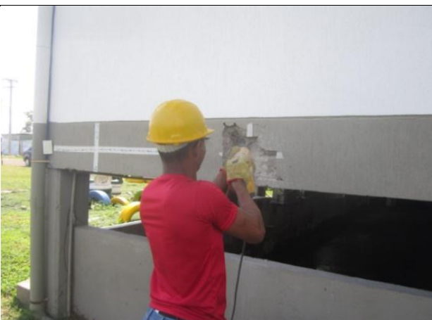
FOTOGRAFIA no. 33. Regata Viga eje B 10-11 semisótano bloque de oficiales.
