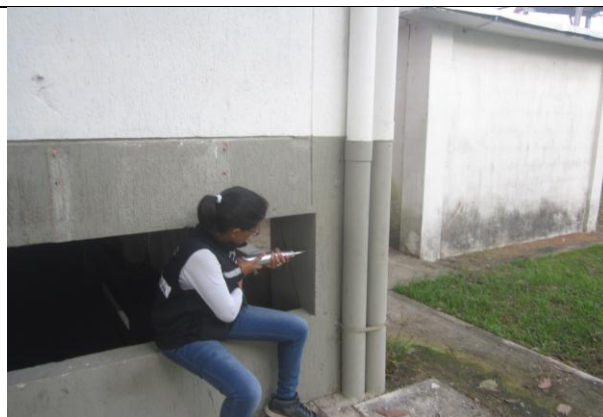
FOTOGRAFIA no. 67 Ensayo de esclerometría columna eje B8 bloque de patrulleros.
