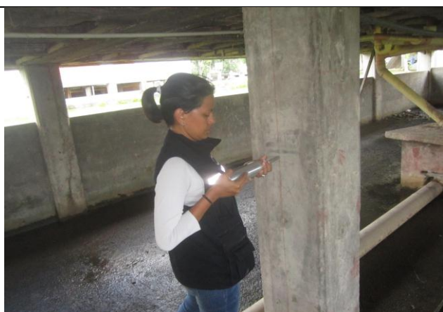
FOTOGRAFIA no. 62 Ensayo de esclerometría columna eje C5 bloque de oficiales.
