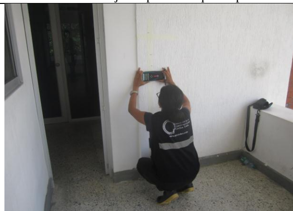
FOTOGRAFIA no. 150. Ensayo de detección magnética ferrosca Columna eje C5 piso 2 bloque de patrulleros.
