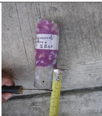
FOTOGRAFIA no 105. Extracción de núcleo en columna eje C6 semisótano bloque de patrulleros.
