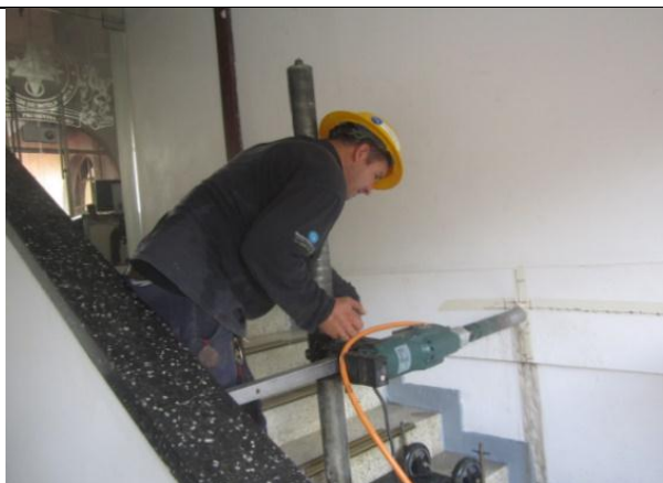
FOTOGRAFIA no. 83. Extracción de núcleo en Viga eje 7i I-H piso 2 zona administrativa.
