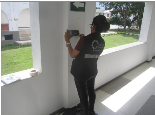
FOTOGRAFIA no. 137. Ensayo de detección magnética ferroscan Columna Eje D7 piso 1 bloque de oficiales.
