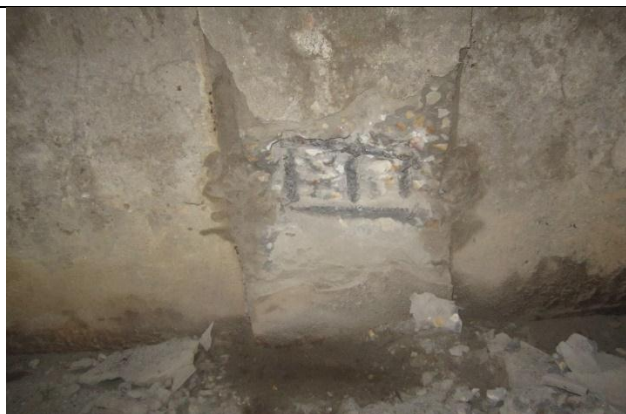
FOTOGRAFIA no 6. Regata columna semisótano eje K-6I zona administrativa 1.
