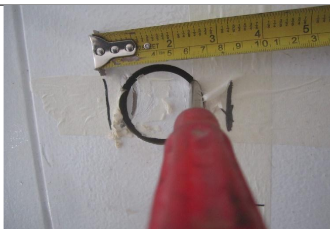
FOTOGRAFIA no. 93. Extracción de núcleo en columna eje C10 piso 1 bloque de oficiales.
