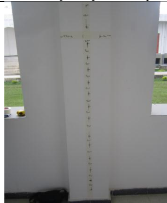
FOTOGRAFIA no. 140. Ensayo de detección magnética ferroscan Columna Eje D4 piso 1 bloque de oficiales.
