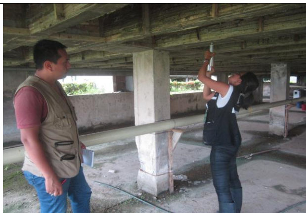
FOTOGRAFIA No. 53 Ensayo de esclerometría Viga 1.
