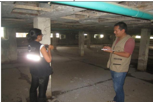
FOTOGRAFIA No. 50 Ensayo de esclerometría Columna 3.
