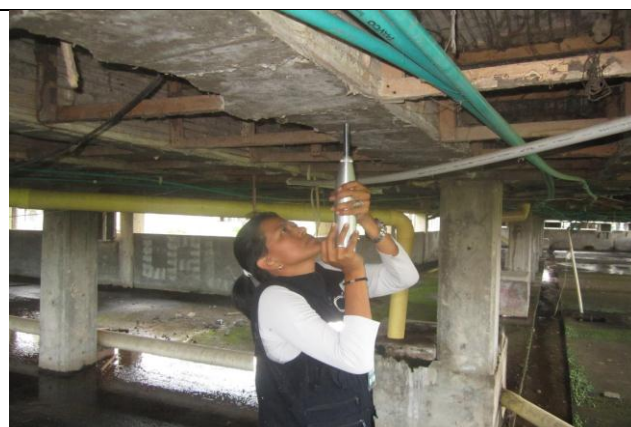
FOTOGRAFIA no. 65 Ensayo de esclerometría viga eje C 9-10 bloque de oficiales.
