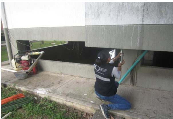
FOTOGRAFIA no. 66 Ensayo de esclerometría viga eje C 7-8 bloque de patrulleros.
