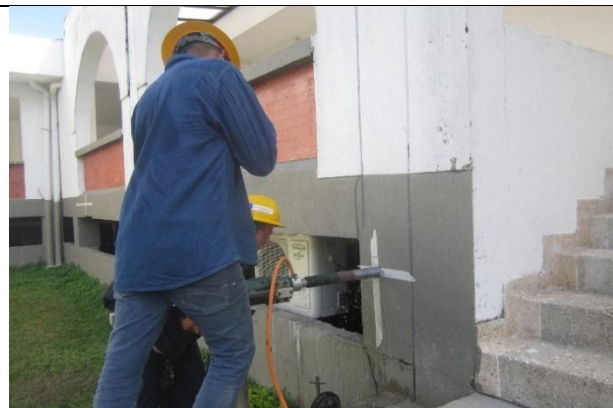
FOTOGRAFIA no. 90. Extracción de núcleo en columna eje I6 semisótano bloque de oficiales.
