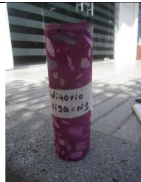
FOTOGRAFIA no. 88. Extracción de núcleo en viga eje N 5-6 semisótano bloque de oficiales.
