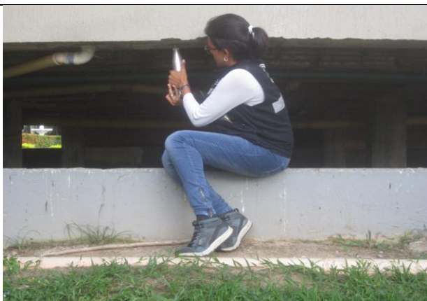
FOTOGRAFIA No. 58 Ensayo de esclerometría Viga eje J 2-3 bloque de oficiales.
