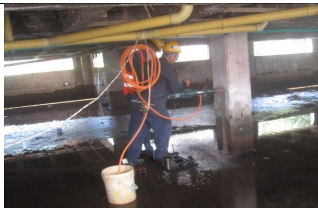
FOTOGRAFIA no 104. Extracción de núcleo en columna eje C6 semisótano bloque de patrulleros.
