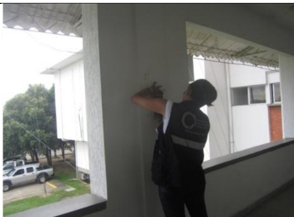
FOTOGRAFIA no. 78. Extracción de núcleo en Columna eje C7 piso 2 zona administrativa.
