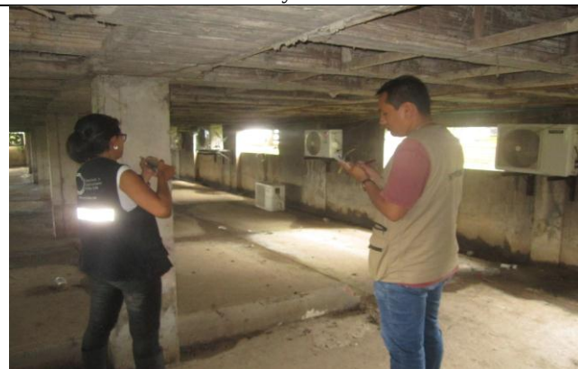
FOTOGRAFIA No. 51 Ensayo de esclerometría Columna 4.
