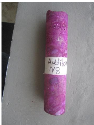
FOTOGRAFIA no. 97. Extracción de núcleo en columna eje D4 piso 2 bloque de oficiales.
