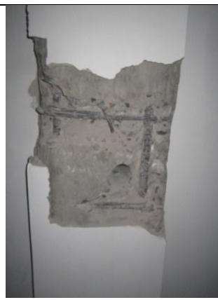
FOTOGRAFIA no. 30. Regata Columna eje D4 piso 2 bloque de oficiales.
