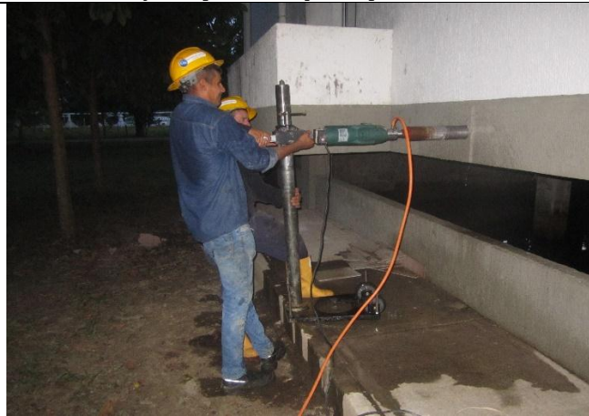
FOTOGRAFIA no. 114. Extracción de núcleo en columna eje 1 B-C piso 1 bloque de patrulleros.
