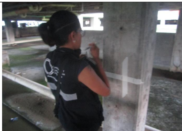
FOTOGRAFIA no. 98. Extracción de núcleo en columna eje C7 semisótano bloque de oficiales.
