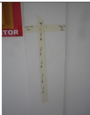
FOTOGRAFIA no 116. Ensayo de detección magnética ferrosca columna eje C6 piso 3 zona administrativa 2.
