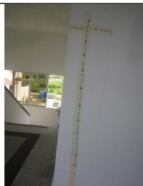
FOTOGRAFIA no 117. Ensayo de detección magnética ferrosca columna eje F4 piso 3 zona administrativa 1.
