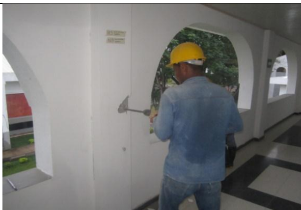
FOTOGRAFIA no. 29. Regata Columna eje D4 piso 2 bloque de oficiales.
