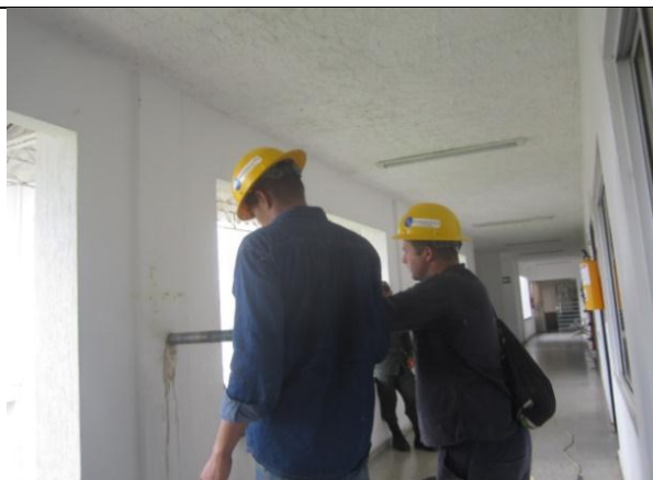
FOTOGRAFIA no. 79. Extracción de núcleo en Columna eje C7 piso 2 zona administrativa.
