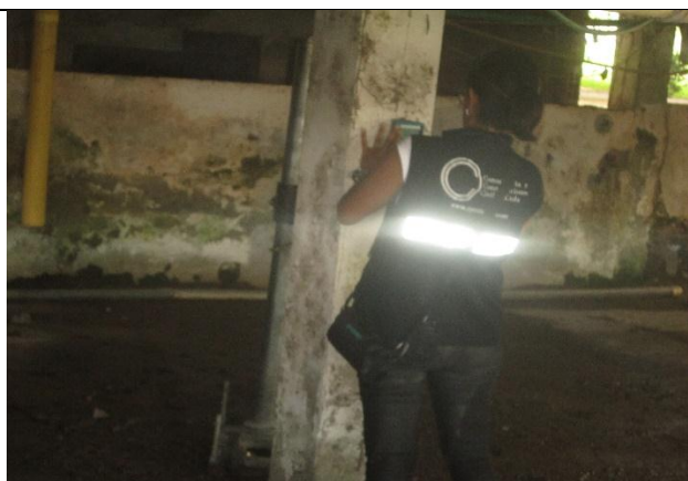
FOTOGRAFIA no. 72. Extracción de núcleo en columna eje 8-IF semisótano bloque de administración.
