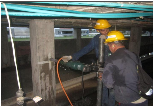
FOTOGRAFIA no. 99. Extracción de núcleo en columna eje C7 semisótano bloque de oficiales.
