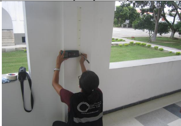
FOTOGRAFIA no. 139. Ensayo de detección magnética ferroscan Columna Eje D4 piso 1 bloque de oficiales.
