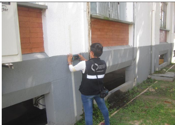
FOTOGRAFIA no. 128. Ensayo de detección magnética ferroscaan columna eje I2 piso 1 zona administrativa 1.
