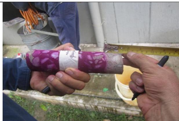
FOTOGRAFIA no 108. Extracción de núcleo en viga eje C 2-3 semisótano bloque de patrulleros.
