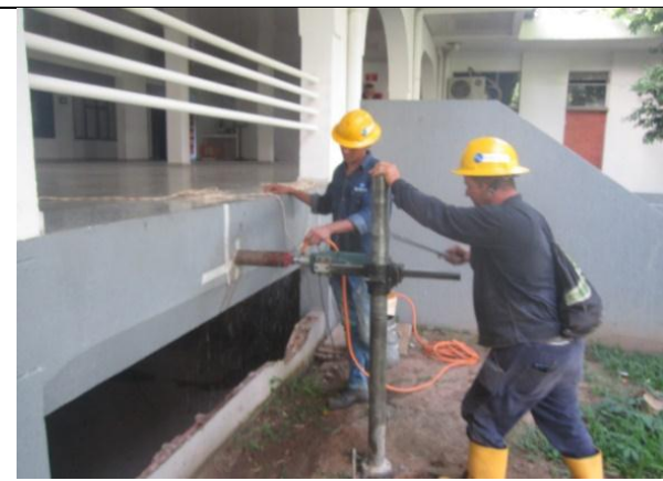
FOTOGRAFIA no. 85. Extracción de núcleo en Viga eje G 2i-3i piso 1 zona administrativa.
