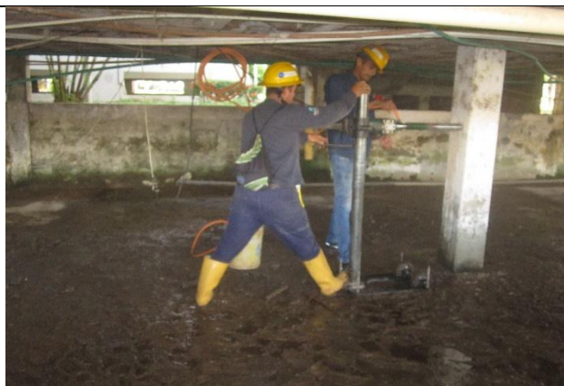
FOTOGRAFIA no. 74. Extracción de núcleo en columna eje 8-IF semisótano bloque de administración.
