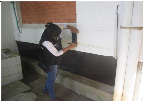
FOTOGRAFIA no 124. Ensayo de detección magnética ferrosca en viga eje 11I F-G piso 1 sanidad.
