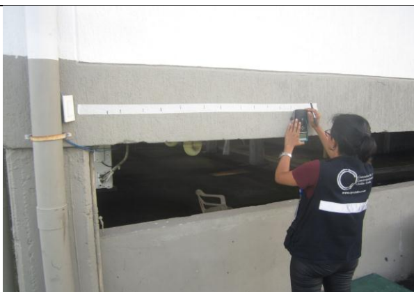
FOTOGRAFIA no. 131. Ensayo de detección magnética ferrosca Viga Eje B 10-11 semisótano bloque de oficiales.
