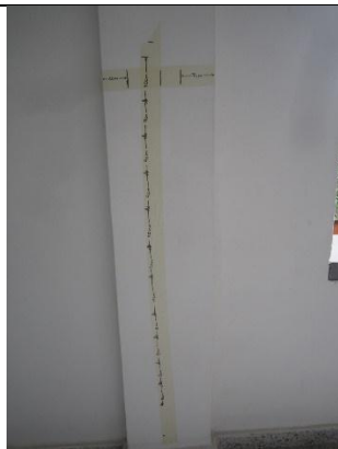
FOTOGRAFIA no 120. Ensayo de detección magnética ferrosca columna eje G1 piso 2 zona administrativa 1.
