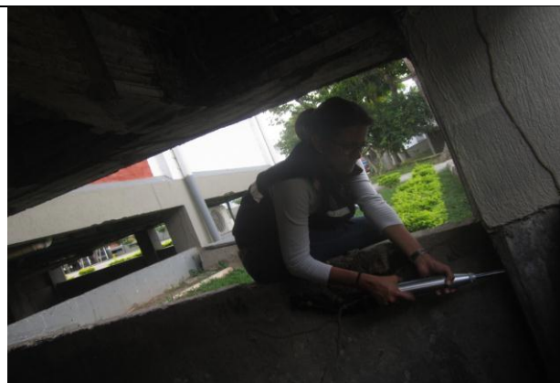
FOTOGRAFIA no. 59 Ensayo de esclerometría columna eje I3 bloque de oficiales.
