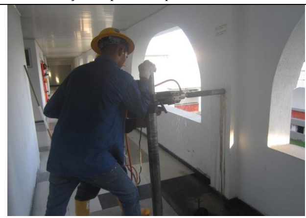
FOTOGRAFIA no. 96. Extracción de núcleo en columna eje D4 piso 2 bloque de oficiales.
