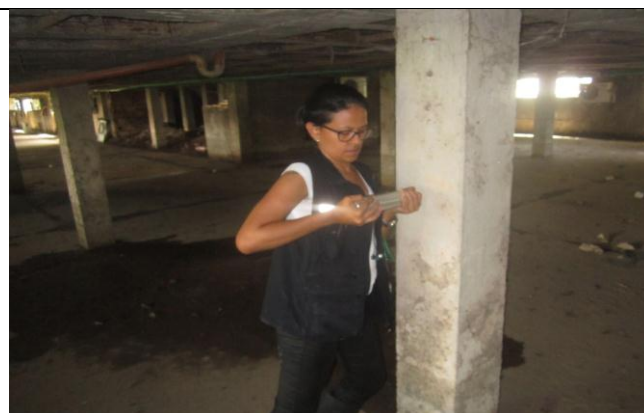
FOTOGRAFIA No. 49 Ensayo de esclerometría Columna 2.
