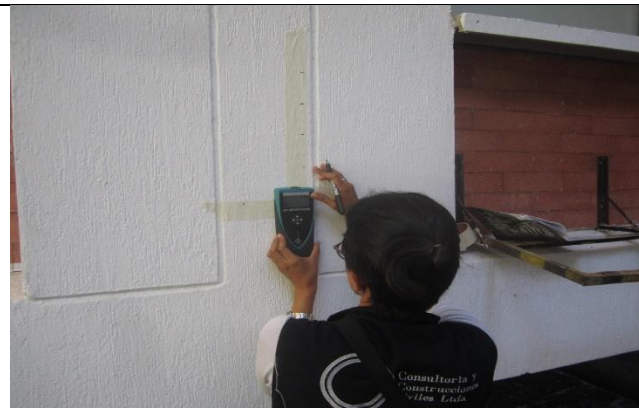
FOTOGRAFIA no 121. Ensayo de detección magnética ferrosca columna eje G-8I piso 1 sanidad.
