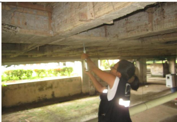
FOTOGRAFIA No. 54 Ensayo de esclerometría Viga 2.
