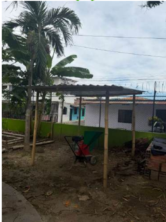
Imagen 4. Inspección del área destinada para procesos complementarios de producción y adecuación de infraestructura técnica.
