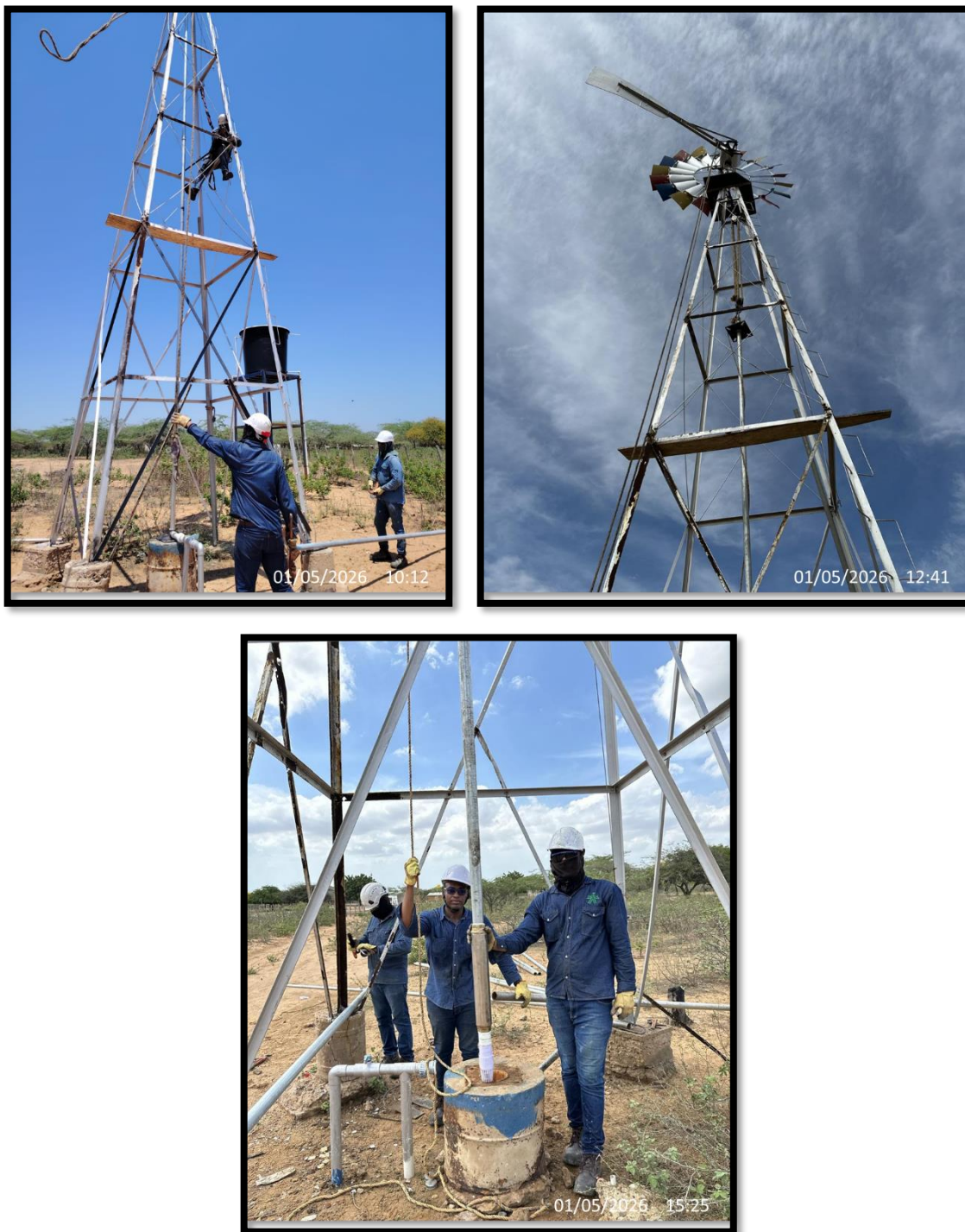
Actividades de mantenimiento con extracción de tuberías, varillas y bomba antigua. (Comunidad WIRRUMANA)
