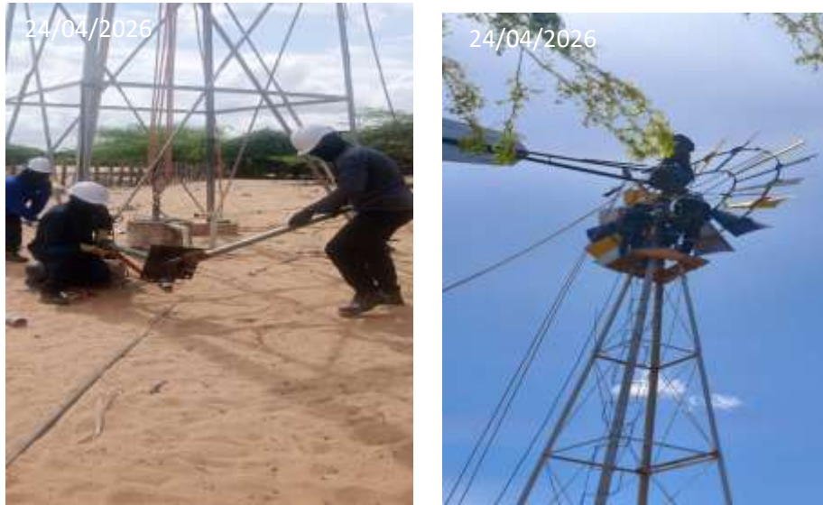
FIGURA 5. Intervención al molino de viento en la comunidad Iwaina-Arreichen,.
