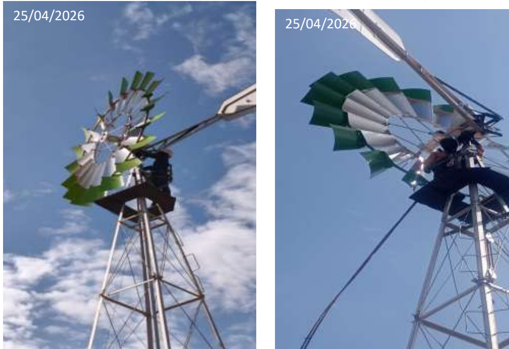
FIGURA 6. Intervención al molino de viento en la comunidad Iwaina-Arreichen,
