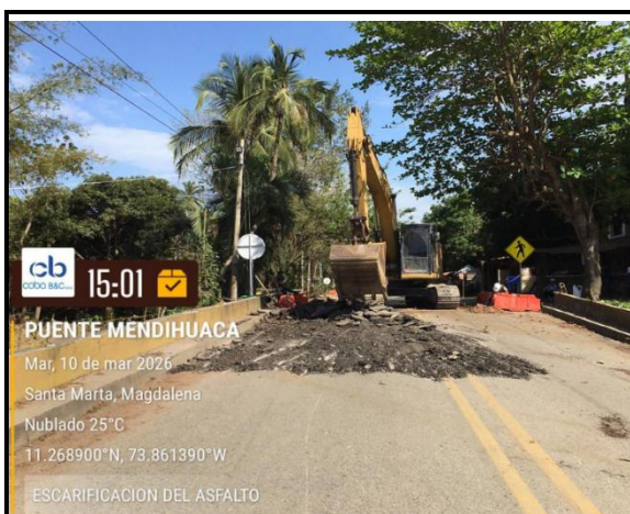
Retiro de carpeta asfáltica en el acceso lado Riohacha
