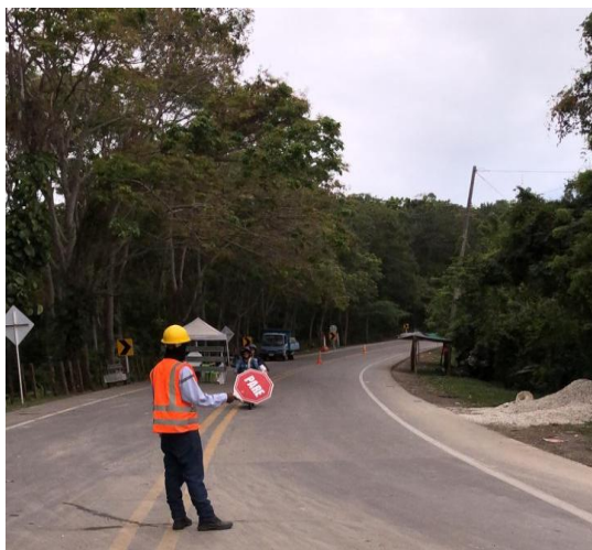
Personal de PMT realizando control y manejo de tránsito en el paso provisional.
