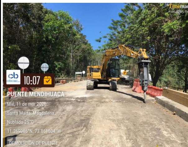
Demolición de la estructura colapsada del puente con equipo mecánico.
