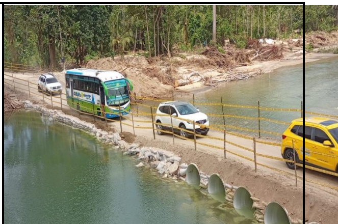
Apertura del paso provisional con tránsito restringido y señalización en el sector del Puente Mendihuaca.
