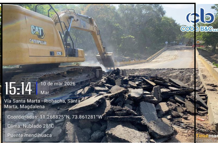
Retiro de carpeta asfáltica en el acceso lado Riohacha
