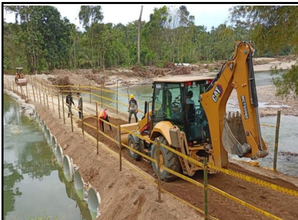
Labores diarias de mantenimiento realizadas al paso provisional.
