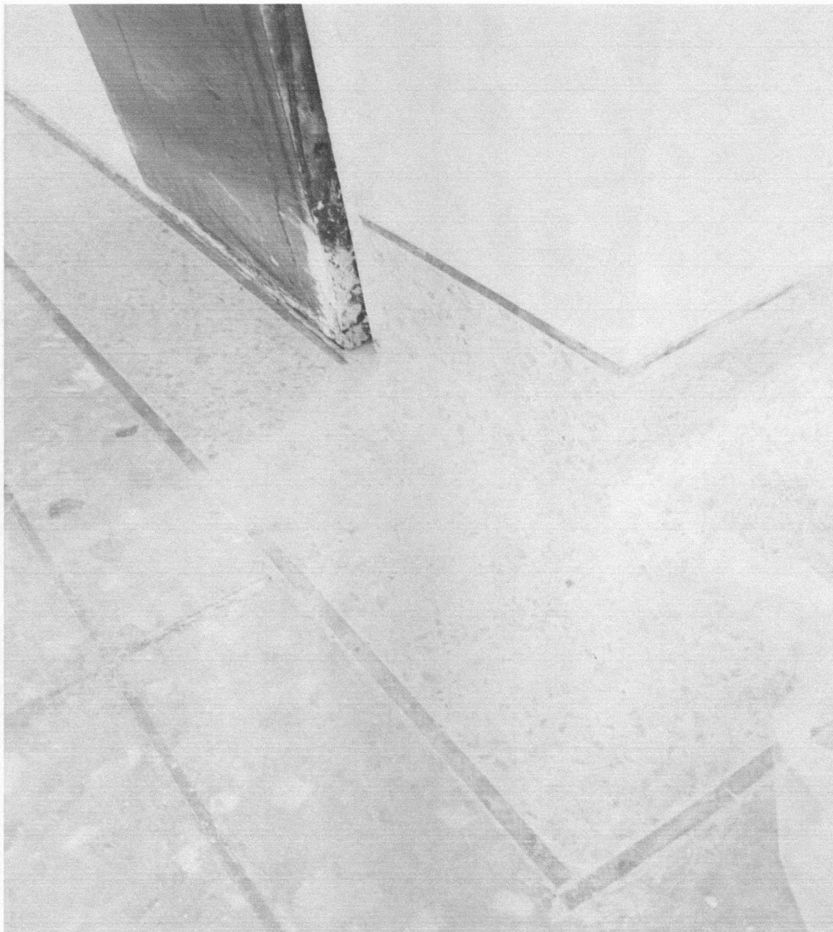
38.12 ML DE JUNTA METALICA DE BRONCE PARA PISOS
