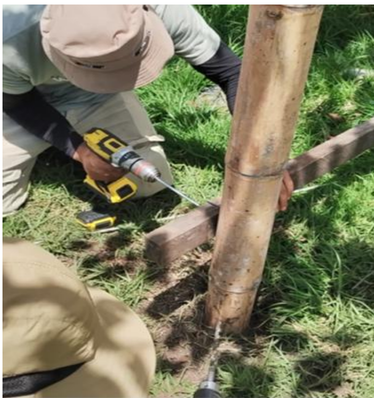
Formación: uniones, empalmes y ensambles para estructuras en guadua – Corregimiento de Catambuco, Municipio de Pasto
