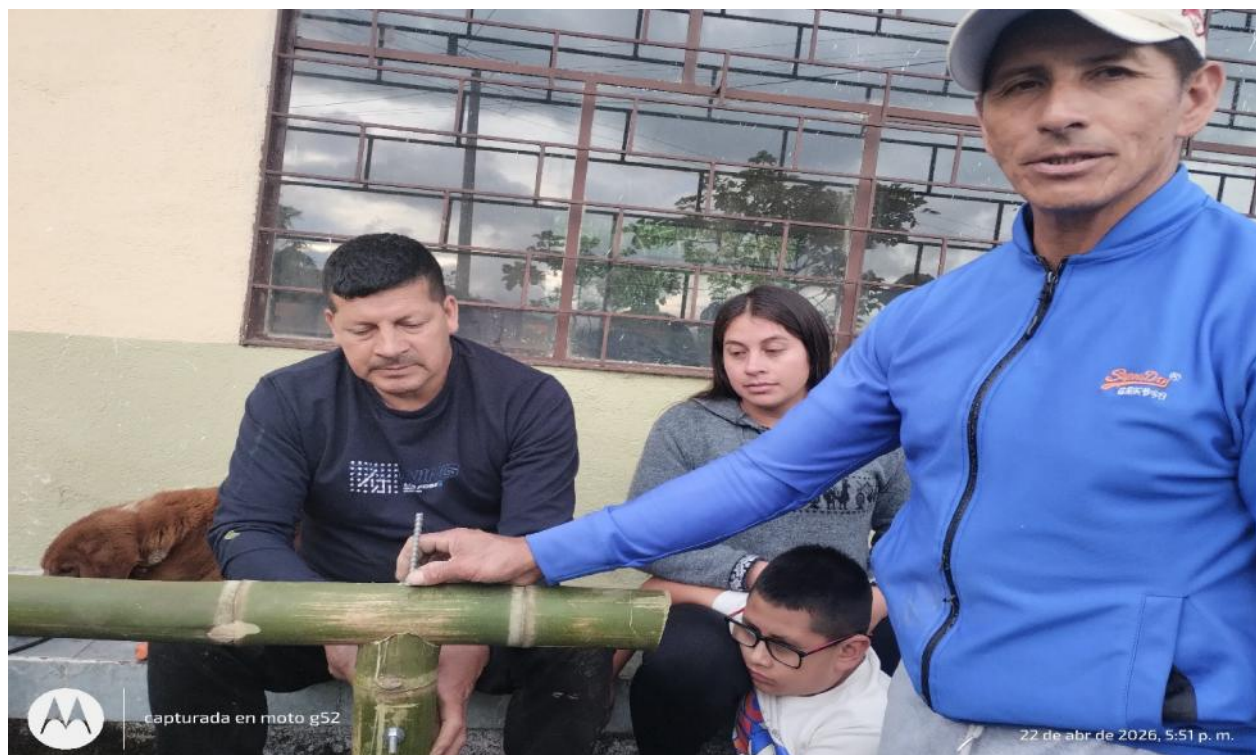
Formación: uniones, empalmes y ensambles para estructuras en guadua – Vereda la Florida, Municipio de San Bernardo
