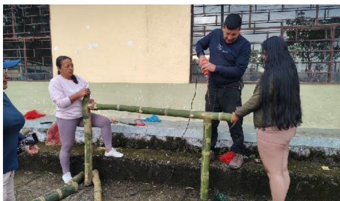
Imagen 5. Realización de cortes en guadua, boca de pescado, pico de flauta
