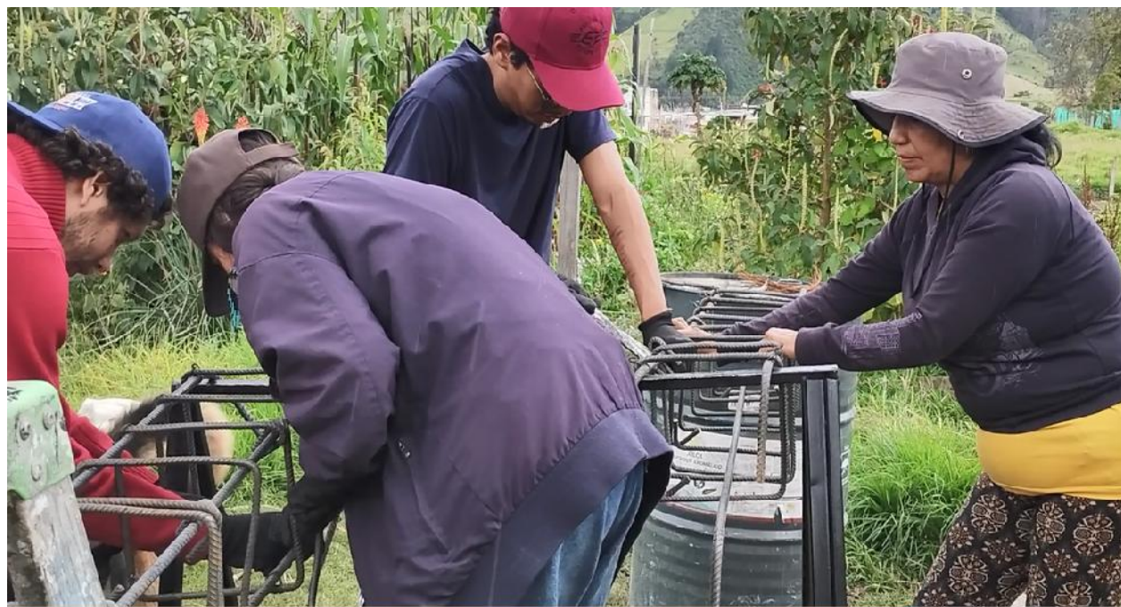
Formación: construcción de estructuras básicas en guadua – Corregimiento de Catambuco, Municipio de Pasto
