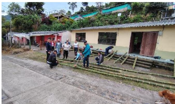
Imagen 3. Alistar elementos estructurales
