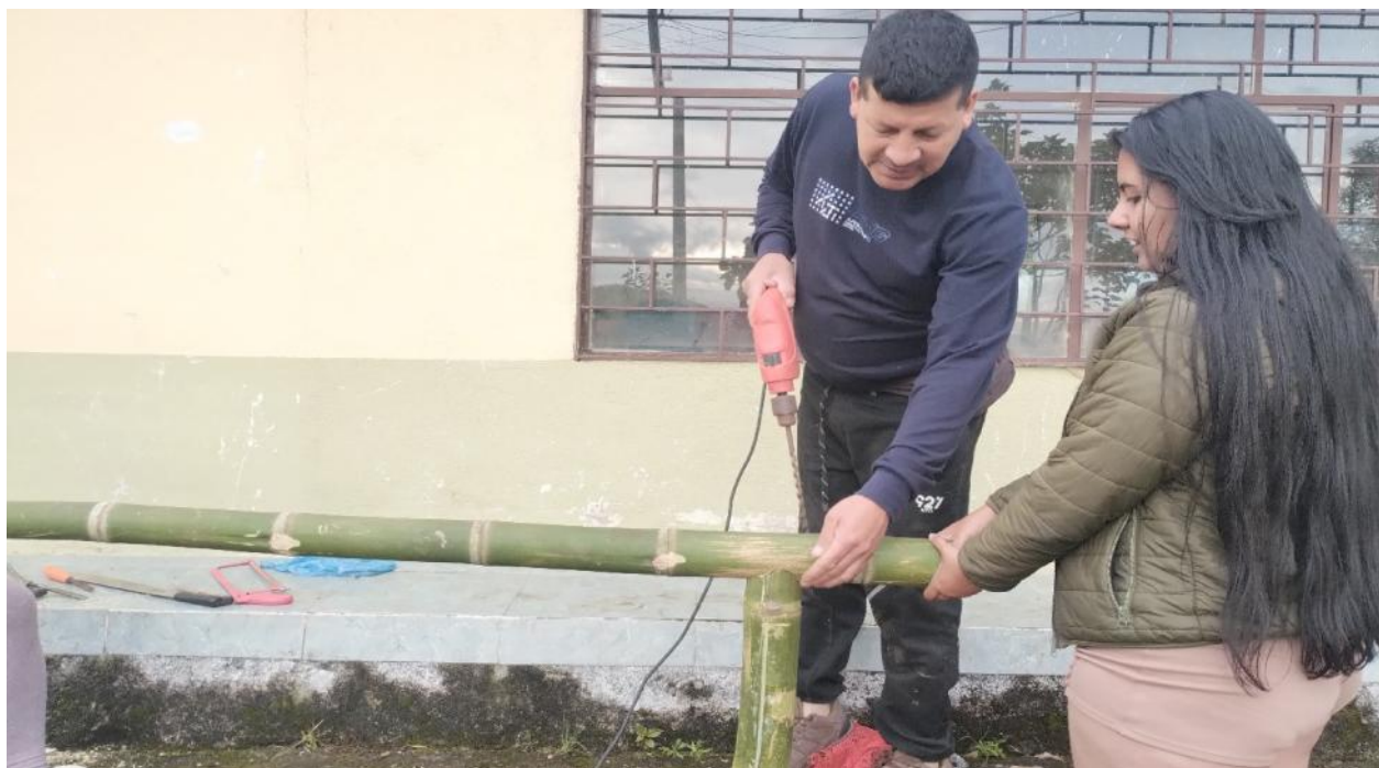
Formación: uniones, empalmes y ensambles para estructuras en guadua – Vereda la Florida, Municipio de San Bernardo
