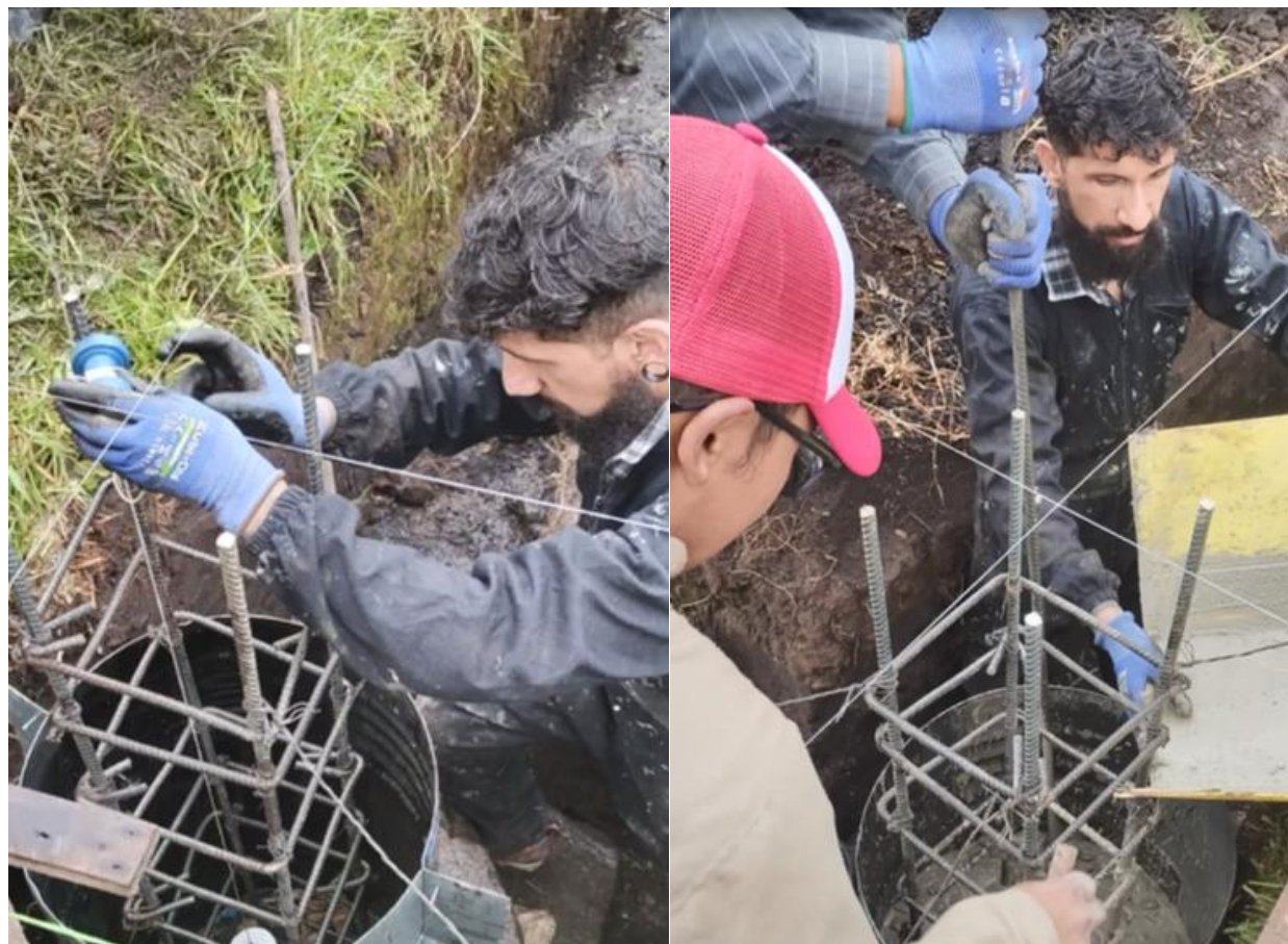
Formación: construcción de estructuras básicas en guadua – Corregimiento de Catambuco, Municipio de Pasto
