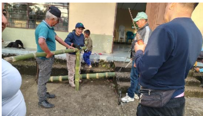
Imagen 5. Realización de cortes en guadua, boca de pescado, pico de flauta
