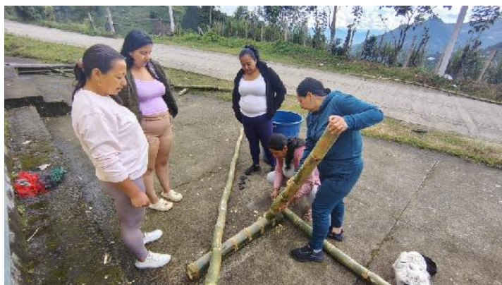
Imagen 4. Realización de cortes en guadua
