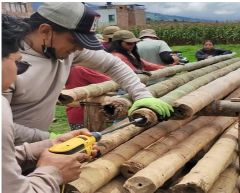
Formación: uniones, empalmes y ensambles para estructuras en guadua – Corregimiento de Catambuco, Municipio de Pasto
