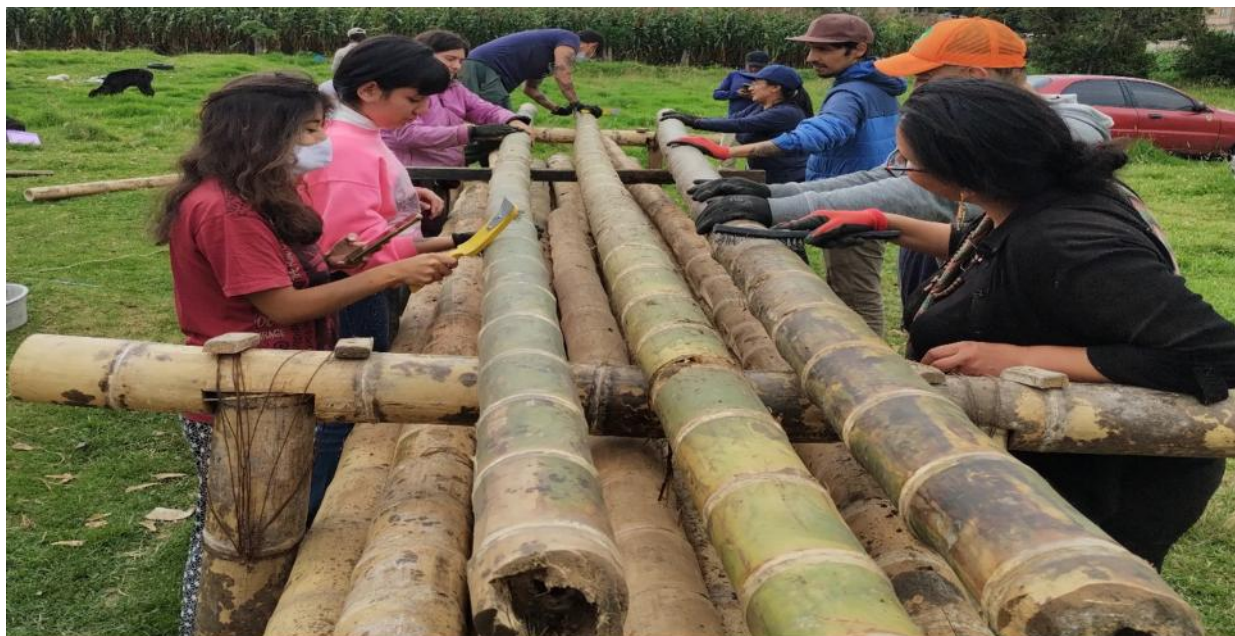
Formación: uniones, empalmes y ensambles para estructuras en guadua – Corregimiento de Catambuco, Municipio de Pasto
