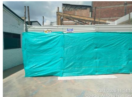
Fotografía 14. Obra de obra de mantenimiento de la infraestructura física de la Secretaría de Educación del Distrito.
