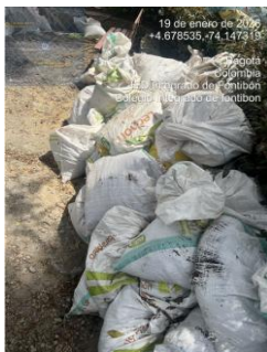
Fotografía 6. Acopio de RCD
