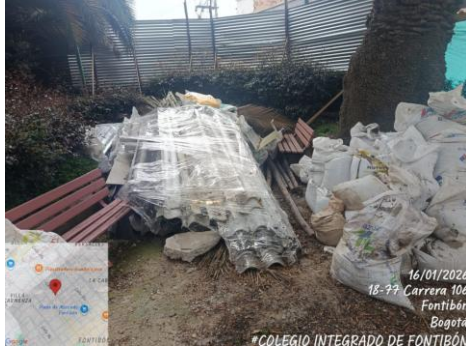
Fotografía 9. Acopio de Respaldo de Materiales de Construcción
