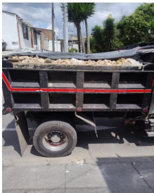
Fotografía 7. Retiro de RCD de un camión para su disposición final
