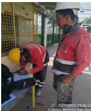
Fotografía 15. Obra de mantenimiento en la fachada del colegio.
