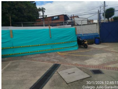
Fotografía 13. Obra de obra de mantenimiento de la infraestructura física de la Secretaría de Educación del Distrito.
