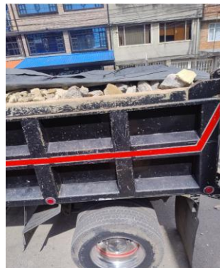
Fotografía 8. Retiro de RCD de un camión para su disposición final
