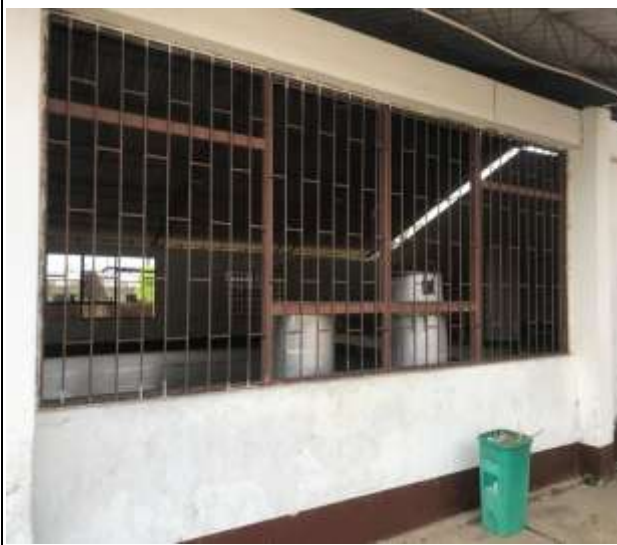
Resanes, suministro y aplicación de pintura en vinilo tipo 2 en muros
