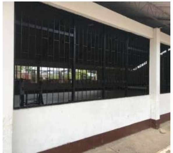
Resanes, suministro y aplicación de pintura en vinilo tipo 2 en muros
