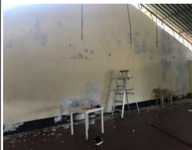
Resanes, suministro y aplicación de pintura en vinilo tipo 2 en muros
