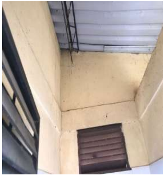
Foto1: en las imágenes se puede evidenciar el estado en que se encuentran los muros, algunos consumidos por la humedad y la suciedad del polvo.
