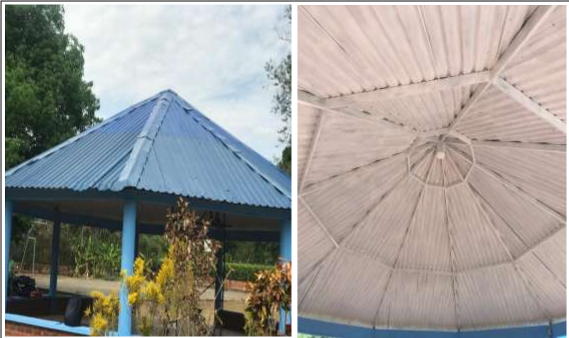
Foto 3: despues de limpiar, retirar la humedad y pintar queda como resultado el techo pintado de manera exterior e interior y los perfiles como rezan en la actividad.
