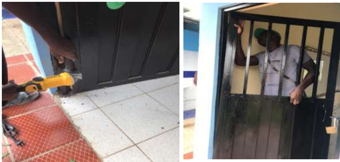
Foto1: Se hacen los cortes con la pulidora para luego instalar las nuevas bisagras y soldar para que la puerta quede nuevamente instalada y nivelada.
