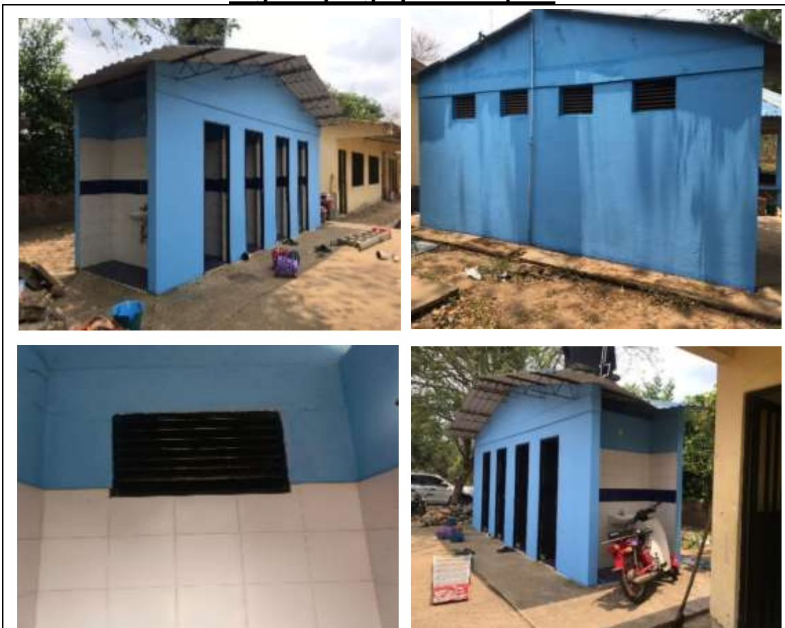
Foto 3: una vez finalizada la pintura se puede evidenciar el resalto que da el color azul y el cambio total a las unidades sanitarias, donde se les aplico pintura de agua tipo 2 a dos manos y pintura de aceite color negro para un total de 90 metros cuadrados.
