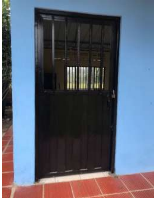
Foto1: ya queda instalada la puerta y nivelada para el uso adecuado de la profesora
