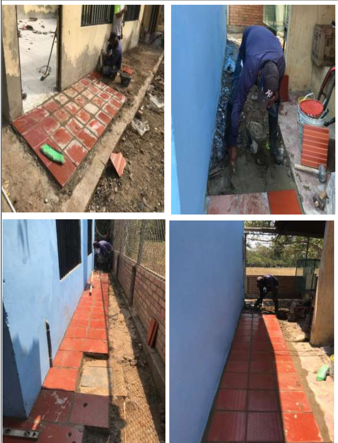
Foto 2: se enchapa 31 metros cuadrado con tablon de gress de 30 x 30 cm, se le hace la respectiva boquilla en las diltaciones y se va limpiando de una vez la baldosa para que no valla a quedar sucia.
