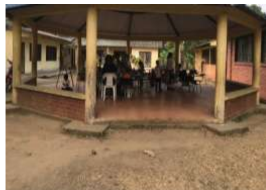
Foto 1: se puede evidenciar que el kiosk escolar esta sucio y descolorido, la pintura existente es de un tono amarillo donde en partes se evidencia la humedad.
