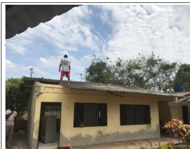
Foto 1: imagen del salón de clases de los grados 3,4 y 5 antes de desentechar
