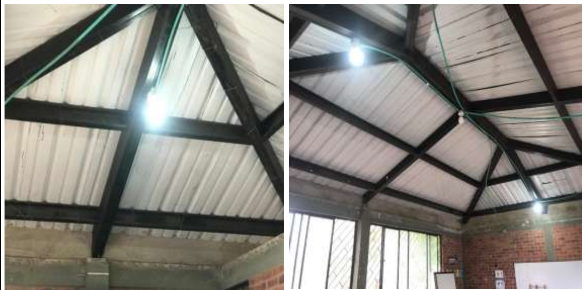
Foto1: se instala la lampara led de 35w para dejar habilitados los 2 puntos eléctricos y quede el aula de clases con iluminación.
