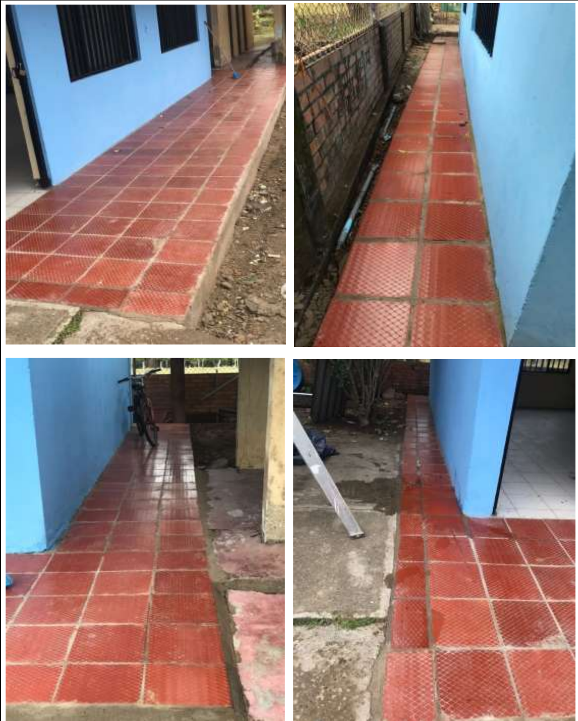
Foto 3: se enchapa los 31 metros cuadrados del piso en tablón en Gress, dejando desnivel hacia los finales en la parte de al frente y con su respectiva boquilla.
