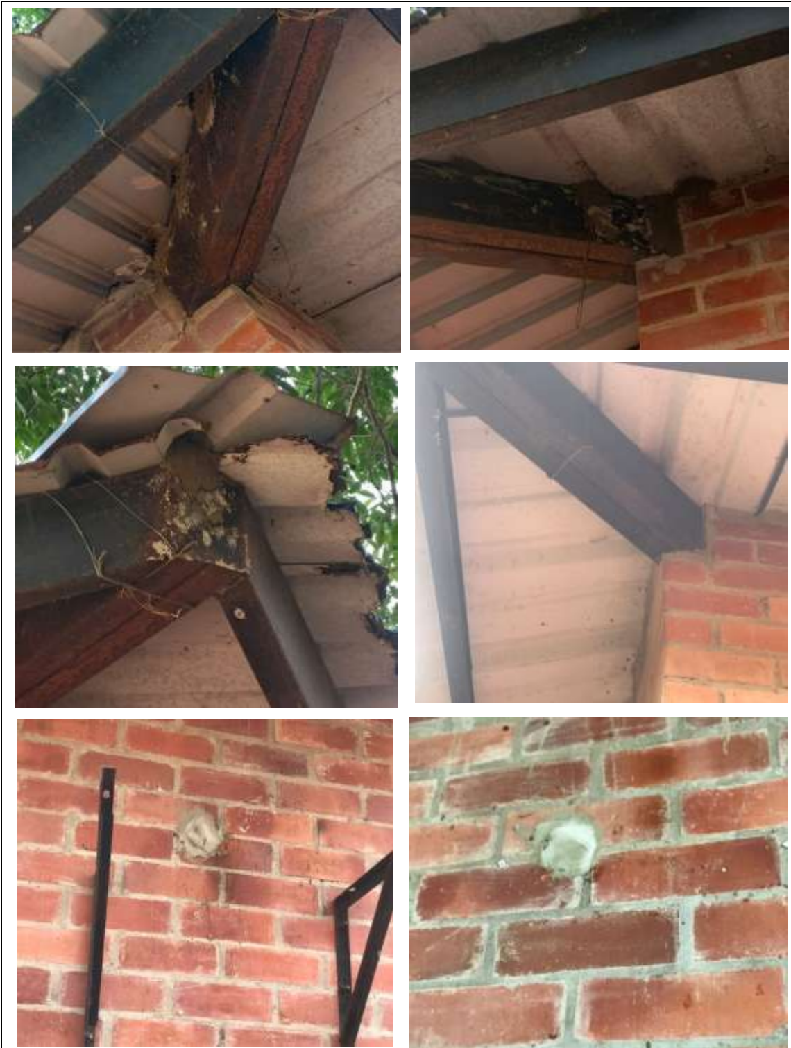
Foto 3: se hace le sellamiento con cemento y pega master para tapan los orificios de las mangueras de los aires, huecos entre las paredes, ventanas, puertas y perfiles para controlar la entrada de plagas como murciélagos, cucarachas, ratones.
