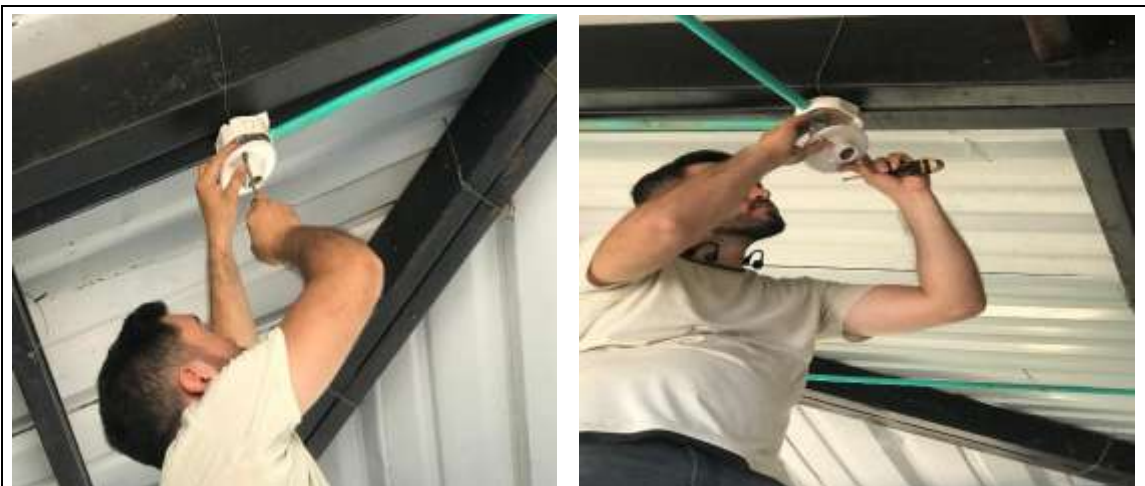
Foto1: se hace el empalme y la instalación de las rosetas para habilitar los 2 puntos para luego instalar las lámparas led de 35w.
