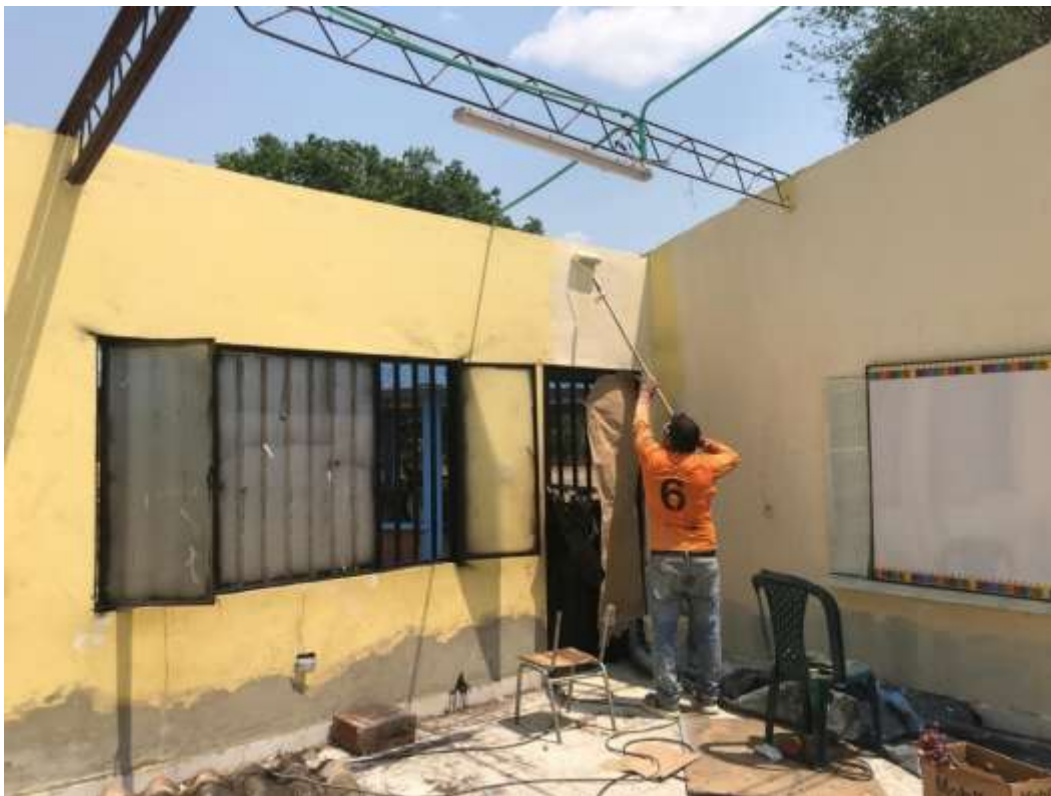
Foto 3: se hace el resane con pega master e invecryl, corrigiendo todas las humedades y deterioros de la pared, luego se aplica la pintura de agua tipo 2 a dos manos de manera interior y exterior color beige y azul claro.
