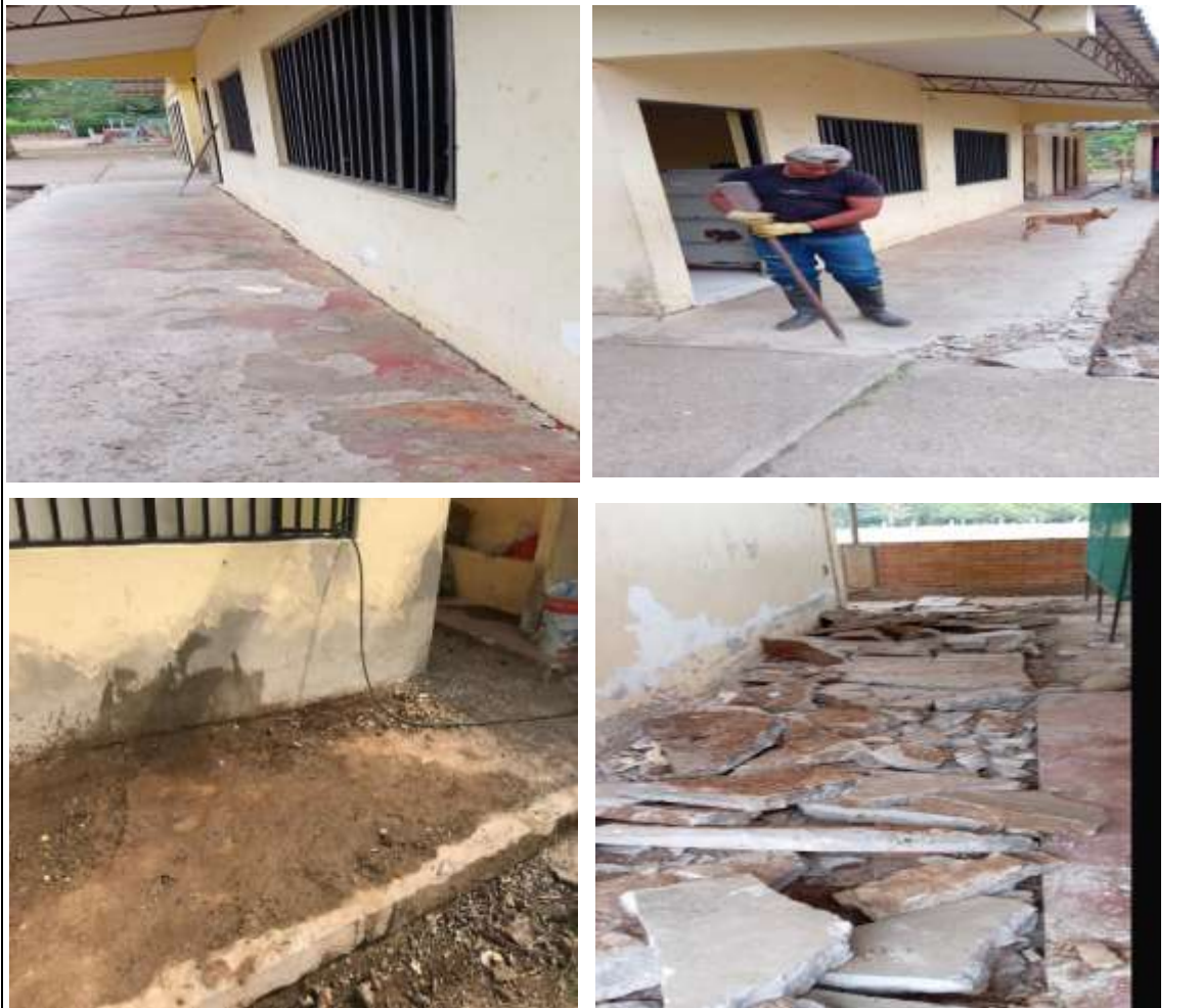
Foto1: se hace la demolición del piso existente con barra y punta, luego se retira el escombros para hacer el replanteo y nivel del existente para poder enchapar el tablón en Gress.
