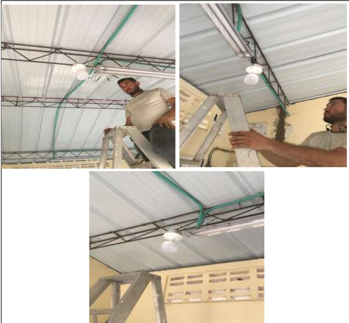
Foto1:se instalan las 3 lámparas led de 35w distribuidos en puntos estratégicos para que hagan la cobertura total de la iluminación en todo el salón de clases.
