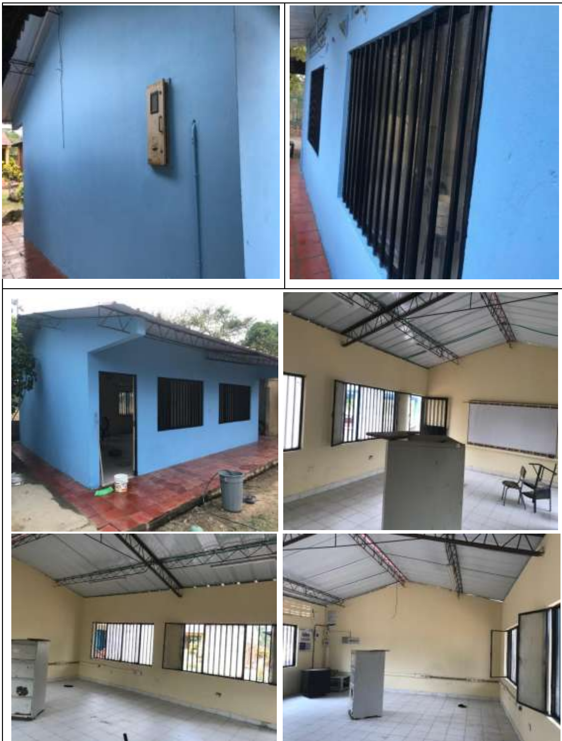
Foto 4: se pintan los 161.90 metros cuadrados de color azul en la parte exterior y de color beige en la parte interior con pintura de agua a dos manos y se hacen los respectivos remates con brocha en los bordes del techo y en los finales de la pared.
