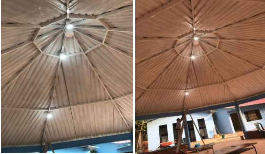
Foto 3: resultado final de la instalacion de las 3 lamparad led de 35 w, dejando iluminado el kiosco escolar .
