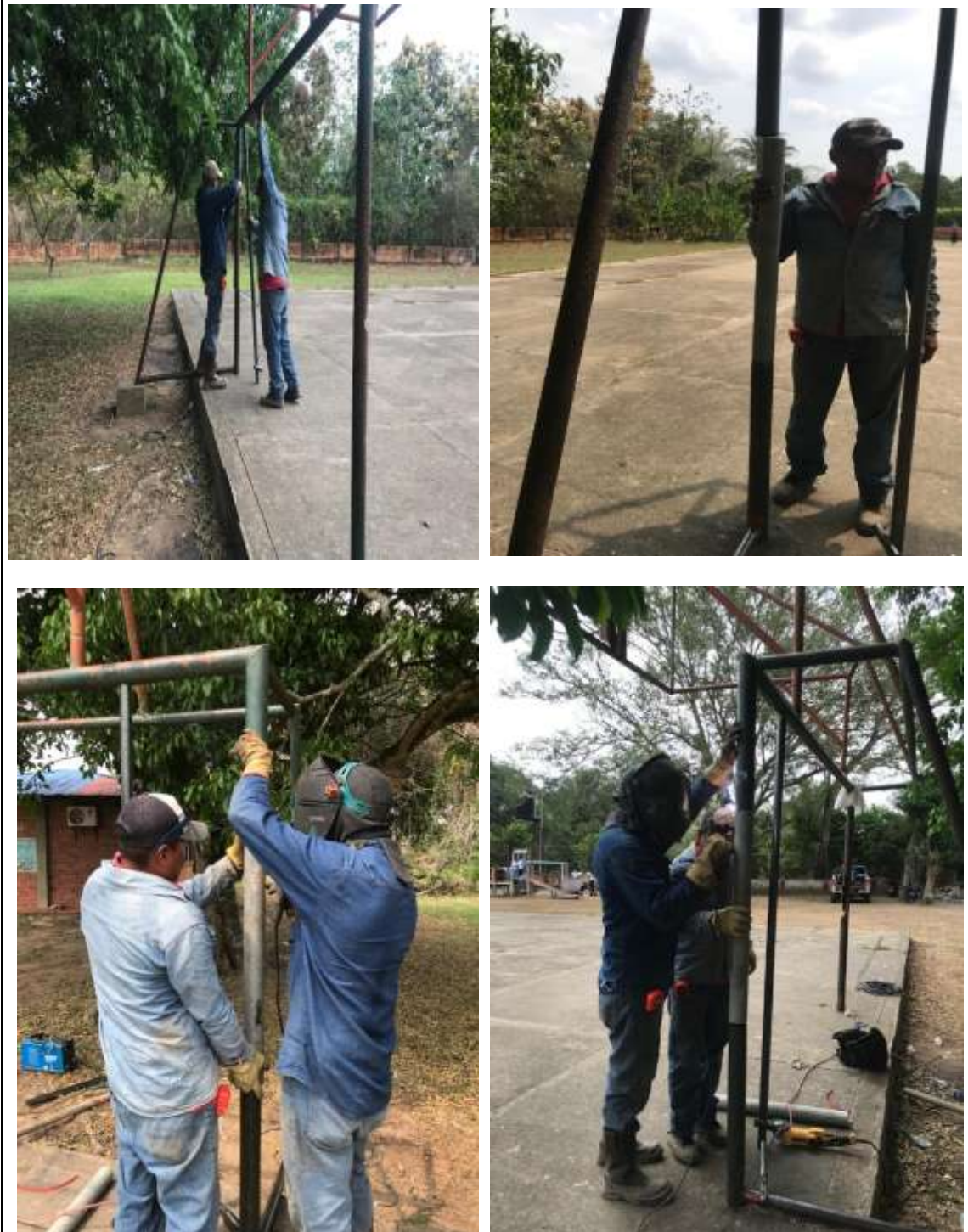
Foto 2: se corta con la pulidora los tubos averiados, se mide y luego se soldan los nuevos tubos, una vez instalados se pulen con la pulidora para que el marco ya quede listo para pintar y de esta manera se arreglan los marcos de las canchas.
