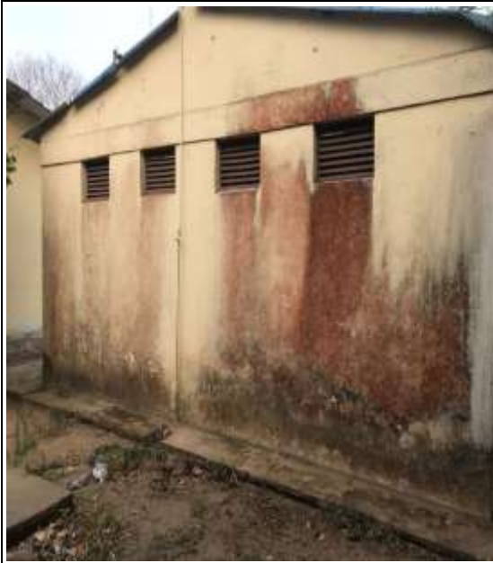
Foto1: en las imágenes se puede evidenciar el estado en que se encuentran los muros, algunos consumidos por la humedad y la suciedad del polvo.
