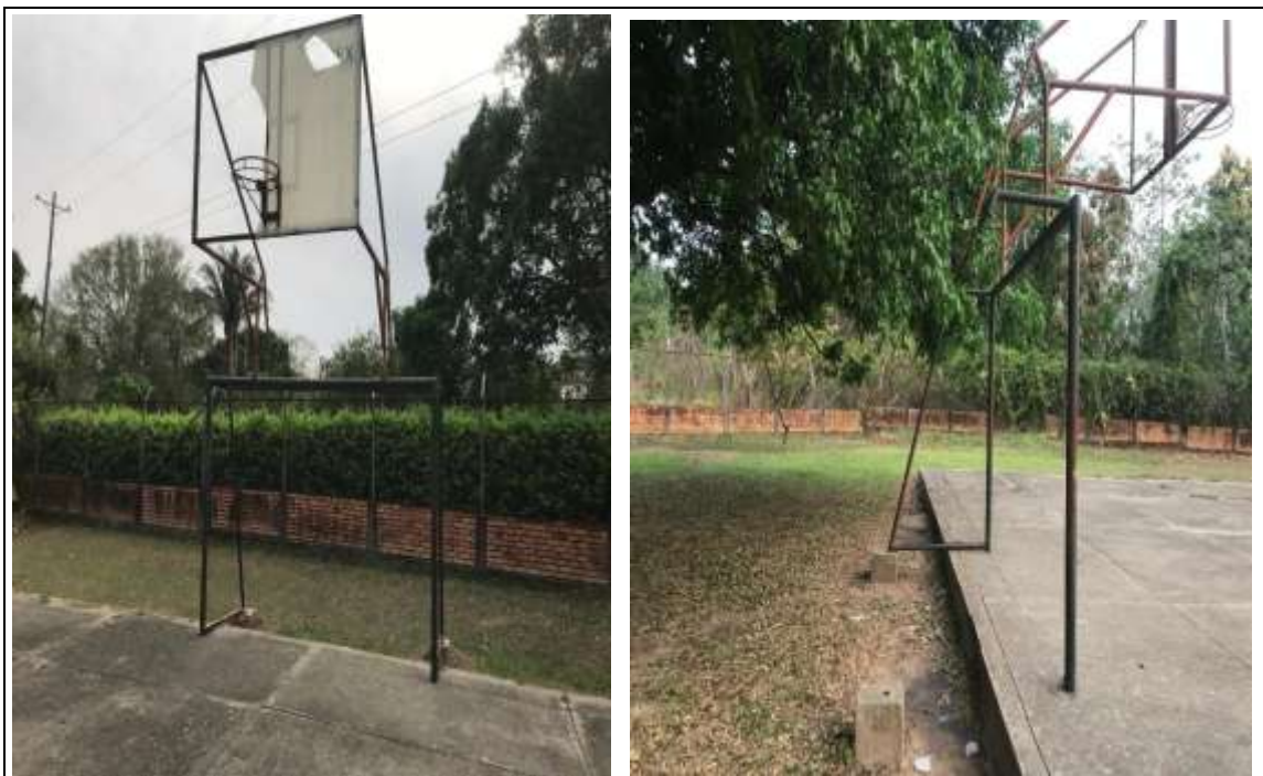
Foto 1: se evidencia el deterioro y desgaste de los marcos de las canchas multifuncionales por el sol y el agua a la que esta expuesta, consumida por la corrosión del oxido.
