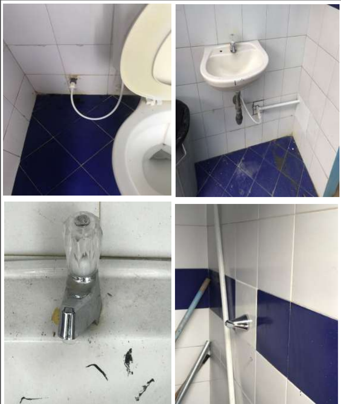
Foto 3: se instalan las mangueras de los lavamanos y las unidades sanitarias para habilitar el paso del agua, se cambian las llaves de los lavamanos el registro de la ducha y así dejamos habilitado las unidades sanitarias para que puedan hacer uso de ellas.
