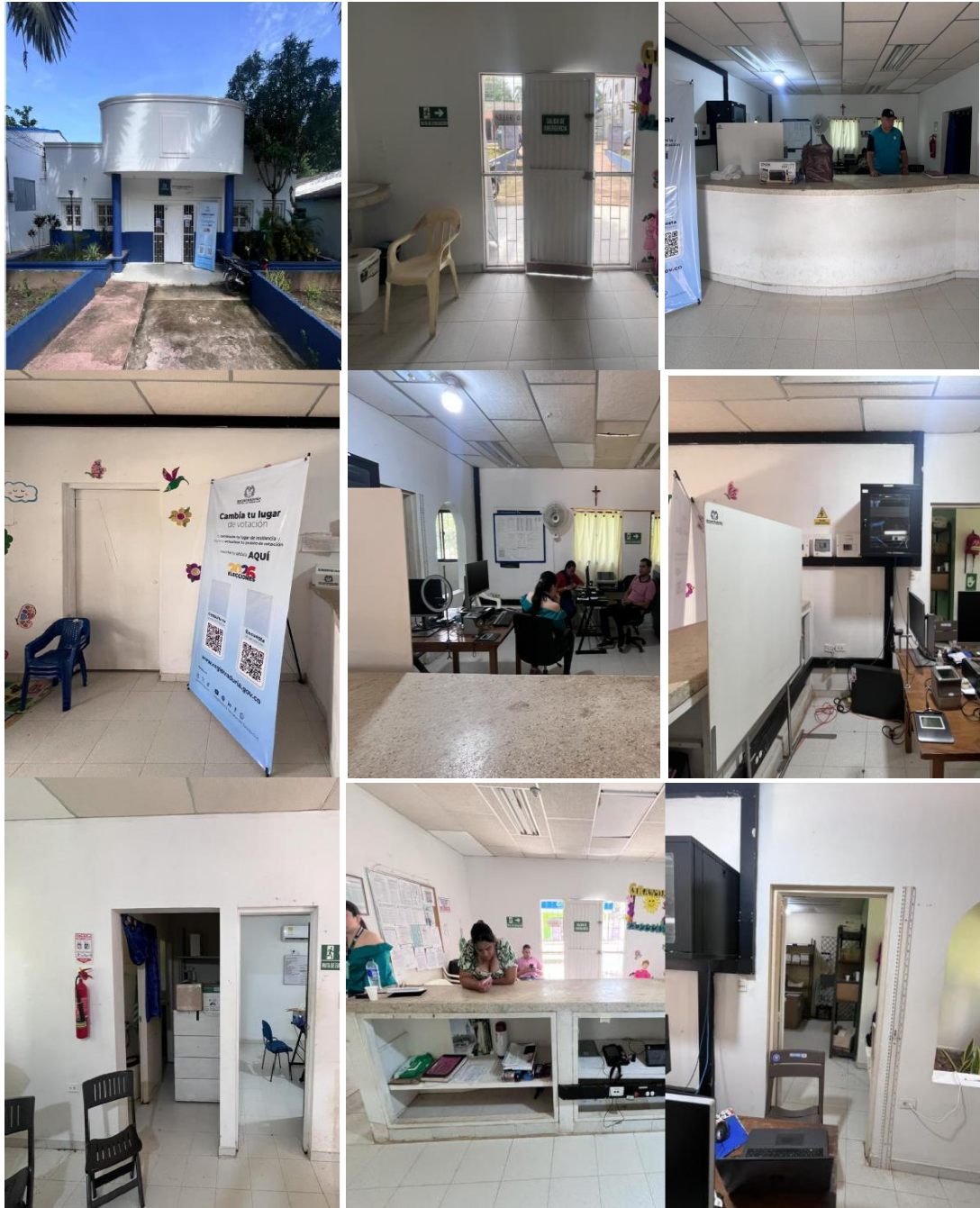
Imagen 3. Estado actual inmueble Registraduría Municipal de La Unión (Sucre).
