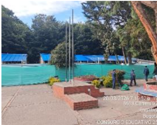
Ilustración 6 Adecuación de cerramiento en Simón Bolívar
