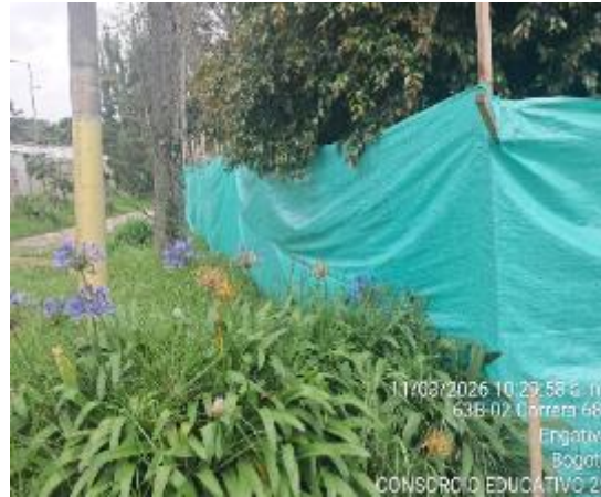
Ilustración 8 Cerramiento en la sede Francisco José Sede A
