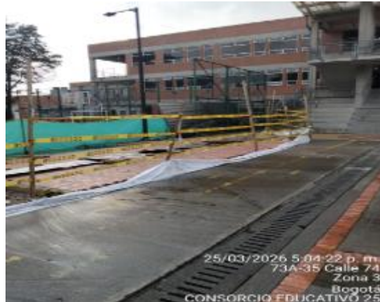
Ilustración 7 Cerramiento en la sede TABORA
