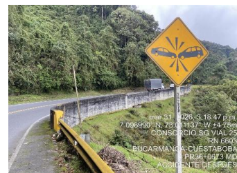
SEÑAL SP 67 PR36+0673 MARGEN DERECHA FECHA INST.
