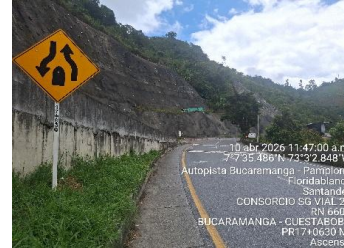
SEÑAL SP 56 PR17+0630 MARGEN IZQUIERDO FECHA INST.
