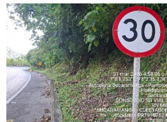
SEÑAL SR 30/30 PR19+0762 MARGEN IZQUIERDA FECHA INST.
