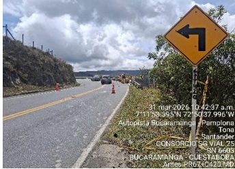
SEÑAL SP 01 PR67+0420 MARGEN DERECHA FECHA INST.
