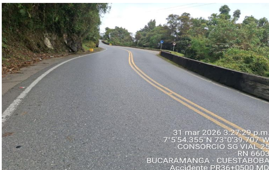
Fotografía, PR36+0500, Sentido Bucaramanga - Pamplona detalle del sitio del accidente
