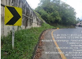
SEÑAL SP 75 PR17+0424 MARGEN IZQUIERDO FECHA INST.
