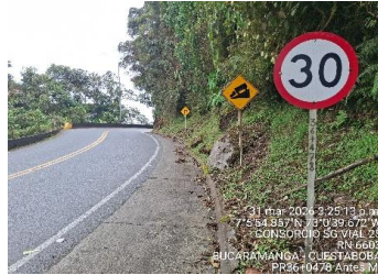
SEÑAL SR 30/30 PR36+0478 MARGEN IZQUIERDA FECHA INST.
