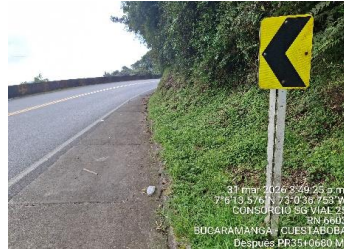
SEÑAL SP 75 PR35+0680 MARGEN IZQUIERDA FECHA INST.
