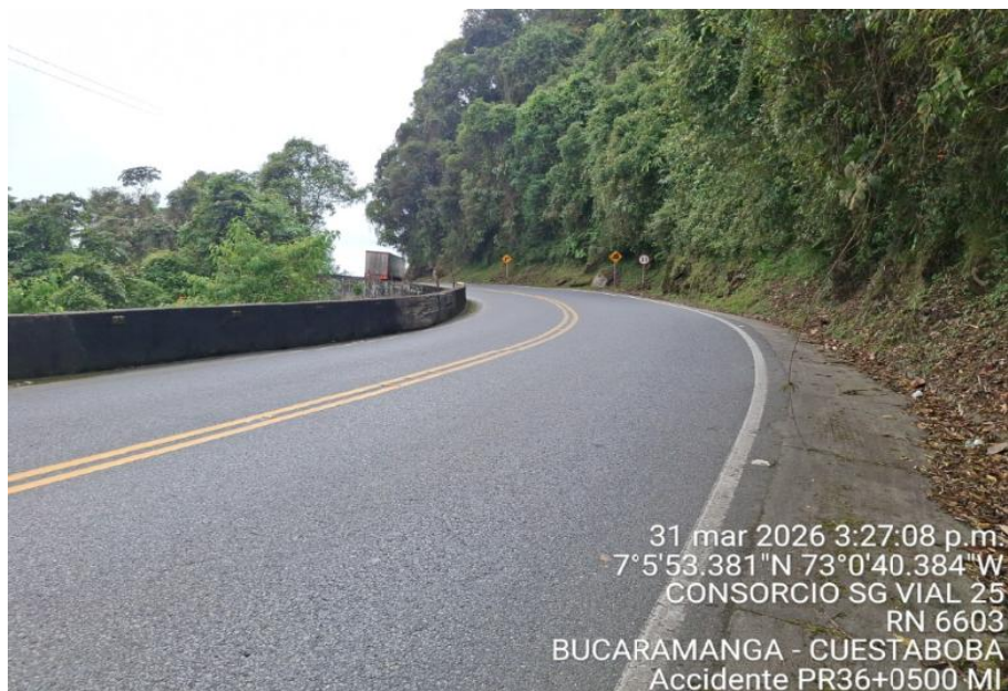
Fotografía, PR36+0500, Sentido Pamplona - Bucaramanga, Panorámica del sitio del accidente
