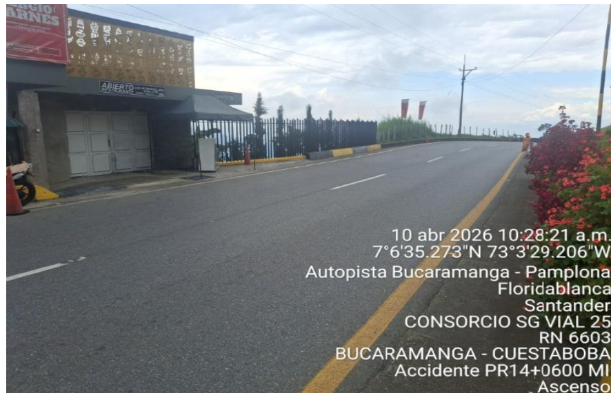
Fotografía, PR14+0600, Sentido Pamplona - Bucaramanga, Panorámica del sitio del accidente
