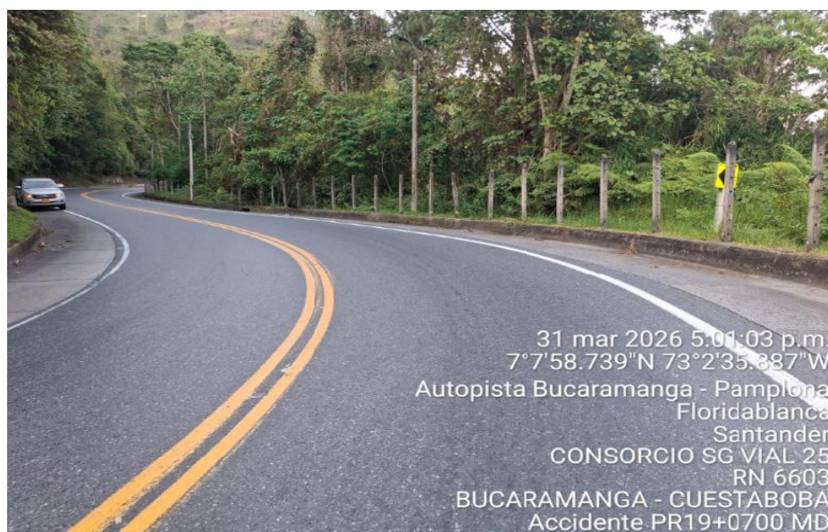
Fotografía, PR19+0700, Sentido Bucaramanga - Pamplona detalle del sitio del accidente
