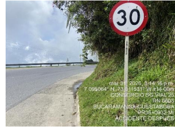
SEÑAL SR 30/30 PR36+0932 MARGEN IZQUIERDA FECHA INST.
