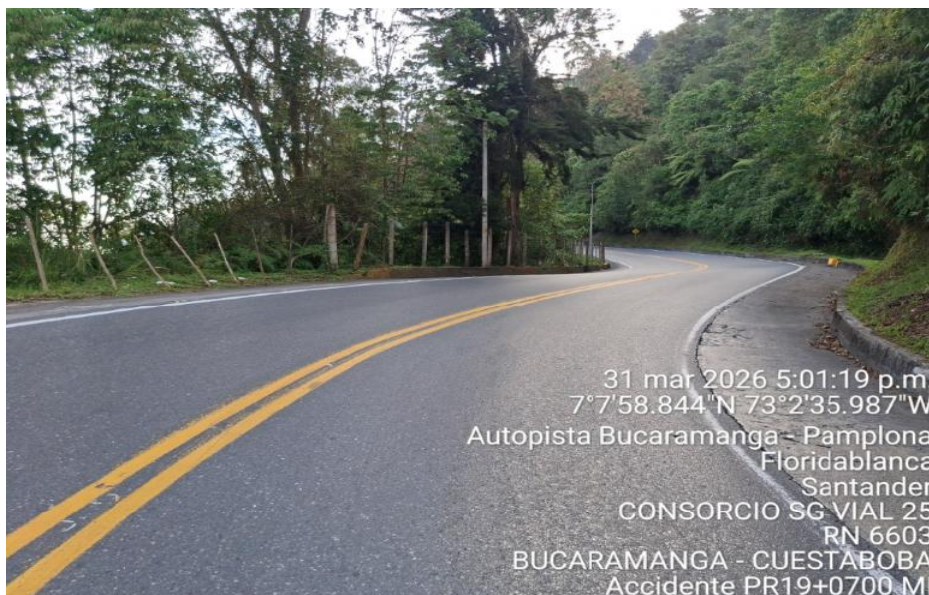
Fotografía, PR19+0700, Sentido Pamplona - Bucaramanga, Panorámica del sitio del accidente
