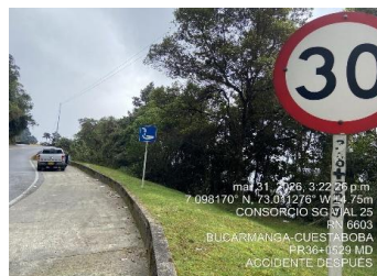
SEÑAL SR 30/30 PR36+0529 MARGEN DERECHA FECHA INST.
