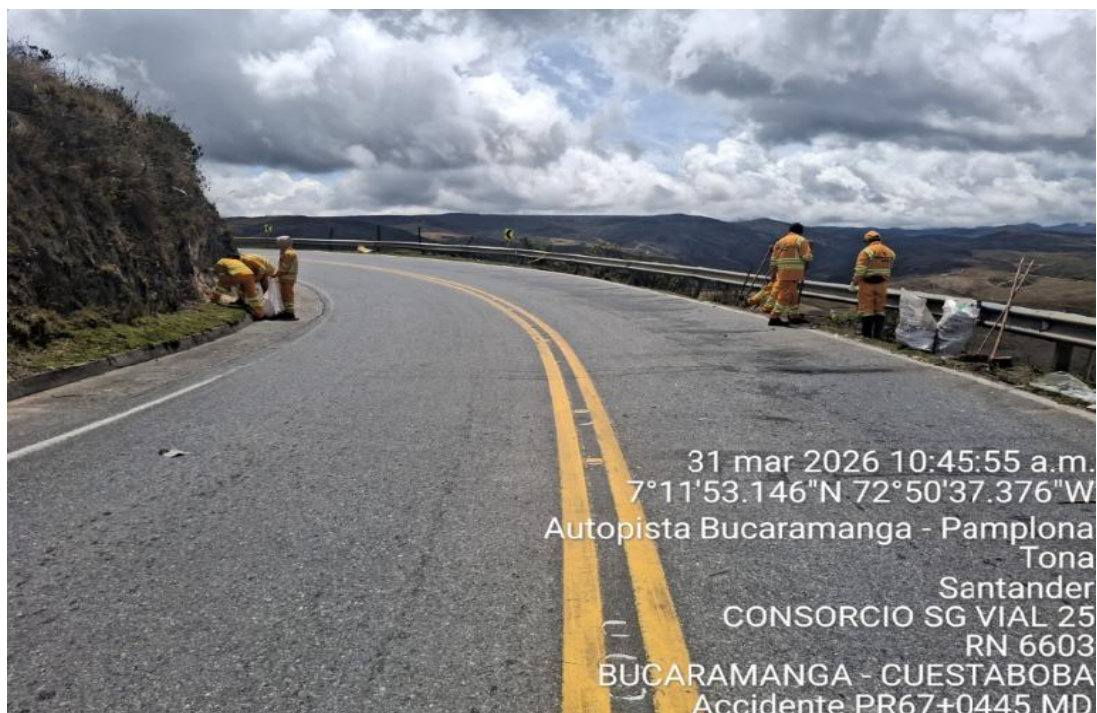
Fotografía, PR67+0445, Sentido Bucaramanga - Pamplona detalle del sitio del accidente
