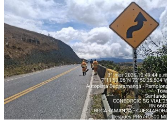
SEÑAL SP 10 PR67+0500 MARGEN DERECHA FECHA INST.
