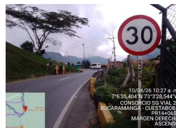
SEÑAL SR30/30 PR14+0659 MARGEN DERECHA FECHA INST.
