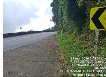
SEÑAL SP 75 PR35+0690 MARGEN IZQUIERDA FECHA INST.
