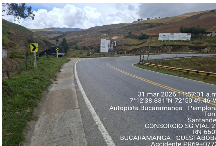
Fotografía, PR69+0773, Sentido Bucaramanga - Pamplona detalle del sitio del accidente
