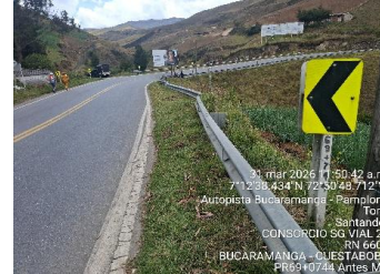
SEÑAL SP 75 PR69+0744 MARGEN DERECHA FECHA INST.
