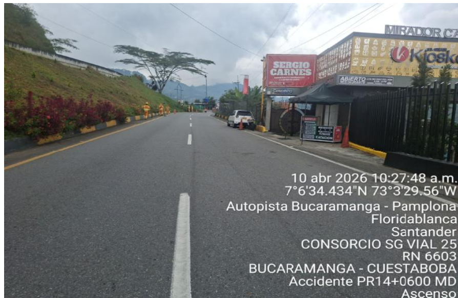
Fotografía. PR14+0600, Sentido Bucaramanga - Pamplona detalle del sitio del accidente
