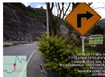
SEÑAL SP 02 PR17+0618 MARGEN DERECHO FECHA INST.
