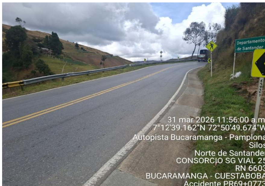
Fotografía, PR69+0773, Sentido Pamplona - Bucaramanga, Panorámica del sitio del accidente
