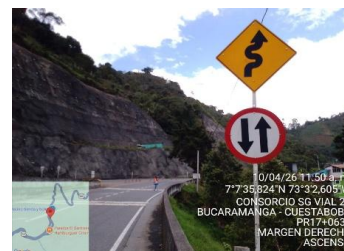
SEÑAL SR 11 / SP 08 PR17+0635 MARGEN DERECHO FECHA INST.
