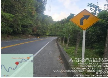
SEÑAL SP 04 PR19+0450 MARGEN DERECHA FECHA INST.
