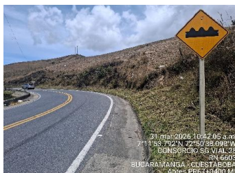
SEÑAL SP 24 PR67+0400 MARGEN IZQUIERDA FECHA INST.
