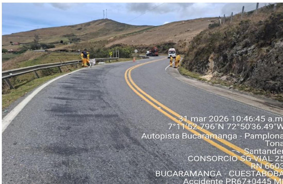
Fotografía, PR67+0445, Sentido Pamplona - Bucaramanga, Panorámica del sitio del accidente
