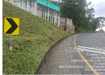
SEÑAL SP 75 PR14+0288 MARGEN IZQUIERDA FECHA INST.
