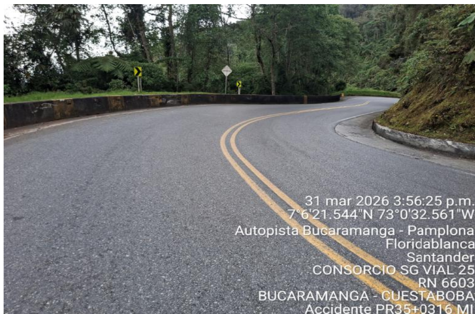
Fotografía, PR35+0316, Sentido Pamplona - Bucaramanga, Panorámica del sitio del accidente
