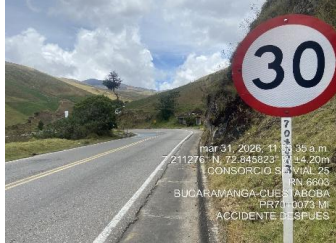
SEÑAL SR 30/30 PR70+0073 MARGEN IZQUIERDA FECHA INST.
