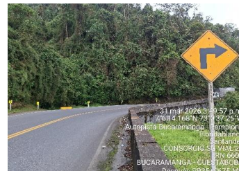
SEÑAL SP 02 PR35+0675 MARGEN DERECHA FECHA INST.
